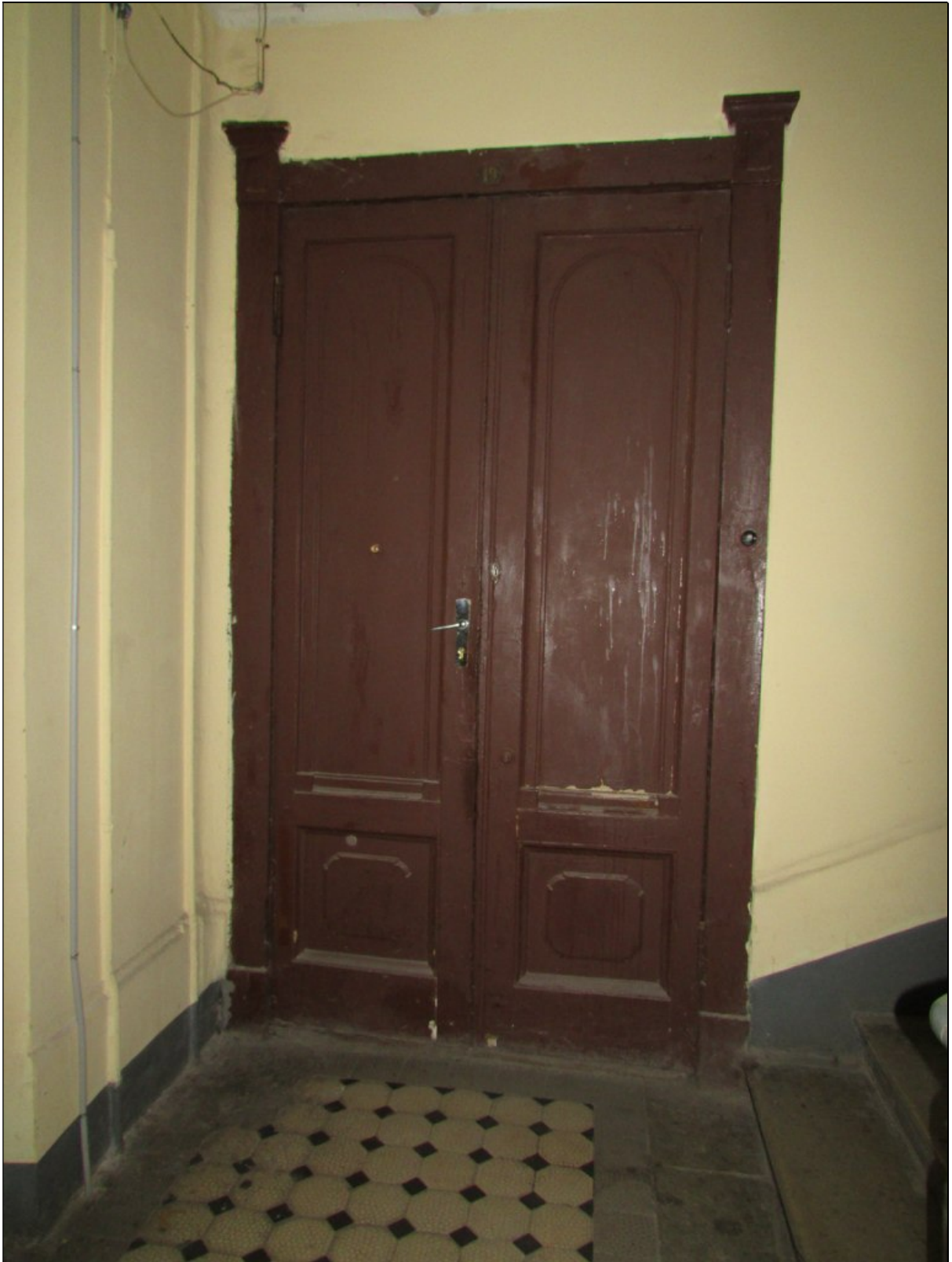
8. Парадная лестница (Л-1). Сохранившаяся историческая входная дверь*.
