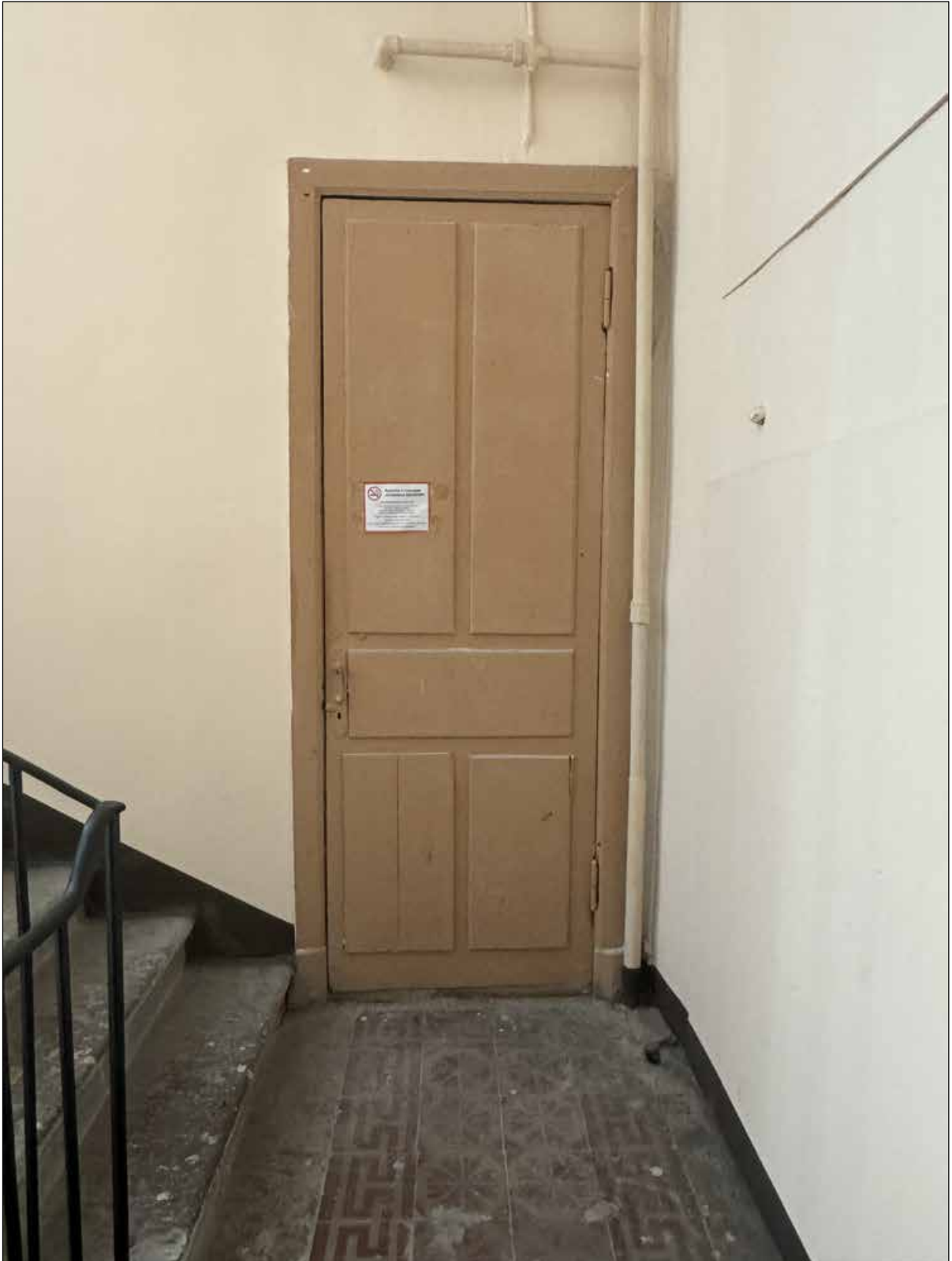
23. «Чёрная» лестница (Л-12). Сохранившаяся историческая входная дверь*.
