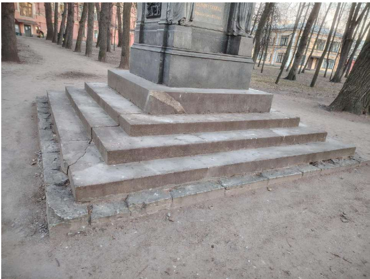
Фото 7. Вид на стереобат и стилобат объекта культурного наследия федерального значения «Памятник врачу Виллие Я.В.» с юго-западной стороны.
