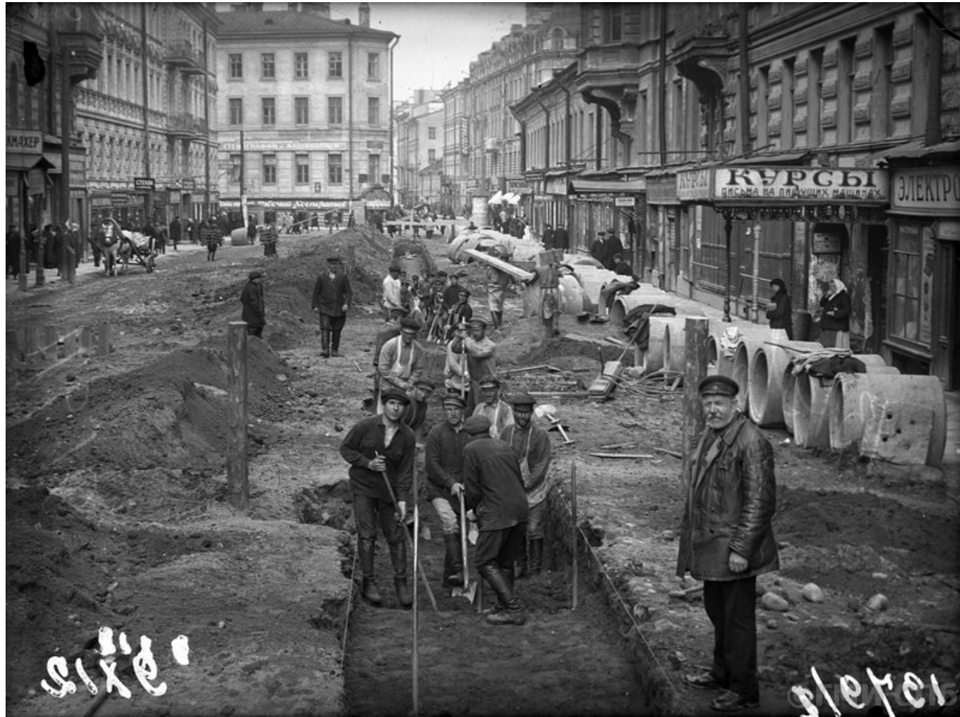
44. Канализационные работы на Моховой улице. Постройка канала. Фотография. Автор фото неизвестен. 1920-1930-е гг. // Источник: https://goskatalog.ru/portal/#/collections?id=17737598 (дата обращения 07.11.2024).
