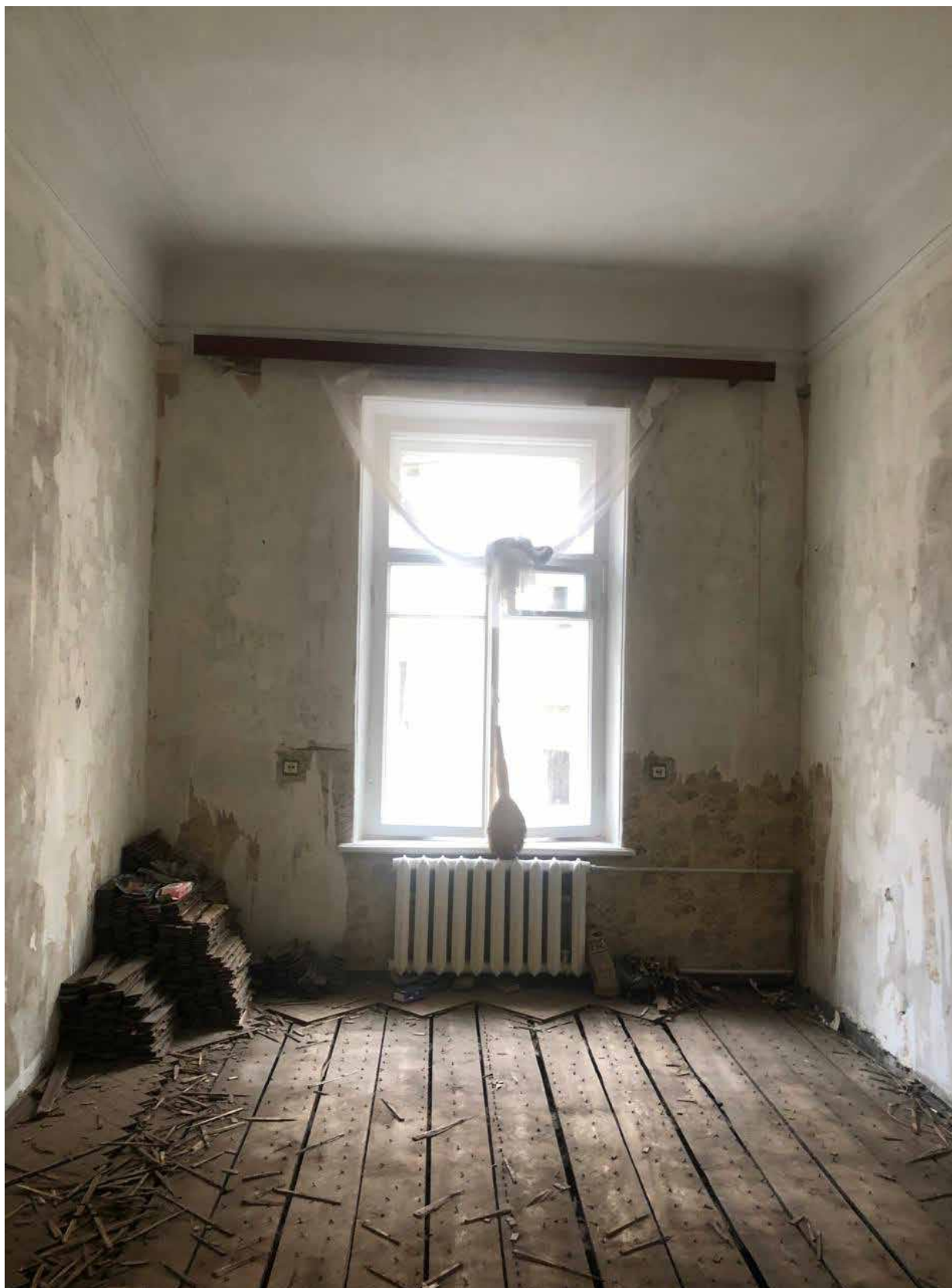
8. Фрагмент интерьера комнаты (помещение 4/21.4);
