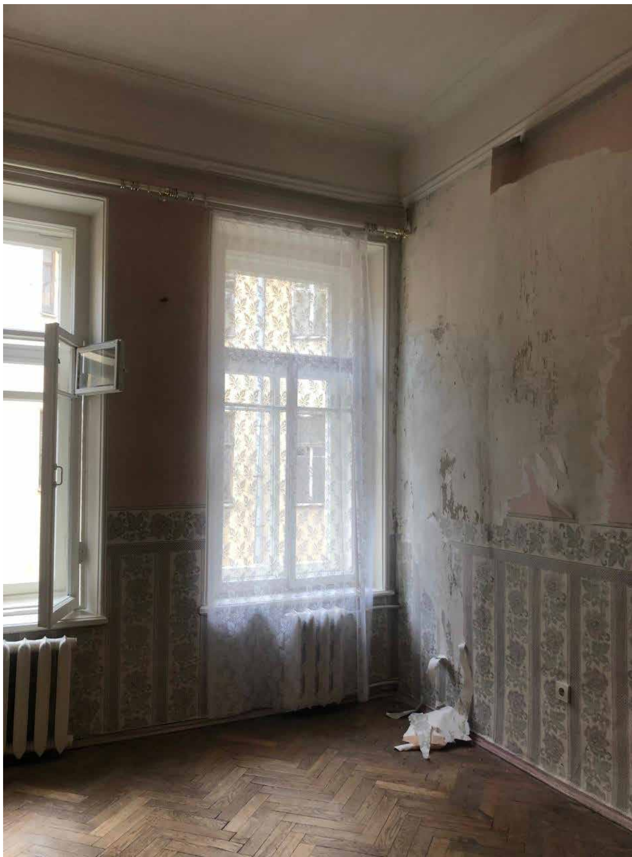
9. Фрагмент интерьера комнаты (помещение 5/17.6);
