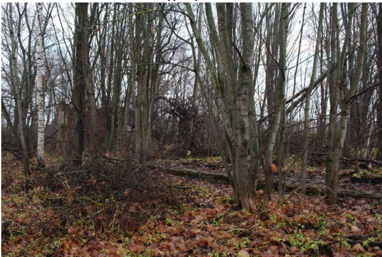
Фото 32. Вид на руины поздней (1964 г.) части объекта культурного наследия регионального значения «Дача с территорией» с северо-запада.
