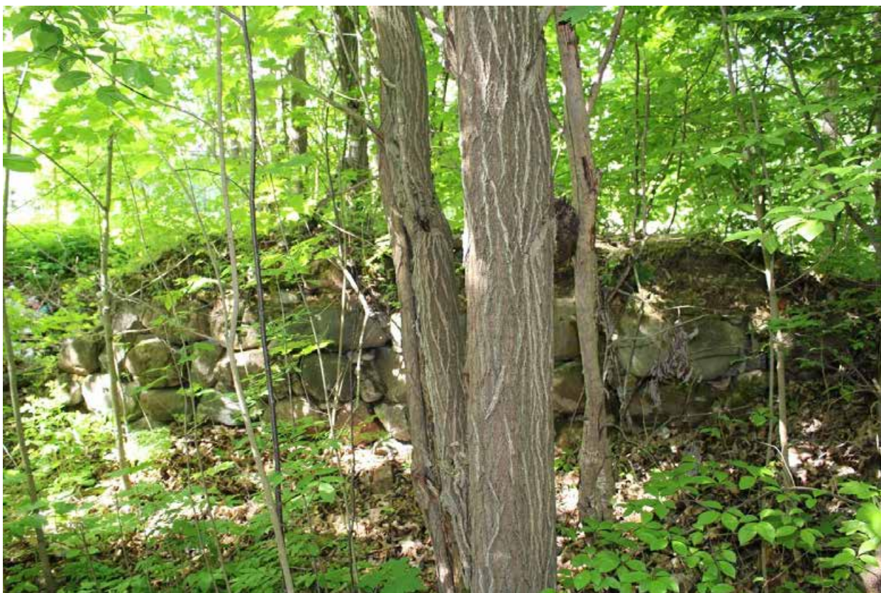
Фото 21. Вид на руины здания и локально сохранившиеся фрагменты бутового фундамента.
