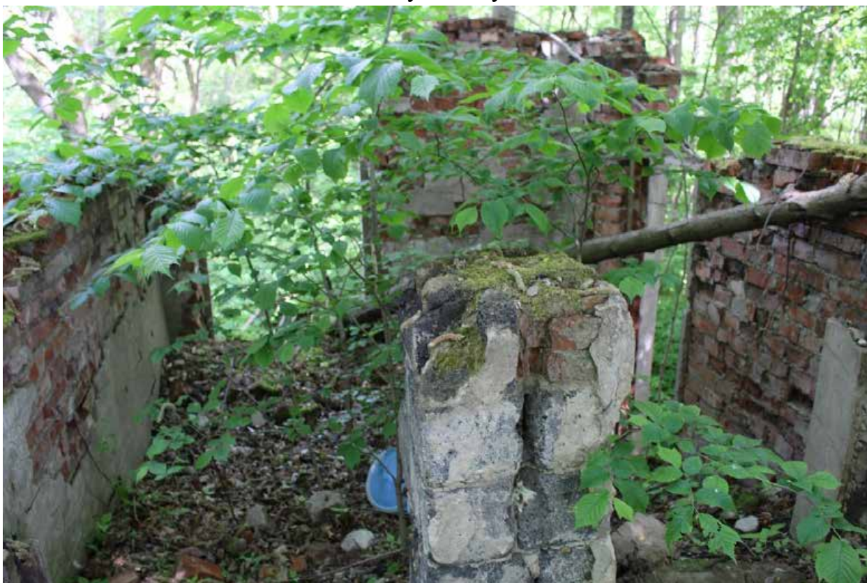
Фото 12. Вид на руины восточной части поздней (1964 г.) северной пристройки к основному объему здания.
