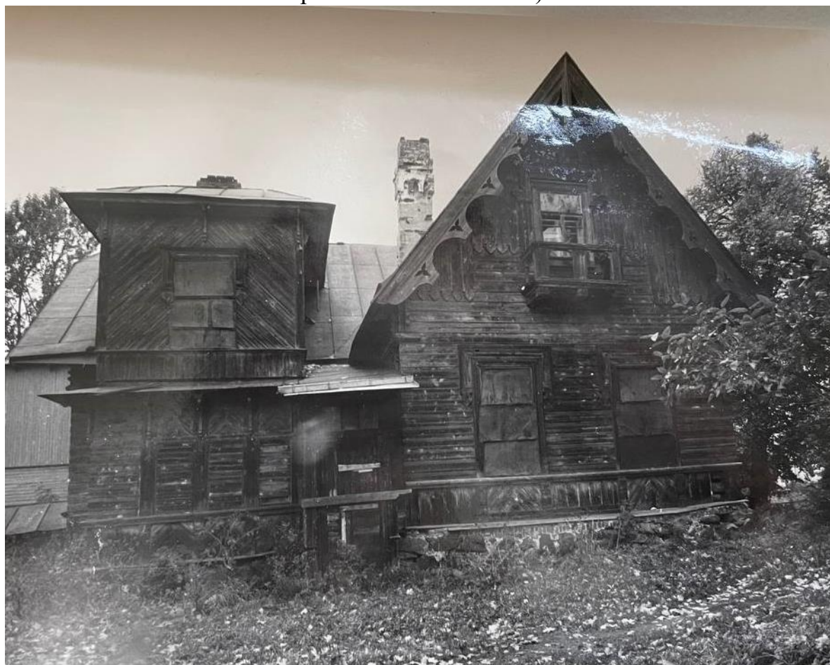
Илл. 21. Корпус 5 («коричневая» дача). Вид с юга. 1990 г. (источник: архив КГИОП п. 219-4).
