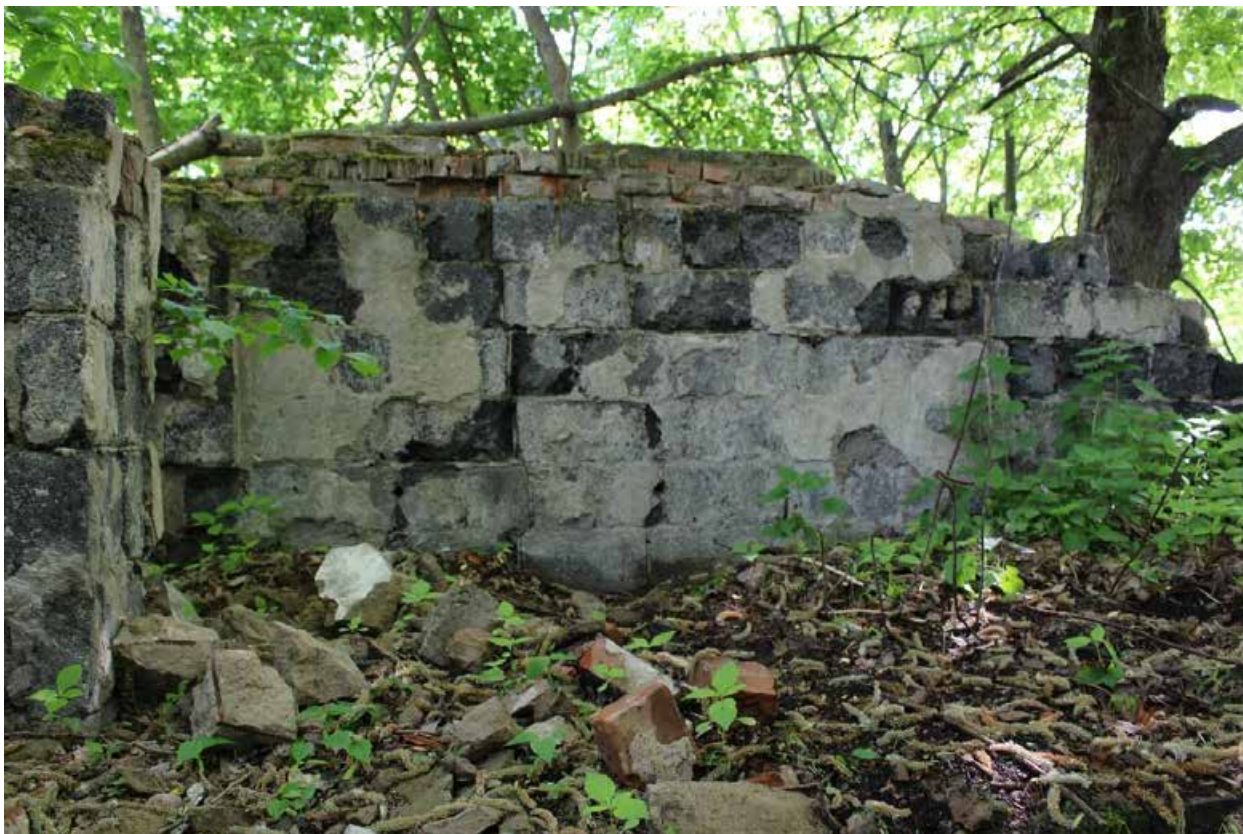
Фото 11. Вид на руины восточной части поздней (1964 г.) северной пристройки к основному объему здания.
