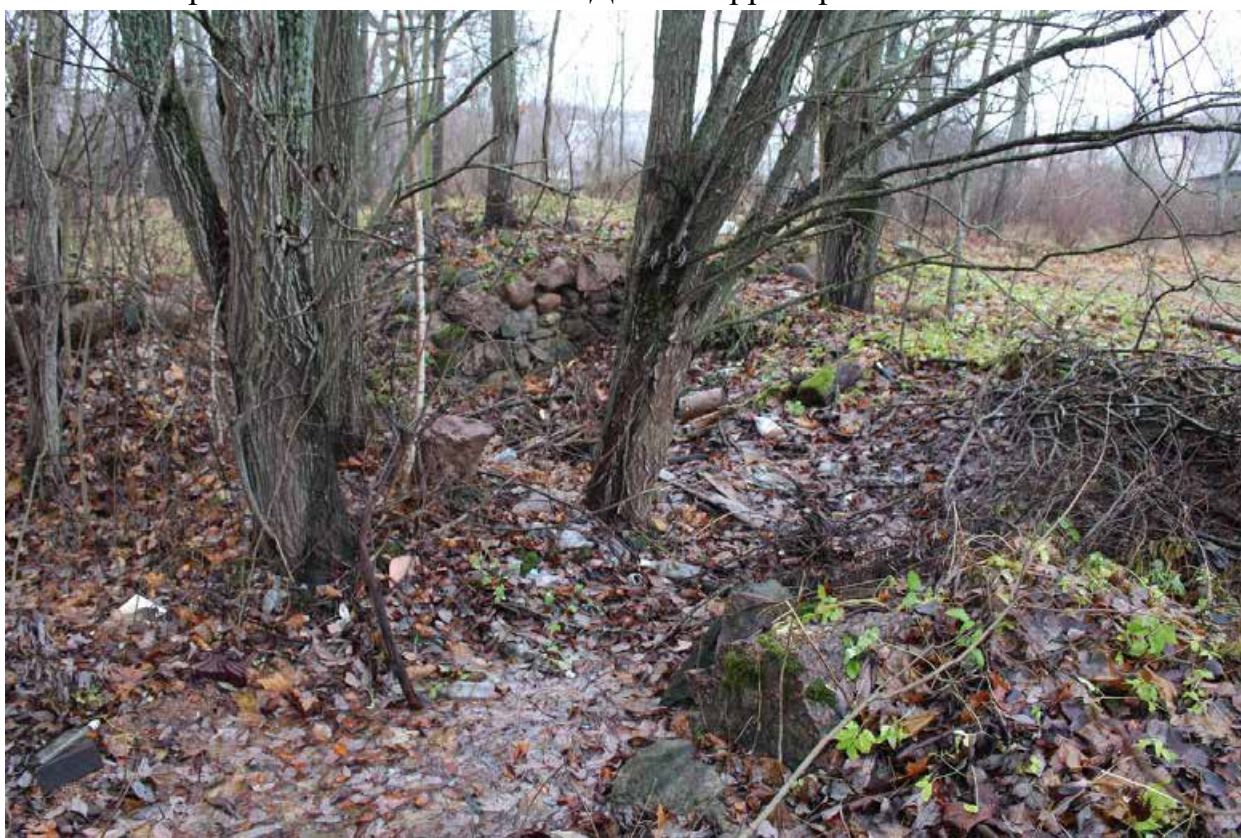
Фото 36. Вид на руины южной части основного объема объекта культурного наследия регионального значения «Дача с территорией» с запада.
