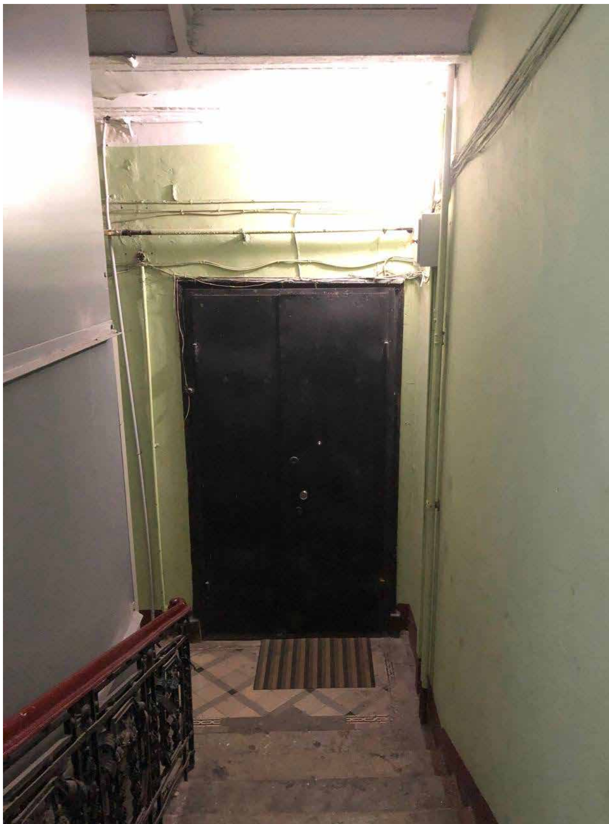
3. Вид на входную дверь в квартиру;
