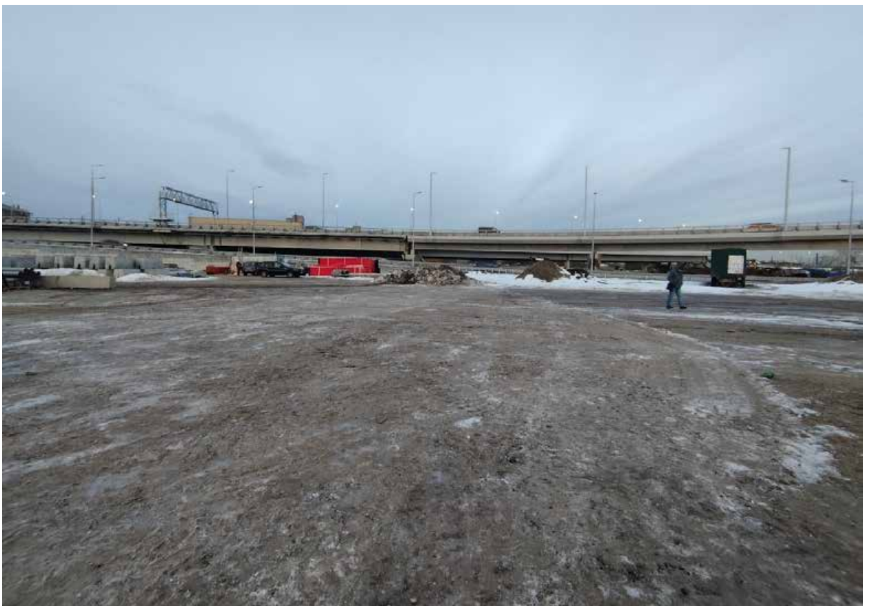
Илл. 20. Объект «Заставская ул.». Точка фотофиксации 4. Вид с востока.
