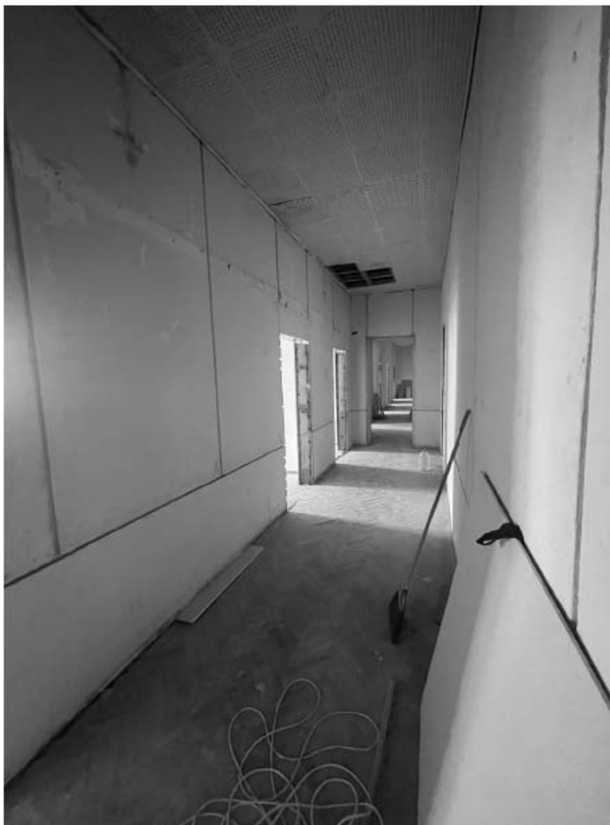
10. Фрагмент интерьера коридора (помещение 15/30.2);
