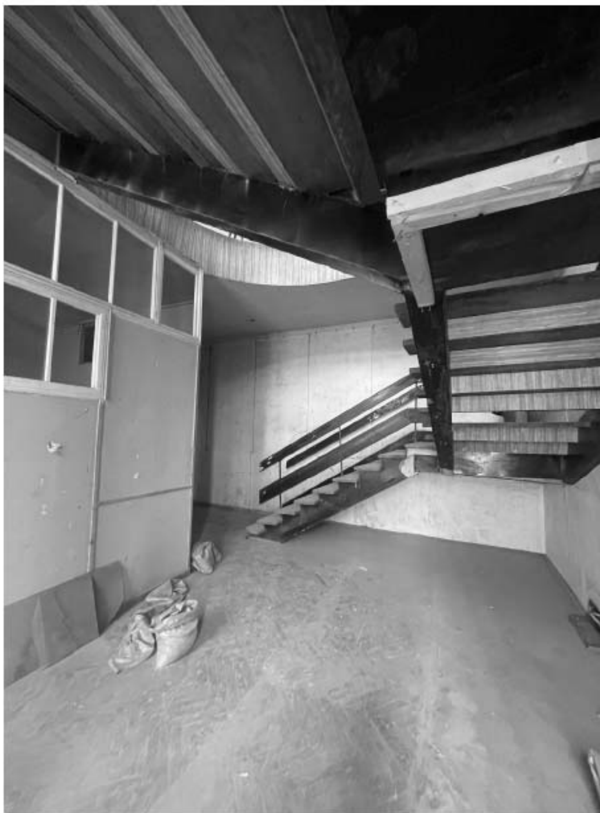
20. Фрагмент интерьера помещения 1-Н (помещение 7/86.8);
