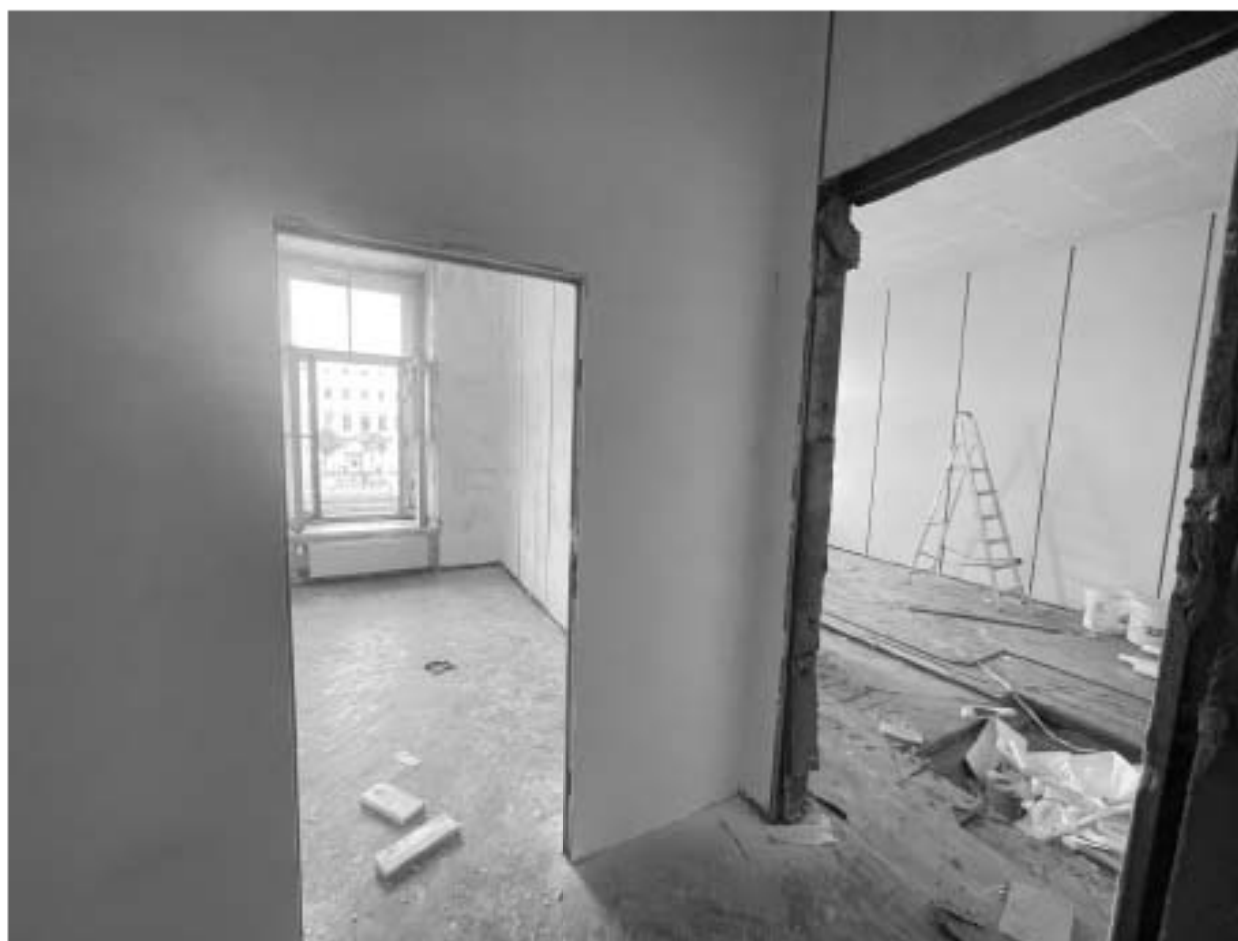
23. Фрагмент интерьера комнаты (помещение 24/12);
