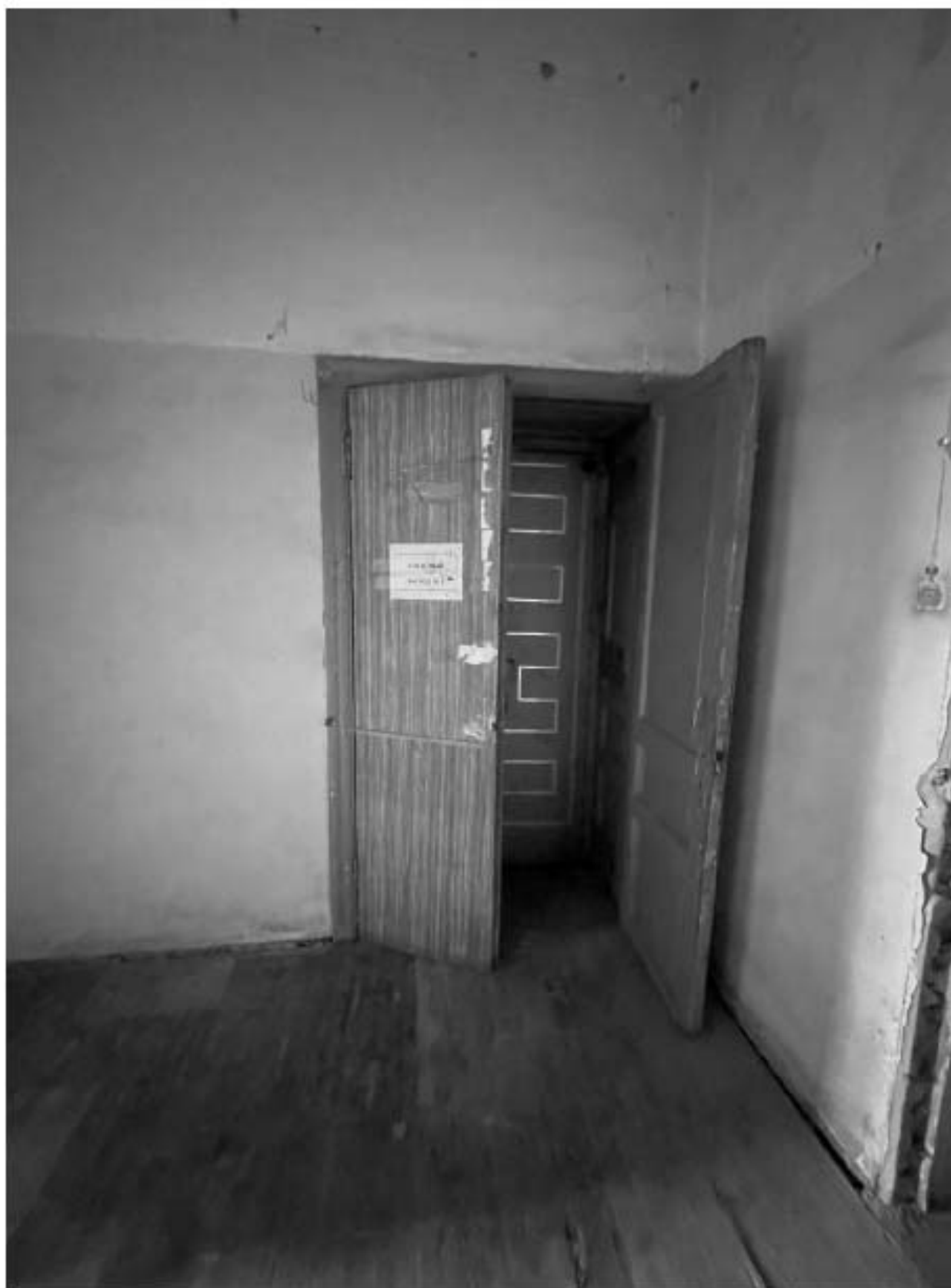
13. Вид на входную дверь в помещении,
