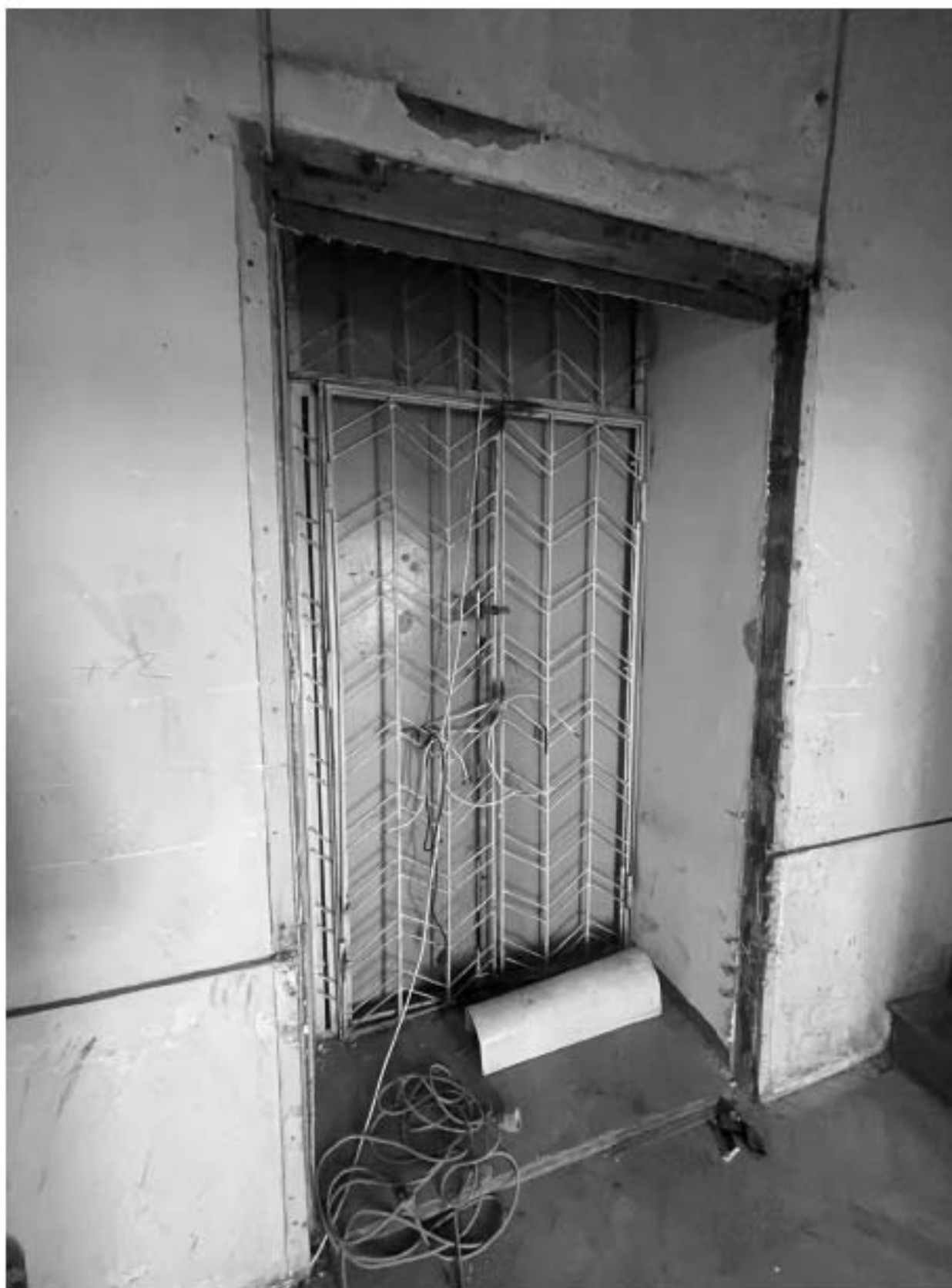
11. Вид на дверь в помещении 1-Н (помещение 15/30.2);
