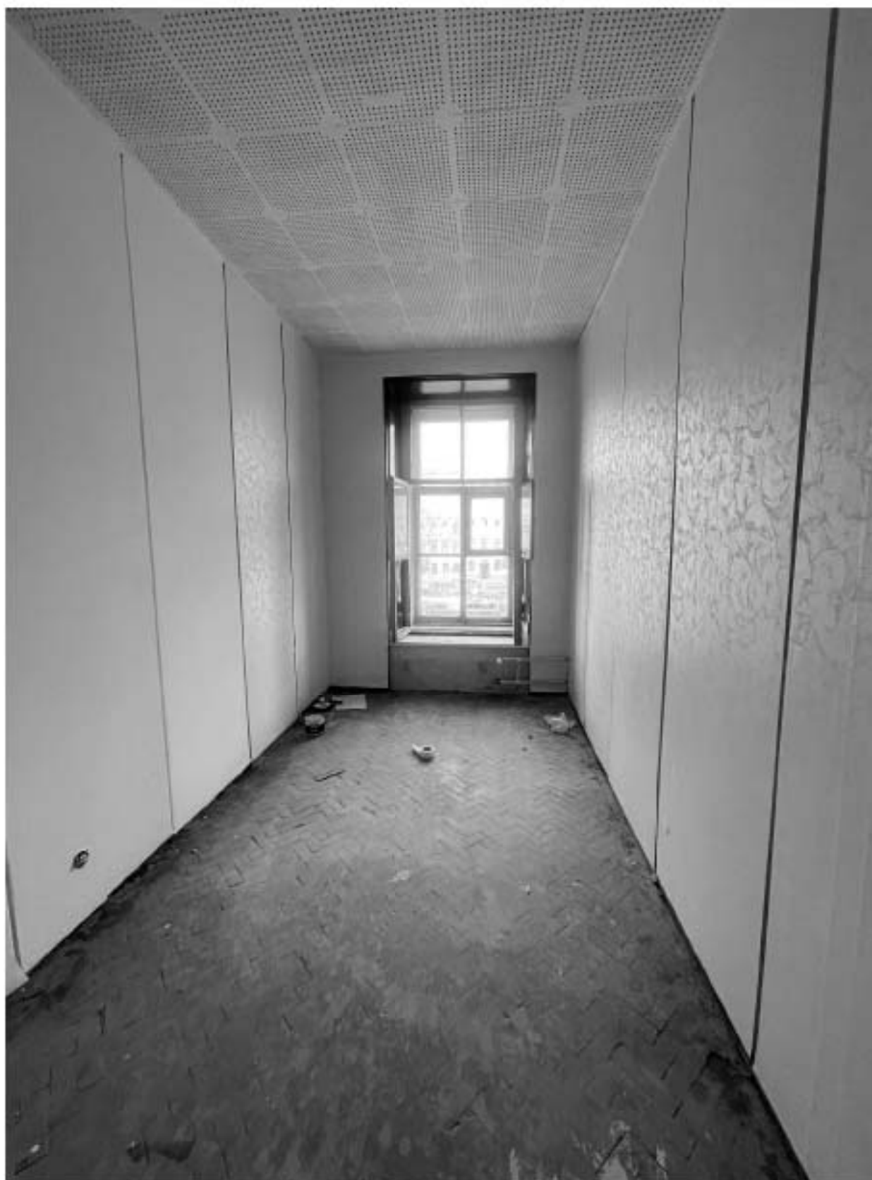
20. Фрагмент интерьера комнаты (помещение 22/12.6);
