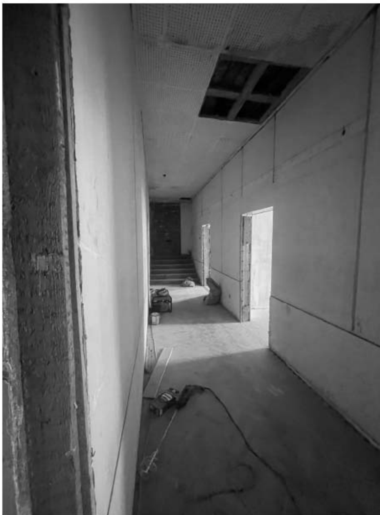
9. Фрагмент интерьера коридора (помещение 15/30.2);
