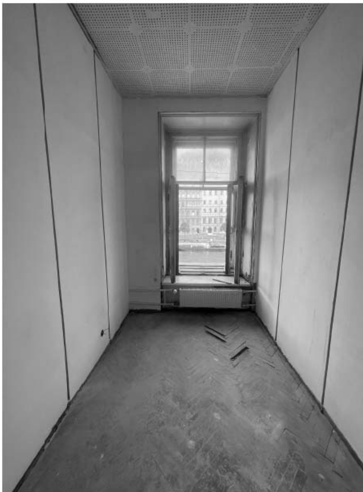
15. Фрагмент интерьера комнаты (помещение 19/11.1);
