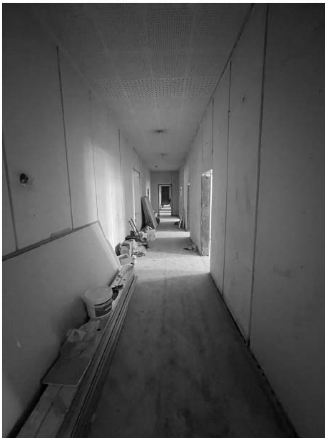
22. Фрагмент интерьера коридора (помещение 26/29.8);
