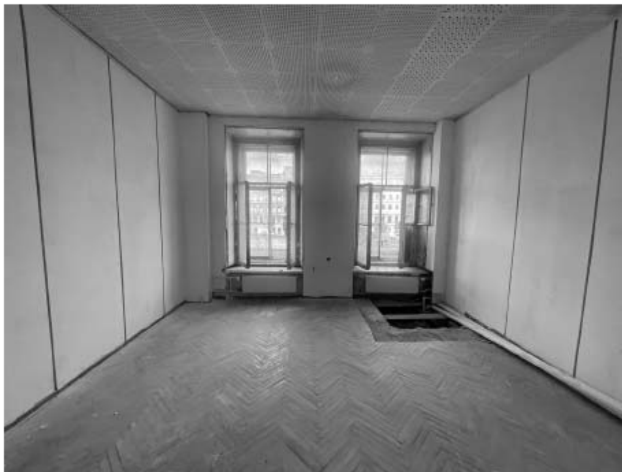
14. Фрагмент интерьера комнаты (помещение 18/24.8);
