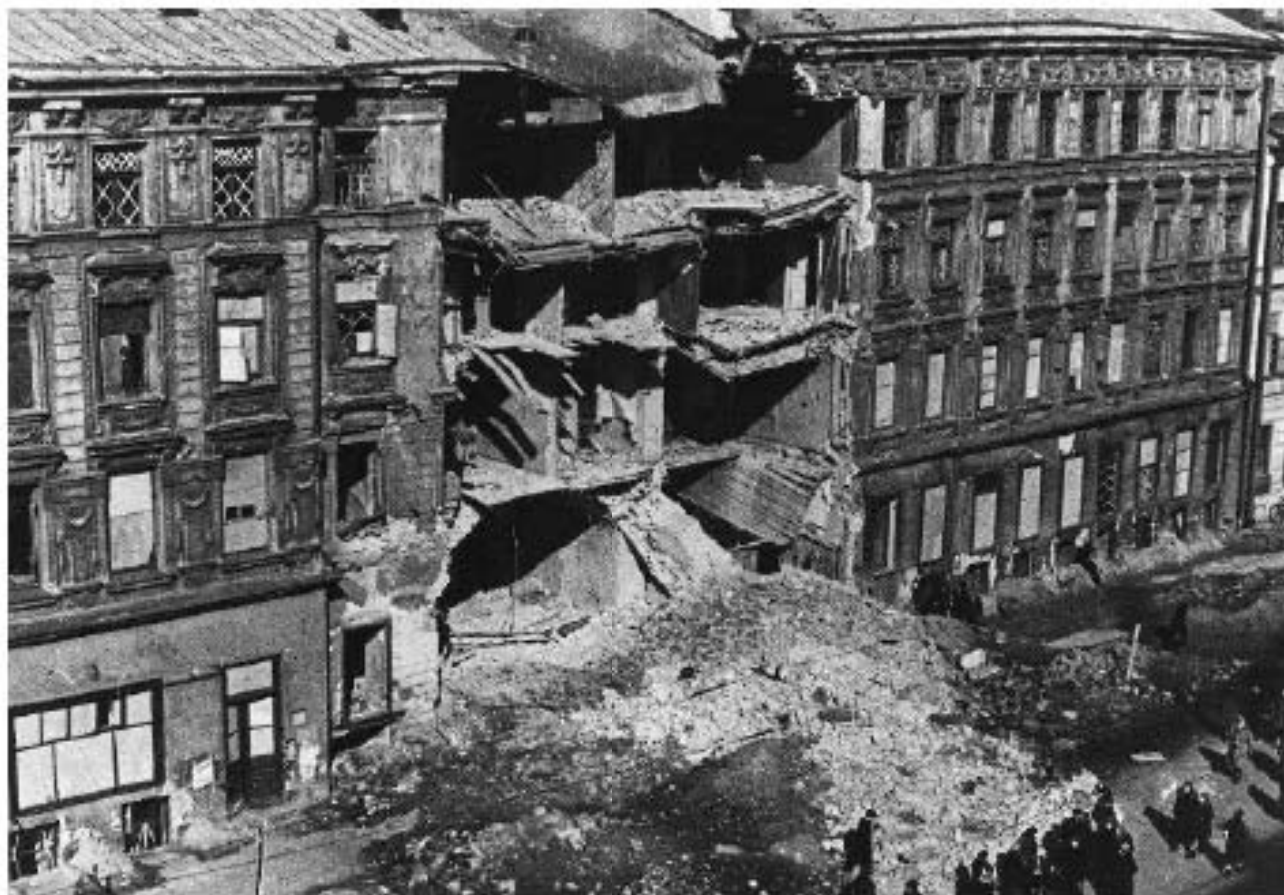
Илл. 35. Здание после попадания в него фугасной бомбы 28 ноября 1941 г. // Сайт: oldsp.ru.
