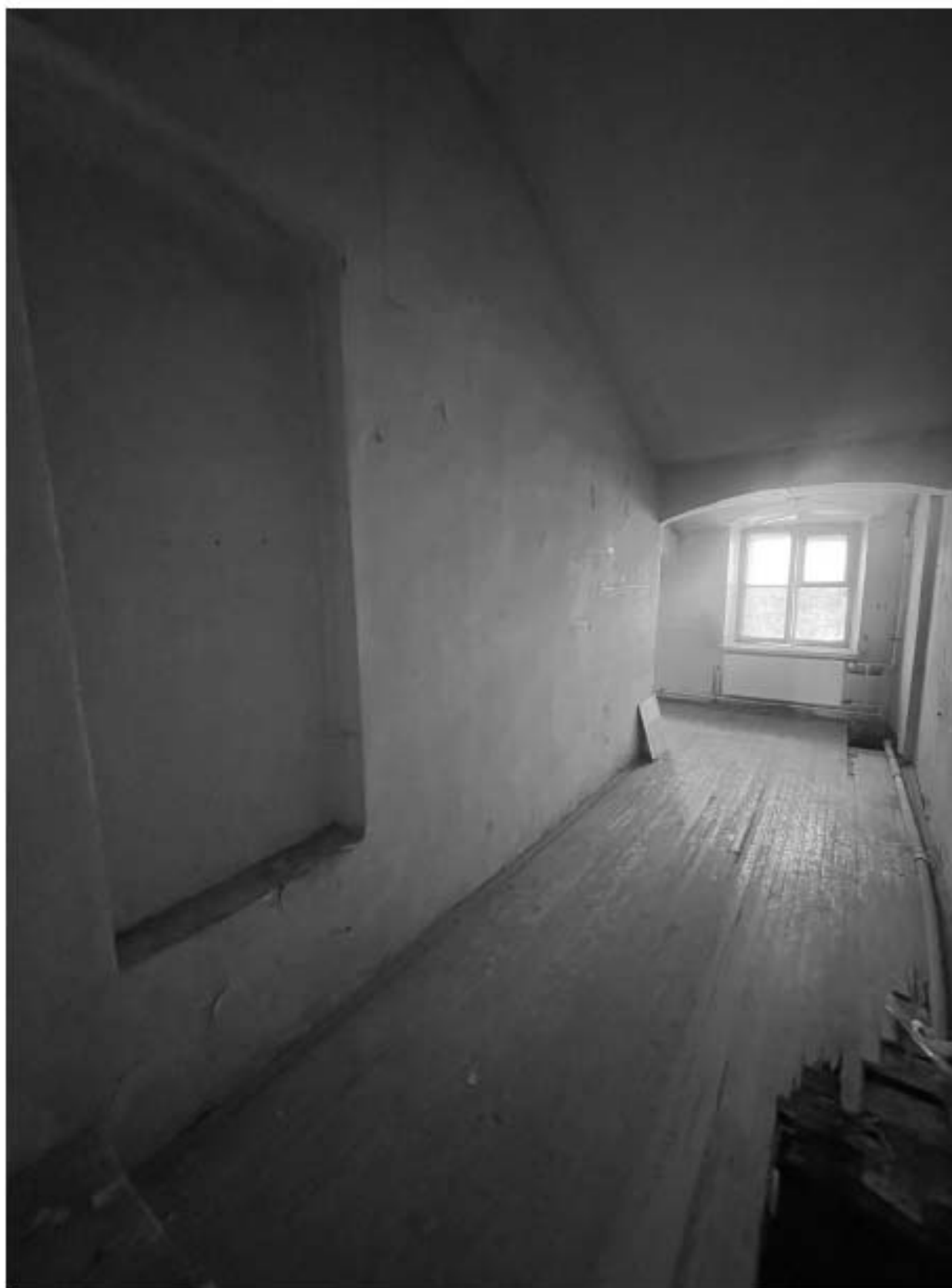
15. Фрагмент интерьера коридора 1-Н (помещение 13/14.1);
