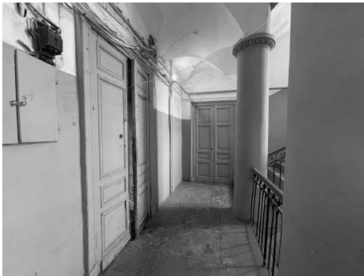
27. Вид на входную дверь в помещение 1-Н.
