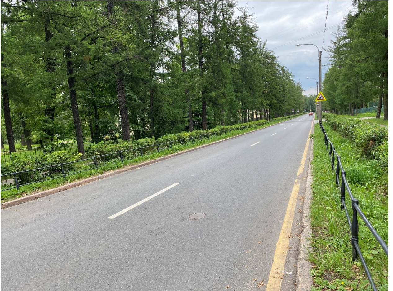
Фото 1. Участок Софийского бульвара между Садовой улицей и Советским переулком. Сентябрь 2024 г.
