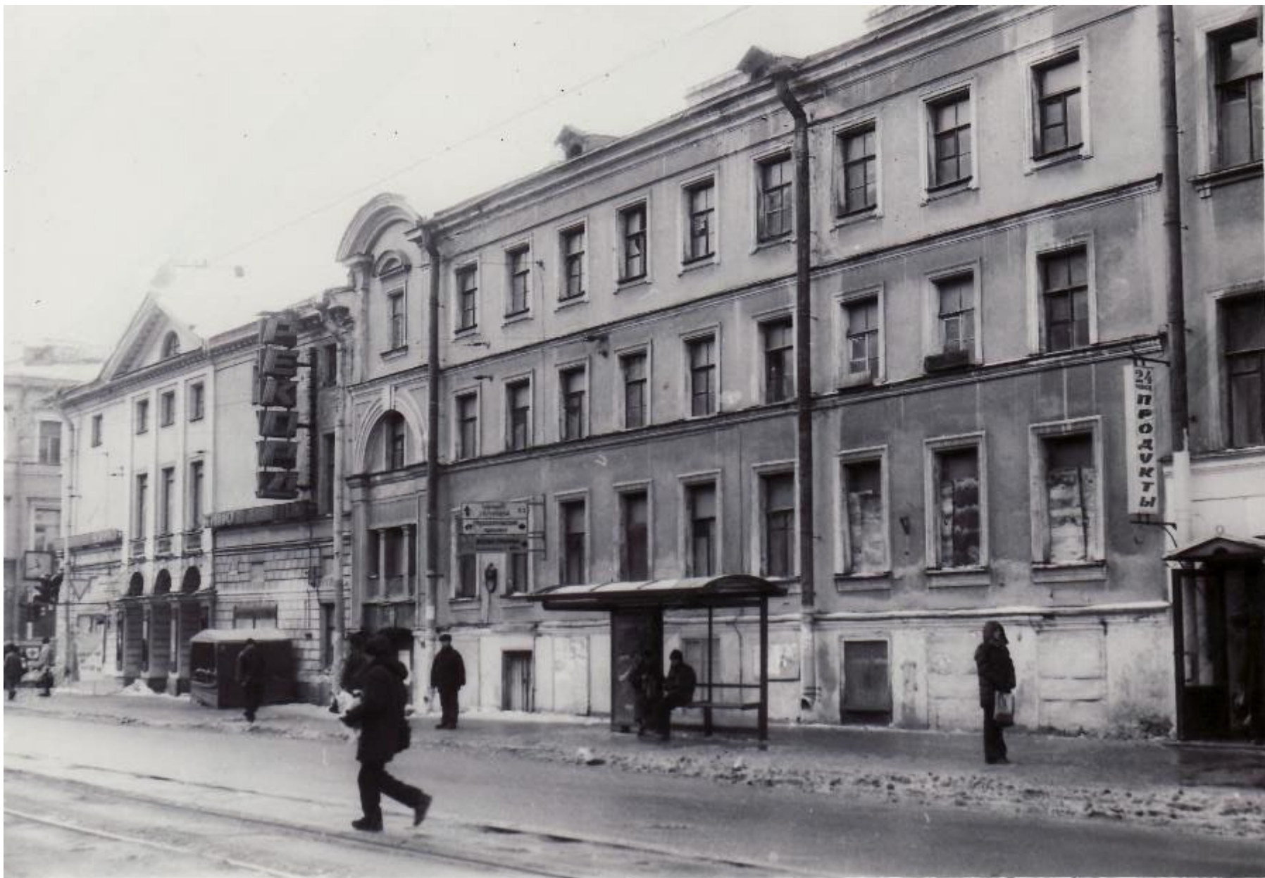
60. Общий вид фасада дома № 73 по улице Садовой (бывший дом архитектора Ц.А. Кавоса, 1853 г.). 22 февраля 2004 г. // ЦГАКФФД СПб. Архивный шифр: Ар 212449.
