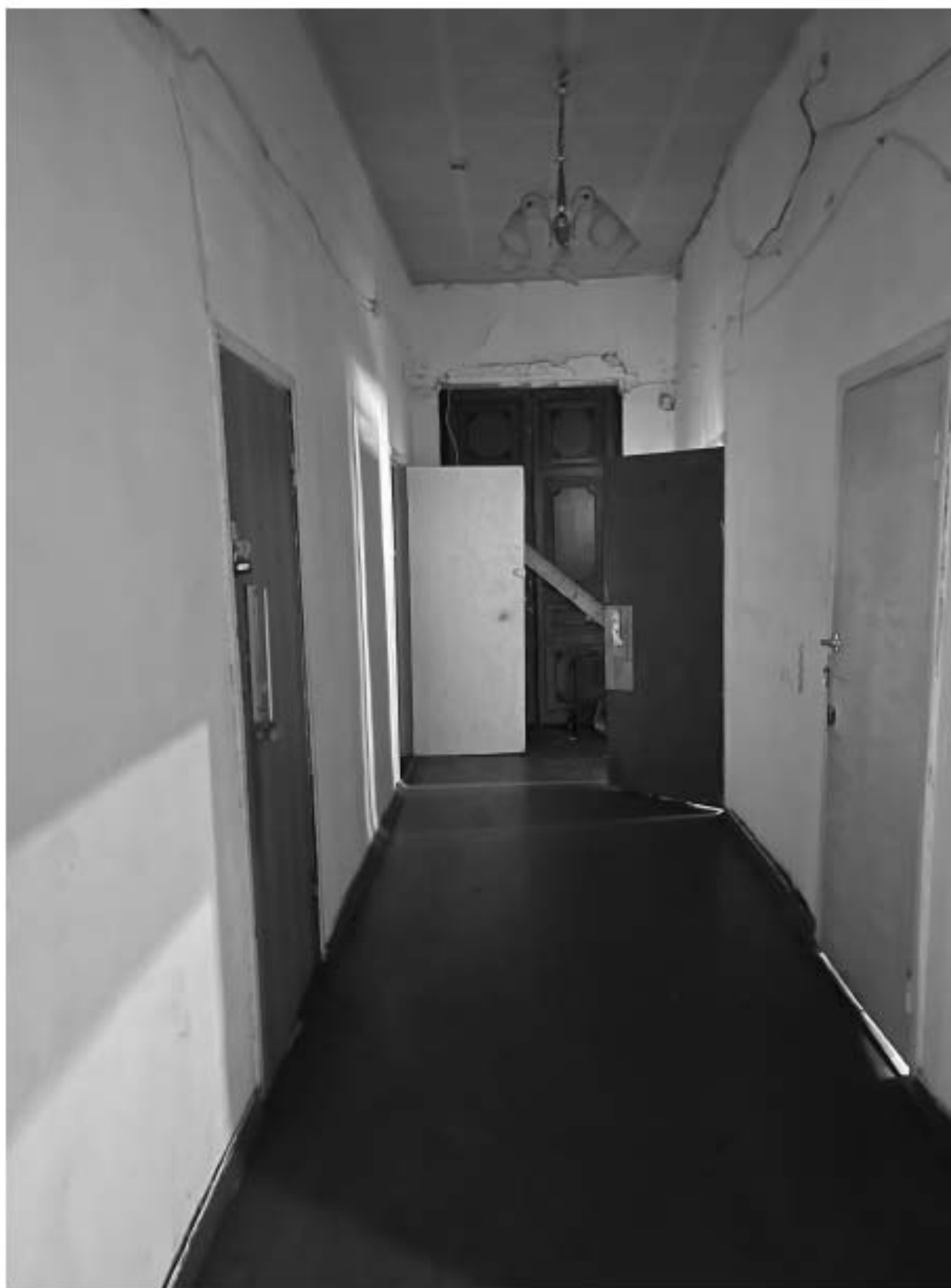
15. Вид на входную дверь в помещение;
