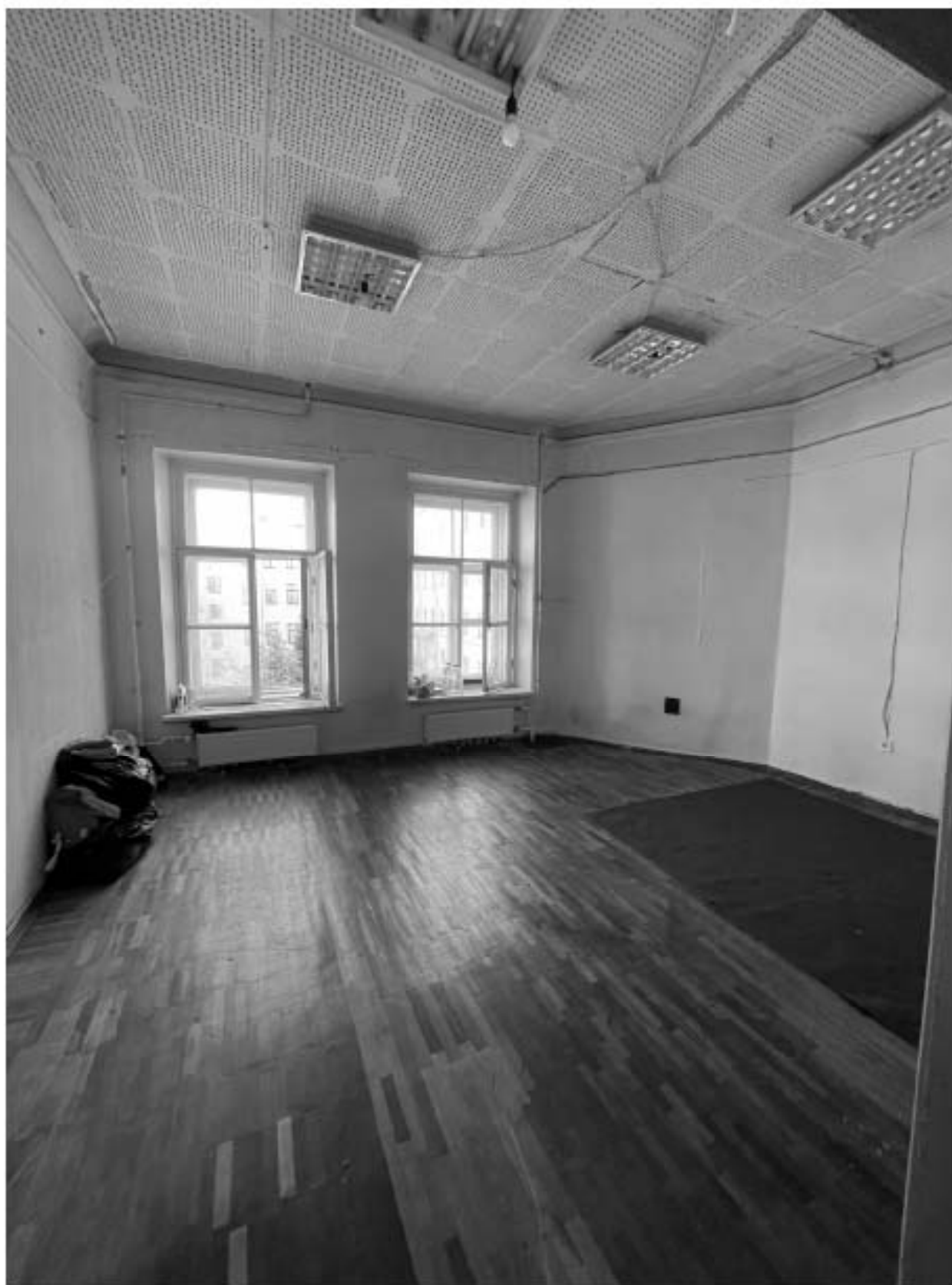
26. Фрагмент интерьера комнаты (помещение 2/26.5);
