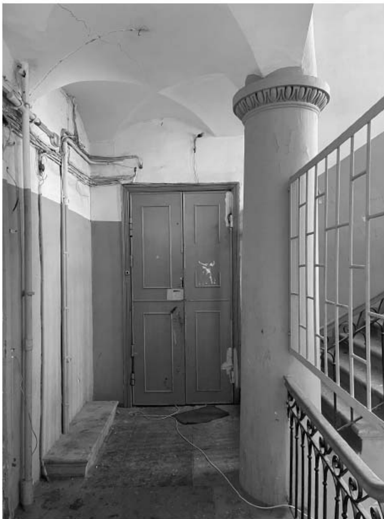
1. Вид на входную дверь в помещение 27-Н;
