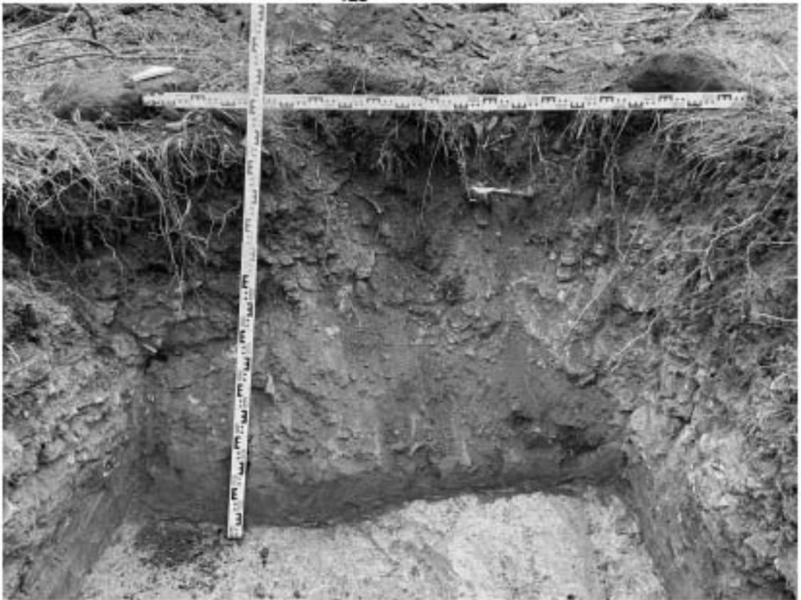
Рис. 72. г. Санкт-Петербург пр. Большевиков, д. 22 корп. 1, лит. А (ЗУ с кадастровым номером 78:12:0006306:2572). Шурф 1. Южный борт. Вид с севера.
