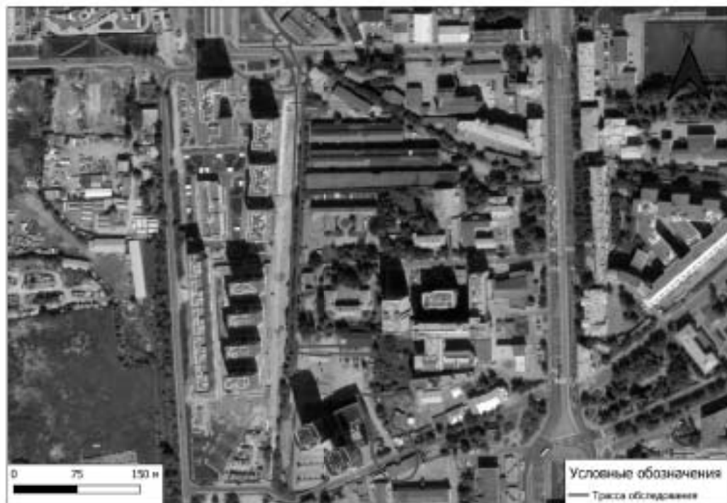
Рис.10. Санкт-Петербург, «Проектирование и строительство Красносельско-Калининской линии от станции «Казаковская» до станции «Обводный канал 2» с электродепо «Красносельское». Участок от станции «Путиловская» до станции «Каретная». Комплекс работ по организации строительства» по адресу: Санкт-Петербург, Фрунзенский, Московский, Кировский районы» Участки трассы обследования на спутниковом снимке Московского района Санкт-Петербурга (ESRI Satellite).
