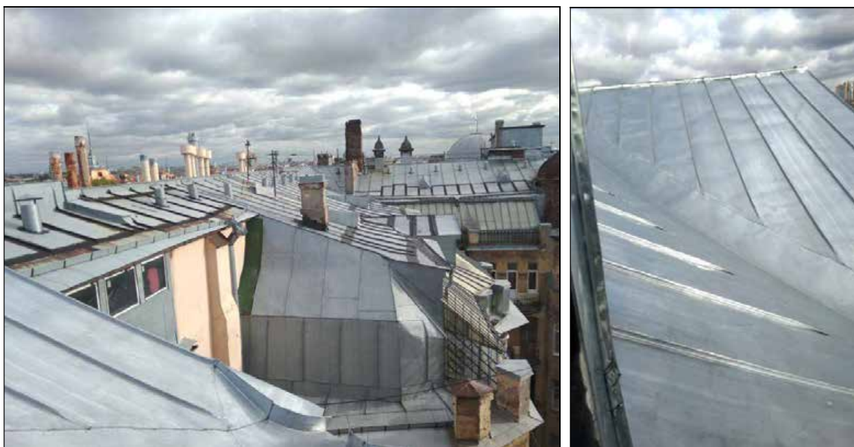
58. Натурная съемка. Фрагменты крыши. 2018. Автор съемки: Куоргти Марина.
