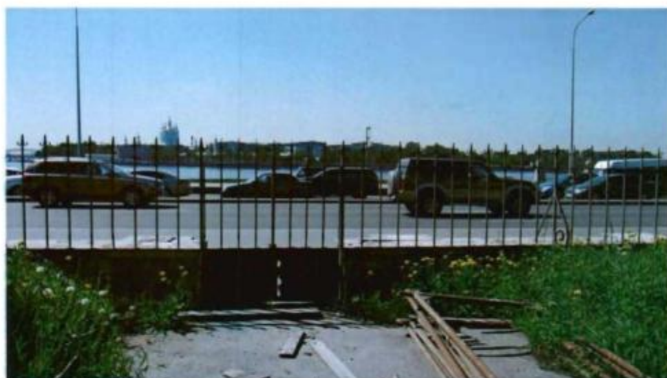
4. Фрагмент северо-восточного фасада объекта культурного наследия.
