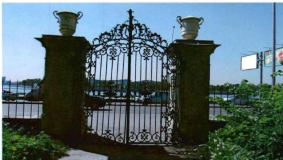
3. Фрагмент северо-восточного фасада объекта культурного наследия. Известняковые пилоны с металлическими вазами и чугунными воротами .
