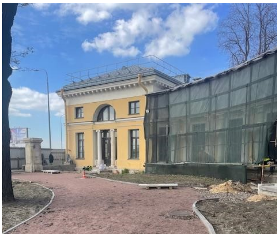
10. Фрагмент западной галереи. Вид на юго-запад. 30.03.2024 г.
