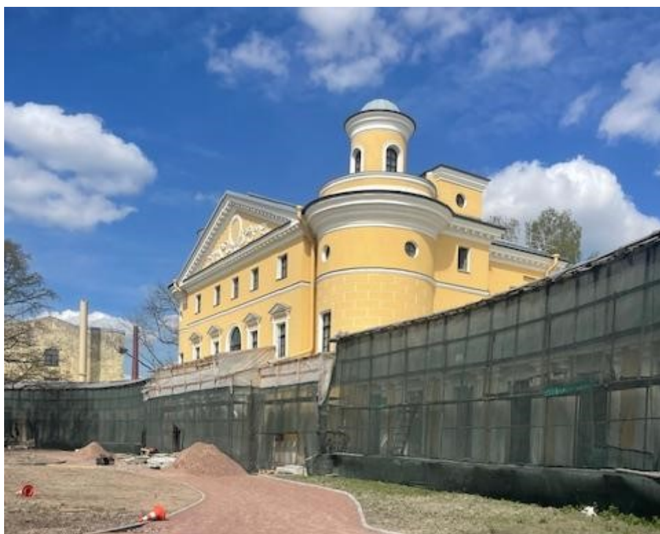
4. Вид на северо-запад от восточного флигеля. 30.03.2024 г.
