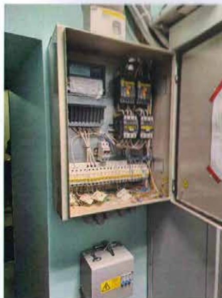
Фото 82. Приборы учета электроэнергии с группой автоматических выключателей в Части 4 (на 1-ом этаже в ч.п. 20 помещения 25-Н).
