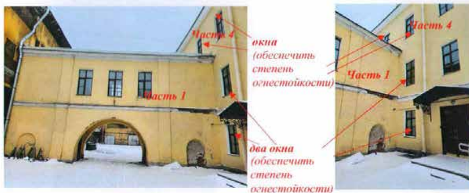
Фото 73. Фрагмент фасадов стен Части 1 и Части 4 здания (линия раздела 3) со стороны Расстанной улицы.
