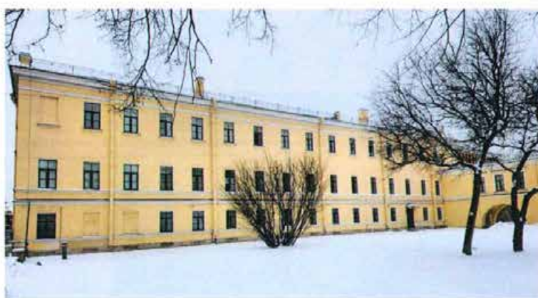
Фото 6. Фрагмент фасада здания (Часть 2) со стороны улицы Расстанная.
