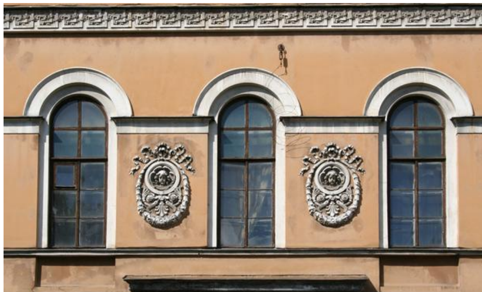
61. Бывший Николаевский дом призрения престарелых и увечных граждан Санкт-Петербургского купеческого общества. Главное здание. Главный фасад (фрагмент). Фотография. 2000-е гг. www.citywalls.ru .
