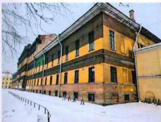
Фото 2. Фрагмент фасада здания (Часть 1) со стороны улицы Расстанная.
