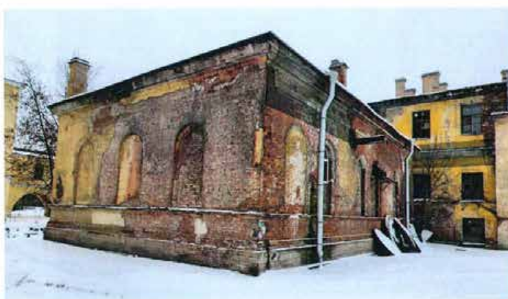
Фото 27. Фрагмент фасадов здания (Часть 1) со стороны Днепропетровской улицы.
