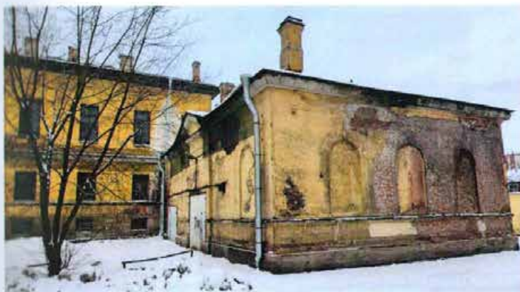
Фото 26. Фрагмент фасадов здания (Часть 1) со стороны Днепропетровской улицы.
