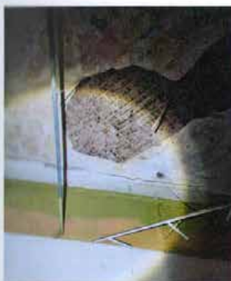
Фото 44. Конструкция междуэтажного перекрытия первого этажа в ч.п. 30 помещения 47-Н (Часть 1)
