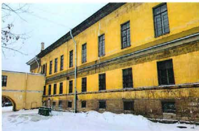
Фото 25. Фрагмент фасада здания (Часть 1) со стороны Днепропетровской улицы.
