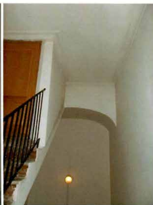
13. Николаевская гимназия (черная лестница и выход на чердак)
