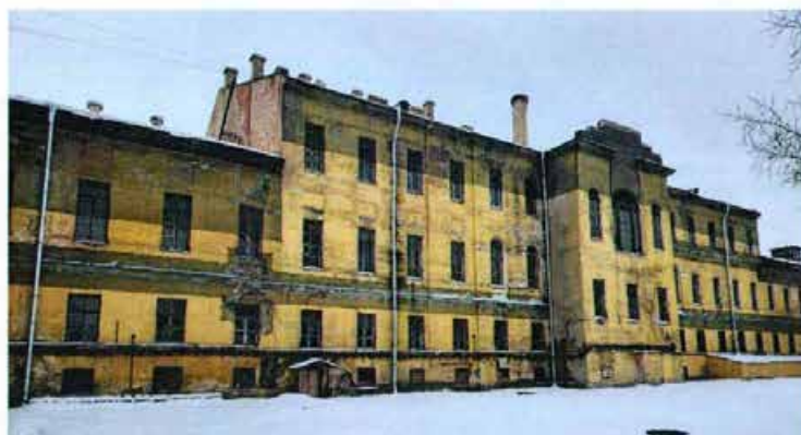
Фото 18. Фрагмент дворовых фасадов здания (Часть 1) со стороны внутриквартальной территории.
