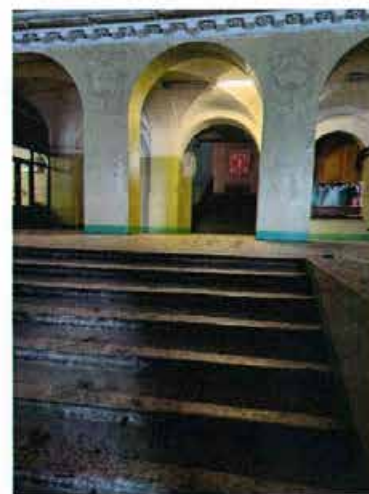
Фото 37. Фрагмент главной лестницы в ч.п. 1 лестницы БЛК (Части 1) на 1-ом этаже.
