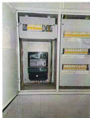
Фото 71. Приборы учета электроэнергии с группой автоматических выключателей в Части 3 (в ч.п. 1 помещения 24-Н).
