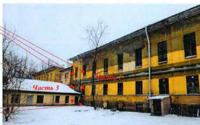
Фото 12. Фрагмент дворовых фасадов здания на границе примыкания Части 3 и Части 1 со стороны Тамбовской улицы.
