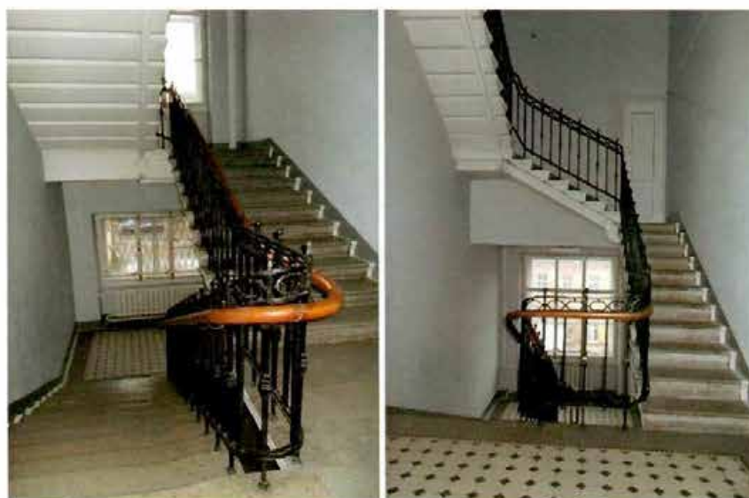
35, 36. Александринская купеческая гимназия (лестница)
