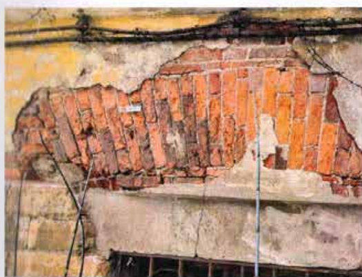
Фото 38. Конструкция наружных стен Части 1 здания с клинчатой перемычкой со стороны Днепропетровской улицы.
