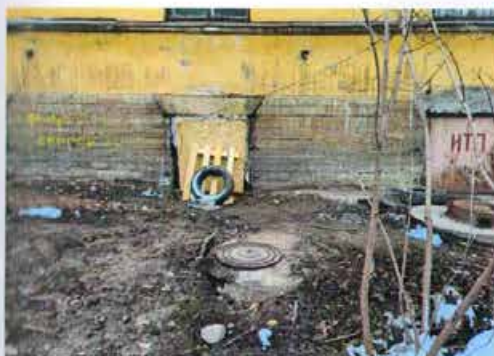
Фото 58. Канализационный колодец Части 1, расположенный со стороны Тамбовской улицы.
