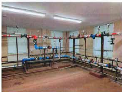
Фото 78. Индивидуальный тепловой пункт в Части 4 (на 1-ом этаже в ч.п. 19 помещения 17-Н).
