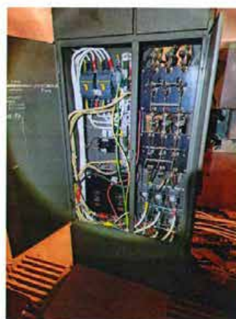
Фото 60. Вводное распределительное устройство системы электроснабжения в ч.п. 1 помещения 45-Н на цокольном этаже (Часть 1).
