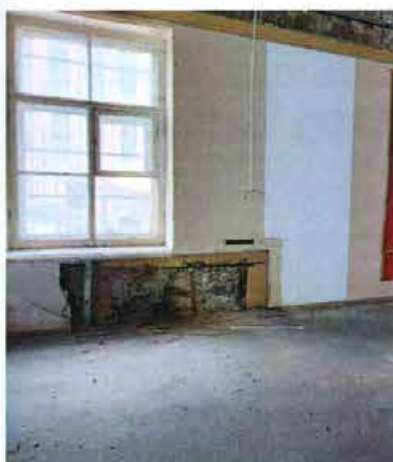
Фото 54. Отсутствие радиаторов отопления в Части 1 здания: на 1 этаже в ч.п. 30 помещения 47-Н и на цокольном этаже в ч.п. 25 помещения 3-Н.
