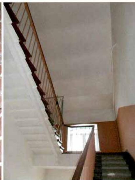
17. Лазарет (лестница 8-ЛК, перекрытия)
