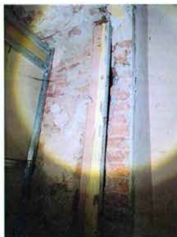
Фото 41. Конструкция внутренних стен
