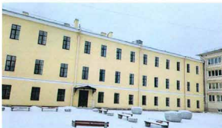
Фото 31. Фрагмент фасада здания (Часть 4) вдоль Днепропетровской улицы.
