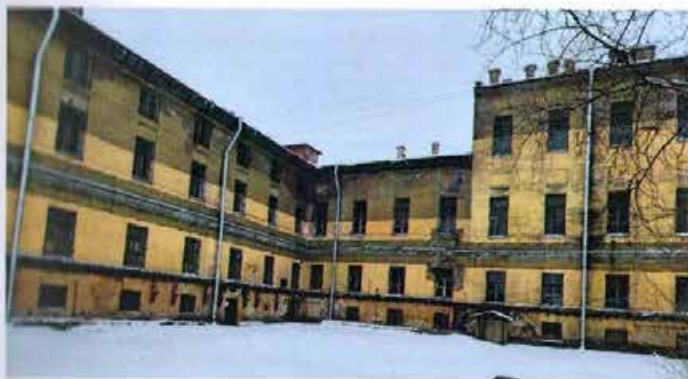
Фото 20. Фрагмент дворовых фасадов здания (Часть 1) со стороны внутриквартальной территории.
