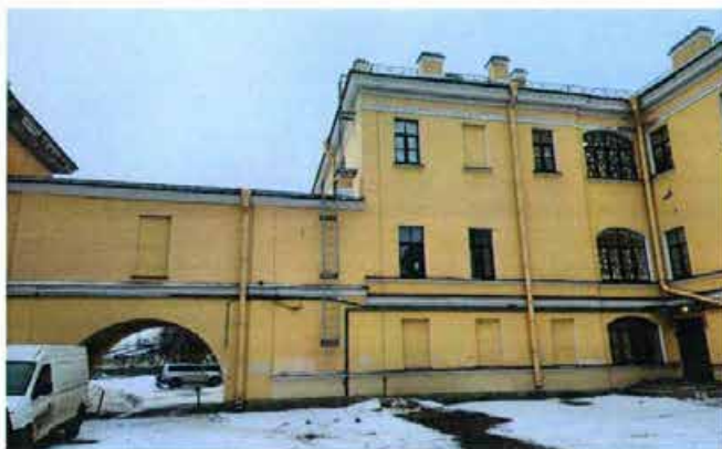
Фото 10. Фрагмент дворовых фасадов здания (Часть 2).
