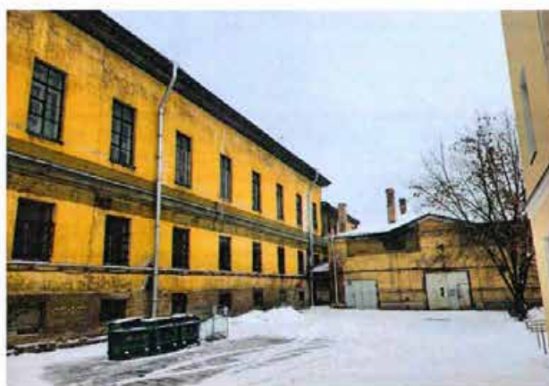
Фото 24. Фрагмент фасада здания (Часть 1) со стороны Днепропетровской улицы.
