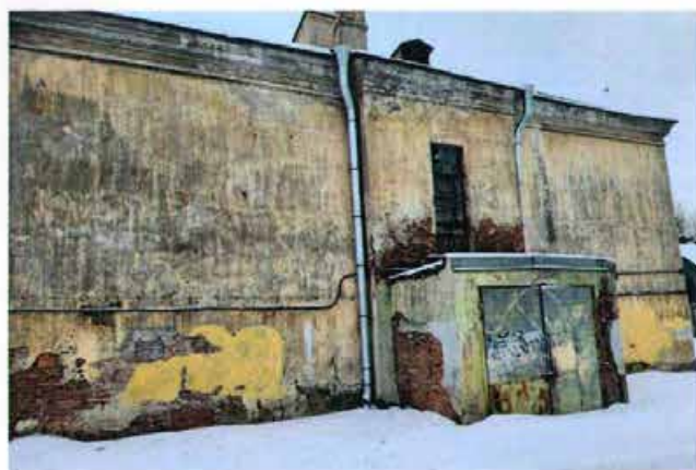
Фото 22. Фрагмент дворового фасада здания (Часть 1) со стороны внутриквартальной территории.
