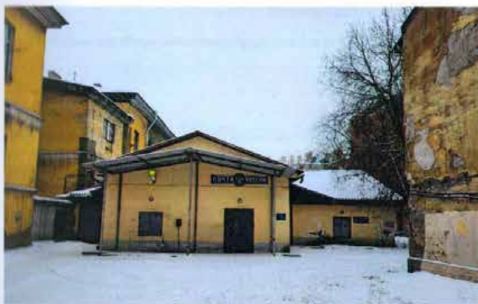
Фото 14. Фрагмент дворовых фасадов здания (Часть 3).
