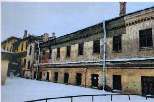
Фото 23. Фрагмент фасада здания (Часть 1) со стороны Днепропетровской улицы.
