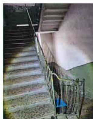
Фото 45. Фрагмент конструкции на 1-ом этаже в ч.п. 1 лестничной клетки 71К (Часть 1)
