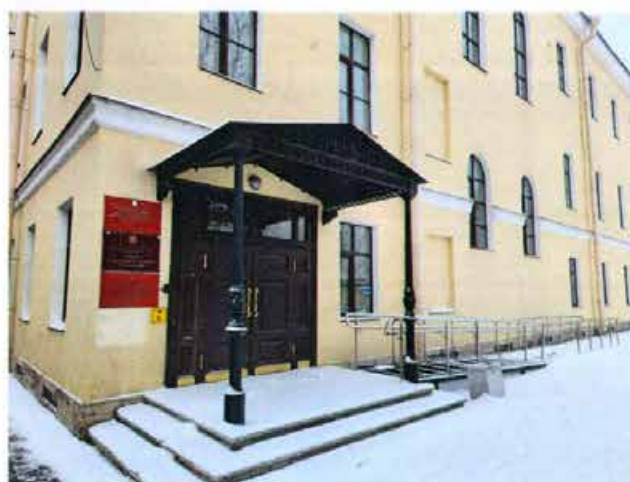
Фото 33. Фрагмент фасада с входной группой в здание (Часть 4) с Днепропетровской улицы.
