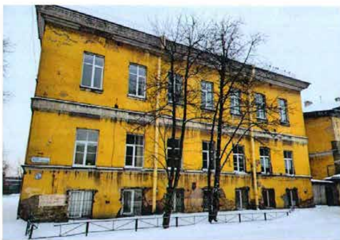
Фото 15. Фрагмент дворового фасада здания (Часть 1) со стороны Тамбовской улицы.
