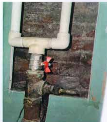
Фото 67. Фрагмент общей кирпичной стены между Частью 1 и Частью 3 (линия раздела 2) на 1-ом этаже в ч.п. 10 помещения 24-Н. Вид со стороны Части 3.
