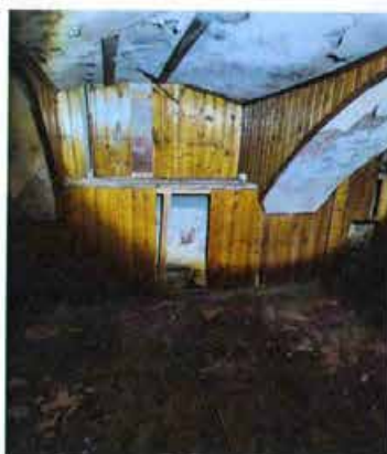
Фото 64. Общая стена между Частью 1 и Частью 3 (линия раздела 2) на цокольном этаже в ч.п. 25 помещения 3-Н (Часть 1).
