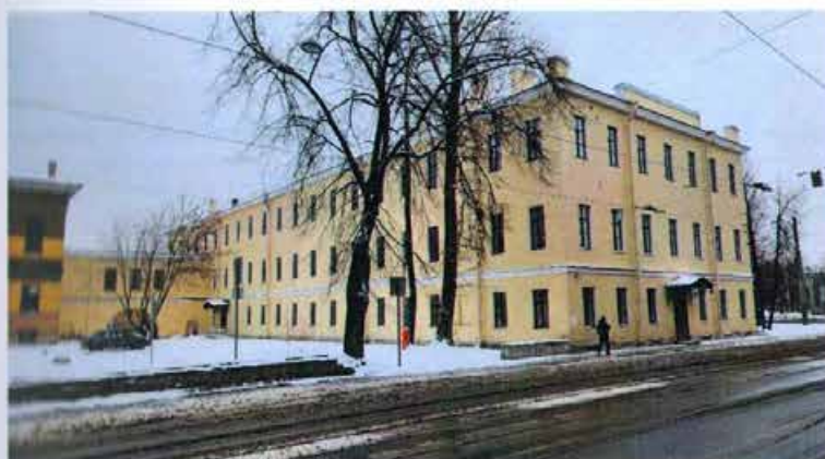
Фото 35. Фрагмент фасадов здания (Часть 1 и Часть 4) вдоль Расстанной улицы.
