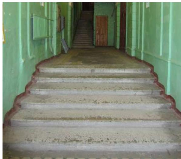
восточная лестница лицевого корпуса, двухмаршевая, с известняковыми ступенями, металлическим кованым ограждением в виде стилизованных стоек с пальметтами, волютами и розетками, с деревянным профилированным поручнем.
