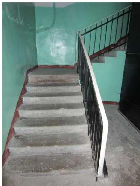
лестница – местоположение (восточный корпус), габариты, тип (двухмаршевая), конструкция (по косоурам), материал ступеней (бетон).
