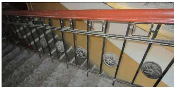
лестница с забежными ступенями (вход на лестницу из юго-восточной части южного внутреннего двора), на косоурах, консольная, с известняковыми ступенями, металлическим кованным ограждением в виде вертикальных прутьев с накладными розетками и фризом в верхнем поясе, с деревянным профилированным поручнем;
