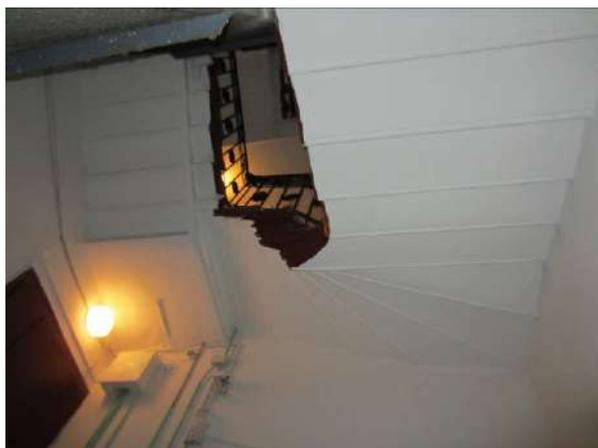
одномаршевая средиственная лестница - местоположение (вход на лестницу из юго-западной части северного внутреннего двора), с металлическим кованым ограждением в виде вертикальных прутьев с накладными розетками и фризом в верхнем поясе, с деревянным профилированным поручнем;
