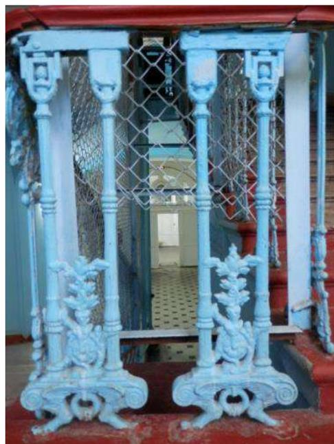
косоурах, с известняковыми ступенями, с площадками, облицованными двухцветной метлахской плиткой (белый, серый), с рисунком «соты», с металлическим ограждением в виде вертикальных стоек с перехватами растительного рисунка сверху и снизу; с профилированным деревянным поручнем;
