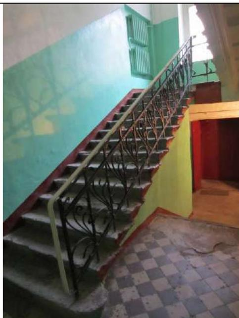
лестница – местоположение (южный корпус), габариты, тип (многомаршевая), конструкция (средистенная), материал ступеней (лещадная плита);
