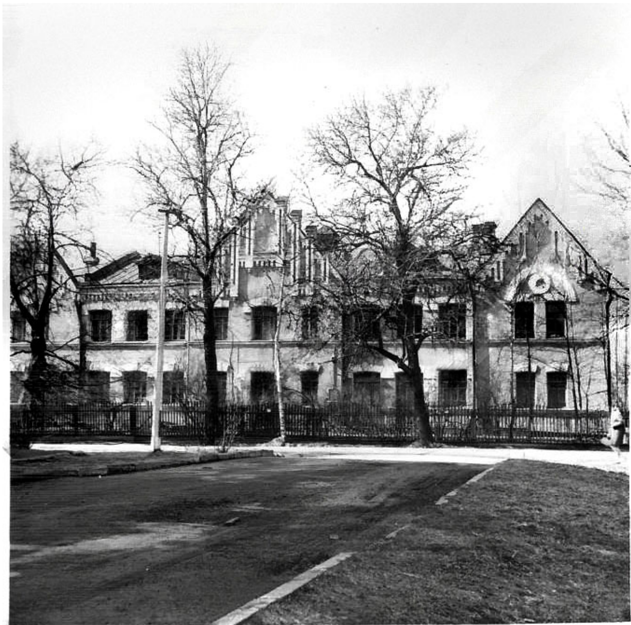
22. Общий вид центрального фасада дома №4 по Ярославскому проспекту (бывшее здание Евангелического приюта во имя Св. Иммануила для детей идиотов и эпилептиков, 1907-1909 гг. - воен. инженер В.П. Стаценко). Фотография. Автор фото – Овчинников Кирилл Владимирович. 1972 г. // Источник: ЦГАКФФД СПб. Фотодокументы. Оп.1БР-57. Ед.хр.73024.
