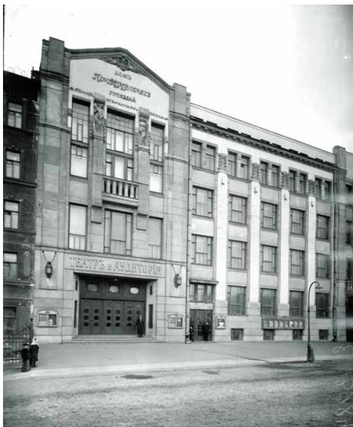
54. Часть фасада Дома Просветительных учреждений после постройки. Фотография 1913 г. ЦГАКФФД. Е 13284
