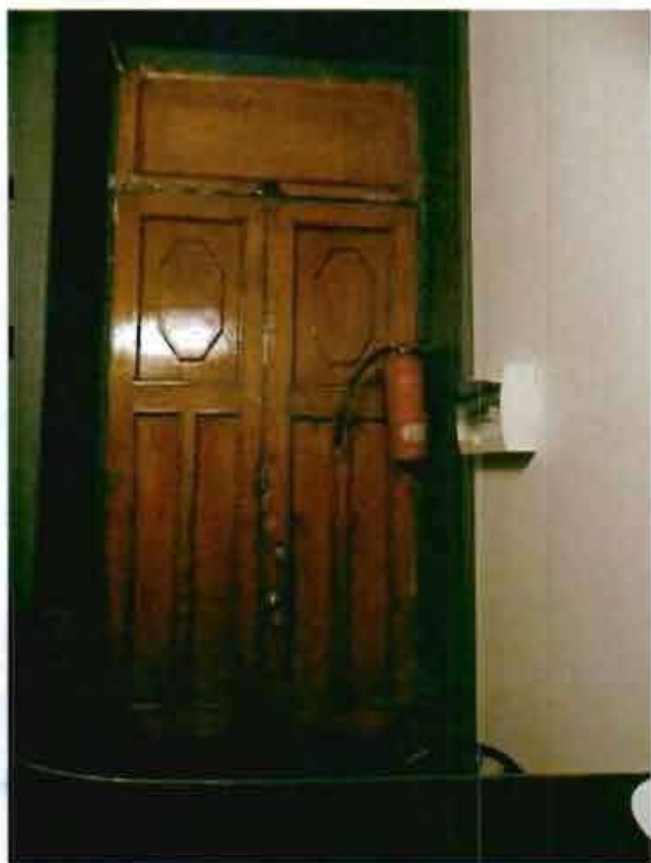
11. Дверные заполнения помещений.
