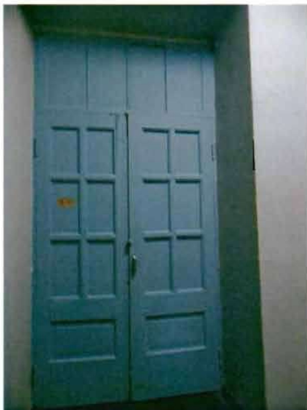
12. Дверные заполнения помещений.
