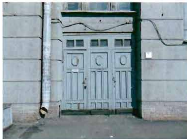
2. Фрагмент южного фасада.
