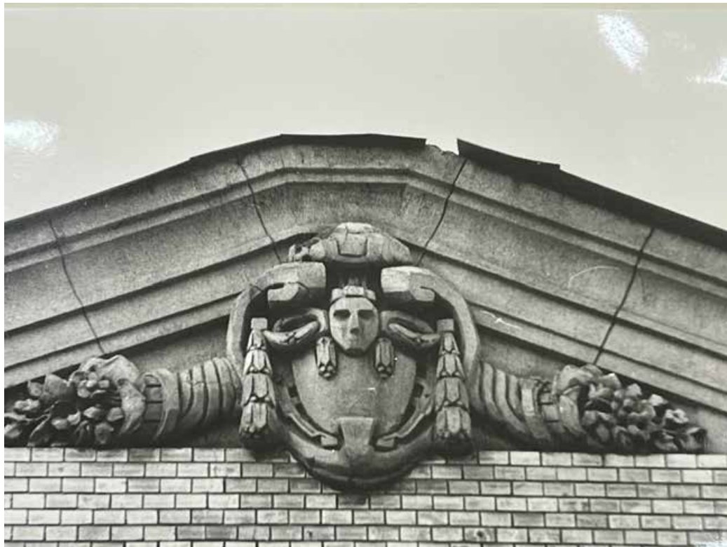
55. Картуш фронтона левого ризалита лицевого фасада Фотография 1990 г
