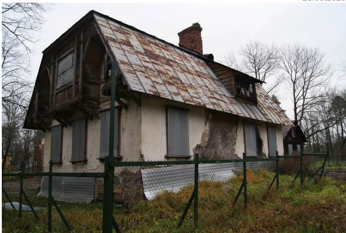
20. Электростанция дворцовая. Дом жилой. Вид с юго-запада. Давыдова Н.А. 26.10.2021.
