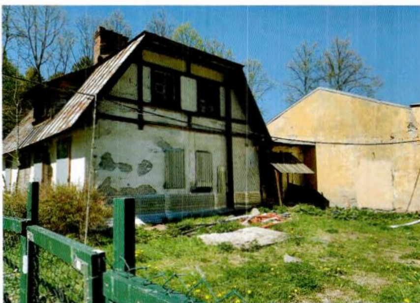
3. Вид на северный и восточный фасады.
