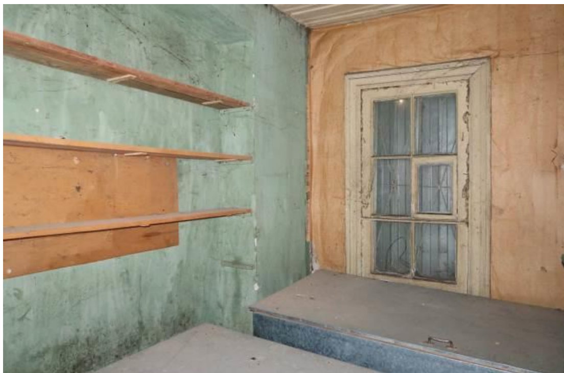
27. Дом жилой. Помещение 1-го этажа, граничащее с электростанцией. Давыдова Н.А. 26.10.2021.
