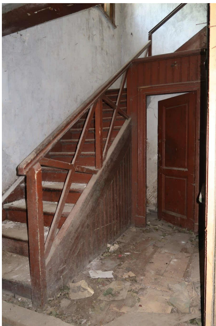
30. Дом жилой. Интерьер лестницы, общий вид. Давыдова Н.А. 26.10.2021.
