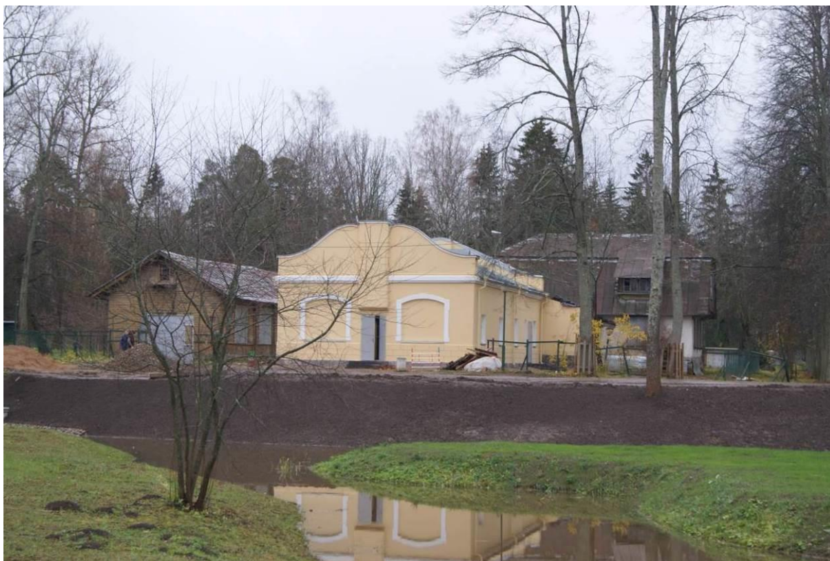
1. Электростанция дворцовая. Дом жилой. Общий вид комплекса с севера. Давыдова Н.А. 26.10.2021.
