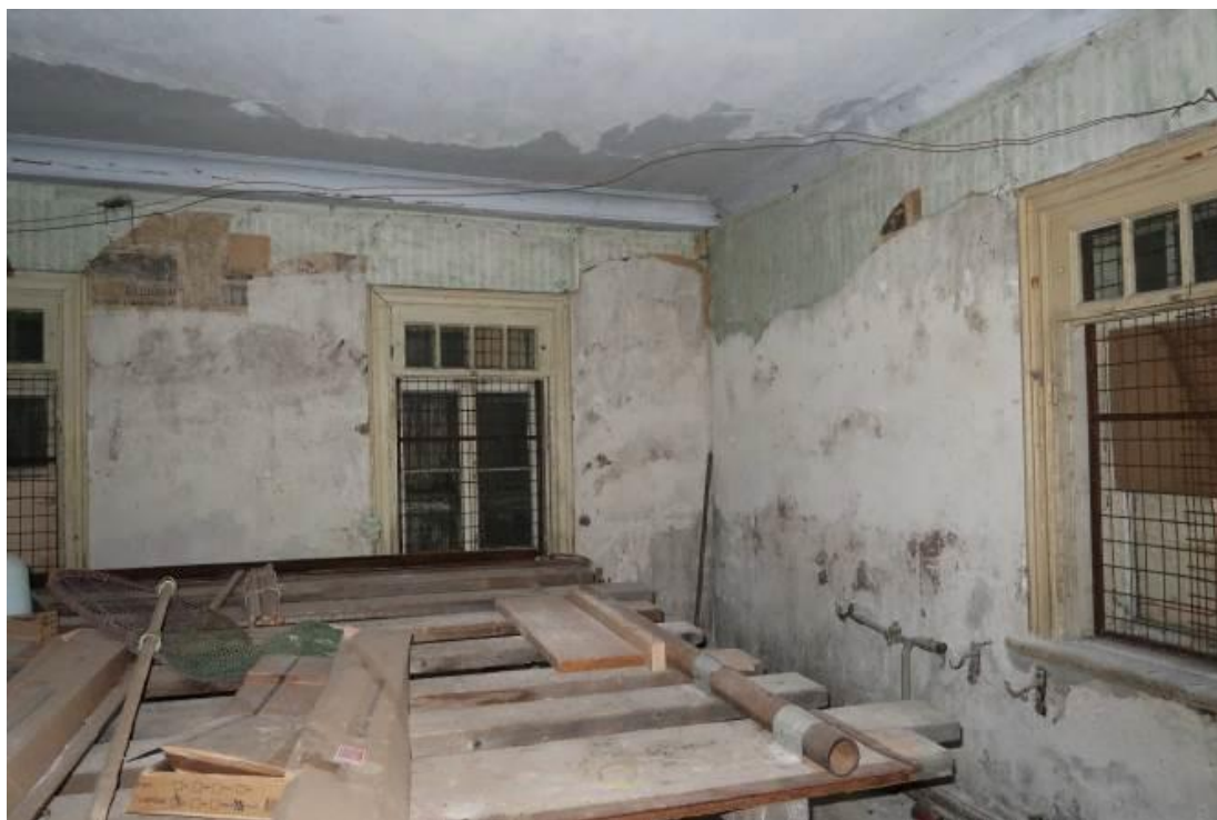
29. Дом жилой. Интерьер помещений 1-го этажа, общий вид. Давыдова Н.А. 26.10.2021.
