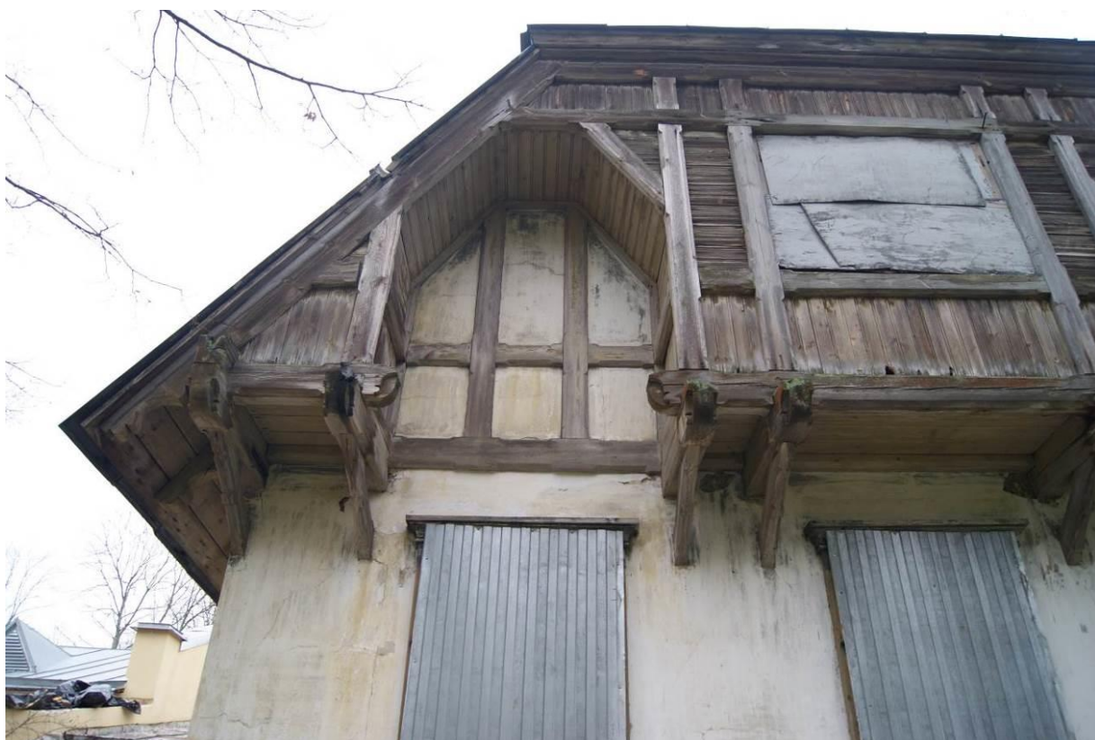
22. Электростанция дворцовая. Дом жилой. Фрагмент западного фасада. Давыдова Н.А. 26.10.2021.
