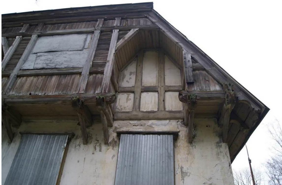
21. Электростанция дворцовая. Дом жилой. Фрагмент западного фасада. Давыдова Н.А. 26.10.2021.
