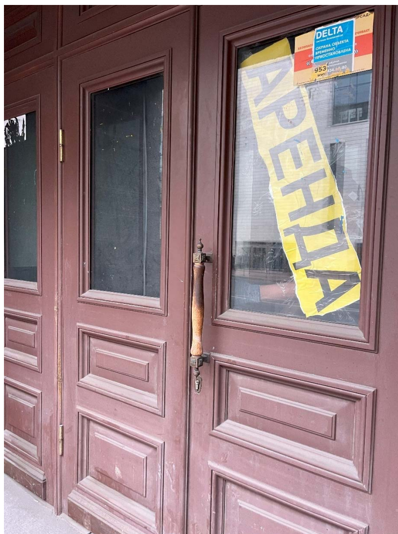
Фото №6. Дверное заполнение входа в помещение 7-Н.
