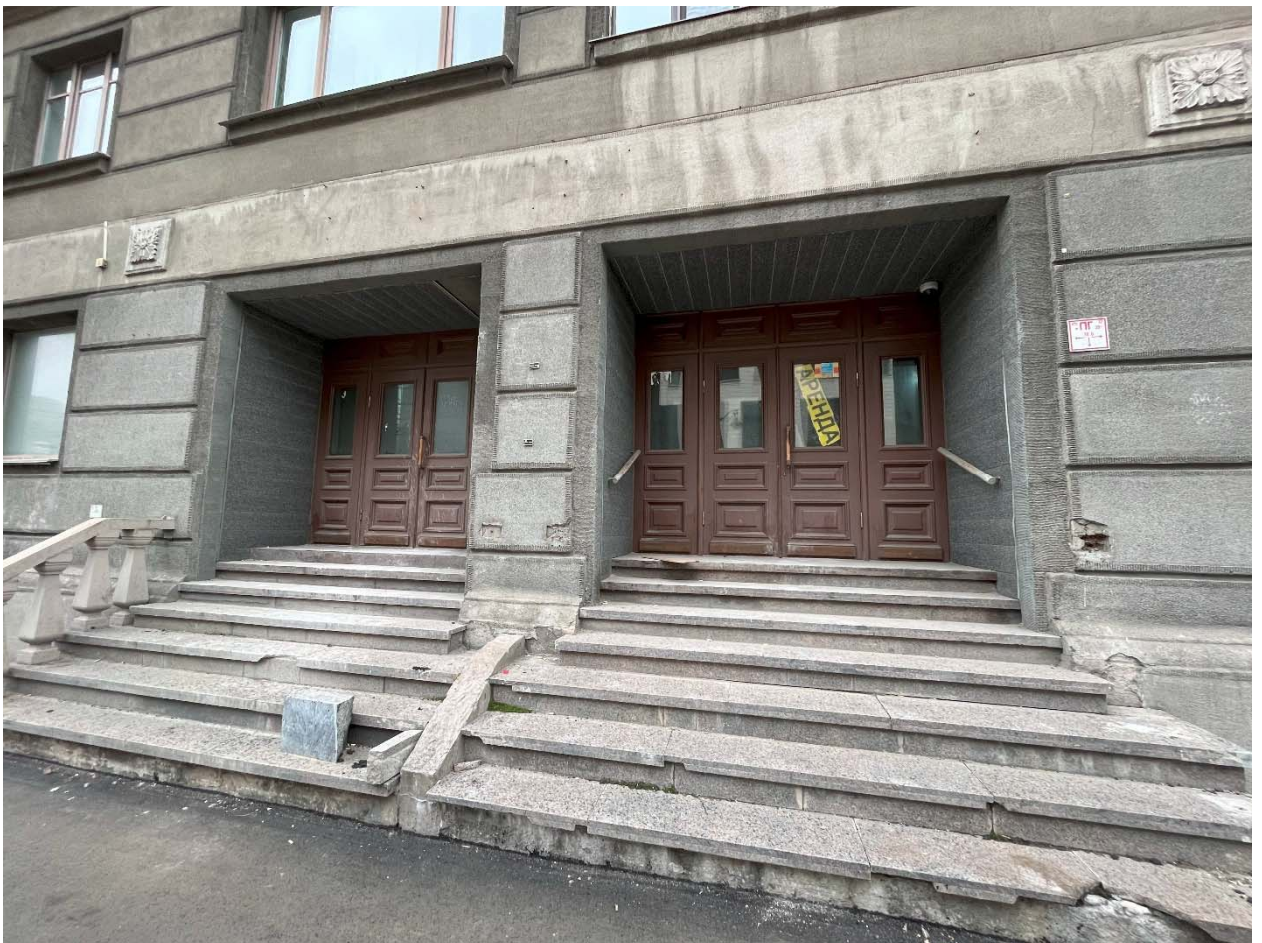
Фото №4. Фрагмент лицевого фасада по улице Декабристов, вход в помещение 7-Н.
