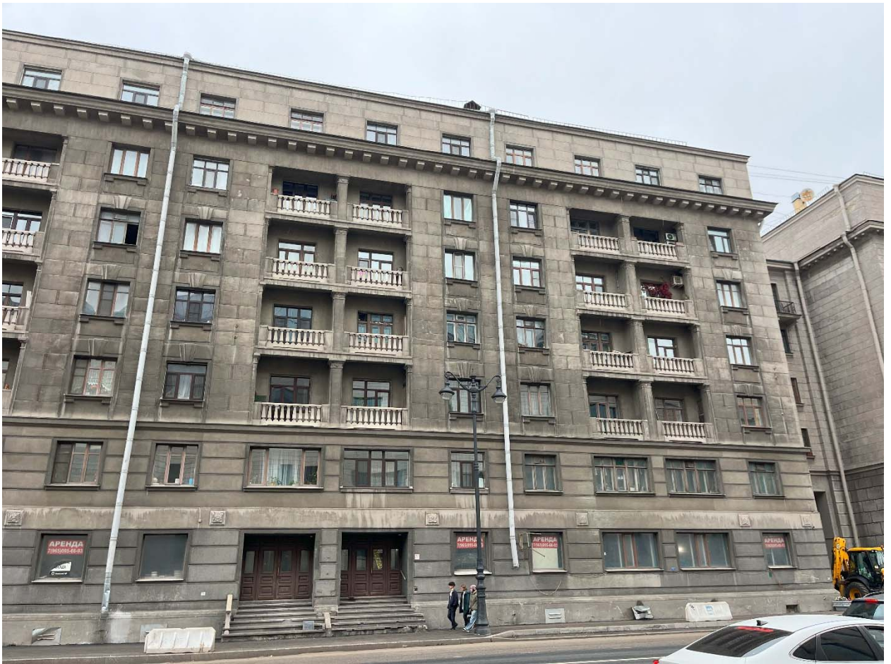
Фото №3. Фрагмент лицевого фасада по улице Декабристов.
