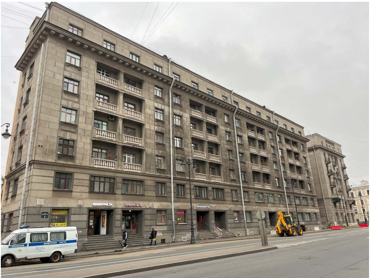
Фото №1. Лицевой фасад по улице Декабристов.
