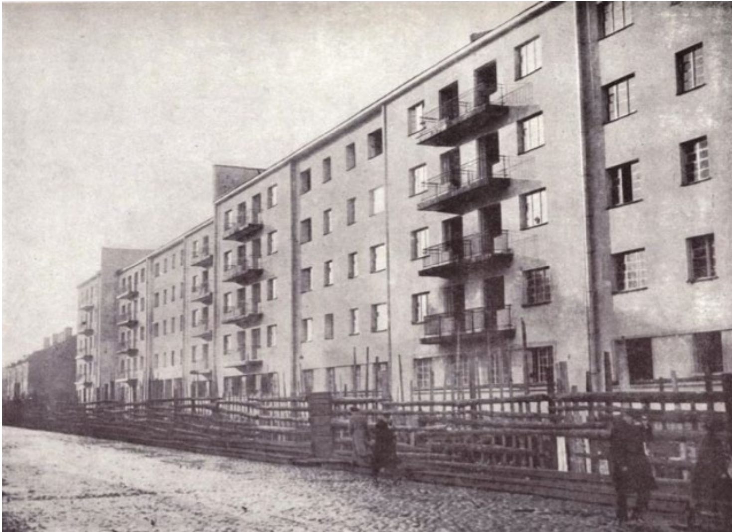
6. Бабуринский жилмассив. Вновь построенный жилой дом для рабочих на Бабуринском переулке. Фотография. 1930 г. // Источник: https://vk.com/@kharchenko_17-zhilmassivy-na-lesnom-prospekte (дата обращения 04.09.2024).
