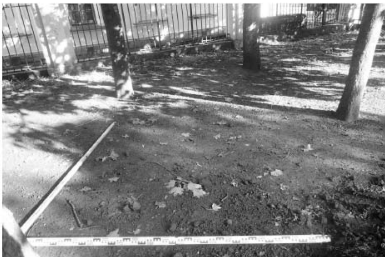
Илл. 95. г. Санкт-Петербург. МО Василеостровский район. Реконструкция наружного освещения парков, садов и скверов с внедрением энергосберегающего и энергетически эффективного оборудования объекта: Благовещенский сад, Шурф №4. До начала работ. Вид с юга.
