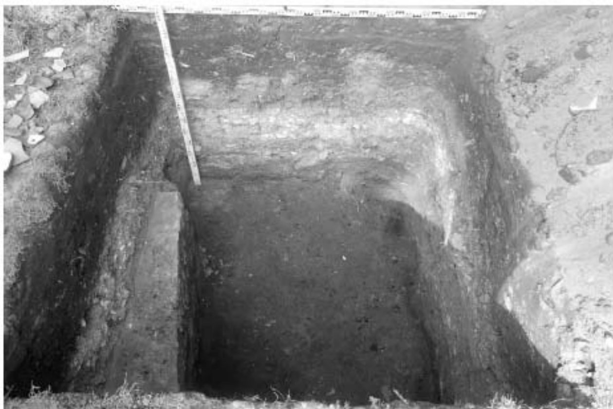
Илл. 74. г. Санкт-Петербург. МО Василеостровский район. Реконструкция наружного освещения парков, садов и скверов с внедрением энергосберегающего и энергетически эффективного оборудования объекта: Благовещенский сад, Шурф №3. Зачистка по основанию Пласта №3. Вид с юга.
