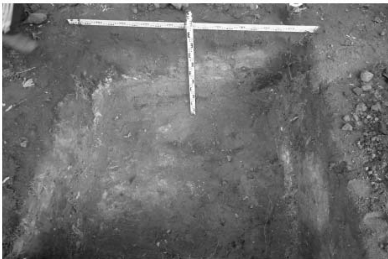
Илл. 96. г. Санкт-Петербург. МО Василеостровский район. Реконструкция наружного освещения парков, садов и скверов с внедрением энергосберегающего и энергетически эффективного оборудования объекта: Благовещенский сад, Шурф №4. Зачистка по основанию Пласта №1. Вид с юга.
