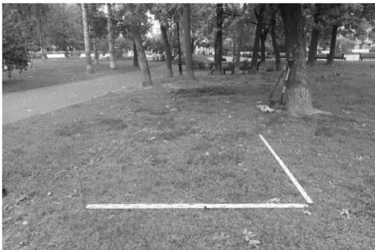
Илл. 50. г. Санкт-Петербург. МО Василеостровский район. Реконструкция наружного освещения парков, садов и скверов с внедрением энергосберегающего и энергетически эффективного оборудования объекта: Благовещенский сад, Шурф №2. До начала работ. Вид с юга.
