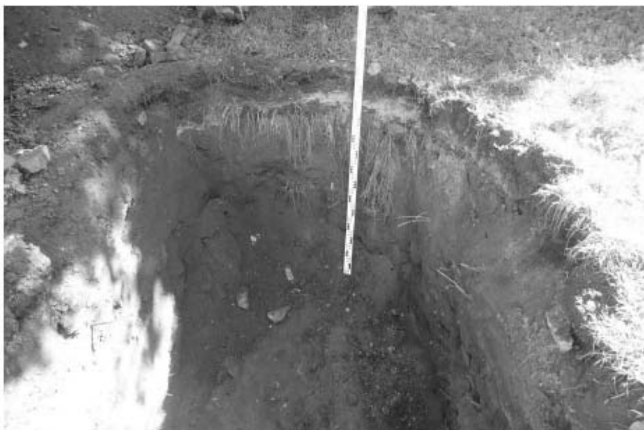
Илл. 19. г. Санкт-Петербург. МО Василеостровский район. Реконструкция наружного освещения парков, садов и скверов с внедрением энергосберегающего и энергетически эффективного оборудования объекта: Благовещенский сад. Нарушение целостности культурных напластований (котлованы ННБ) при прокладке водопровода. Вид с северо-запада.
