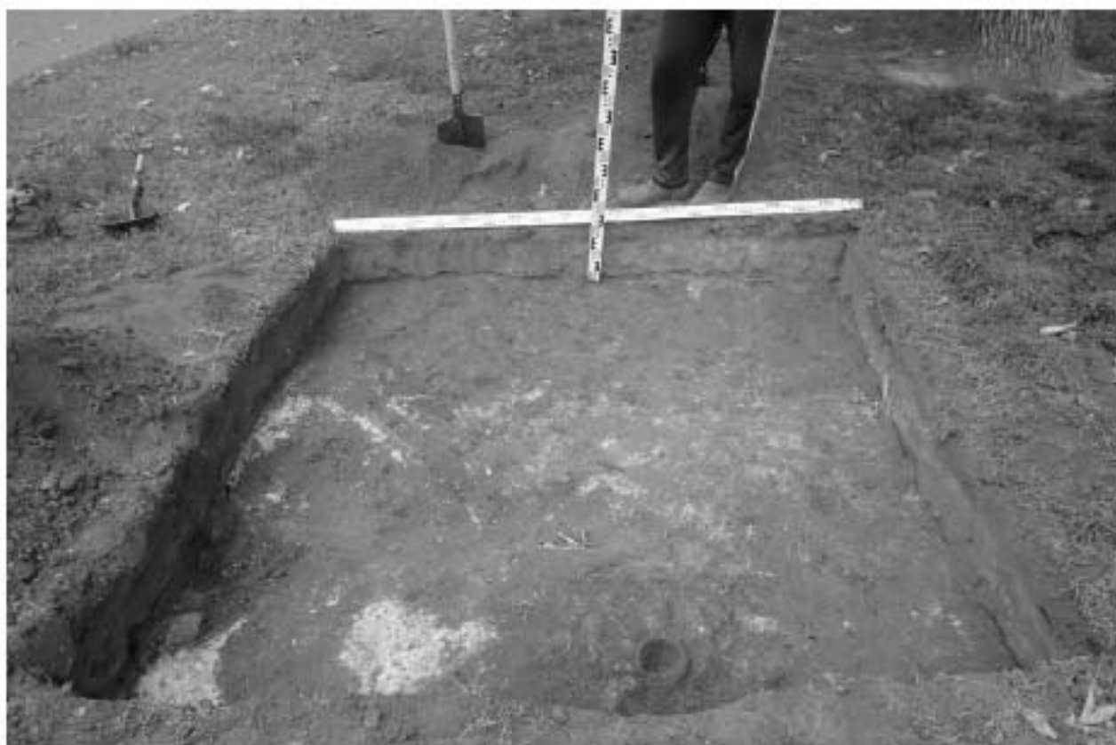
Илл. 52. г. Санкт-Петербург. МО Василеостровский район. Реконструкция наружного освещения парков, садов и скверов с внедрением энергосберегающего и энергетически эффективного оборудования объекта: Благовещенский сад, Шурф №2. Зачистка по основанию Пласта №1. Вид с юга.
