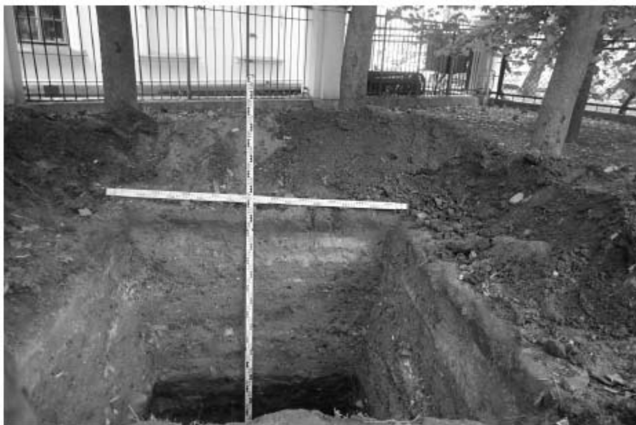
Илл. 108. г. Санкт-Петербург. МО Василеостровский район. Реконструкция наружного освещения парков, садов и скверов с внедрением энергосберегающего и энергетически эффективного оборудования объекта: Благовещенский сад. Шурф №4. Северная стенка с включением окружающего пейзажа. Вид с юга.
