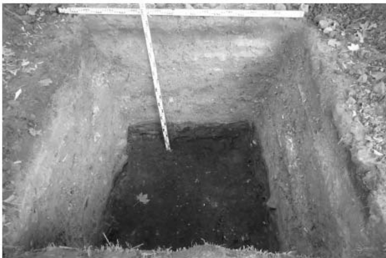
Илл. 98. г. Санкт-Петербург. МО Василеостровский район. Реконструкция наружного освещения парков, садов и скверов с внедрением энергосберегающего и энергетически эффективного оборудования объекта: Благовещенский сад, Шурф №4. Зачистка по основанию Пласта №2. Вид с юга.
