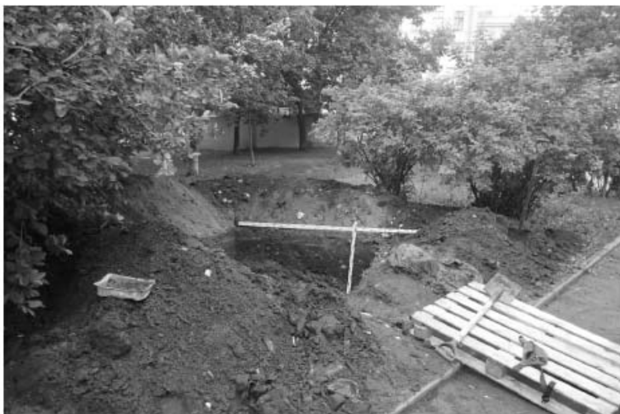
Илл. 91. г. Санкт-Петербург. МО Василеостровский район. Реконструкция наружного освещения парков, садов и скверов с внедрением энергосберегающего и энергетически эффективного оборудования объекта: Благовещенский сад, Шурф №3. Северная стенка с включением окружающего пейзажа. Вид с юга.
