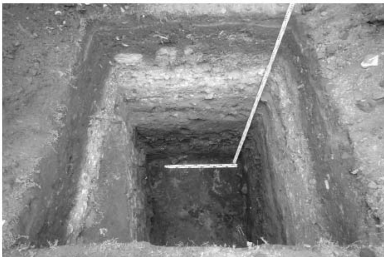
Илл. 78. г. Санкт-Петербург. МО Василеостровский район. Реконструкция наружного освещения парков, садов и скверов с внедрением энергосберегающего и энергетически эффективного оборудования объекта: Благовещенский сад, Шурф №3. Зачистка по основанию Пласта №5. Вид с юга.
