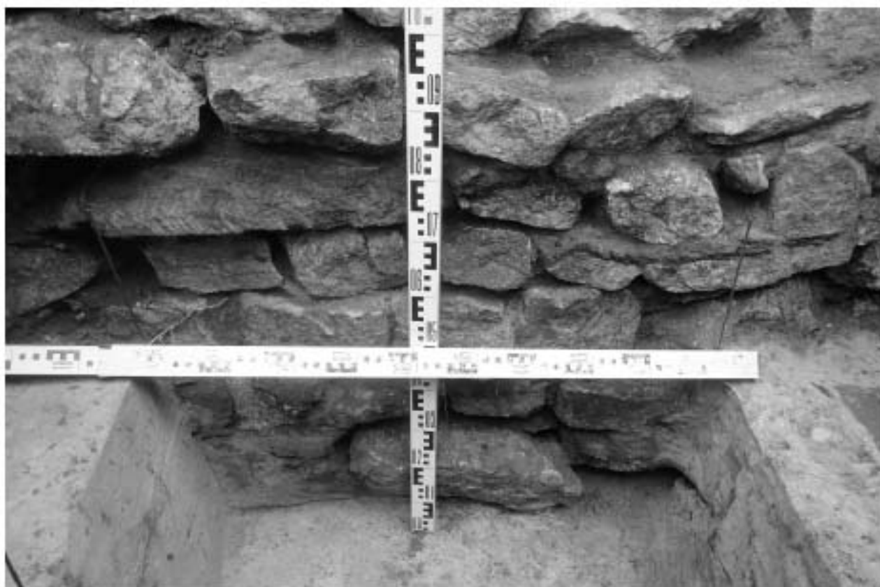
Илл. 36. г. Санкт-Петербург. МО Василеостровский район. Реконструкция наружного освещения парков, садов и скверов с внедрением энергосберегающего и энергетически эффективного оборудования объекта: Благовещенский сад, Шурф №1. Проюпка до основания подошвы фундаментов. Вид с северо-востока.
