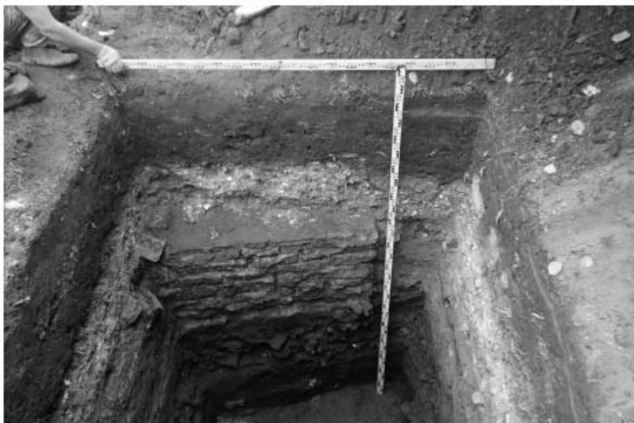
Илл. 88. г. Санкт-Петербург. МО Василеостровский район. Реконструкция наружного освещения парков, садов и скверов с внедрением энергосберегающего и энергетически эффективного оборудования объекта: Благовещенский сад, Шурф №3. Западная стенка. Вид с востока.
