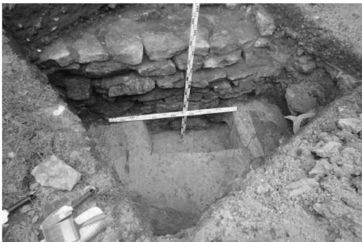
Илл. 35. г. Санкт-Петербург. МО Василеостровский район. Реконструкция наружного освещения парков, садов и скверов с внедрением энергосберегающего и энергетически эффективного оборудования объекта: Благовещенский сад, Шурф №1. Проюпка до основания подошвы фундаментов. Вид с северо-востока.
