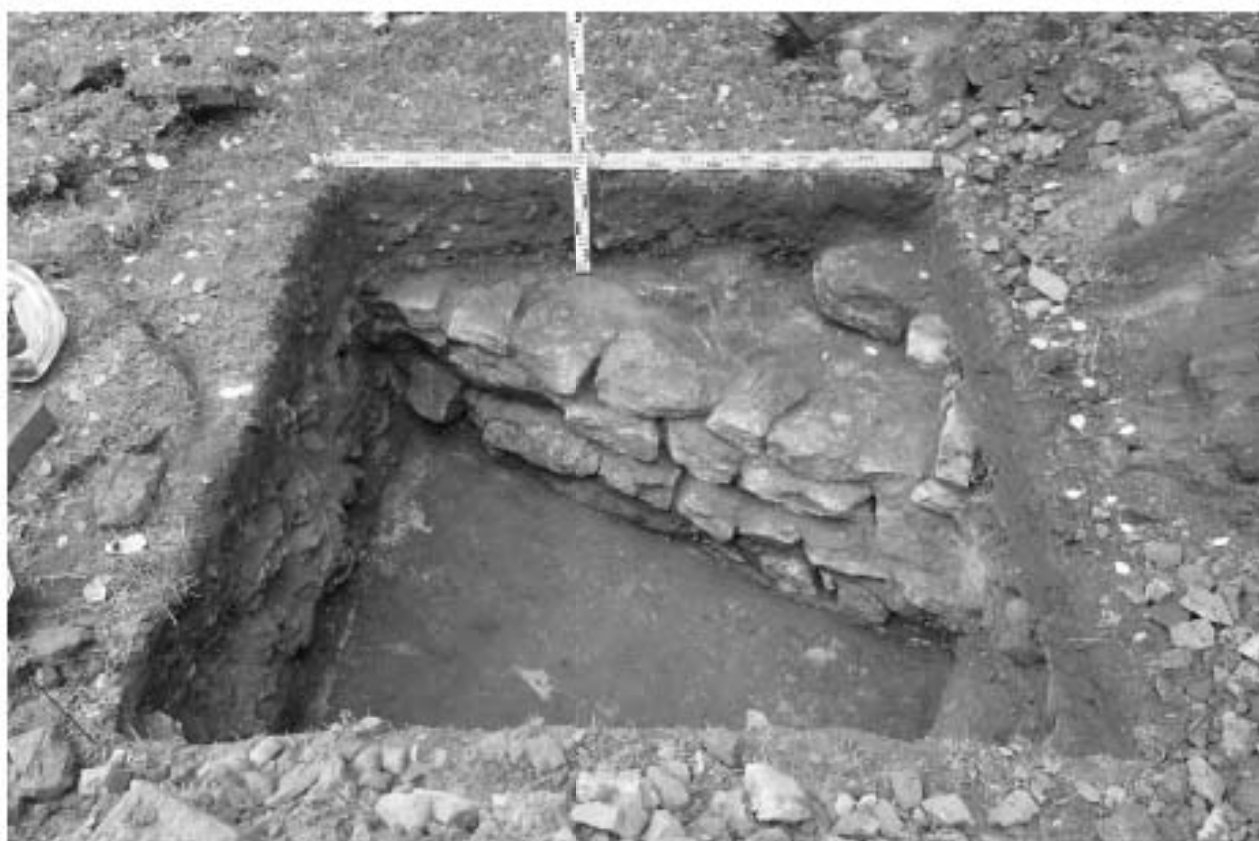
Илл. 30. г. Санкт-Петербург. МО Василеостровский район. Реконструкция наружного освещения парков, садов и скверов с внедрением энергосберегающего и энергетически эффективного оборудования объекта: Благовещенский сад, Шурф №1. Зачистка по основанию Пласта №3. Вид с севера.
