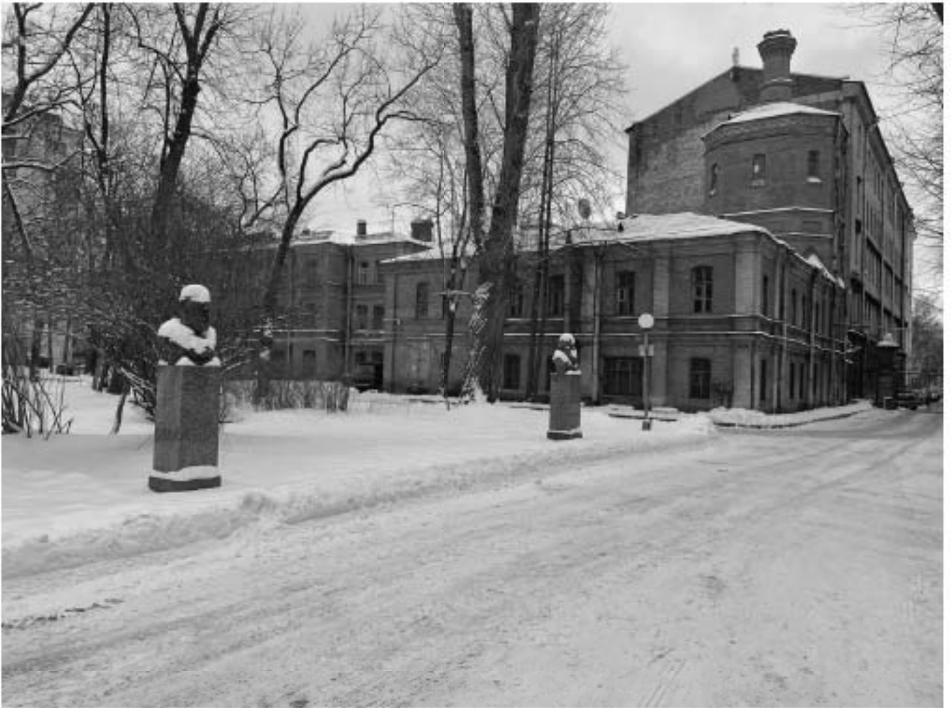
Фото № 8. Вид на территорию объекта культурного наследия федерального значения «Институт экспериментальной медицины», расположенный по адресу: г. Санкт-Петербург, Академика Павлова ул., 9, 12. Объект культурного наследия федерального значения «Корпус машинный с водонапорной башней». Фото Васильева Н. В. (11.02.2025 г.)
