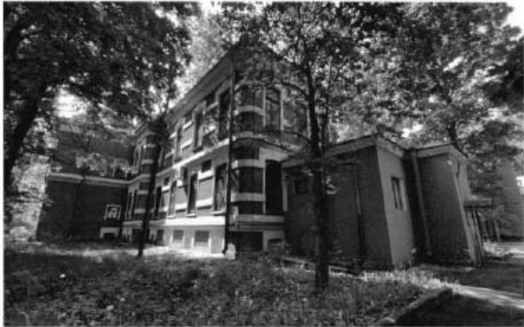
3. Общий вид с северо-восточной стороны.
