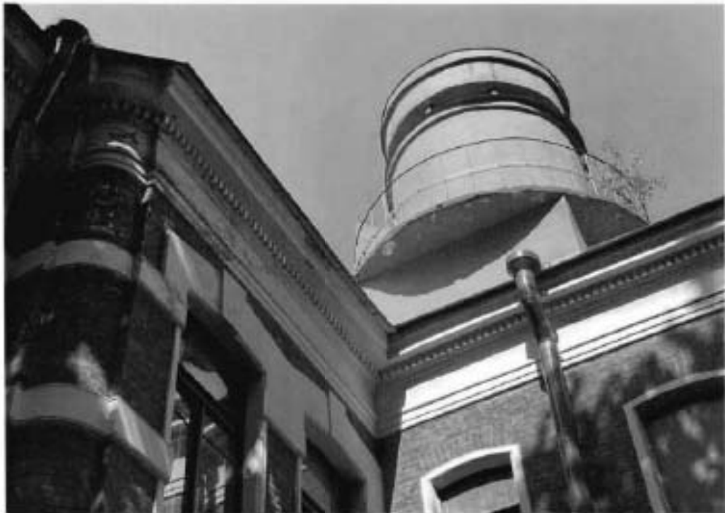
4. Круглая смотровая башня.
