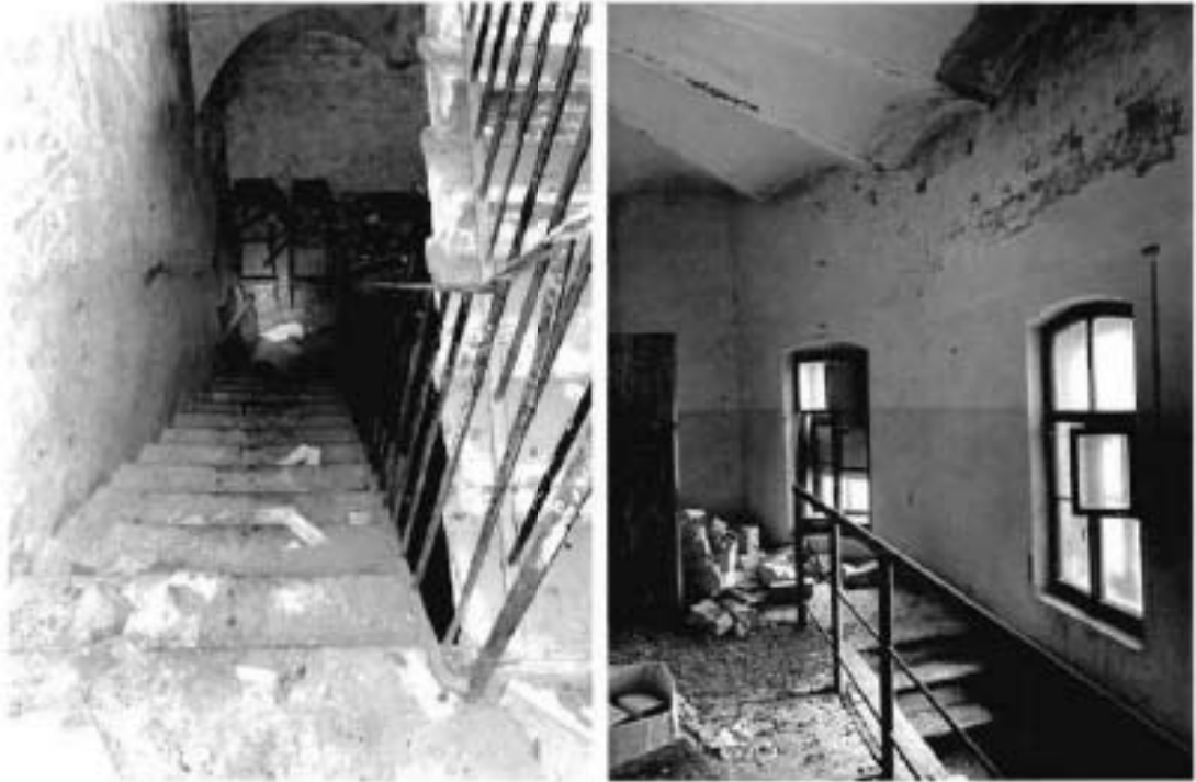
7, 8. Лестница бапти объекта культурного наследия.
