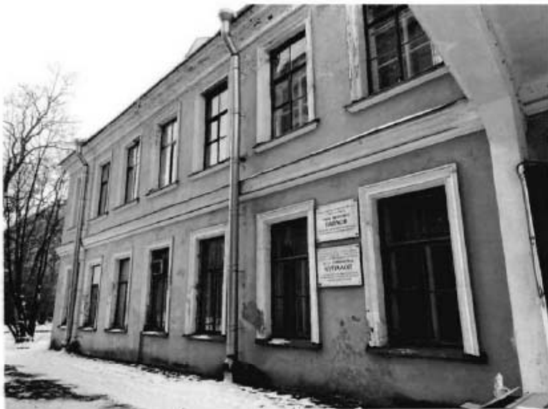
3. Фрагмент северо-восточного фасада объекта культурного наследия (левая сторона).
