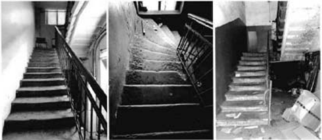
4, 5, 6. Внутренние лестницы объекта культурного наследия.
