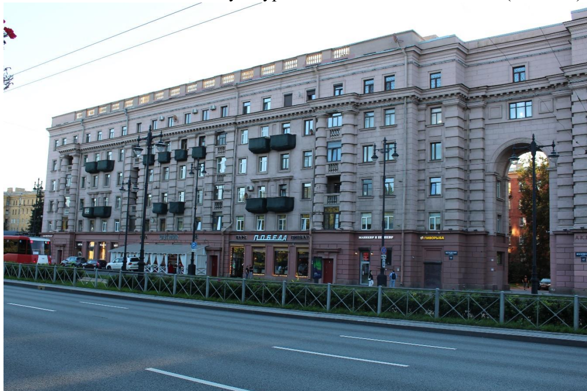
Фото 2. Вид на восточный фасад выявленного объекта культурного наследия «Здание 2» по адресу: Санкт-Петербург, Московский пр., 159, входящего в состав выявленного объекта культурного наследия «Жилые дома (4 здания)».
