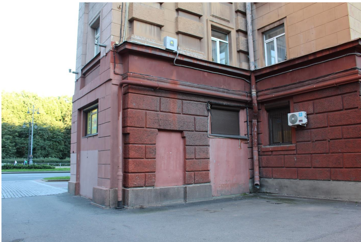
Фото 5. Вид на фрагмент западного фасада выявленного объекта культурного наследия «Здание 2» по адресу: Санкт-Петербург, Московский пр., 159, входящего в состав выявленного объекта культурного наследия «Жилые дома (4 здания)», в границах помещения 10-Н.
