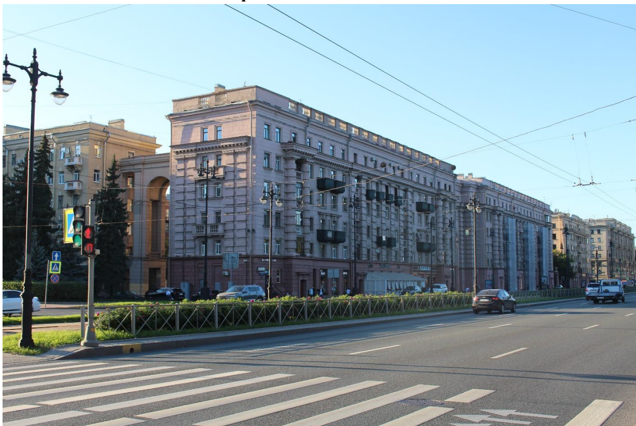
Фото 1. Вид на восточный фасад выявленного объекта культурного наследия «Здание 2» по адресу: Санкт-Петербург, Московский пр., 159, входящего в состав выявленного объекта культурного наследия «Жилые дома (4 здания)».
