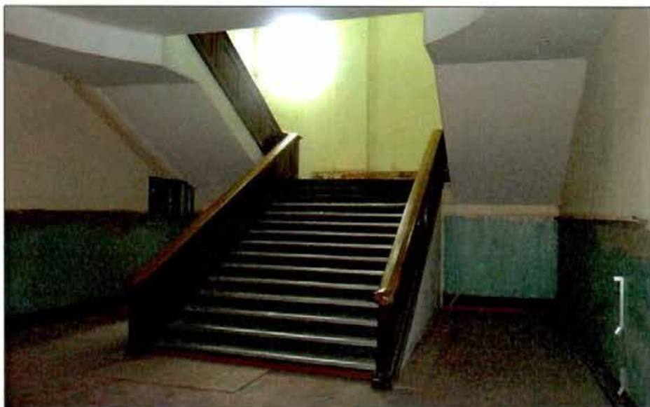
13. Лестница в западном крыле лицевого корпуса в уровне 3-го этажа.
