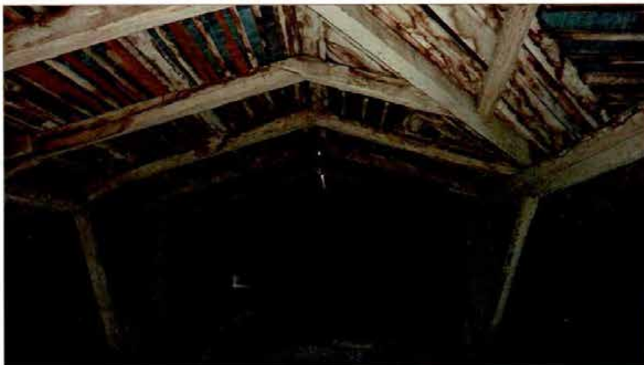
7. Чердак. Стропильная система.
