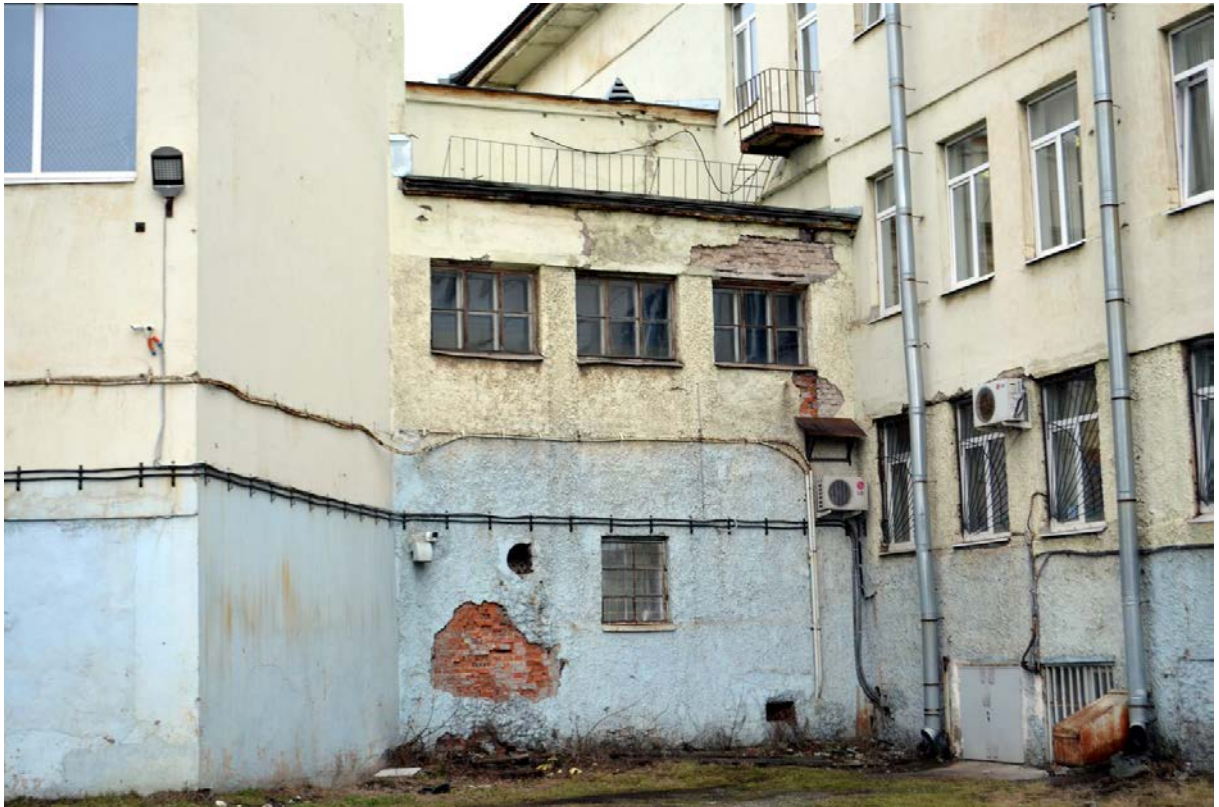
Фото 12. Выявленный ОКН «Здание школы». Фрагмент южного фасада.
