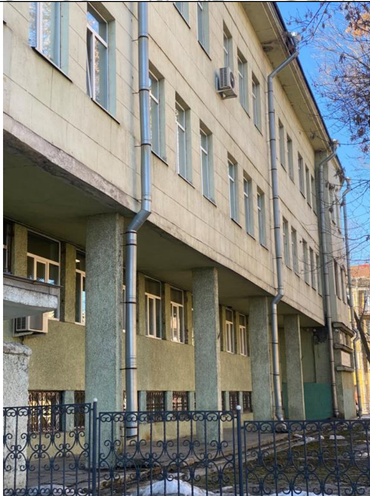
Фото 4. Выявленный ОКН «Здание школы». Фрагмент восточного фасада.
