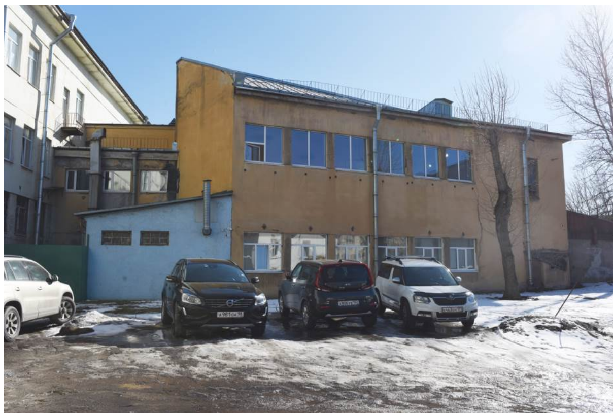
Фото 17. Выявленный ОКН «Здание школы». Фрагмент северного фасада.
