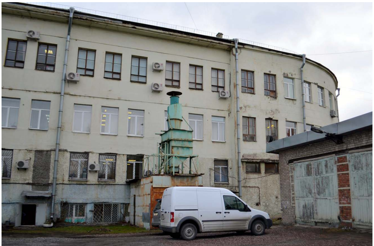
Фото 10. Выявленный ОКН «Здание школы». Фрагмент западного фасада.
