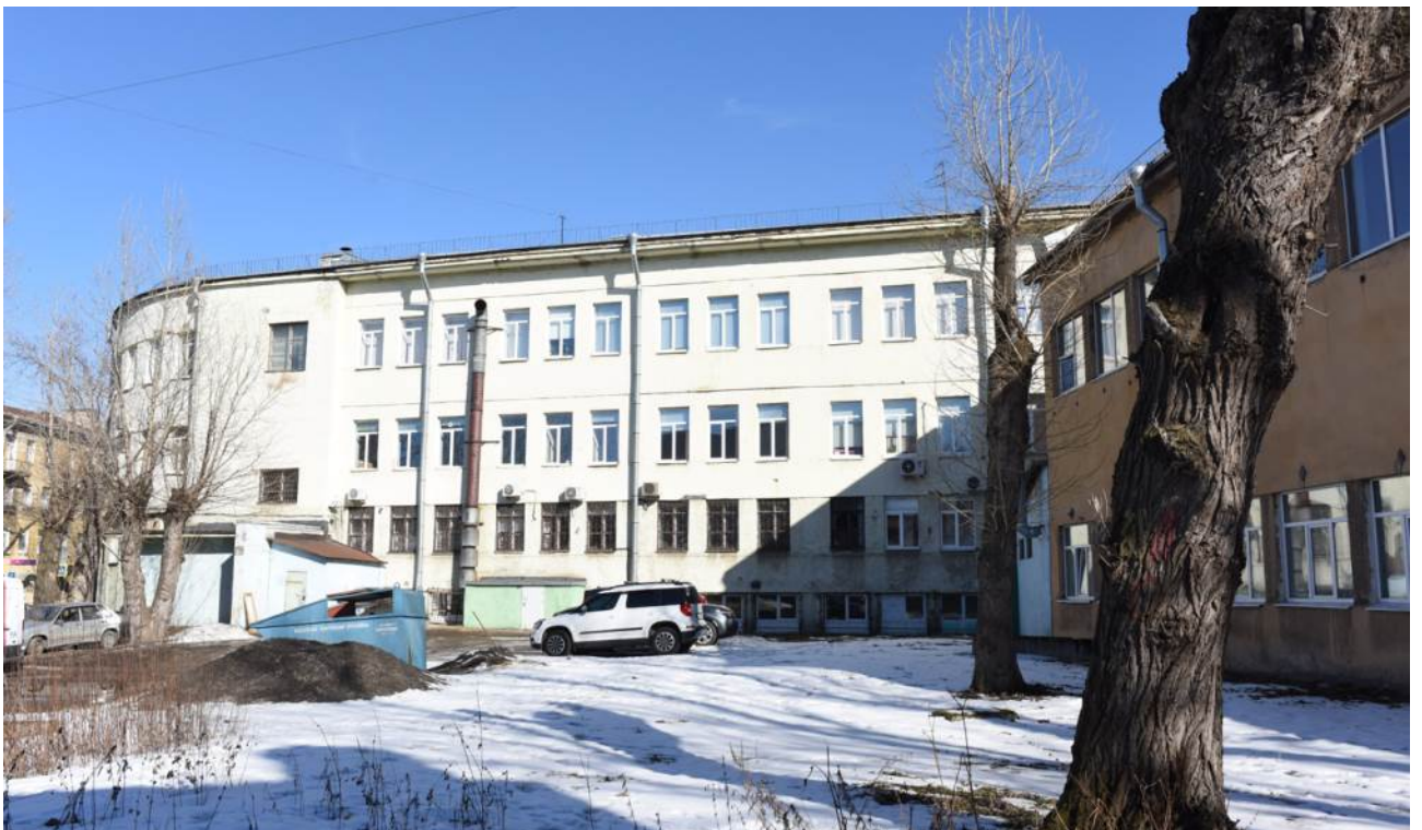
Фото 16. Выявленный ОКН «Здание школы». Фрагмент западного фасада.
