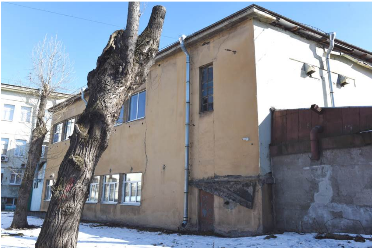
Фото 19. Выявленный ОКН «Здание школы». Фрагмент северного фасада. Вид с запада.
