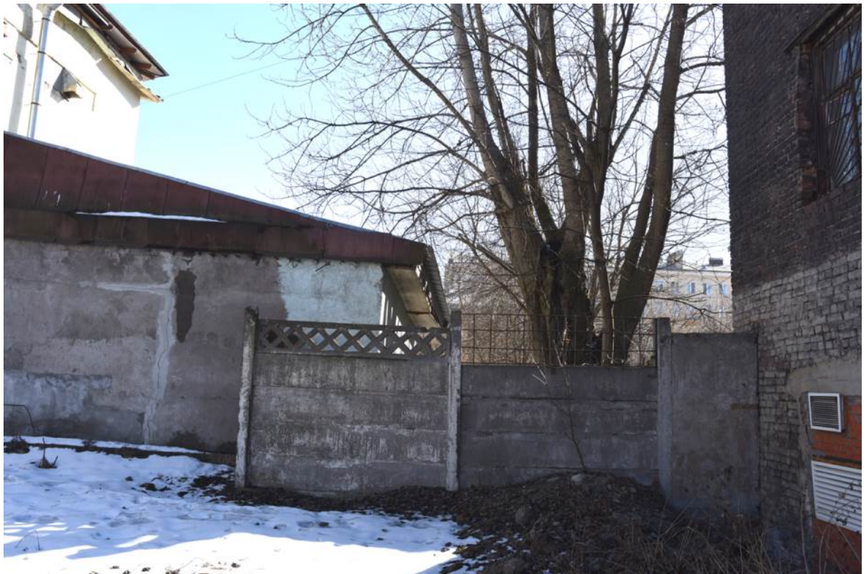
Фото 20. Выявленный ОКН «Здание школы». Фрагмент северного фасада.
