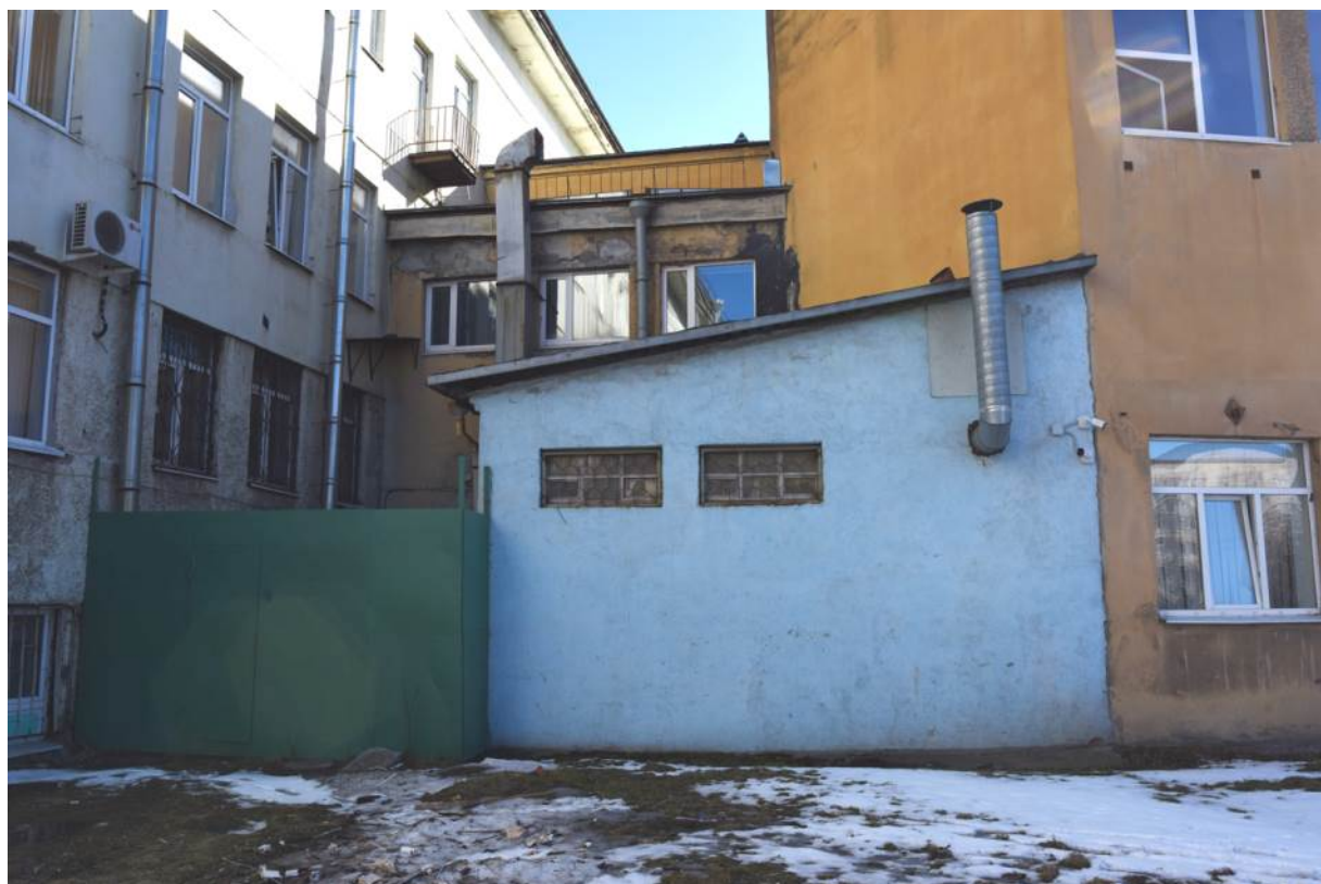
Фото 18. Выявленный ОКН «Здание школы». Фрагмент северного фасада.
