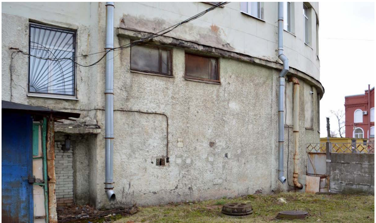
Фото 11. Выявленный ОКН «Здание школы». Фрагмент западного фасада.
