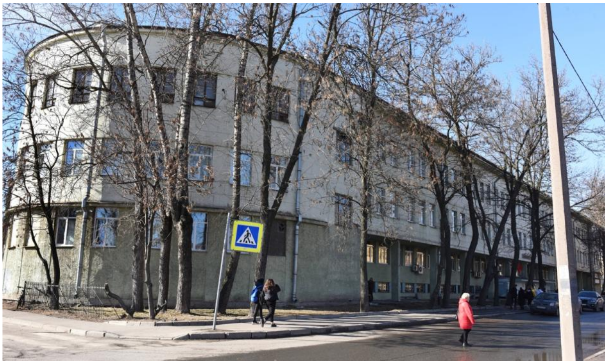
Фото 6. Выявленный ОКН «Здание школы». Общий вид восточного фасада. Вид с юго-востока.
