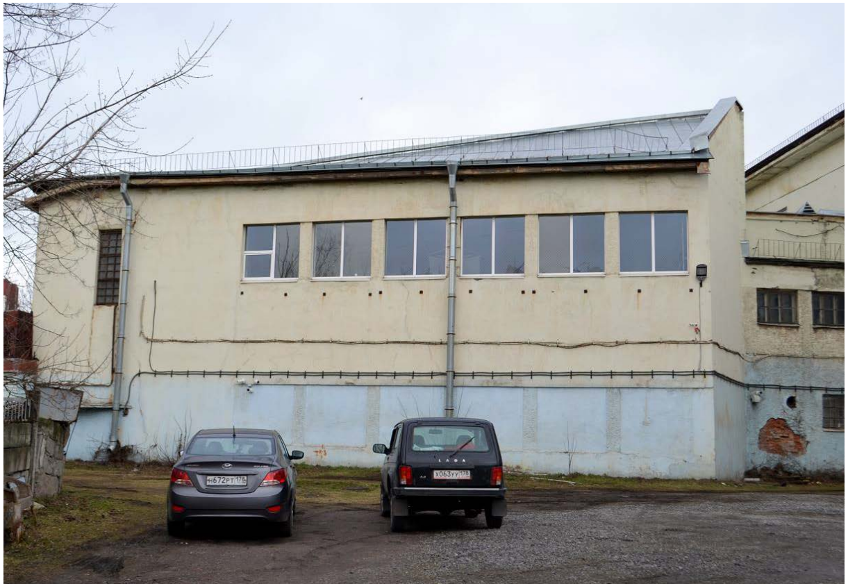
Фото 13. Выявленный ОКН «Здание школы». Фрагмент южного фасада.
