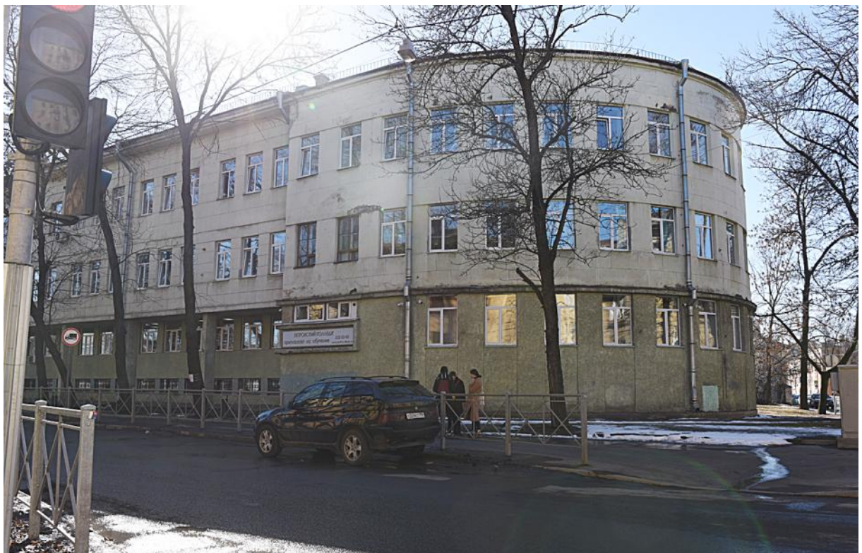
Фото 2. Выявленный ОКН «Здание школы». Общий вид здания с улицы Балтийской.
