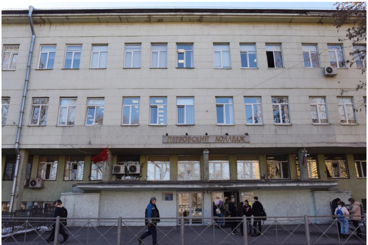
Фото 5. Выявленный ОКН «Здание школы». Центральная часть восточного фасада.
