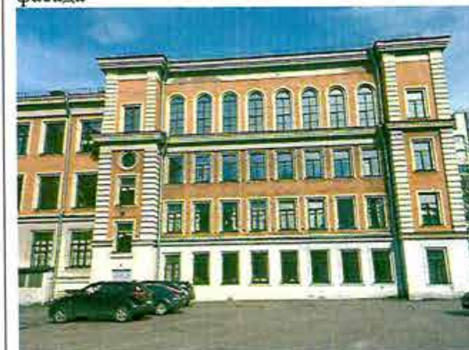
дворовый фасад северного флигеля
