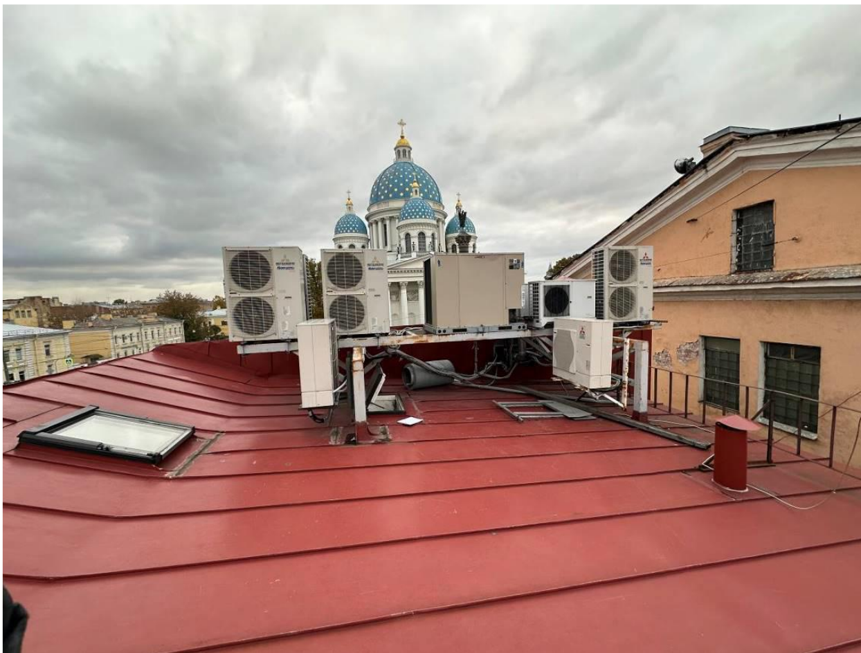
Фото 21. Общий вид на кровлю. Металлическая рама под наружные блоки кондиционеров и оборудование.
