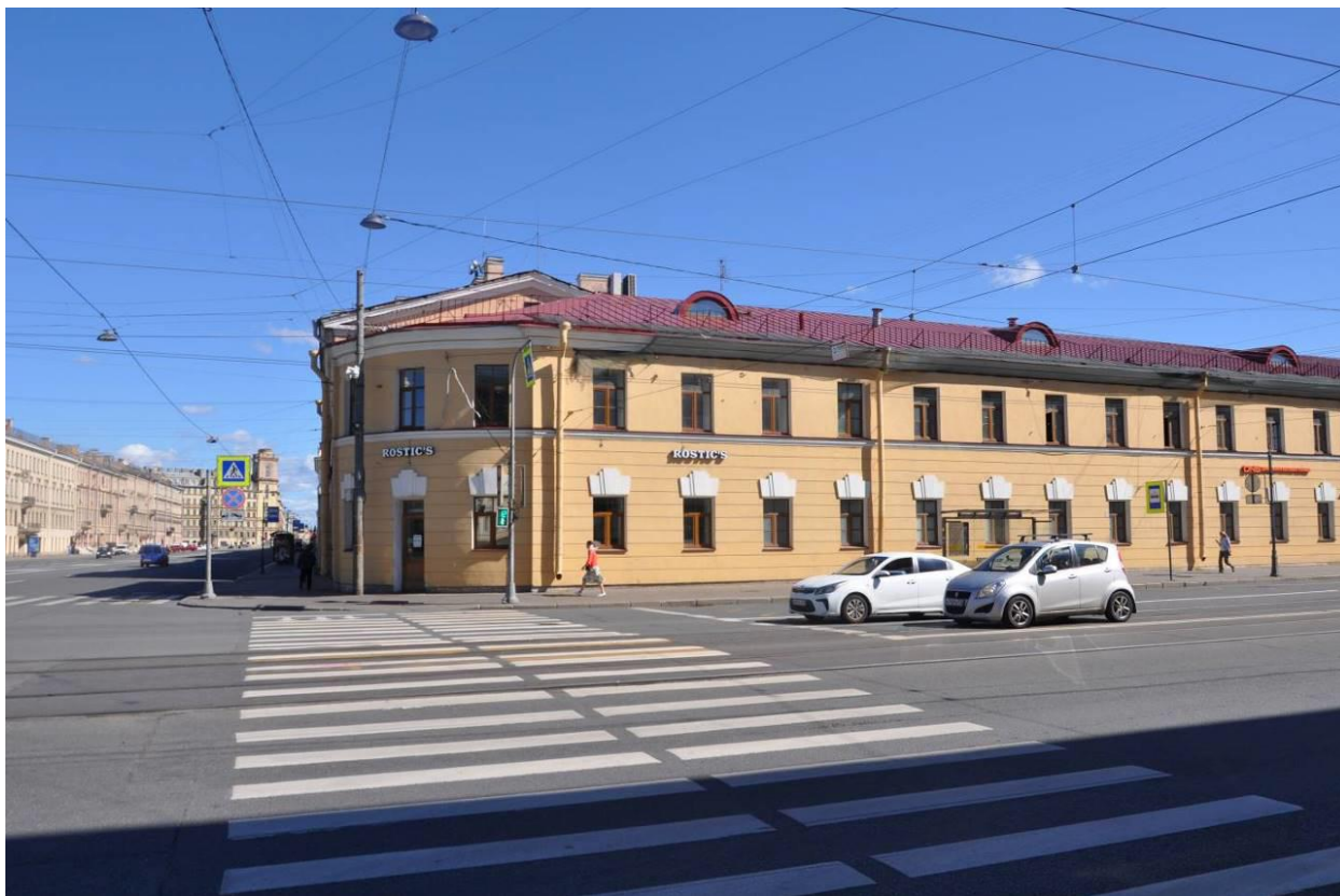
Фото 1. Общий вид фасада в осях А/1-2.
