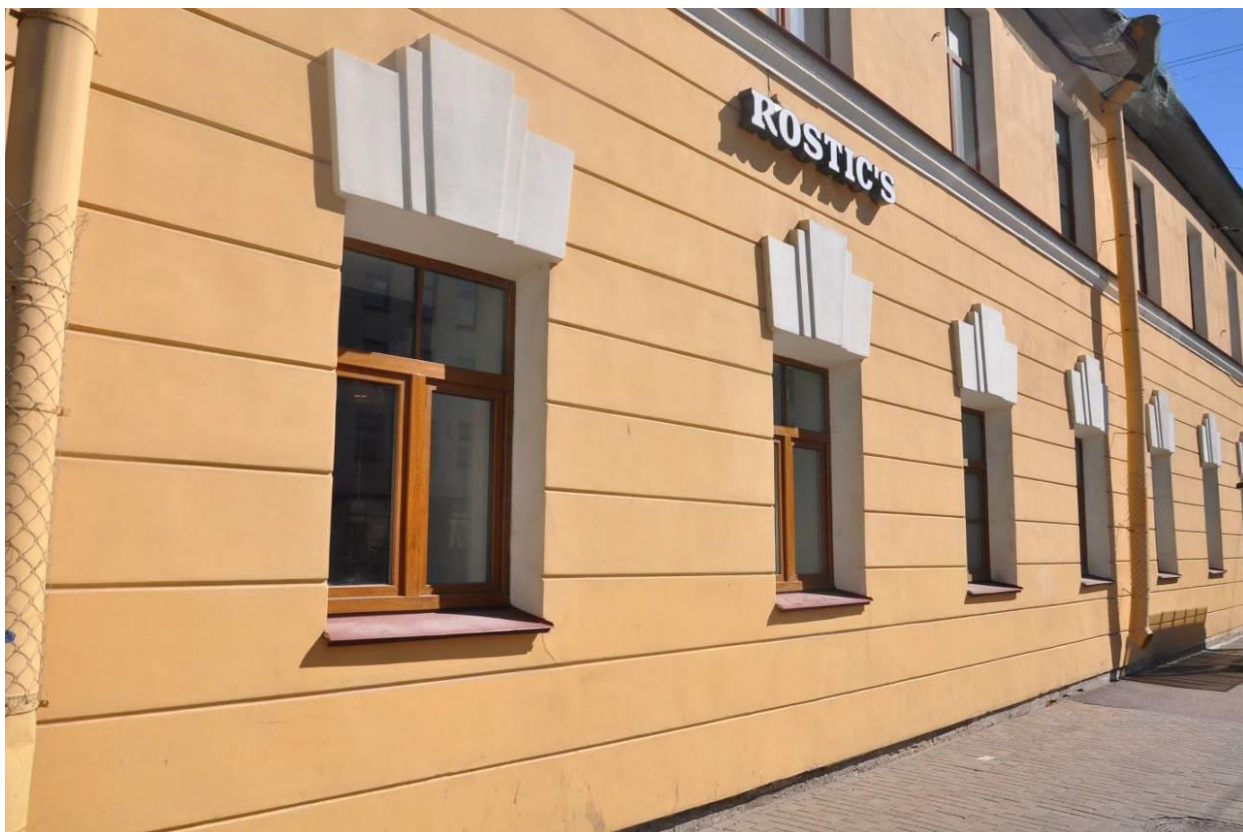
Фото 3. Фрагмент фасада в осях А/2-4.
