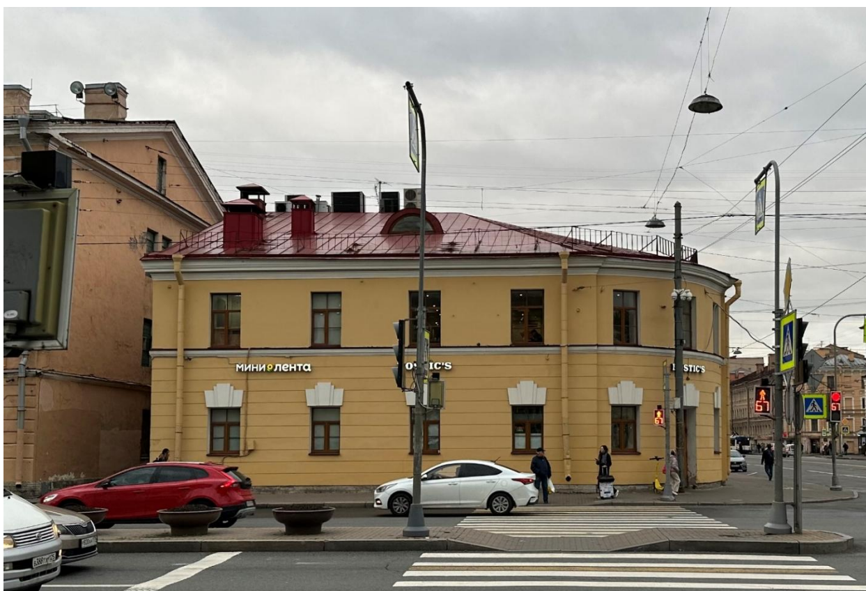
Фото 2. Общий вид фасада в осях А-В/1.
