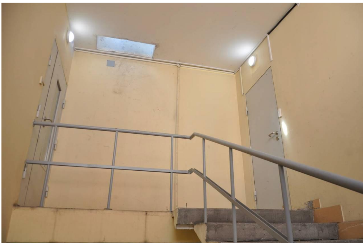
Фото 18. Лаз выхода на кровлю. Вход в чердачное помещение.
