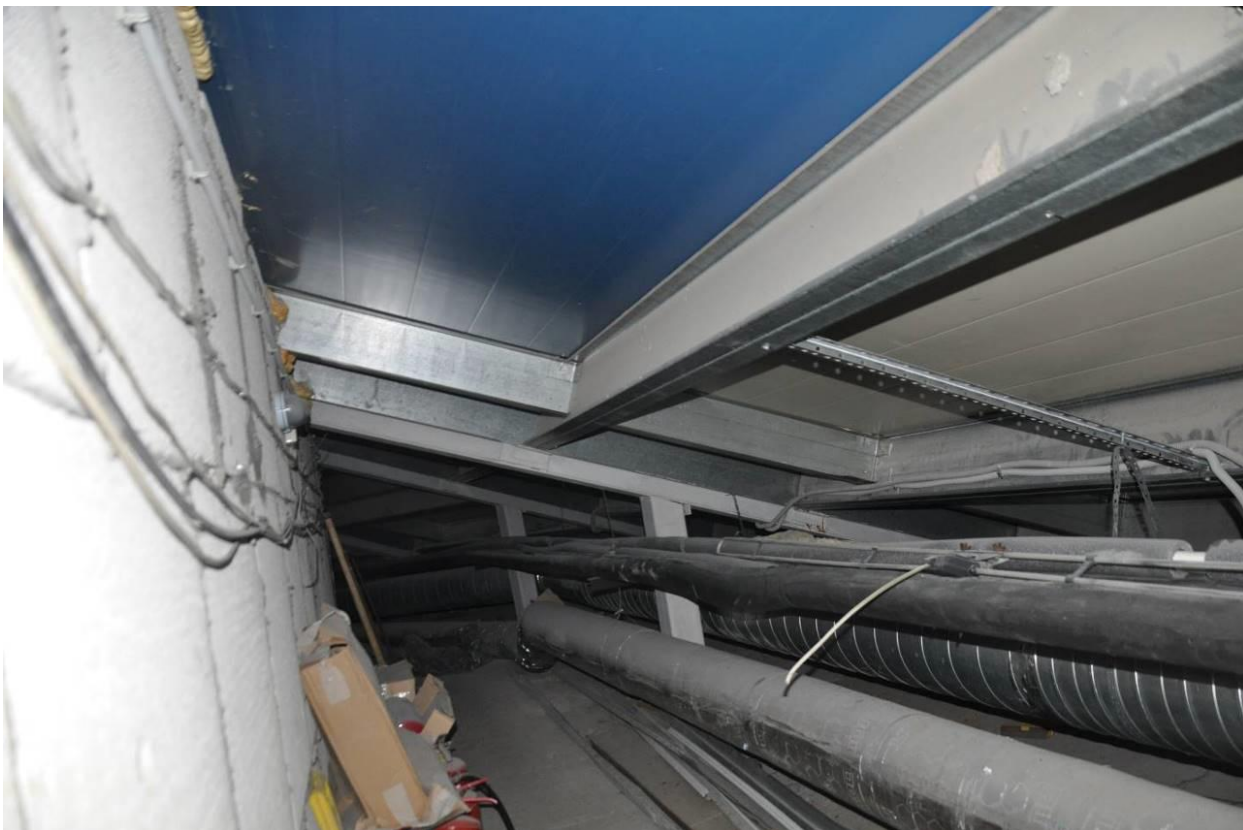
Фото 19. Элементы стропильной системы. Общий вид.
