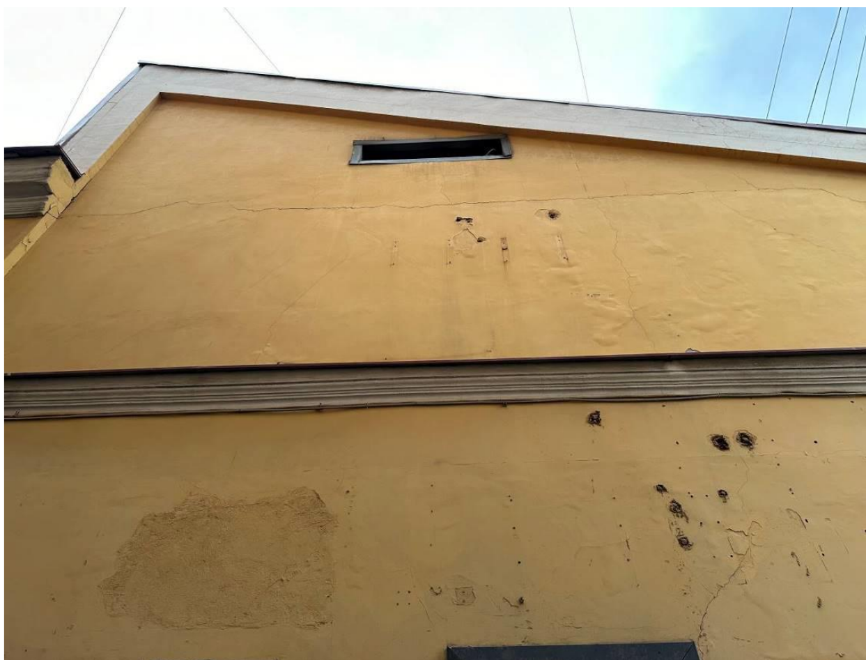
Фото 4. Фрагмент фасада в осях В/2-4.
