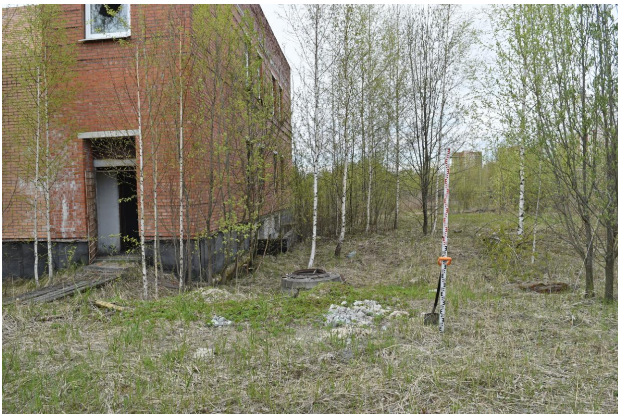
Рис. 39. Санкт-Петербург, Бухарестская-2025. Точка фотофиксации-3. Вид с юга. Для масштаба использована рейка длиной 2 м.
