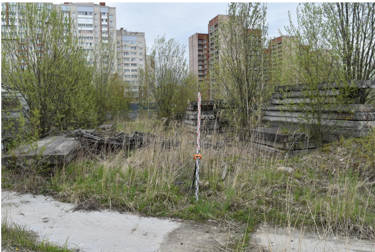
Рис. 61. Санкт-Петербург, Бухарестская-2025. Точка фотофиксации-17. Вид с запада. Для масштаба использована рейка длиной 2 м.
