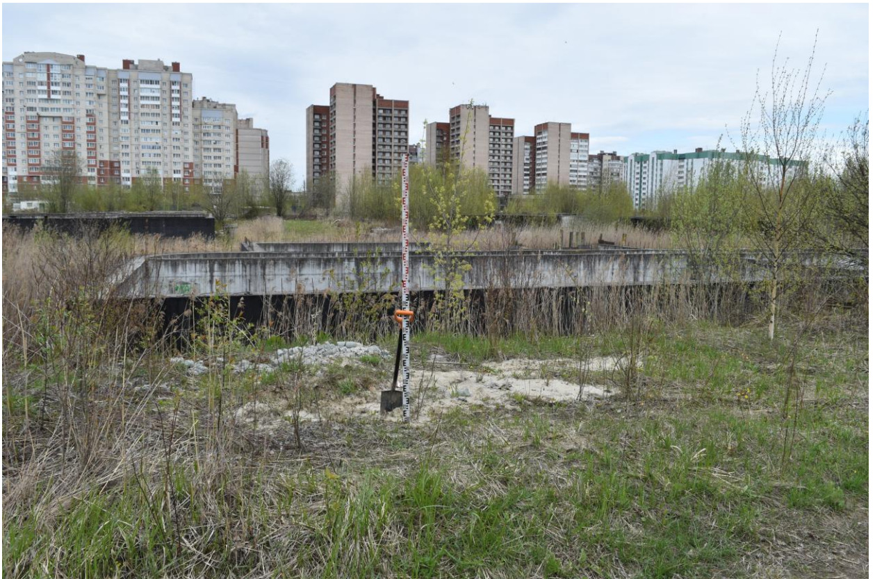
Рис. 53. Санкт-Петербург, Бухарестская-2025. Точка фотофиксации-12. Вид с запада. Для масштаба использована рейка длиной 2 м.
