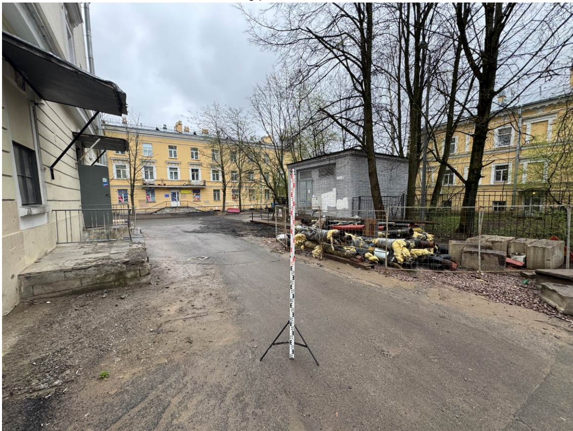
Рис. 19. Санкт-Петербург, Пушкинский р-н., г. Пушкин. Точка съемки 1. Общий вид участка обследования у ОКН «Дом Е.Ф. Калашниковой («Северная гостиница»)». Вид с ЗЮЗ.
