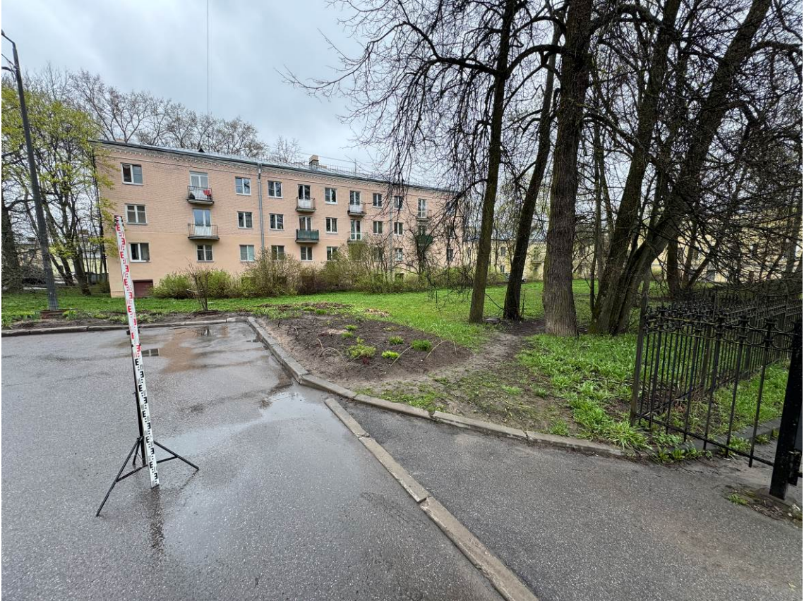
Рис. 37. Санкт-Петербург, Пушкинский р-н., г. Пушкин. Точка съемки 8. Общий вид участка обследования у ОКН «Ратуша и Николаевская гимназия». Вид с ЗЮЗ.
