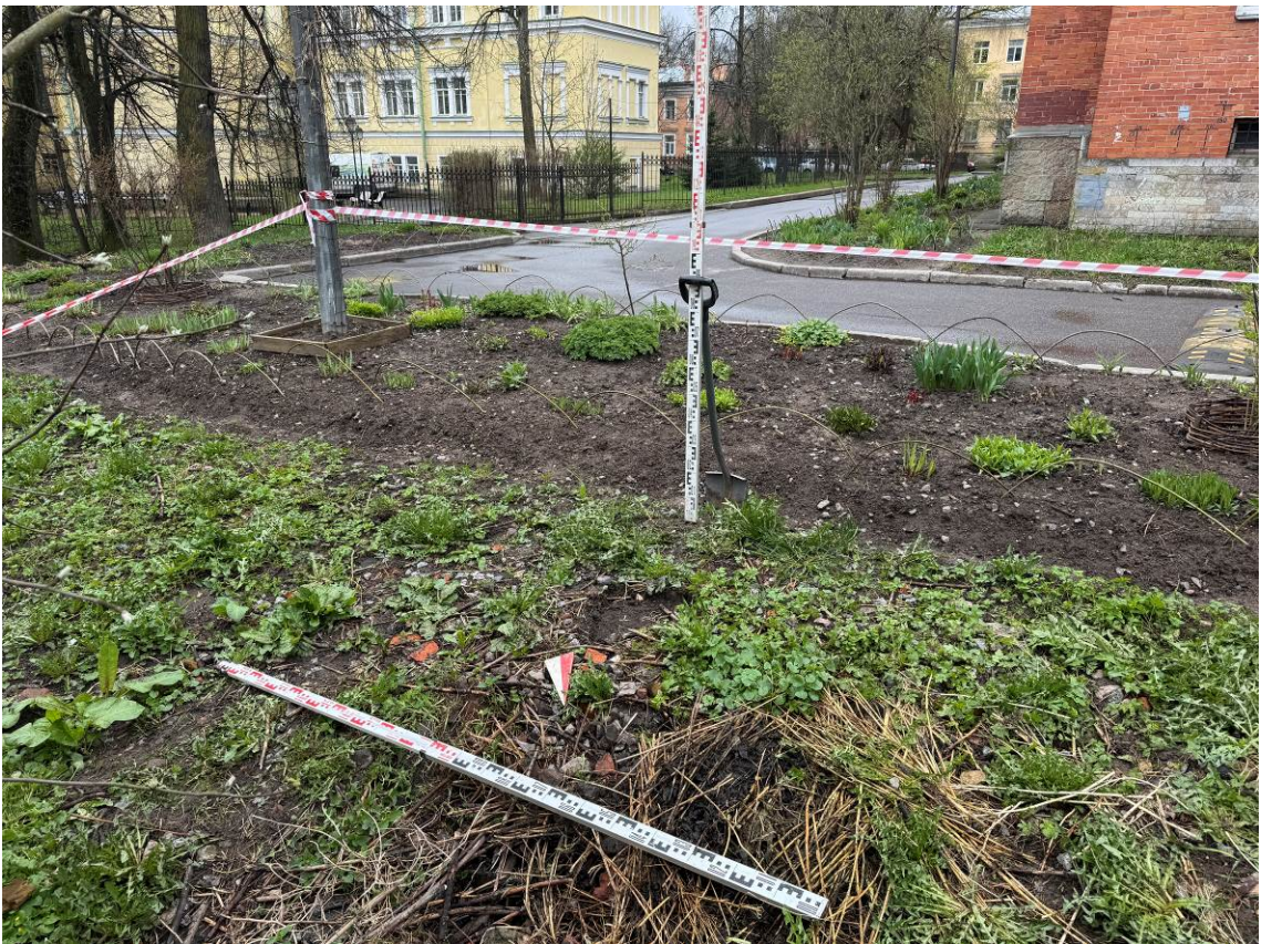
Рис. 42. Санкт-Петербург, Пушкинский р-н., г. Пушкин. Месторасположение Шурфа 1. До начала работ. Вид с С.
