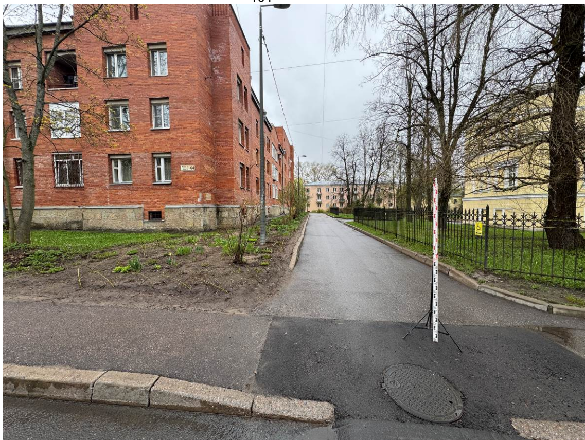
Рис. 33. Санкт-Петербург, Пушкинский р-н., г. Пушкин. Точка съемки 7. Общий вид участка обследования у ОКН «Ратуша и Николаевская гимназия». Вид с ЮЗ.
