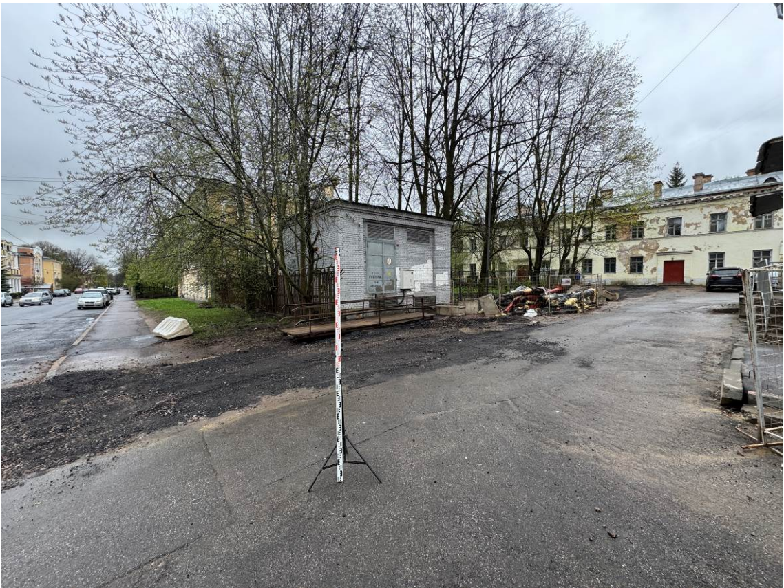
Рис. 22. Санкт-Петербург, Пушкинский р-н., г. Пушкин. Точка съемки 2. Общий вид участка обследования у ОКН «Дом Е.Ф. Калашниковой («Северная гостиница»)». Вид с ССЗ.
