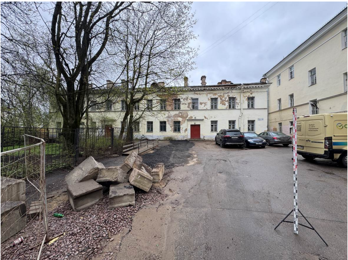
Рис. 18. Санкт-Петербург, Пушкинский р-н., г. Пушкин. Точка съемки 1. Общий вид участка обследования у ОКН «Дом Е.Ф. Калашниковой («Северная гостиница»)». Вид с СВ.
