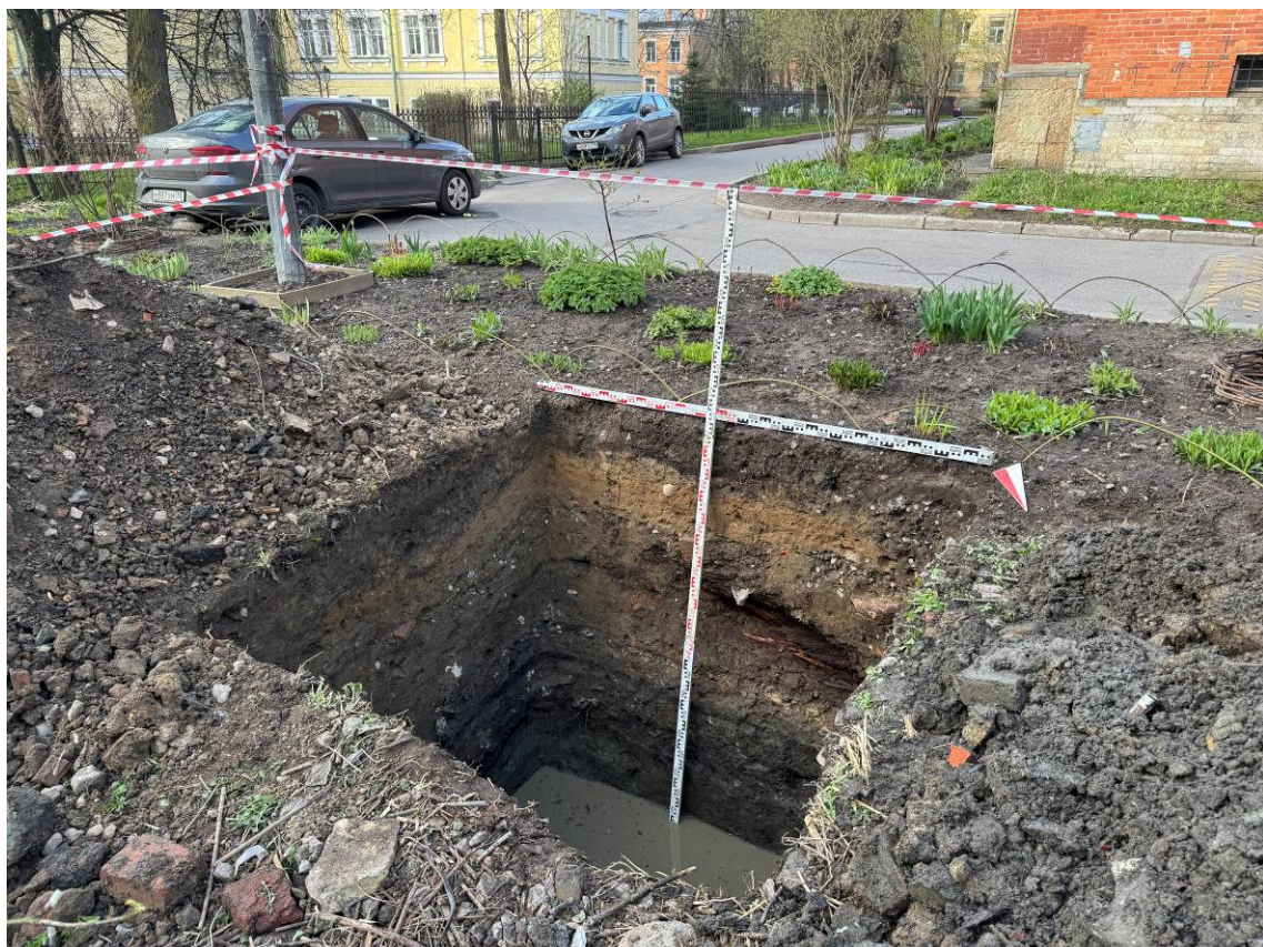
Рис. 44. Санкт-Петербург, Пушкинский р-н., г. Пушкин. Шурф 1. Финальная зачистка. Общий вид шурфа с С.
