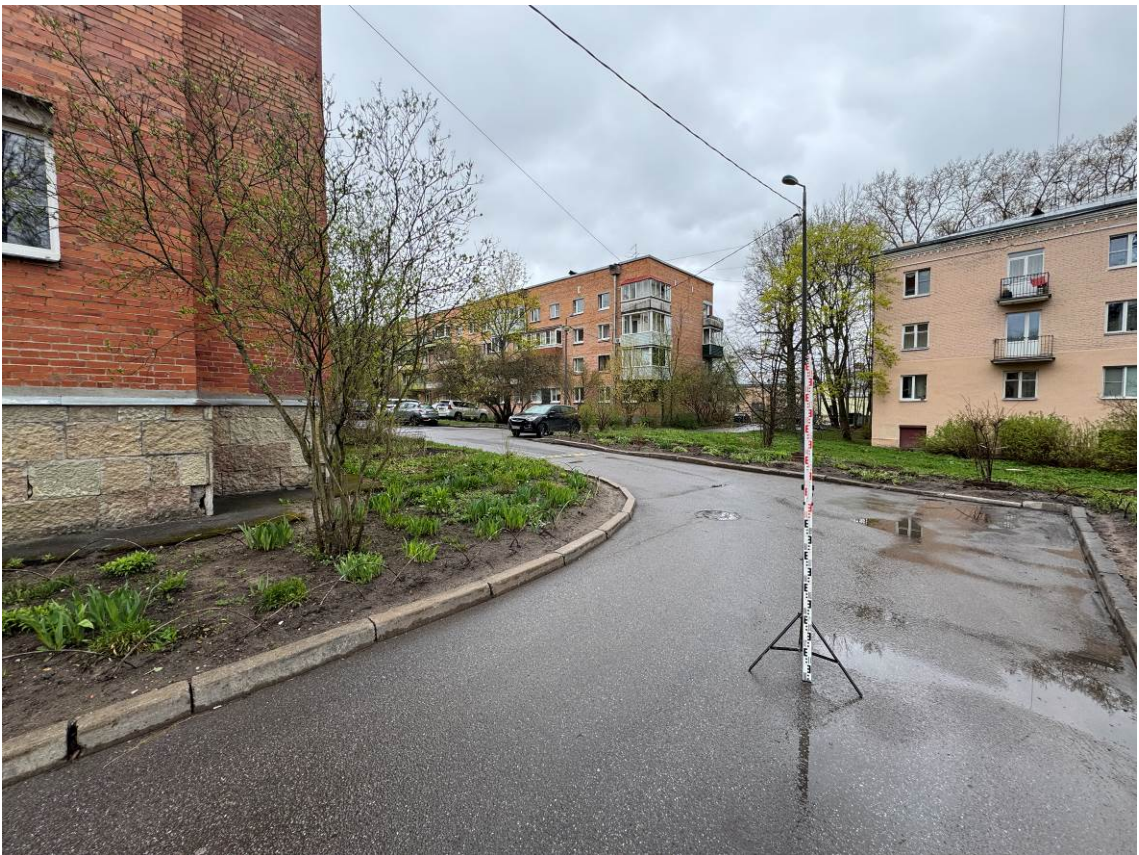
Рис. 38. Санкт-Петербург, Пушкинский р-н., г. Пушкин. Точка съемки 8. Общий вид участка обследования у ОКН «Ратуша и Николаевская гимназия». Вид с Ю.
