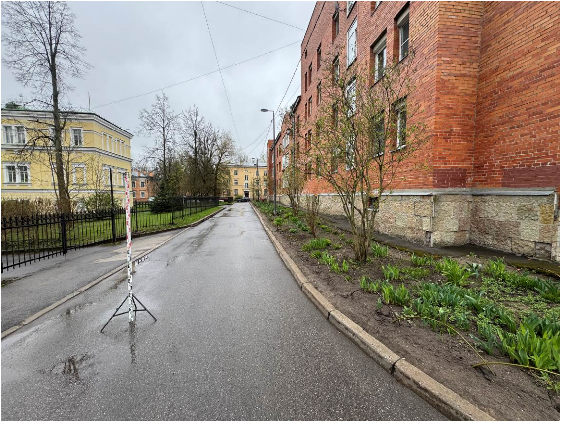
Рис. 35. Санкт-Петербург, Пушкинский р-н., г. Пушкин. Точка съемки 8. Общий вид участка обследования у ОКН «Ратуша и Николаевская гимназия». Вид с СВ.
