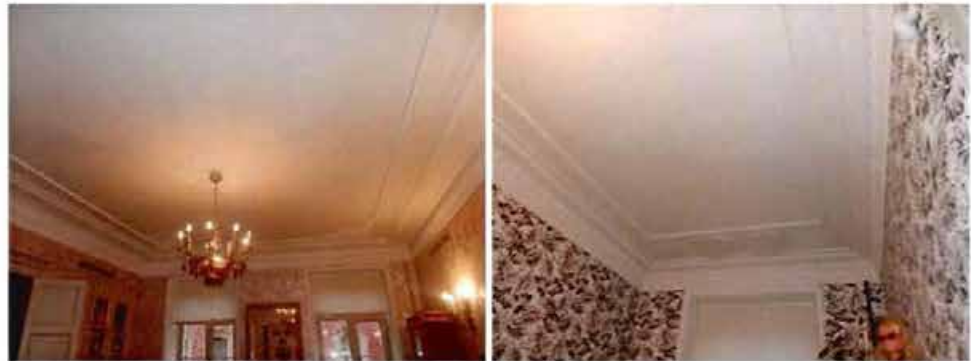
27, 28. Сводчатые потолки в уровне 1 этажа здания (кв. 24)
