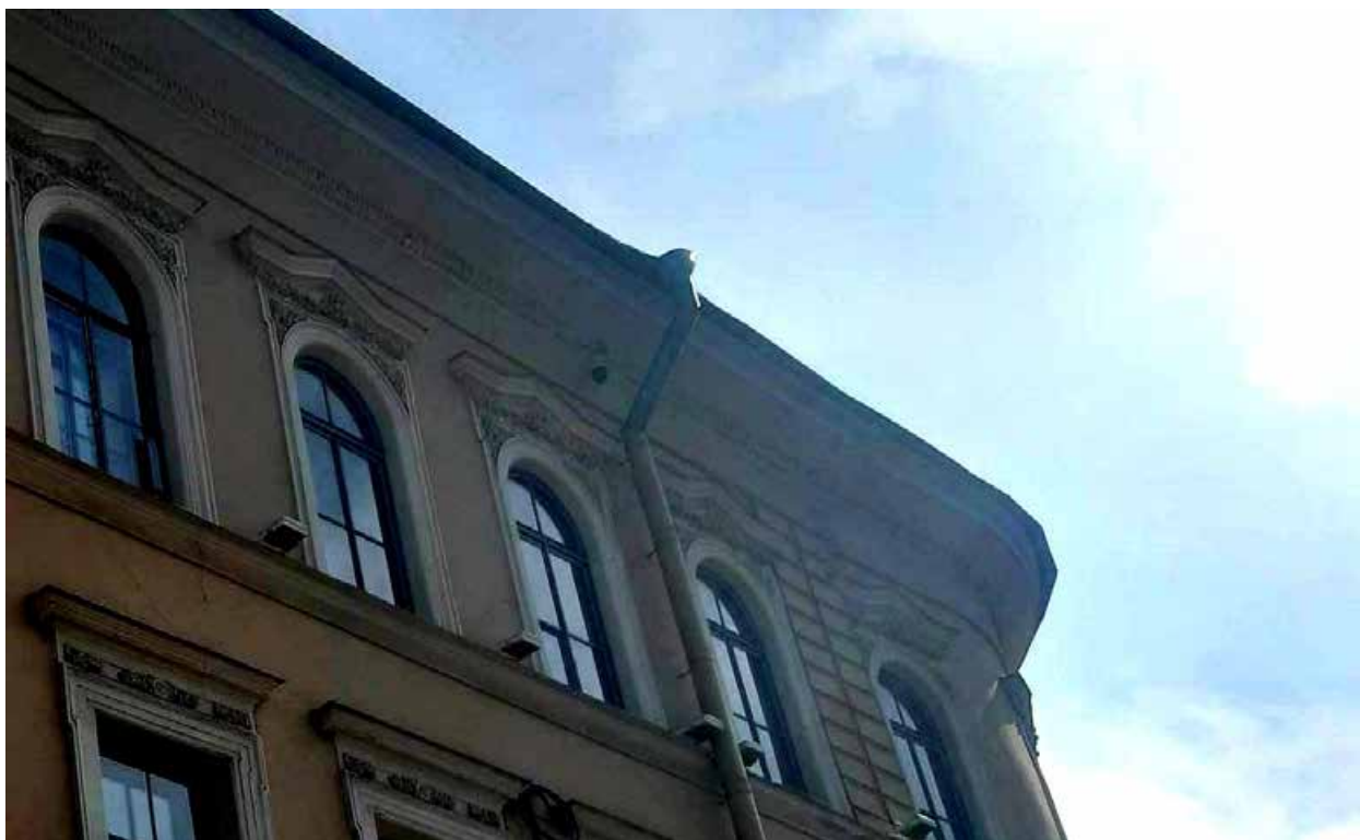
3. «Дом, где в 1866-1870 гг. находилась «Артель художников» и жил художник Крамской И.Н.» (Вознесенский пр., д. 2, лит. А). Лицевой фасад. Фото мест установки оборудования и прокладки кабельных трасс. Штиглиц М.С. 12.05.2025.
