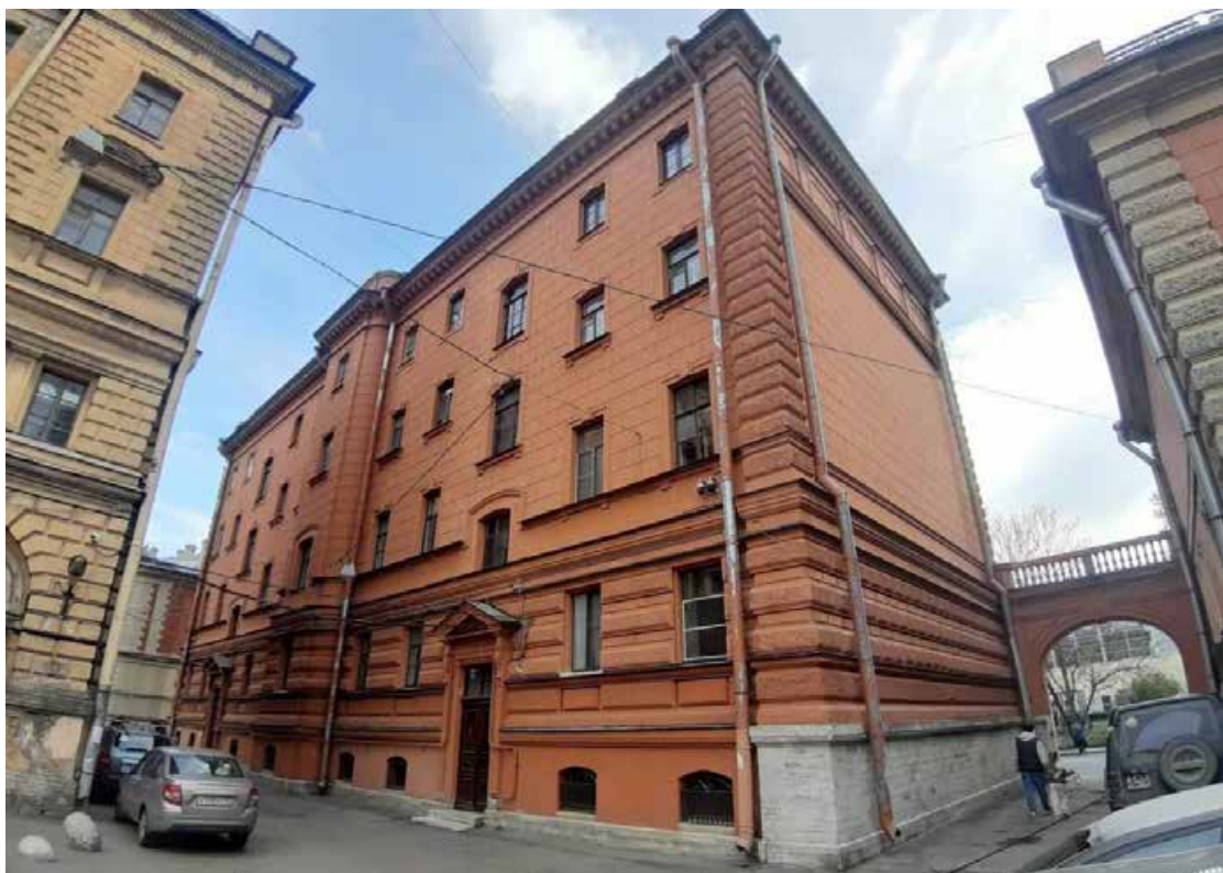
9. «Флигель жилой» (в составе «Дворец Великого князя Алексея Александровича») (Английский пр., д. 2, лит. А). Дворовый фасад. Фото мест установки оборудования и прокладки кабельных трасс. Штиглиц М.С. 12.05.2025.
