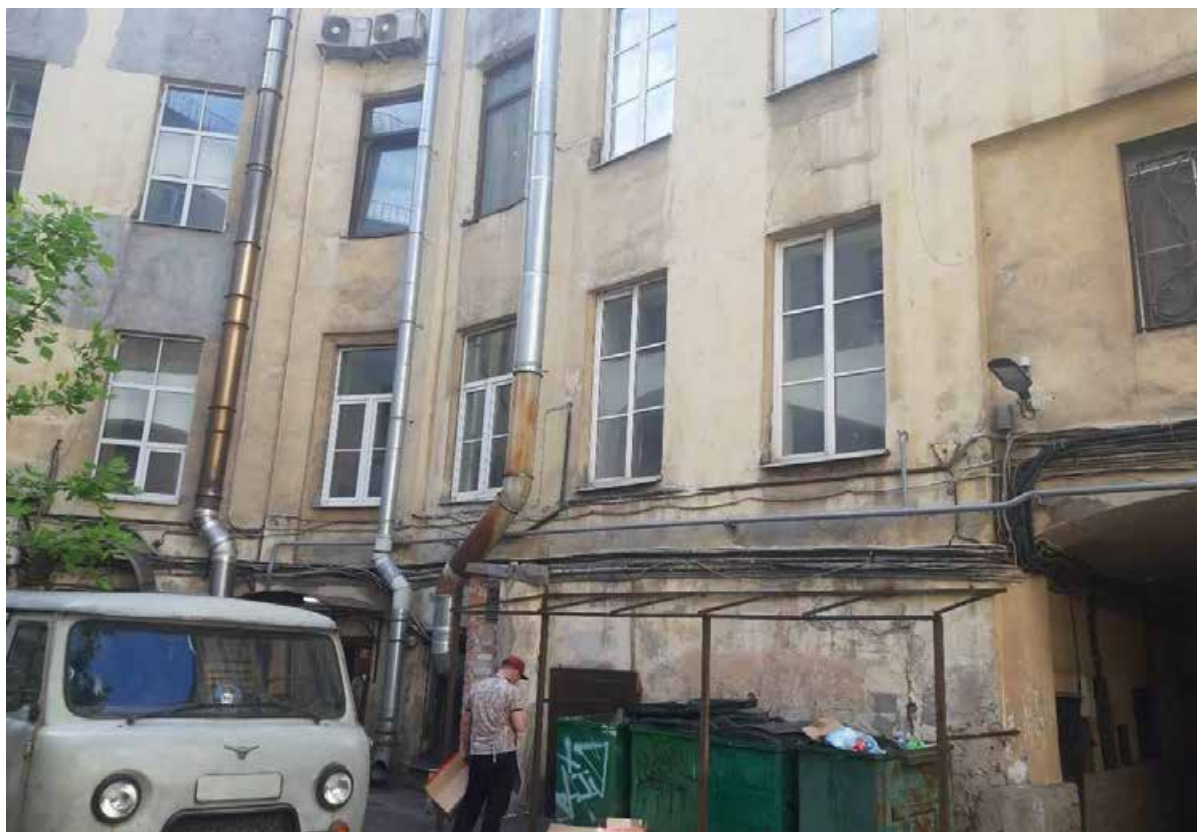
5. «Дом, где в 1866-1870 гг. находилась «Артель художников» и жил художник Крамской И.Н.» (Вознесенский пр., д. 2, лит. А). Дворовый фасад. Фото мест установки оборудования и прокладки кабельных трасс. Штиглиц М.С. 12.05.2025.
