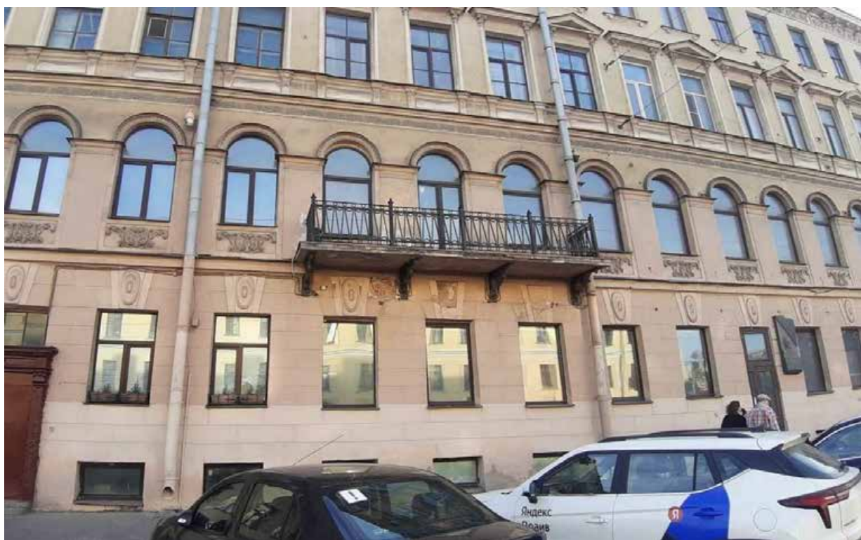
32. «Дом Серебряковых» (Измайловский пр., д. 1, лит. А). Лицевой фасад по Измайловскому пр. Фото мест установки оборудования и прокладки кабельных трасс. Штиглиц М.С. 12.05.2025.
