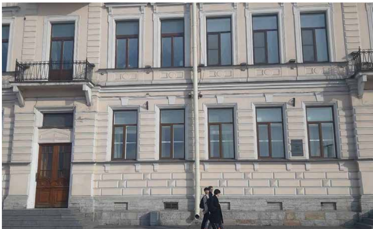
17. «Дом В.П. Орлова-Давыдова» (Галерная ул., д. 19, лит. А). Фрагмент фасада по Английской наб. Фото мест установки оборудования и прокладки кабельных трасс. Штиглиц М.С. 12.05.2025.
