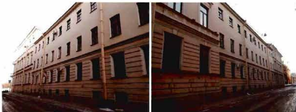
9, 10. Внутренний двор. Северный и южный фасады
