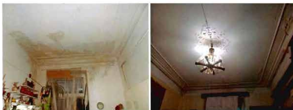
36, 37. Архитектурно-художественная отделка интерьеров и техническое состояние квартир (кв. 7)
