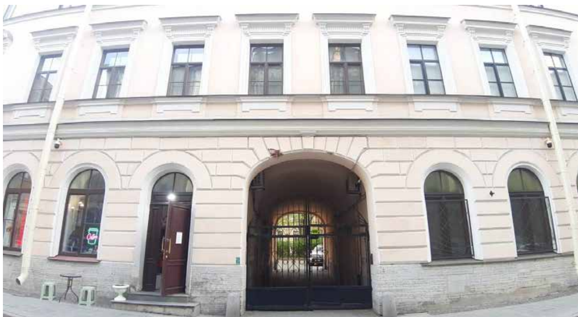
15. «Дом В.П. Орлова-Давыдова» (Галерная ул., д. 19, лит. А). Лицевой фасад по Галерной ул. Фото мест установки оборудования и прокладки кабельных трасс. Штиглиц М.С. 12.05.2025.
