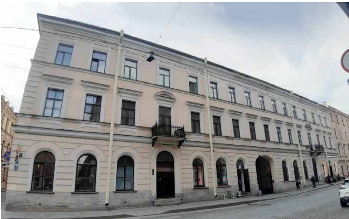
13. «Дом В.П. Орлова-Давыдова» (Галерная ул., д. 19, лит. А). Лицевой фасад по Галерной ул. Штиглиц М.С. 12.05.2025.
