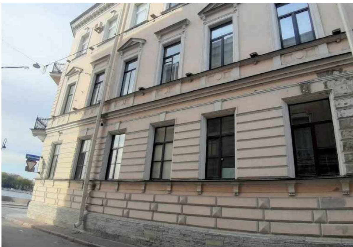
16. «Дом В.П. Орлова-Давыдова» (Галерная ул., д. 19, лит. А). Фрагмент фасада по Замятину пер. Фото мест установки оборудования и прокладки кабельных трасс. Штиглиц М.С. 12.05.2025.
