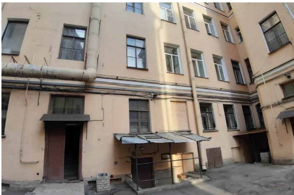
34. «Дом Серебряковых» (Измайловский пр., д. 1, лит. А). Дворовые фасады. Фото мест установки оборудования и прокладки кабельных трасс. Штиглиц М.С. 12.05.2025.
