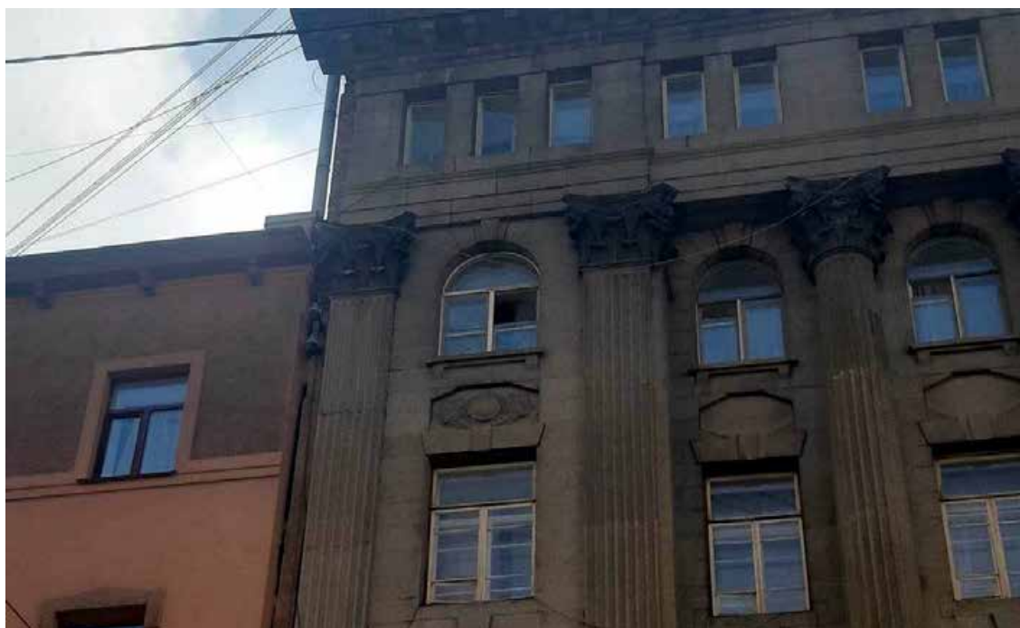
20. «Дом Второго Российского общества страхования от огня с флигелями» (Гороховая улица, д. 3, лит. А). Лицевой фасад. Фото мест установки оборудования и прокладки кабельных трасс. Штиглиц М.С. 12.05.2025.
