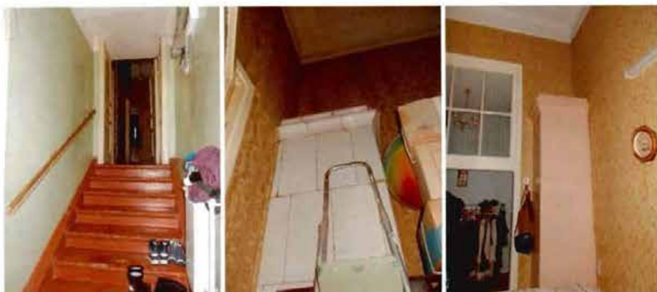
54, 55, 56. Лестница Л-5 (вход со стороны внутреннего двора)
