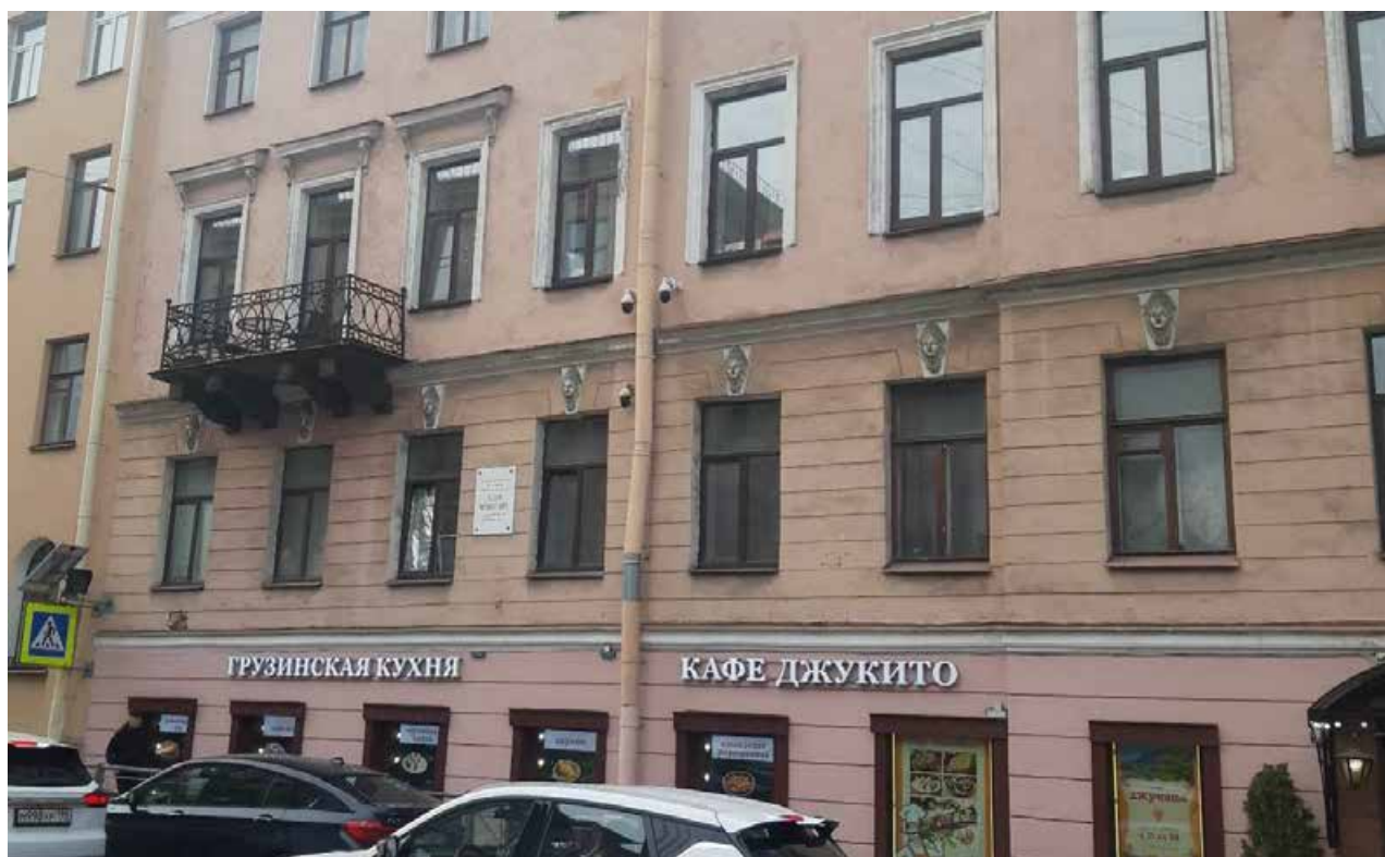
25. «Дом И. Иохима» (Казанская ул., д. 39, лит. А). Лицевой фасад по Казанской ул. Фото мест установки оборудования и прокладки кабельных трасс. Штиглиц М.С. 12.05.2025.
