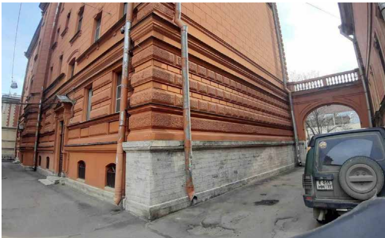
11. «Флигель жилой» (в составе «Дворец Великого князя Алексея Александровича») (Английский пр., д. 2, лит. А). Дворовый фасад. Фото мест установки оборудования и прокладки кабельных трасс. Штиглиц М.С. 12.05.2025.
