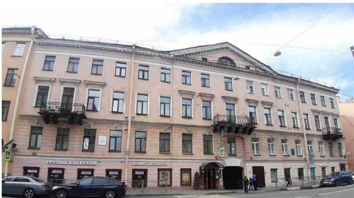
24. «Дом И. Иохима» (Казанская ул., д. 39, лит. А). Лицевой фасад по Казанской ул. Штиглиц М.С. 12.05.2025.
