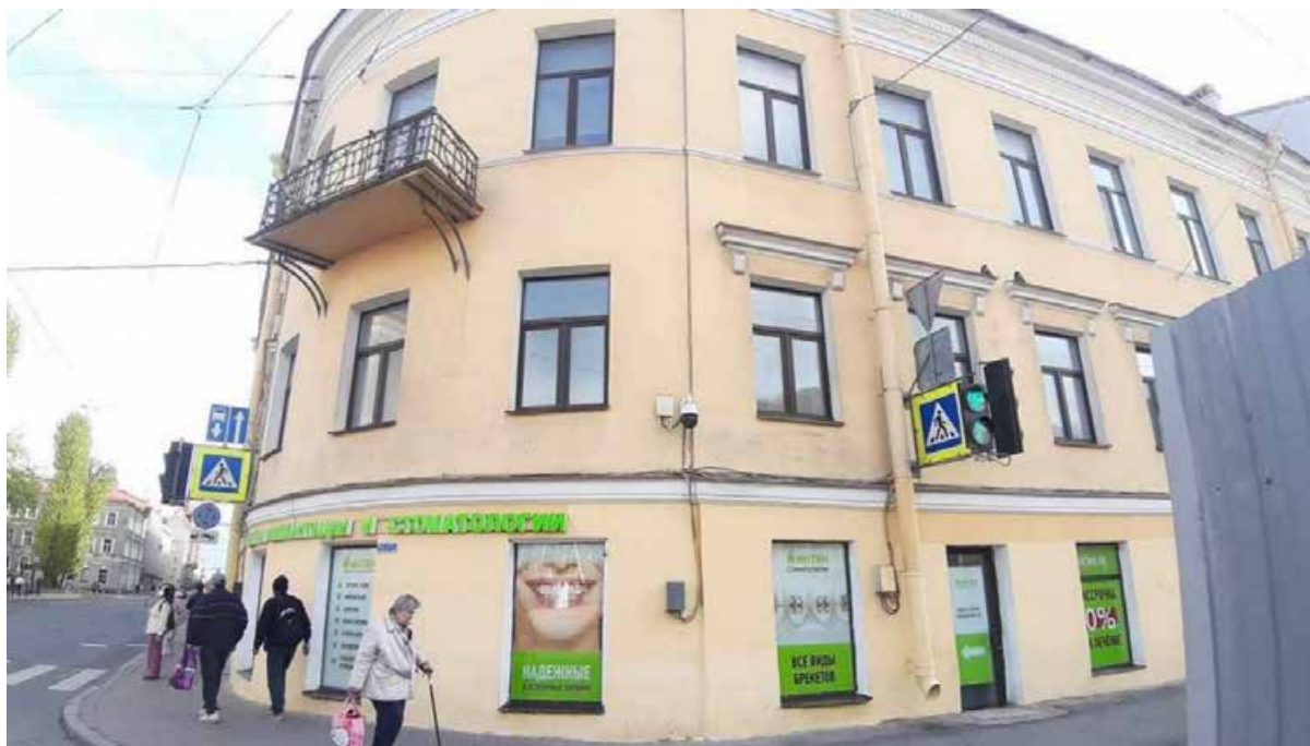
30. «Жилой дом» (Вознесенский пр., д. 25, лит. А). Лицевой фасад по наб.кан. Грибоедова. Фото мест установки оборудования и прокладки кабельных трасс. Штиглиц М.С. 12.05.2025.
