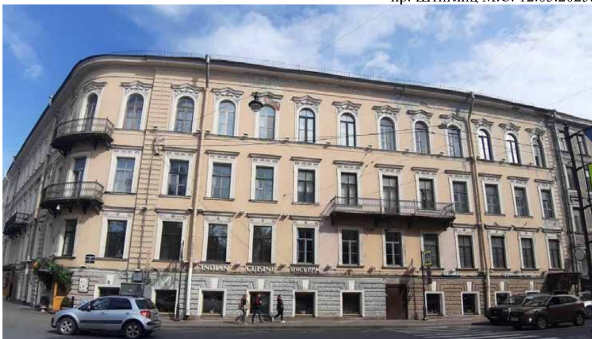
2. «Дом, где в 1866-1870 гг. находилась «Артель художников» и жил художник Крамской И.Н.» (Вознесенский пр., д. 2, лит. А). Лицевой фасад по Вознесенскому пр. Штиглиц М.С. 12.05.2025.
