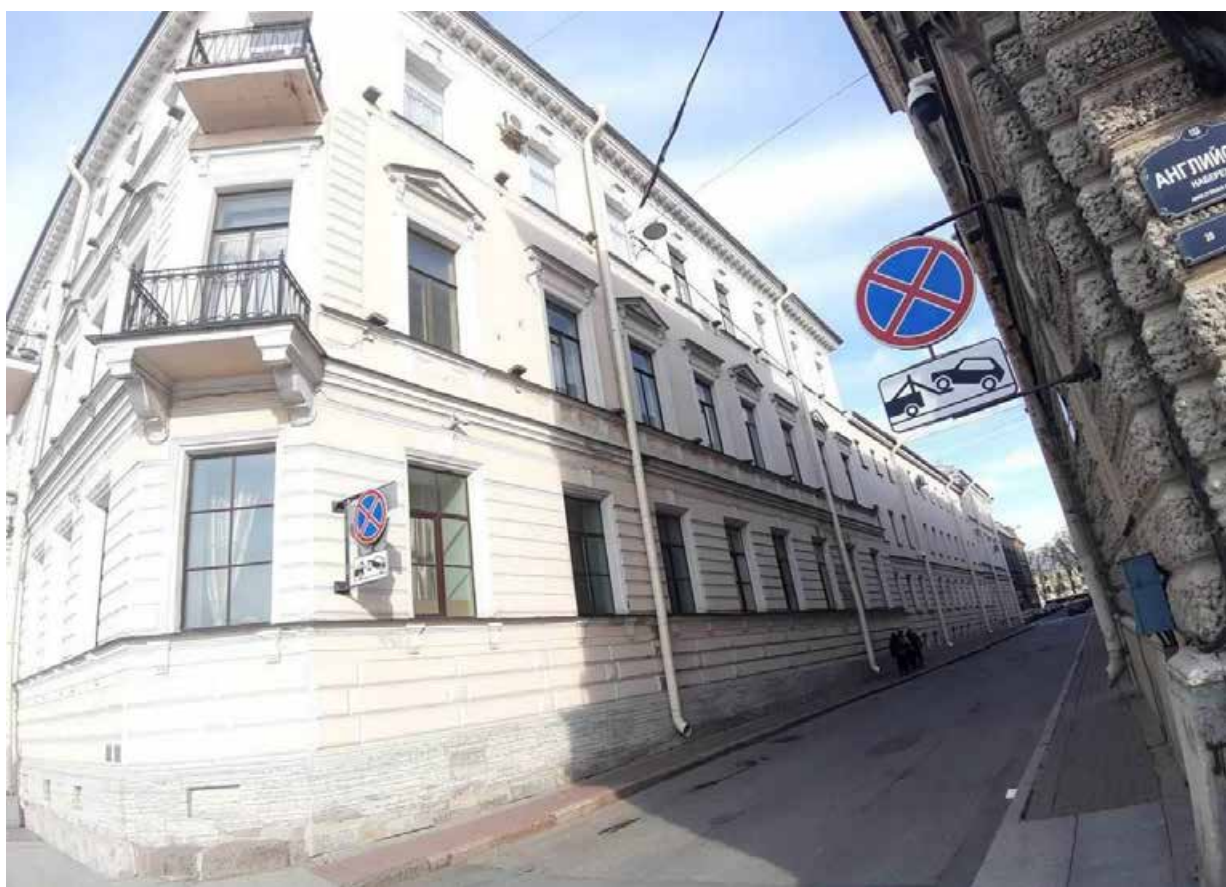
14. «Дом В.П. Орлова-Давыдова» (Галерная ул., д. 19, лит. А). Лицевой фасад по Замятину пер. Фото мест установки оборудования и прокладки кабельных трасс. Штиглиц М.С. 12.05.2025.
