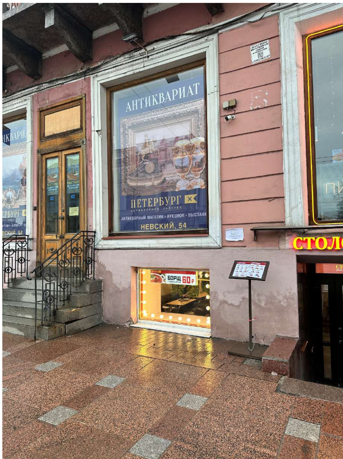
Фото 7. Вид на часть лицевого фасада со стороны Невского пр. в границах рассматриваемых помещений.
