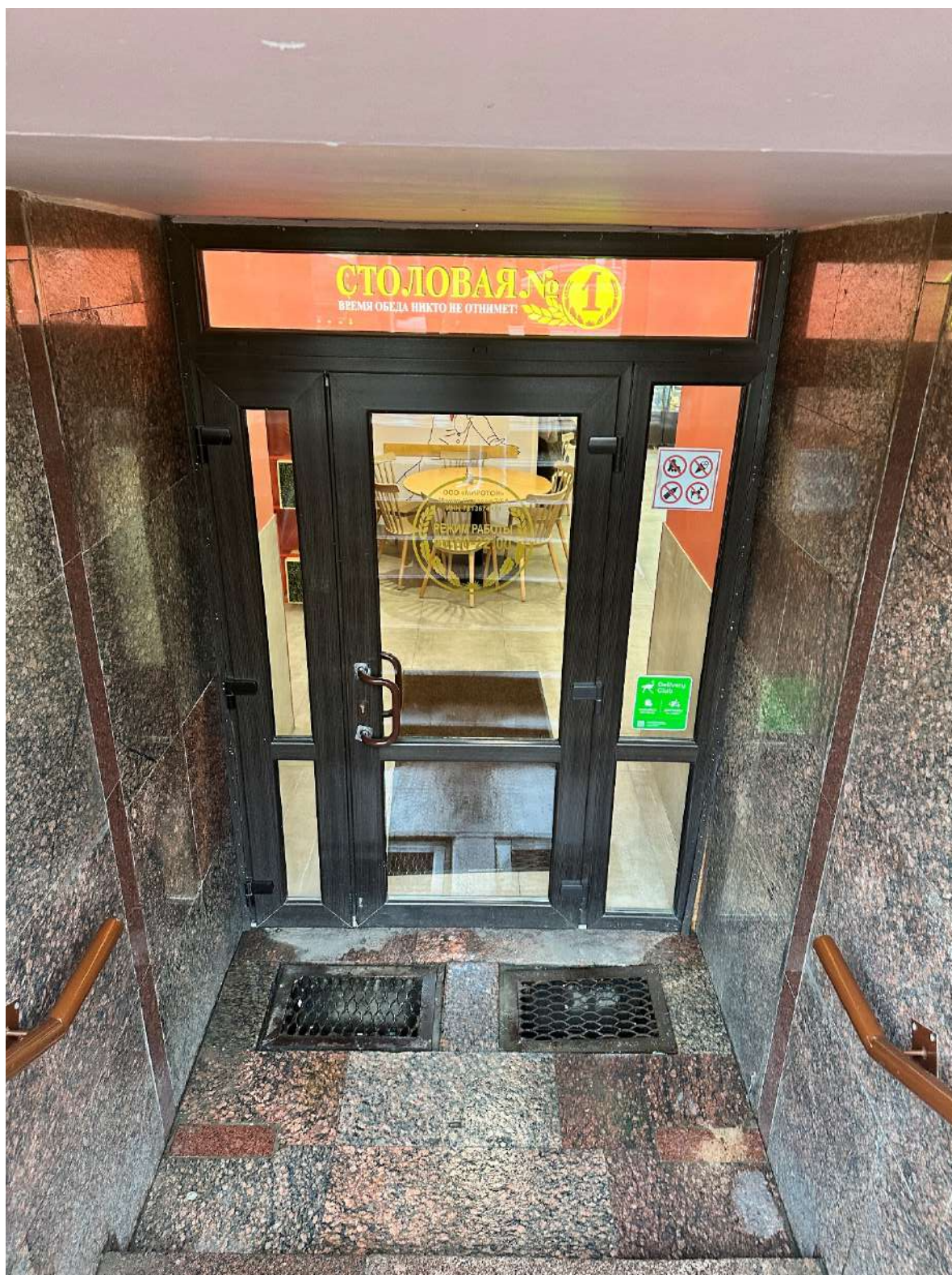
Фото 10. Вид на часть лицевого фасада со стороны Невского пр. в границах рассматриваемых помещений. Главный вход.
