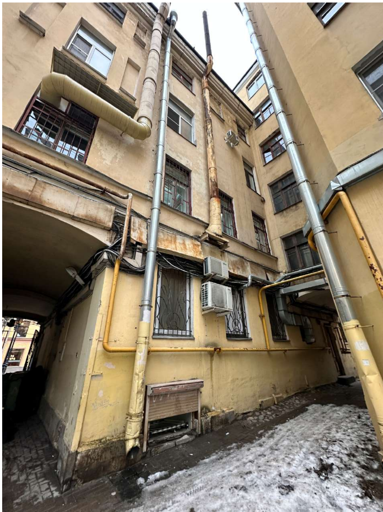
Фото 17. Общий вид на объект со стороны дворового фасада.
