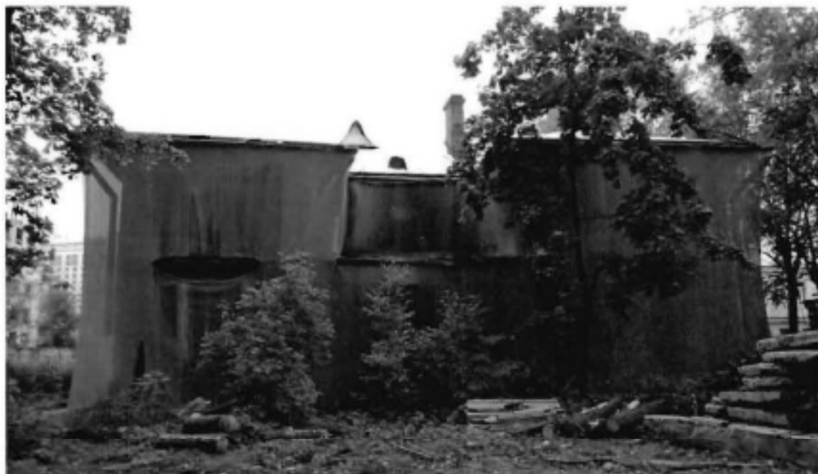
1. Восточный фасад объекта культурного наследия.
