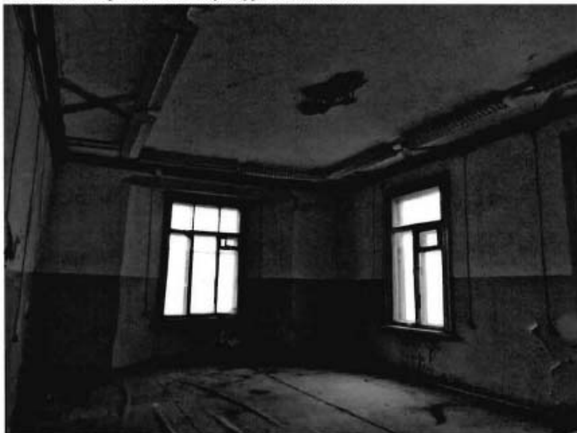
2. Помещение 1-го этажа.
