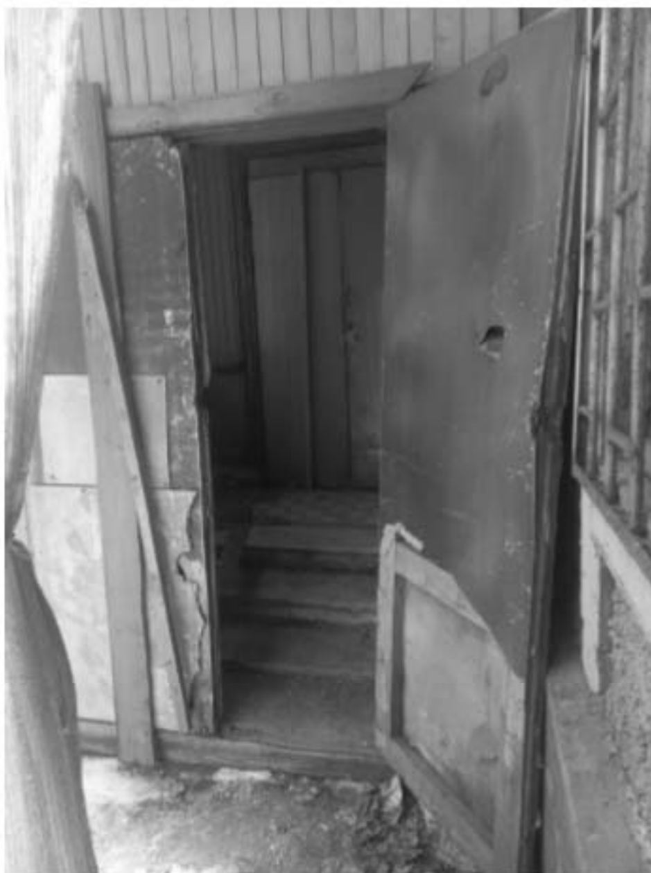
Фото 5. Главный вход в здание.
