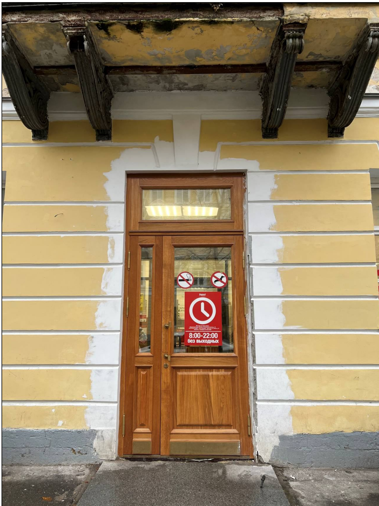
3. Фрагмент лицевого фасада дома №43 со стороны проспекта Ленина.
