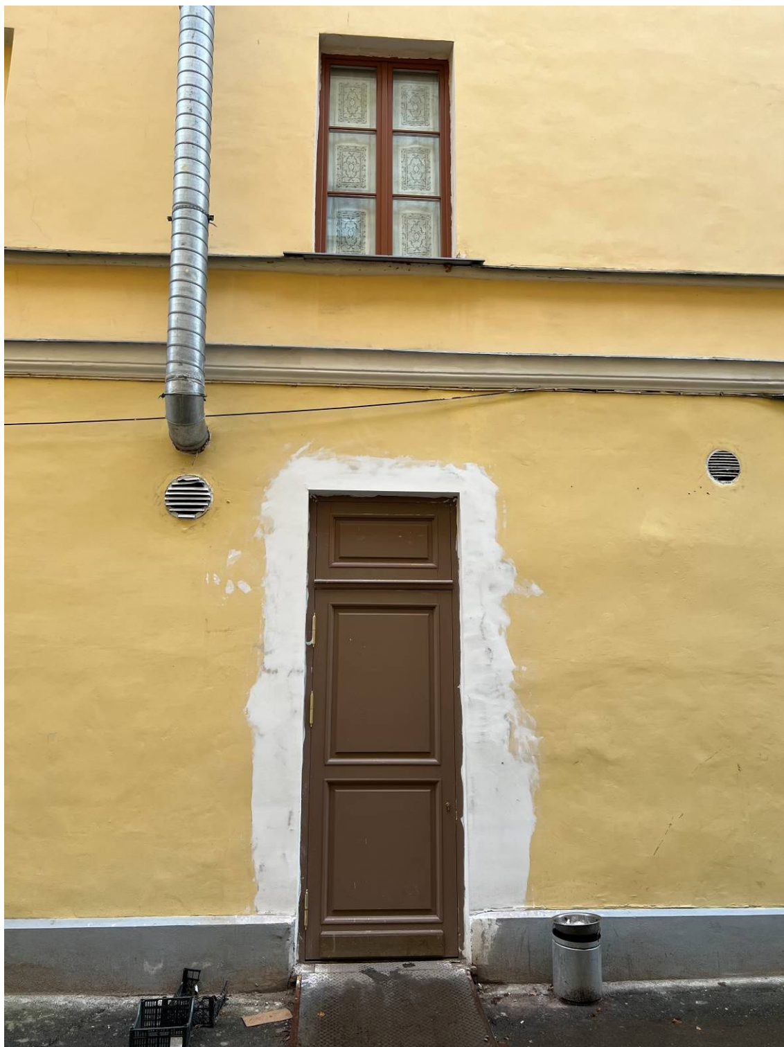
14. Боковой юго-западный фасад. Фрагмент
