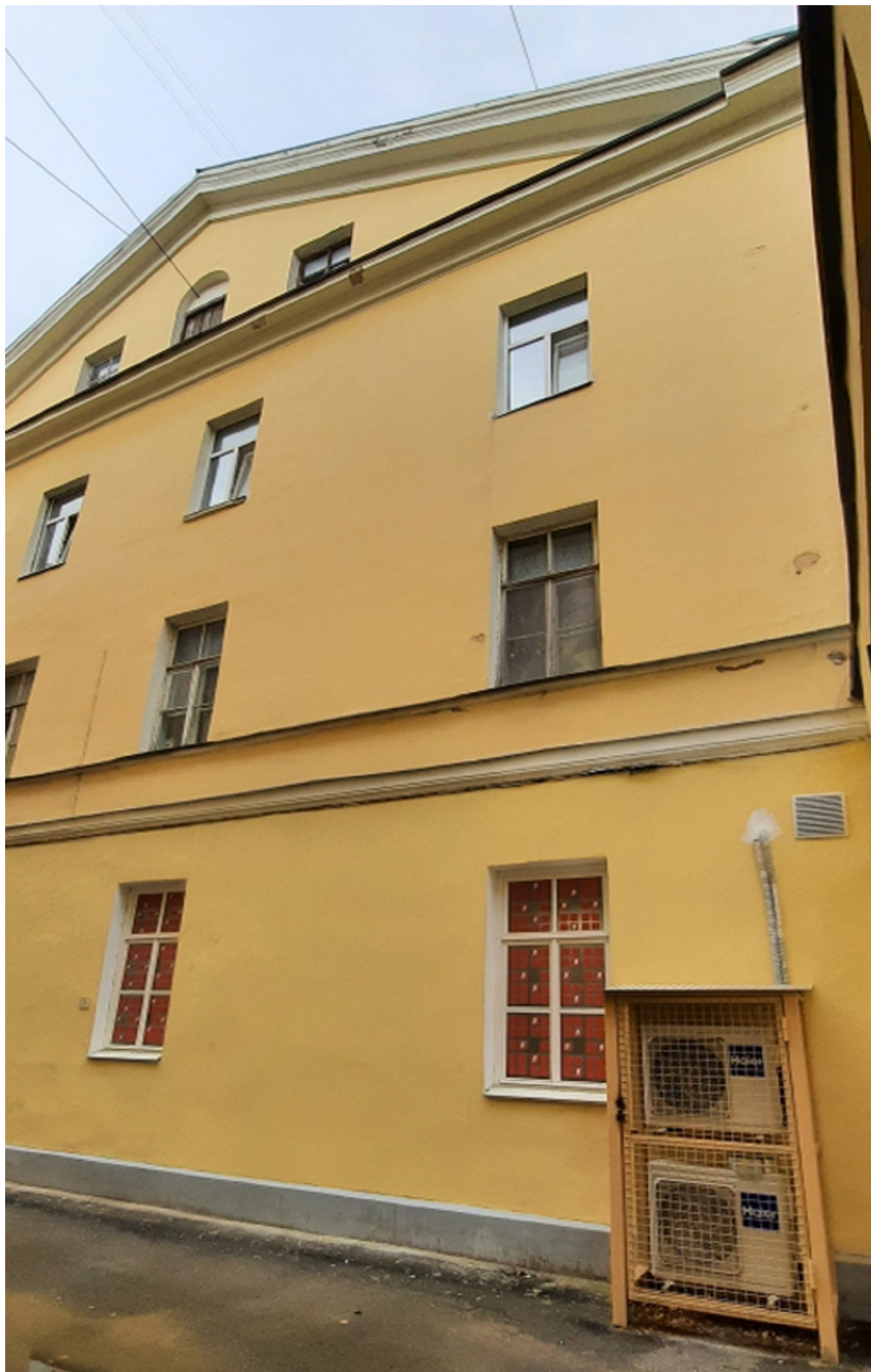
13. Боковой юго-западный фасад. Фрагмент
