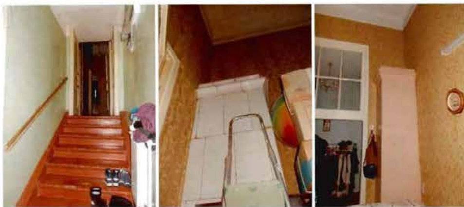
54, 55, 56. Лестница Л-5 (вход со стороны внутреннего двора)
