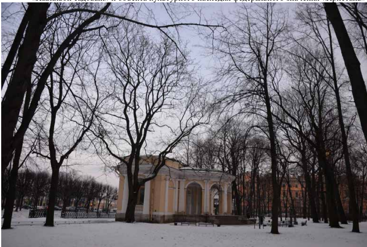
10. Западный фасад объекта культурного наследия федерального значения «Павильон садовый»
