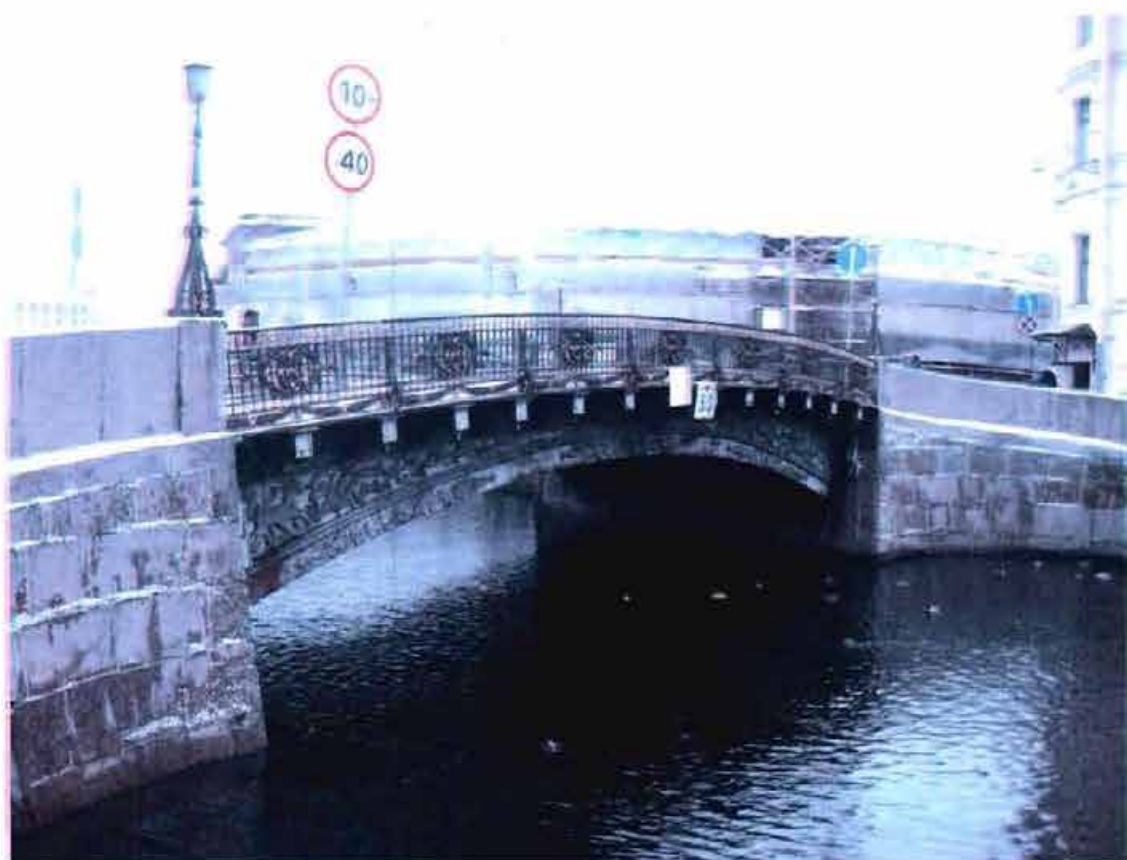
7. Вид моста со стороны низового фасада
