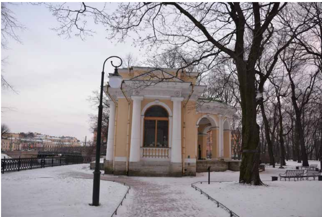
11. Западный фасад объекта культурного наследия федерального значения «Павильон садовый»
