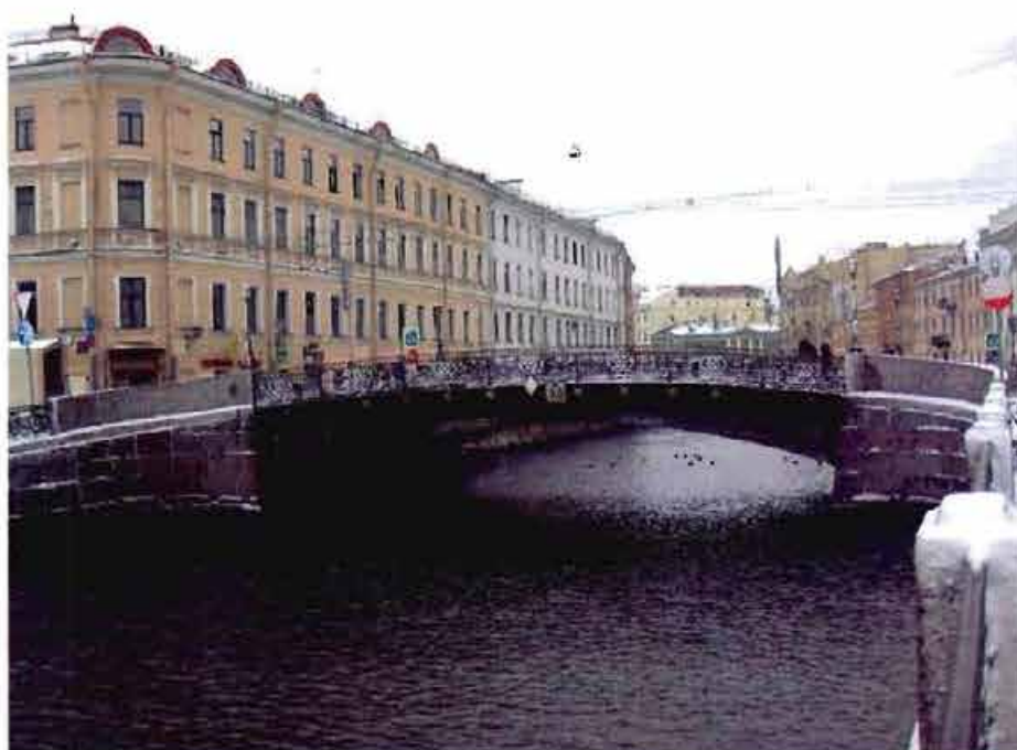
2. Вид моста со стороны верхового фасада
