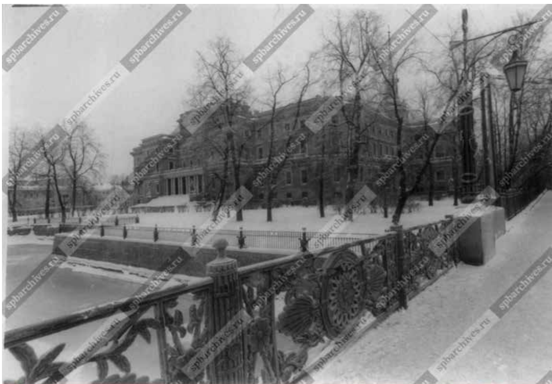
28. Вид на здание Михайловского (Инженерного) замка с Садового моста (архитекторы В.И.Баженов и В.Ф. Бренна, 1797-1800 годы). Кон.1960-х - нач. 1970-х гг. ЦГАКФФД СПб. Фотодокумент Ар 185940
