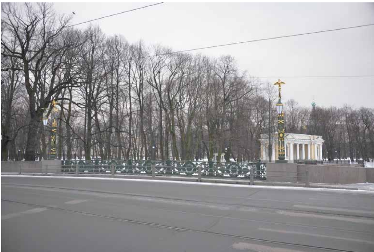
3. Вид на проезжую часть объекта культурного наследия федерального значения «Мост Михайловский (1-й Садовый)»
