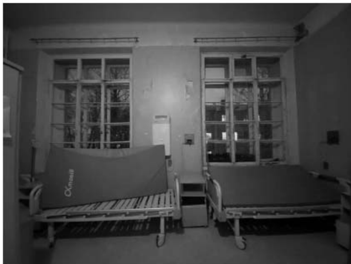
Фото №32. 2-ый этаж. Помещение 5-Н (13).
