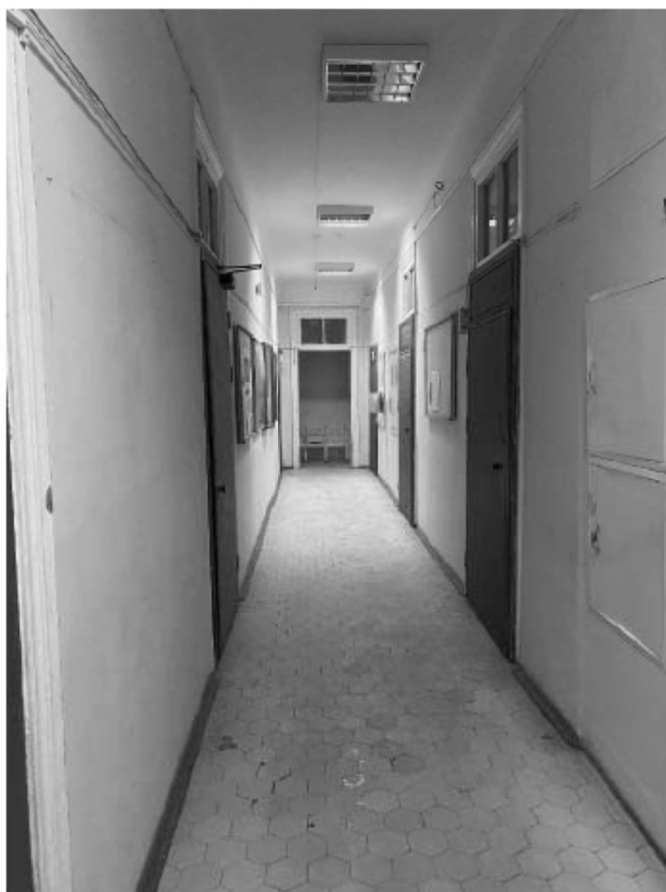
Фото №11. 1-ый этаж. Помещение 4-Н (29).
