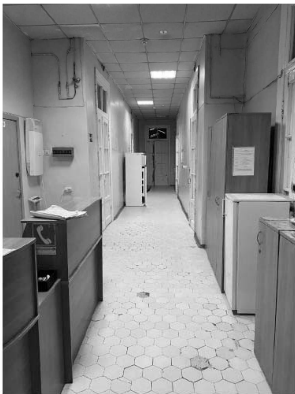
Фото №47. 2-ый этаж. Помещение 5-Н (22).
