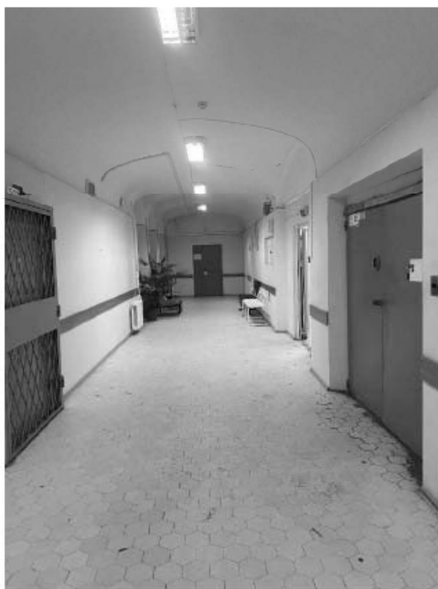
Фото №10. 1-ый этаж. Помещение 4-Н (17).
