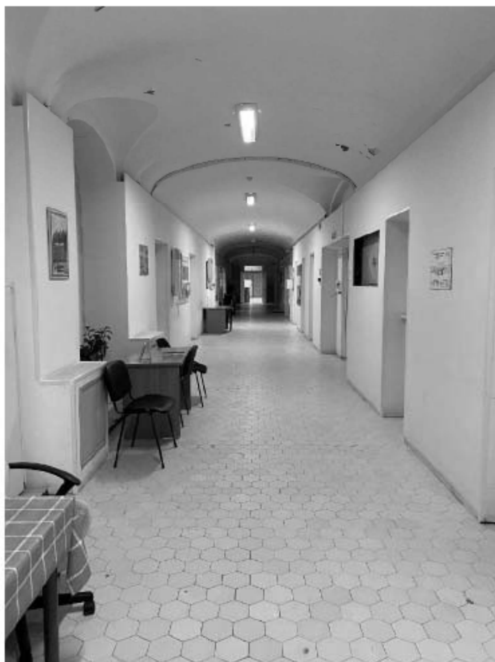
Фото №38. 2-ый этаж. Помещение 5-Н (17).
