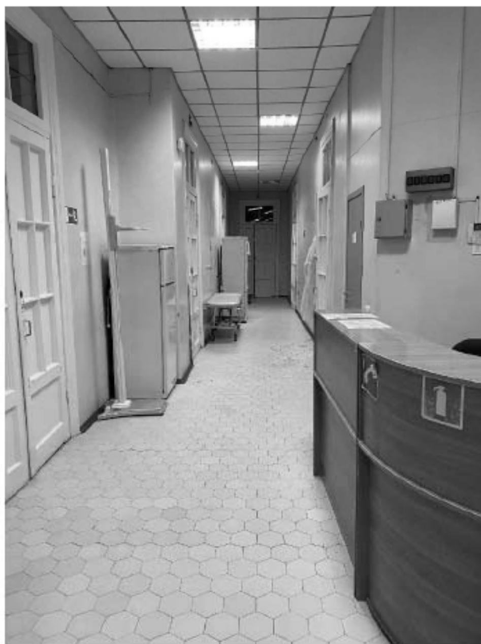
Фото №29. 2-ый этаж. Помещение 5-Н (16).
