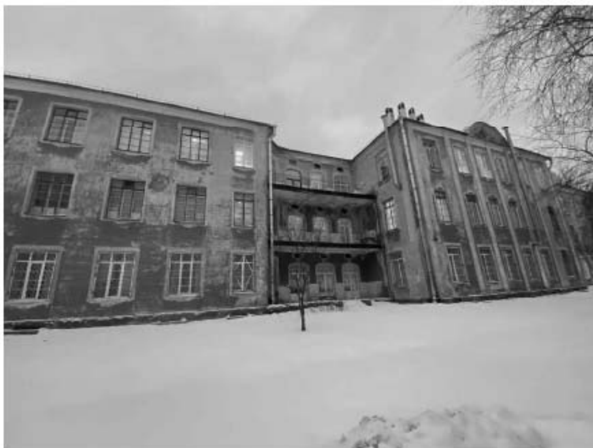
Фото №7. Фрагмент восточного фасада
