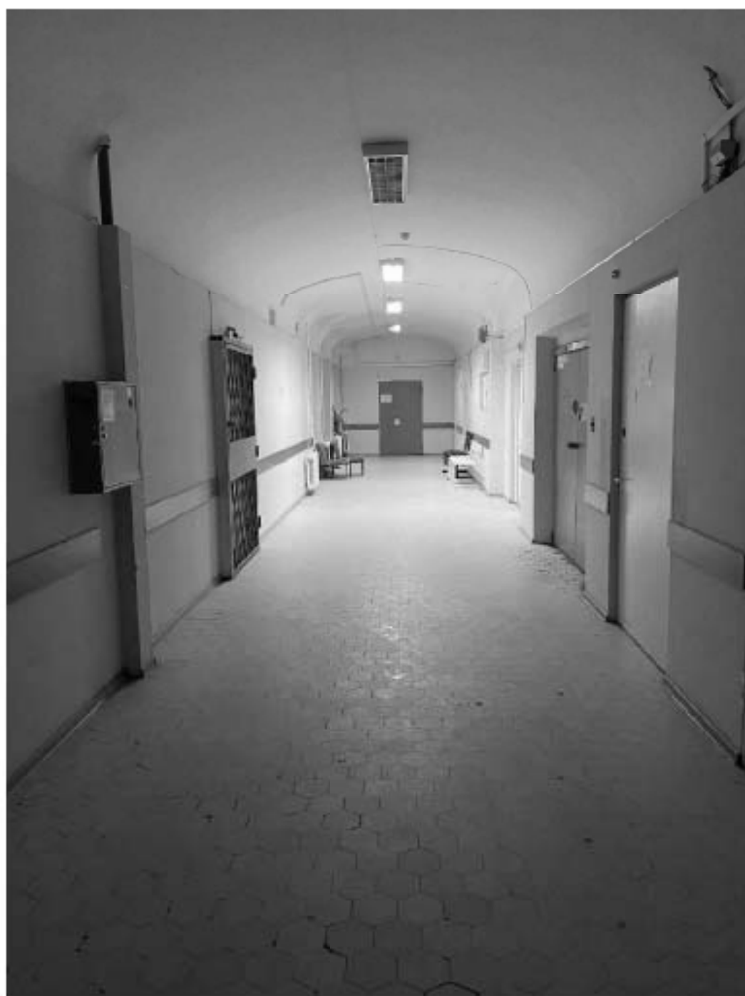
Фото №26. 1-ый этаж. Помещение 4-Н (17).
