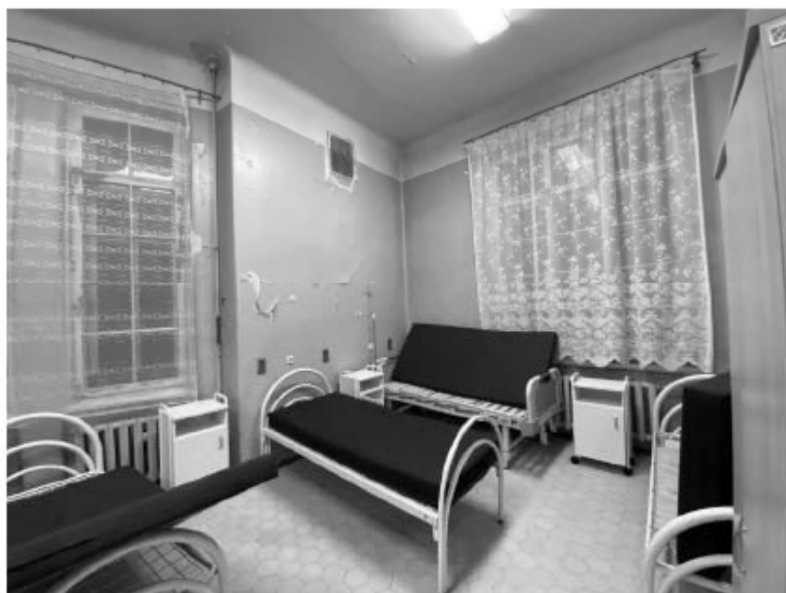
Фото №35. 2-ый этаж. Помещение 5-Н (12).
