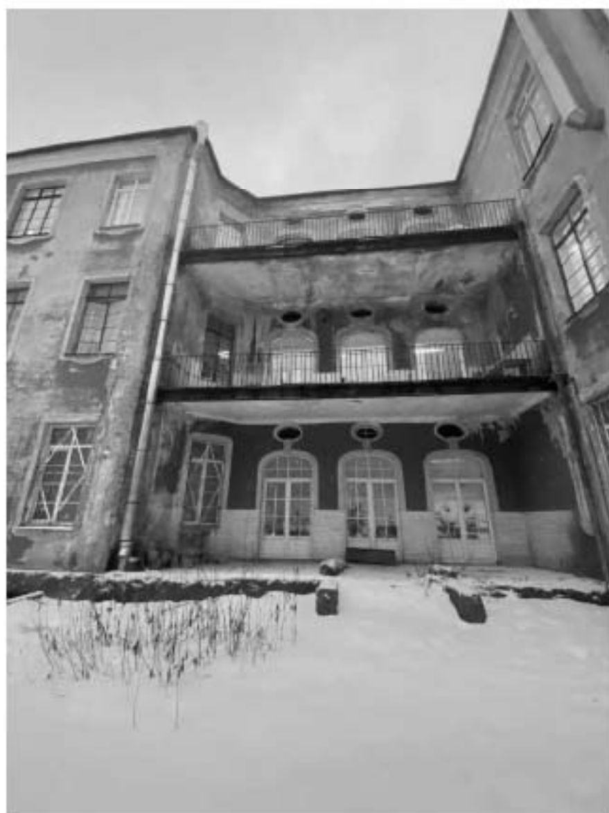
Фото №8. Фрагмент восточного фасада.
