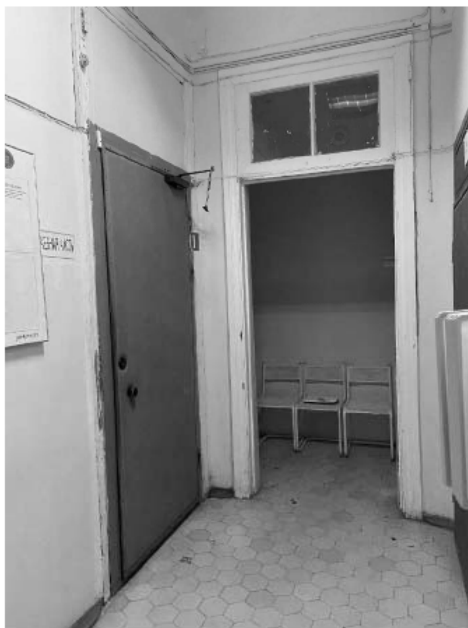
Фото №12. 1-ый этаж. Помещение 4-Н (29).
