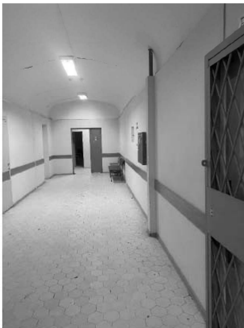
Фото №9. 1-ый этаж. Помещение 4-Н (17).
