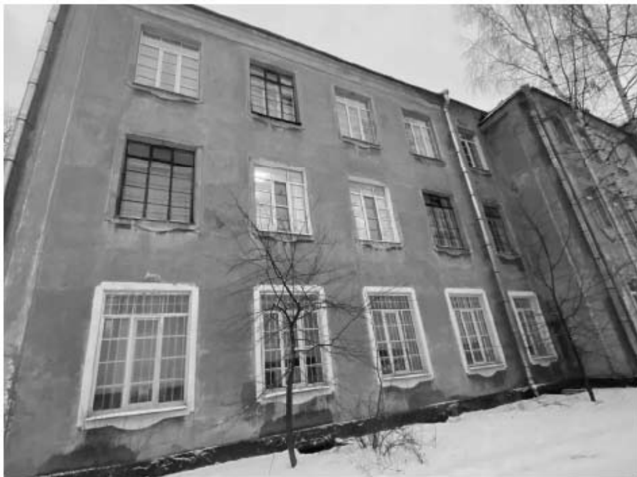
Фото №3. Фрагмент западного фасада.
