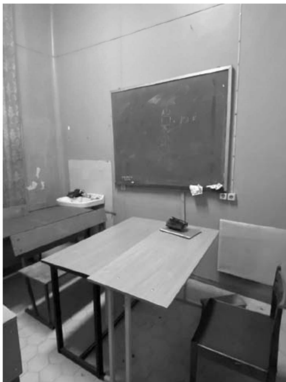
Фото №20. 1-ый этаж. Помещение 4-Н (25).
