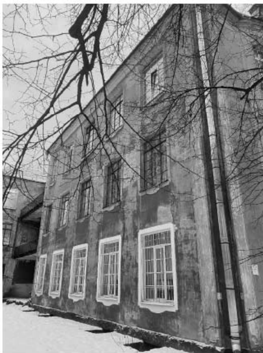
Фото №1. Фрагмент восточного фасада.
