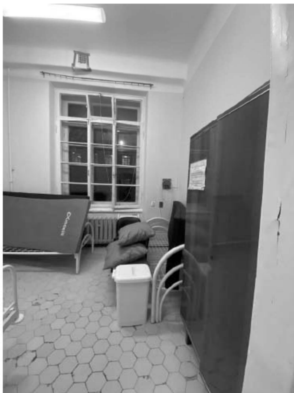
Фото №30. 2-ый этаж. Помещение 5-Н (14).
