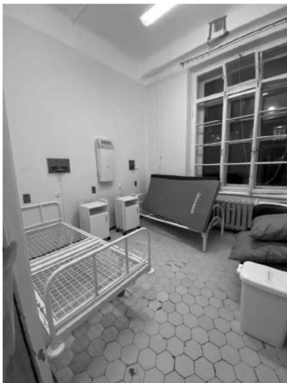
Фото №31. 2-ый этаж. Помещение 5-Н (14).
