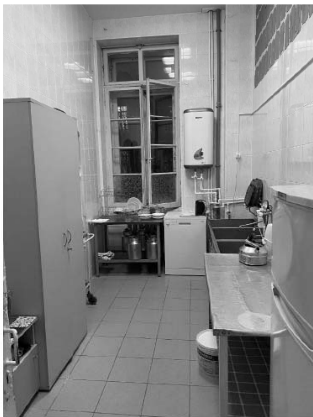
Фото №40. 2-ый этаж. Помещение 5-Н (7).
