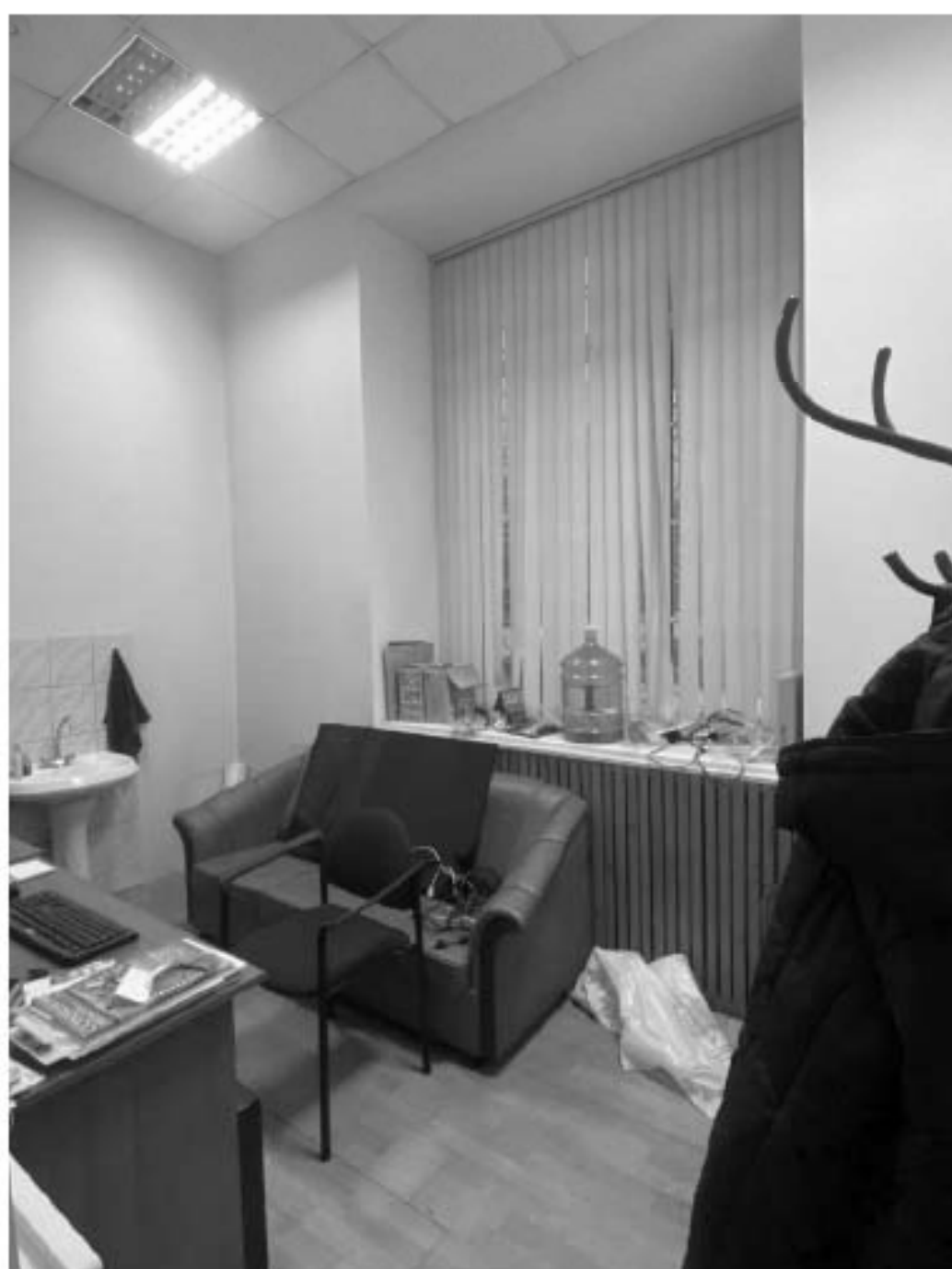
Фото №18. 1-ый этаж. Помещение 4-Н (24).
