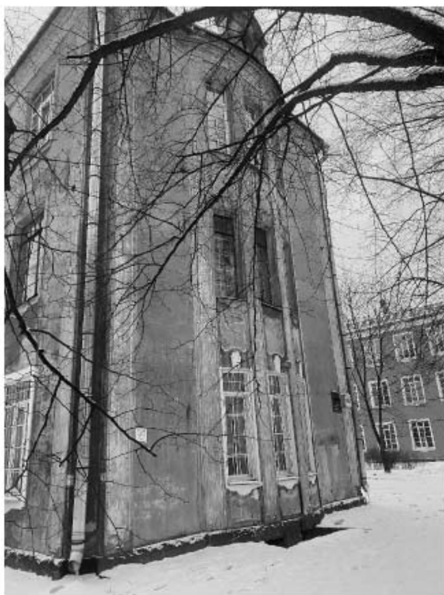
Фото №2. Северный фасад.
