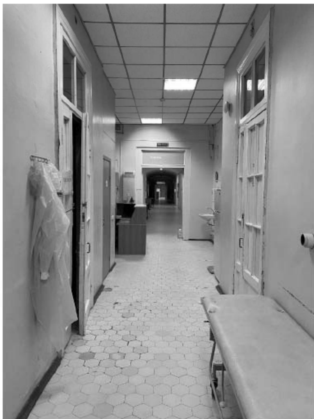
Фото №36. 2-ый этаж. Помещение 5-Н (16, 17).
