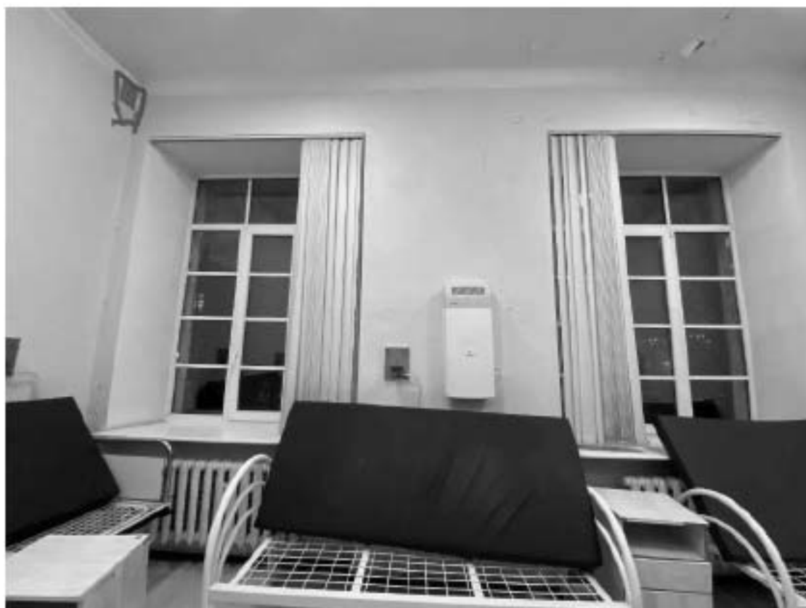
Фото №33. 2-ый этаж. Помещение 5-Н (11).
