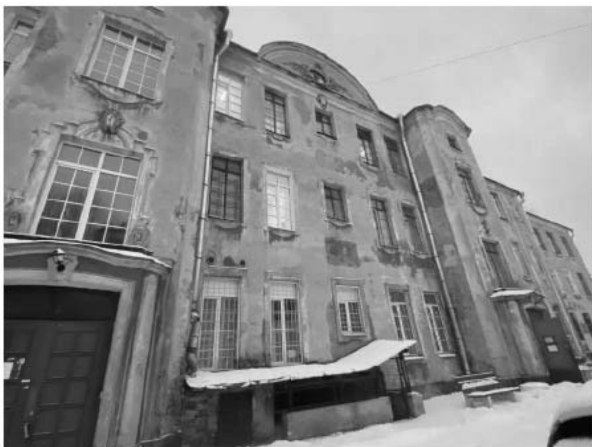
Фото №4. Фрагмент западного фасада.
