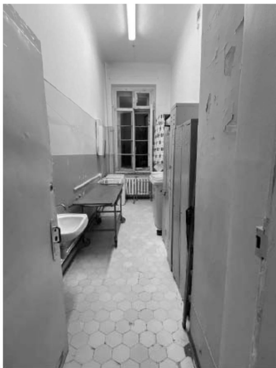
Фото №43. 2-ый этаж. Помещение 5-Н (4).
