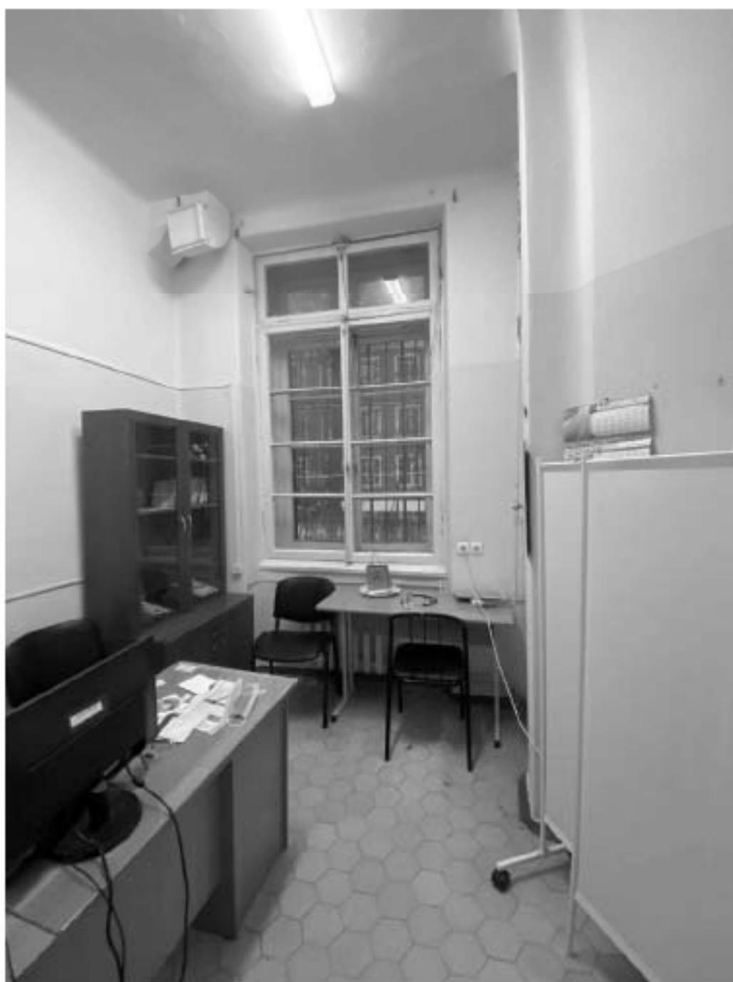
Фото №22. 1-ый этаж. Помещение 4-Н (33).
