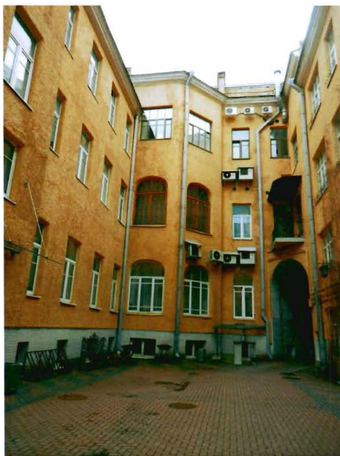
4. Фрагмент дворового фасада
