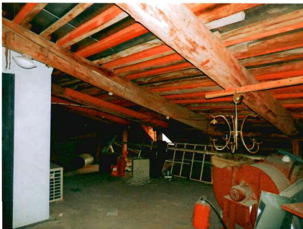
15. Стропильная система
