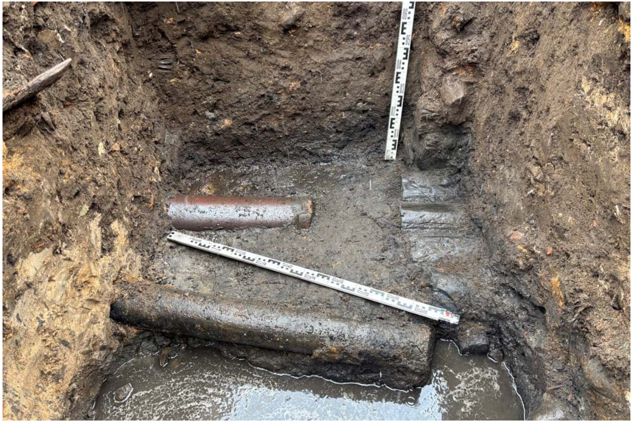
Рис. 44. СПб-2025. Василеостровский р-н. 26-я линия В.О. д. 3. Шурф №3. Водопроводных трубы. На переднем плане чугунная труба, на заднем – керамическая. Вид с северо-запада
