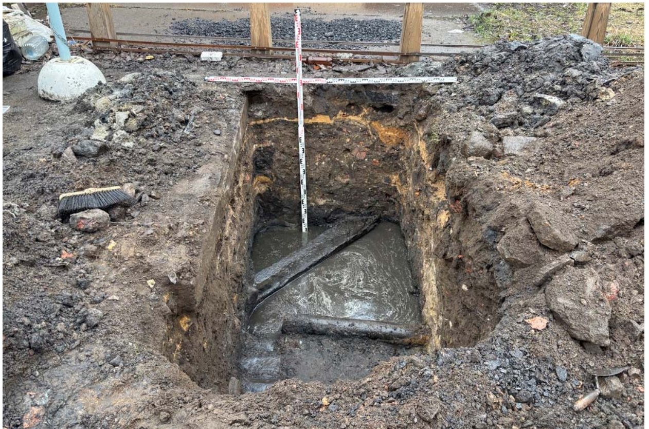
Рис. 43. СПБ-2025. Василеостровский р-н. 26-я линия В.О. д. 3. Шурф №3. Фиксация по уровню материка и залегания водопроводных труб. Вид с юго-востока
