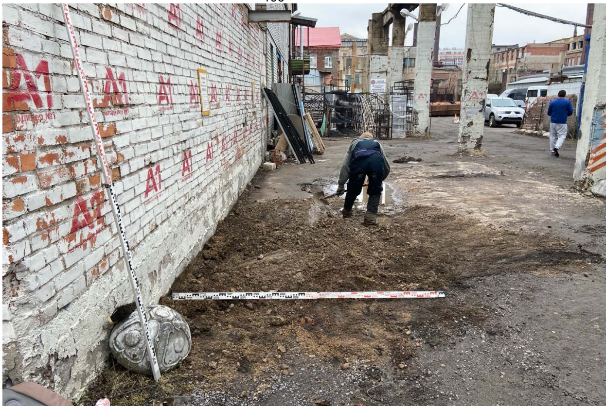
Рис. 40. СПБ-2025. Василеостровский р-н. 26-я линия В.О. 3. Шурф №2. Вид после рекультивации. Вид с юга
