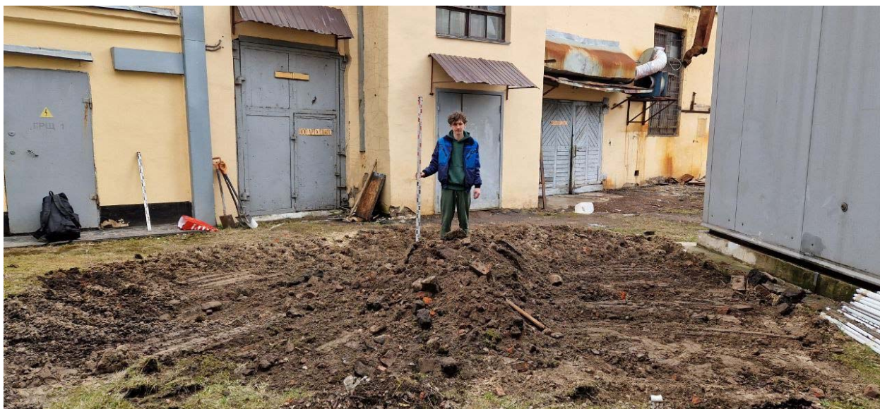
Рис. 37. СПб-2025. Василеостровский р-н. 26-я линия В.О. 1. Шурф №1. Вид после Рекультивации. Вид с севера
