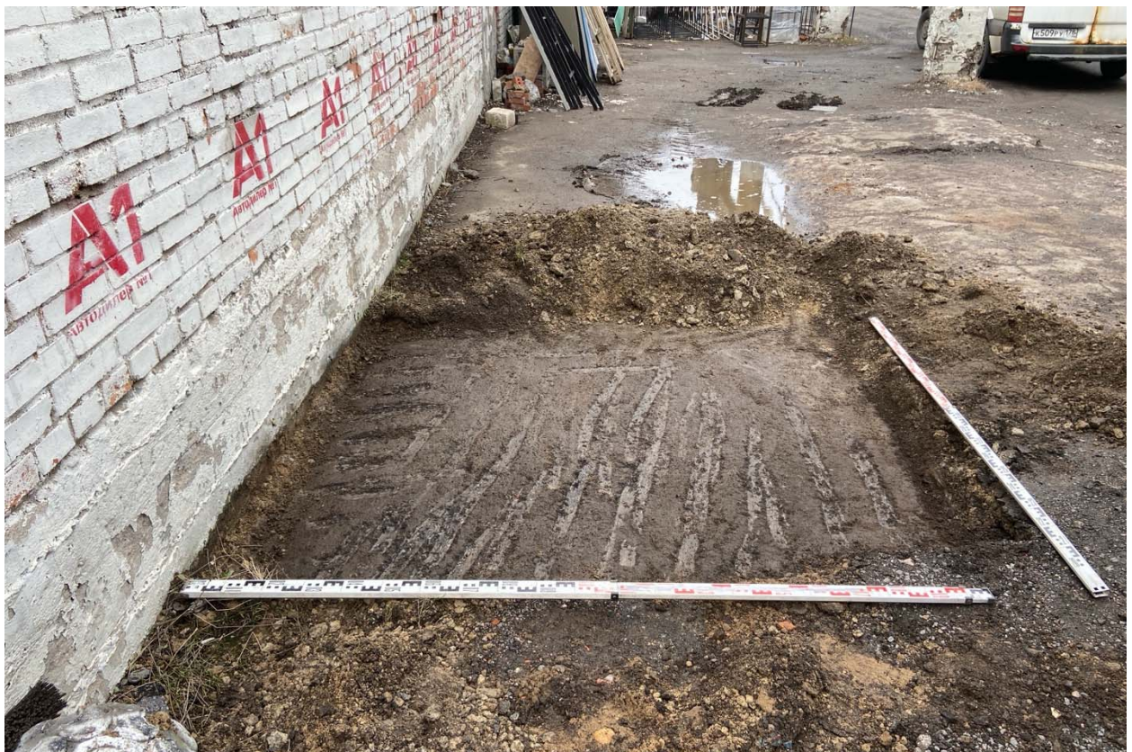
Рис. 39. СПБ-2025. Василеостровский р-н. 26-я линия В.О. д. 3. Шурф №2. Фиксация по уровню бетонной плиты и прекращения работ. Вид с юга
