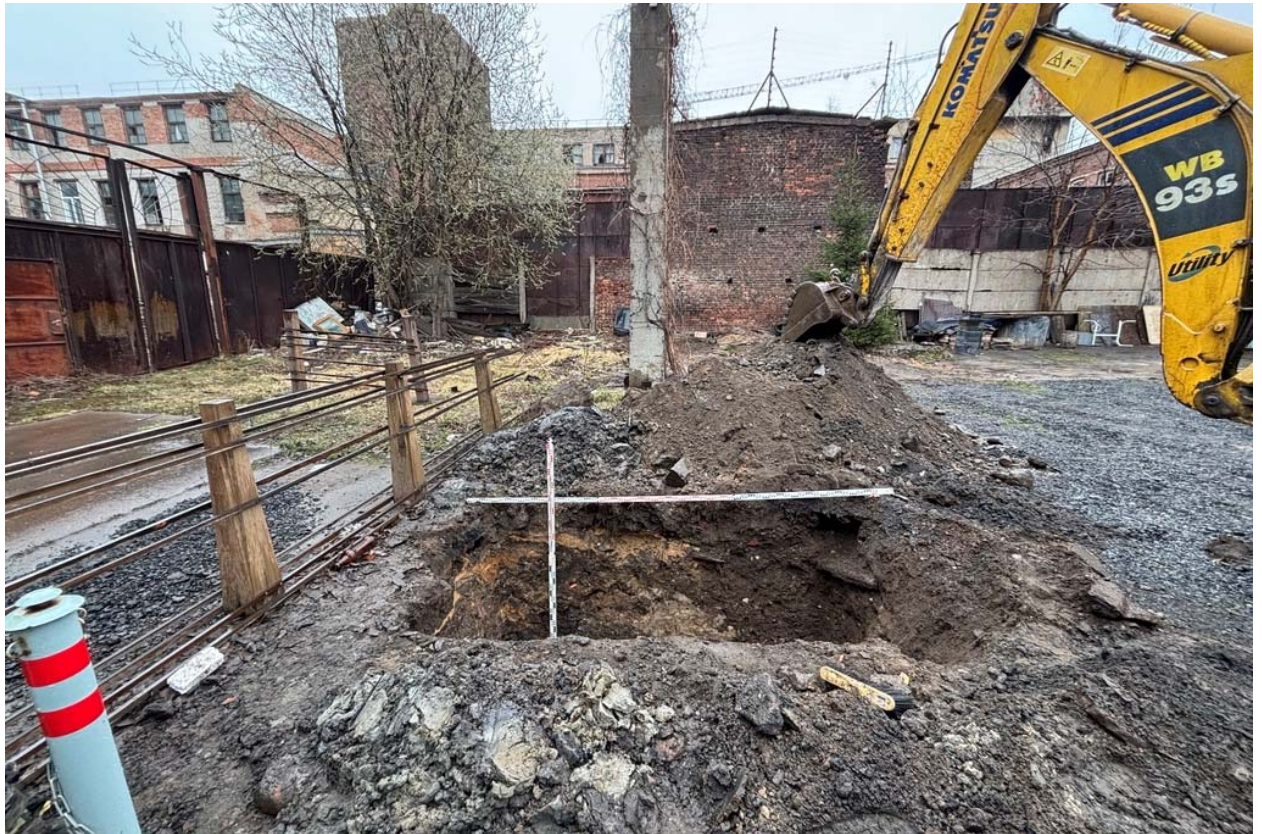
Рис. 42. СПБ-2025. Василеостровский р-н. 26-я линия В.О. д. 3. Шурф №3. Вид выкопанного шурфа. Вид с юго-запада
