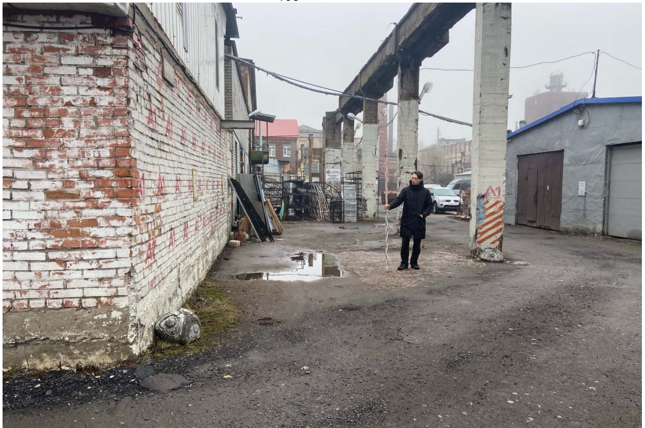
Рис. 38. СПБ-2025. Василеостровский р-н. 26-я линия В.О. д. 3. Шурф №2. Вид до начала работ. Вид с юга
