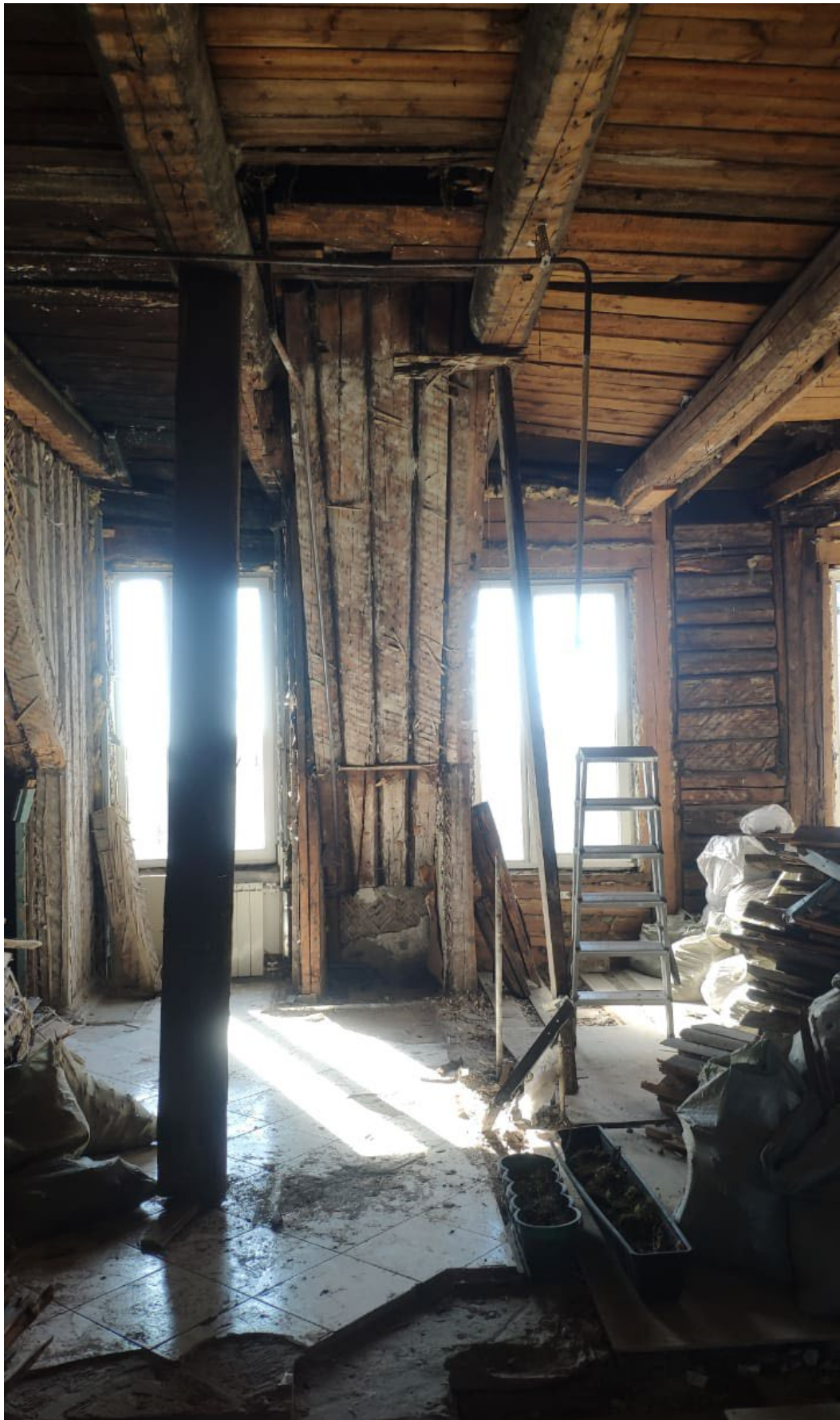
Фото № 2. Интерьер квартиры № 26. Помещения 1,6,7,8,9,10. Перегородки и ценные элементы архитектурно-художественной отделки отсутствуют. Проводятся противоаварийные работы.
