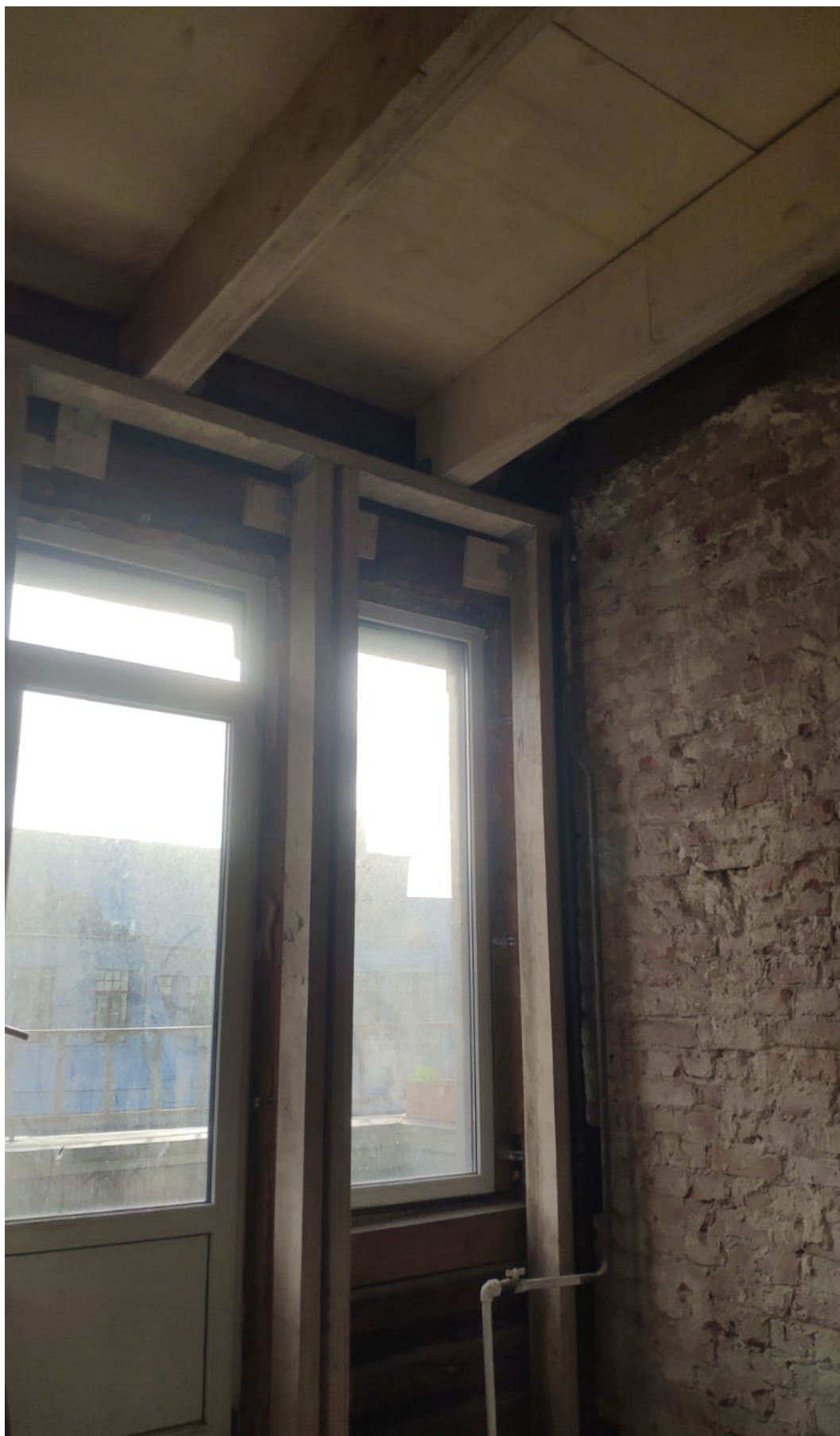
Фото № 11. Интерьер квартиры № 26. Помещение 4. Ценные элементы архитектурно-художественной отделки отсутствуют. Потолок разобран. Проводятся противоаварийные работы.
