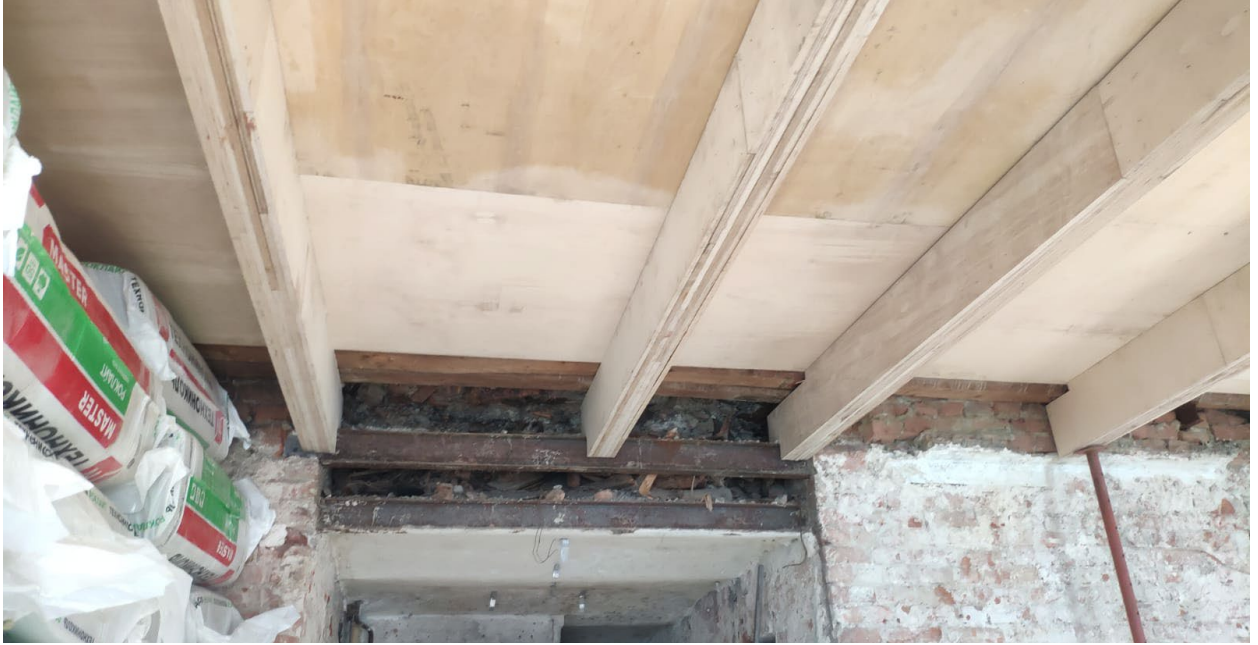
Фото № 14. Интерьер квартиры № 26. Помещение 4. Ценные элементы архитектурно-художественной отделки отсутствуют. Потолок разобран. Проводятся противоаварийные работы.
