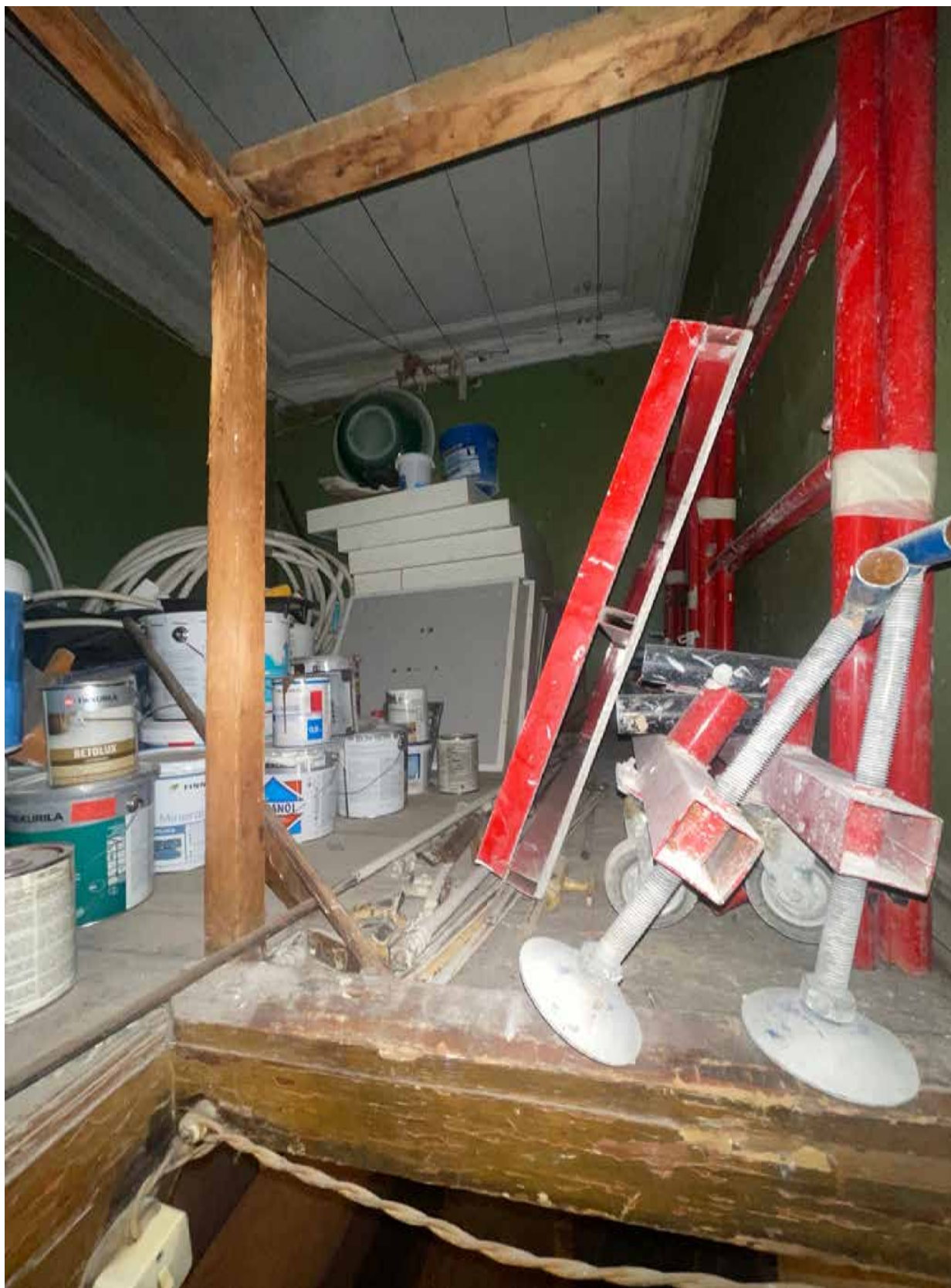
40. Фрагмент интерьера технической полки (антресоли) (помещение 26/13.2).
