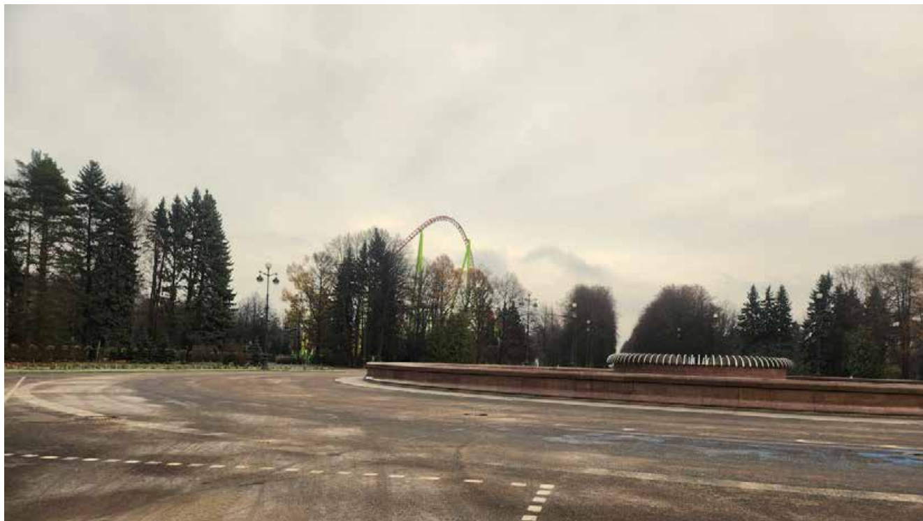
Фото 23. ОКН регионального значения «Приморский парк Победы» по адресу: г. Санкт-Петербург, Крестовский остров. Дата съемки 13.11.2024
