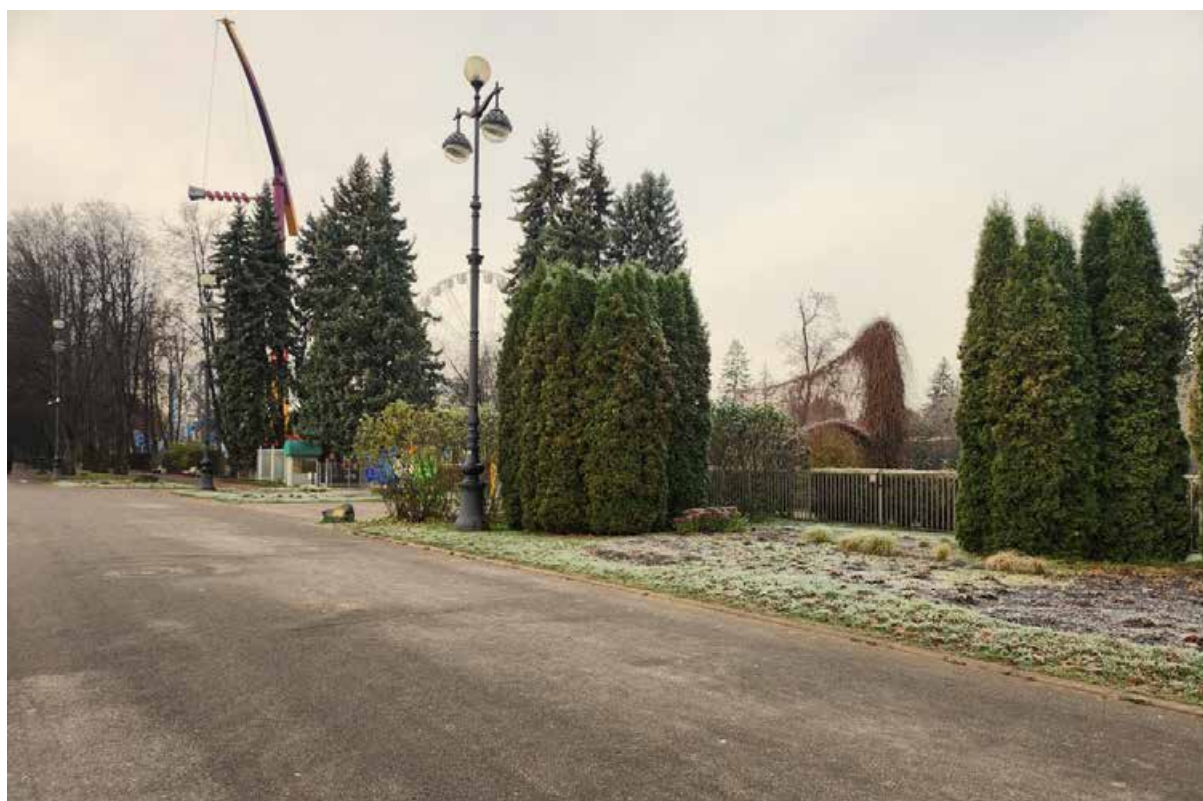
Фото 4. ОКН регионального значения «Приморский парк Победы» по адресу: г. Санкт-Петербург, Крестовский остров. Дата съемки 13.11.2024
