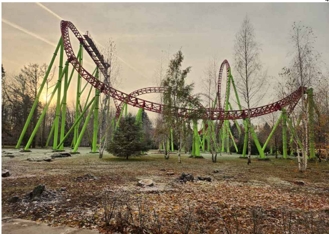
Фото 21. ОКН регионального значения «Приморский парк Победы» по адресу: г. Санкт-Петербург, Крестовский остров. Дата съемки 13.11.2024
