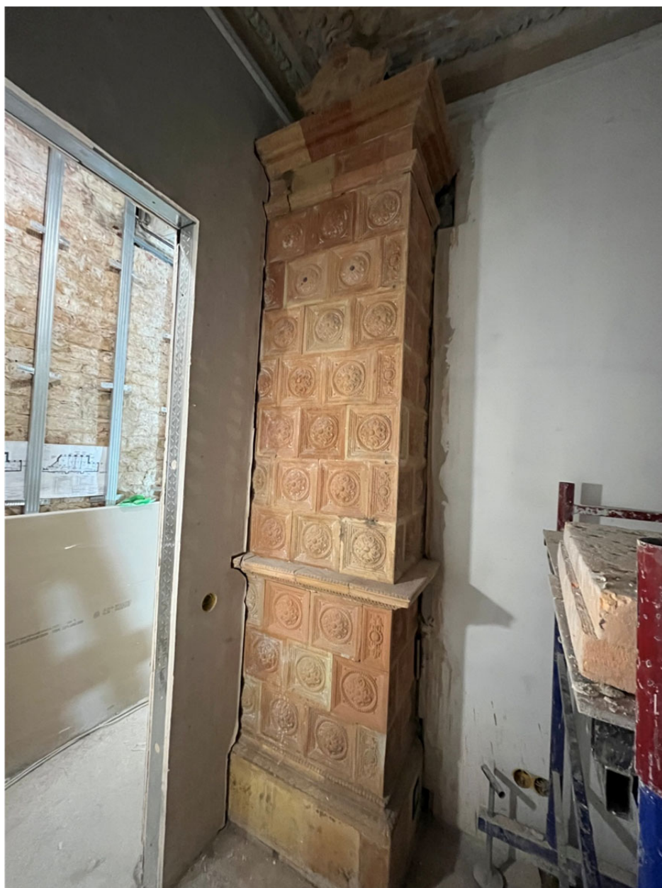
Фото №19. Квартира №12, комната №7. Печь.
