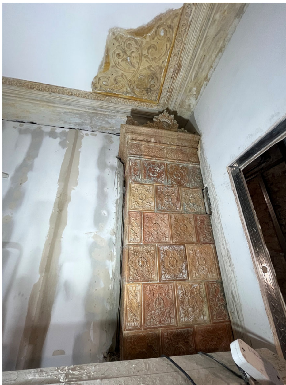
Фото №16. Квартира №12, комната №8. Печь.
