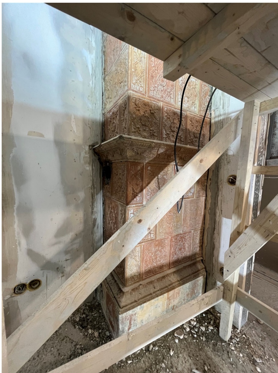
Фото №17. Квартира №12, комната №8. Печь.
