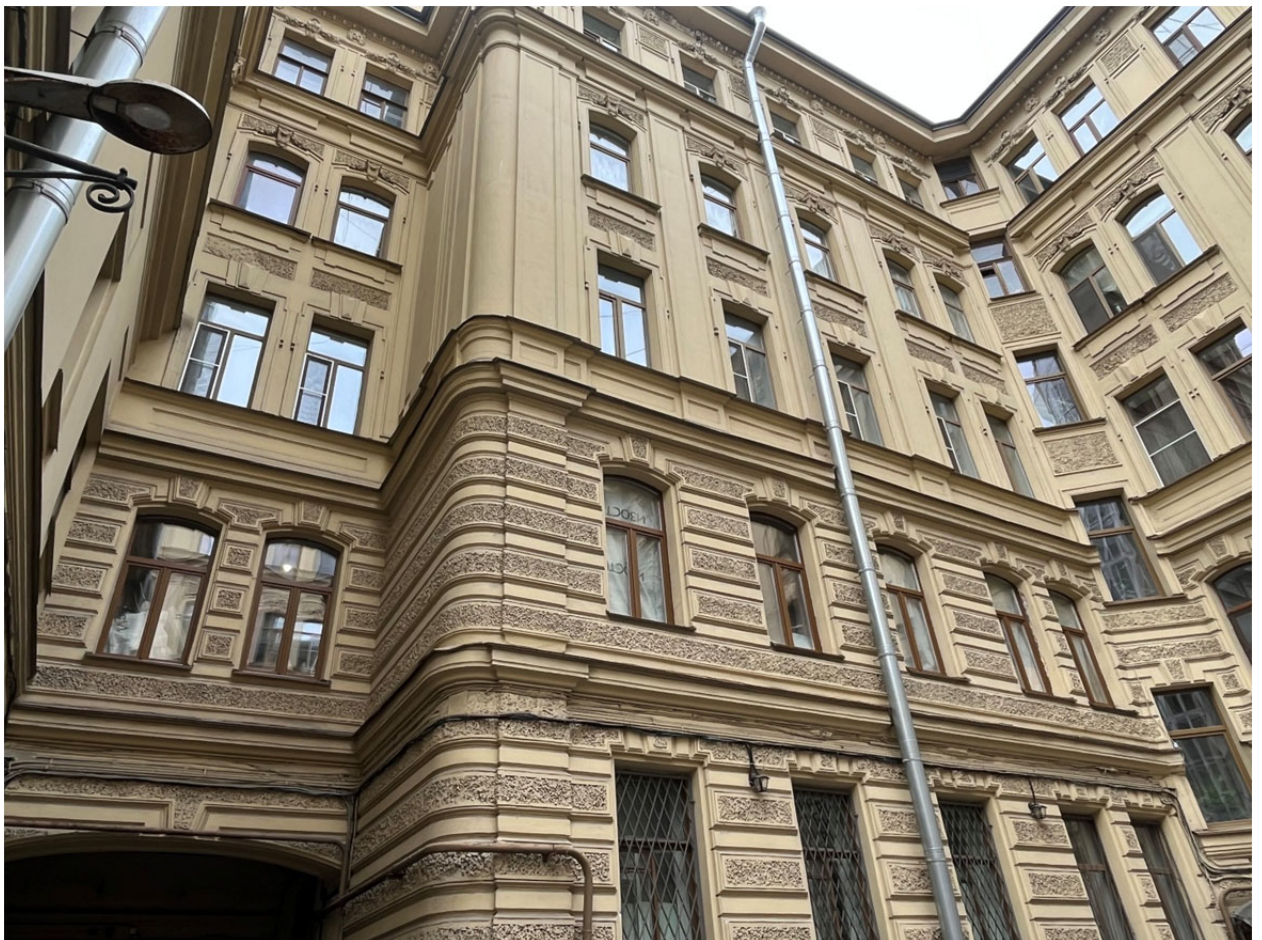
Фото №4. Восточный дворовый фасад западного дворового корпуса. Окна квартиры.
