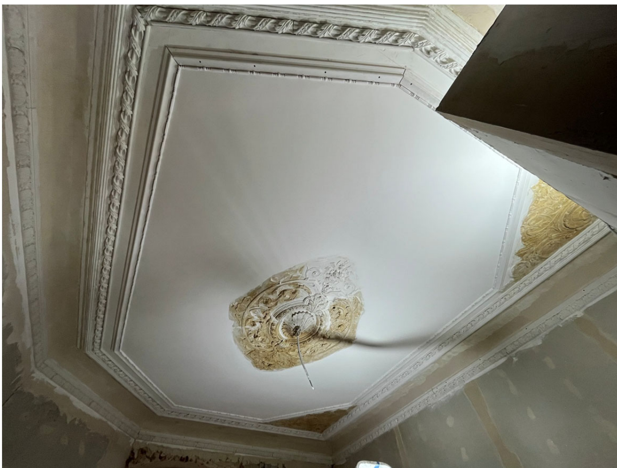
Фото №8. Квартира №12, комната №9, отделка потолка.
