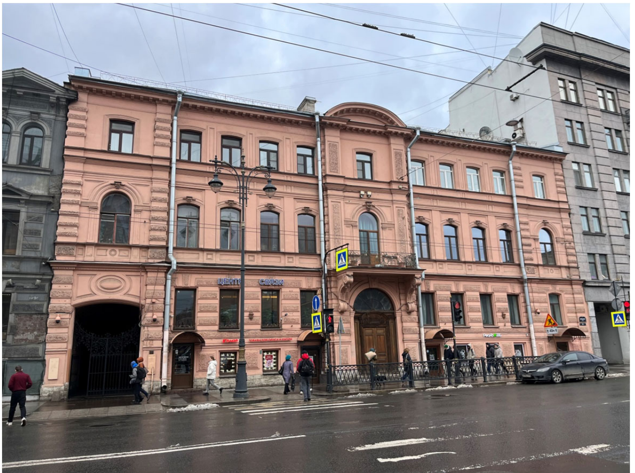
Фото №1. Южный лицевой фасад лицевого корпуса.
