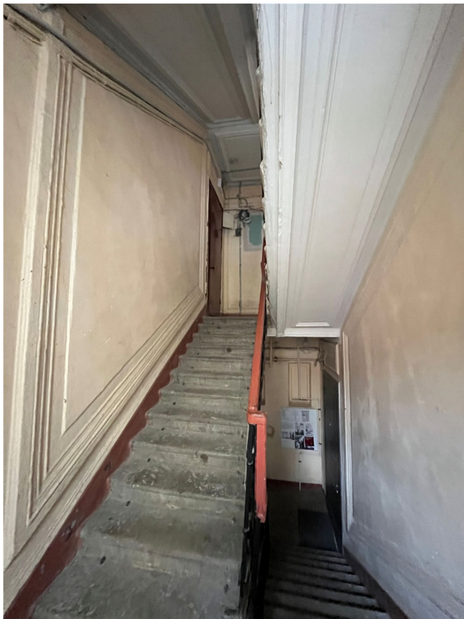
Фото №5. Вид на лестничную площадку второго этажа, вход в квартиру №12.
