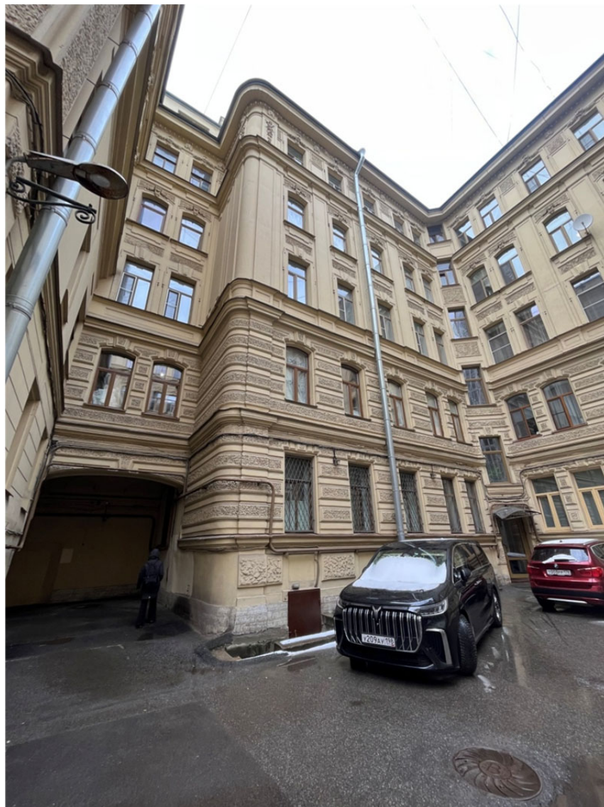
Фото №2. Восточный дворовый фасад западного дворового корпуса.
