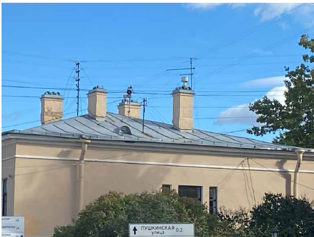
Фото 3. Крыша со стороны Оранжерейной улицы
