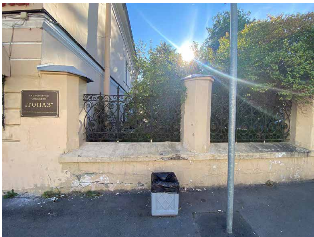
Фото 4. Часть садового ограждения со стороны Оранжерейной улицы
