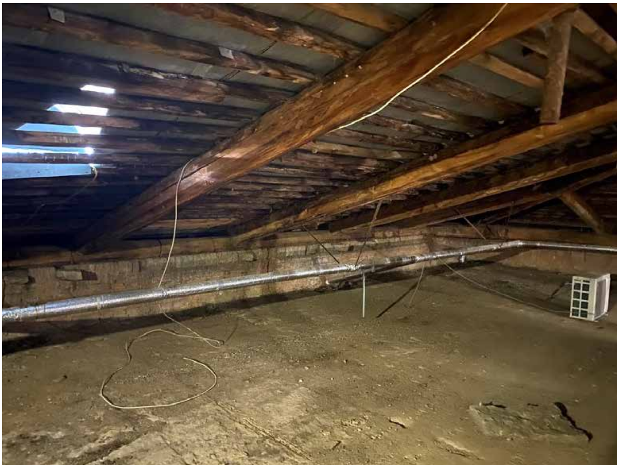
Фото 218. Чердак. Слуховое окно по фасаду кровли.
