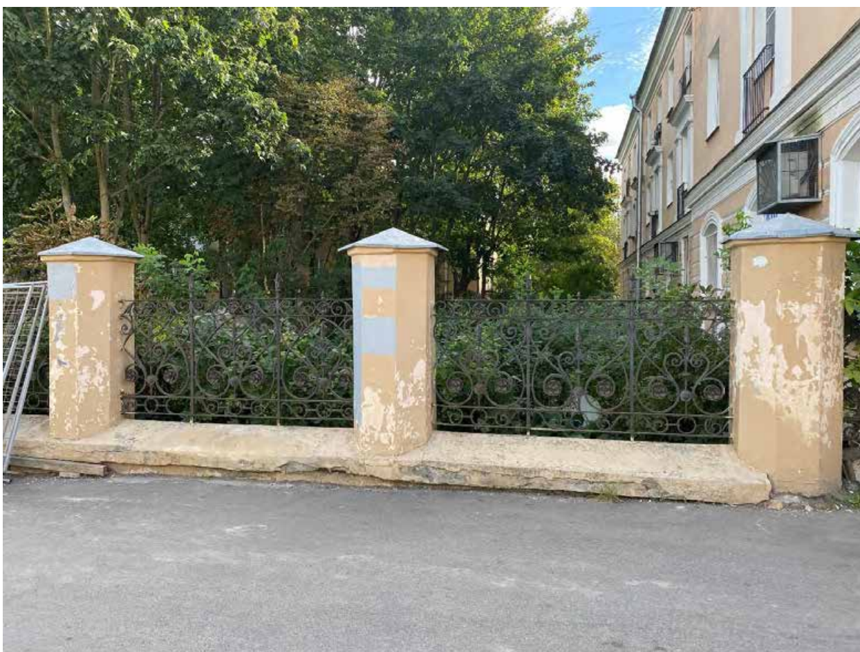
Фото 35. Часть садового ограждения со стороны Оранжерейной улицы
