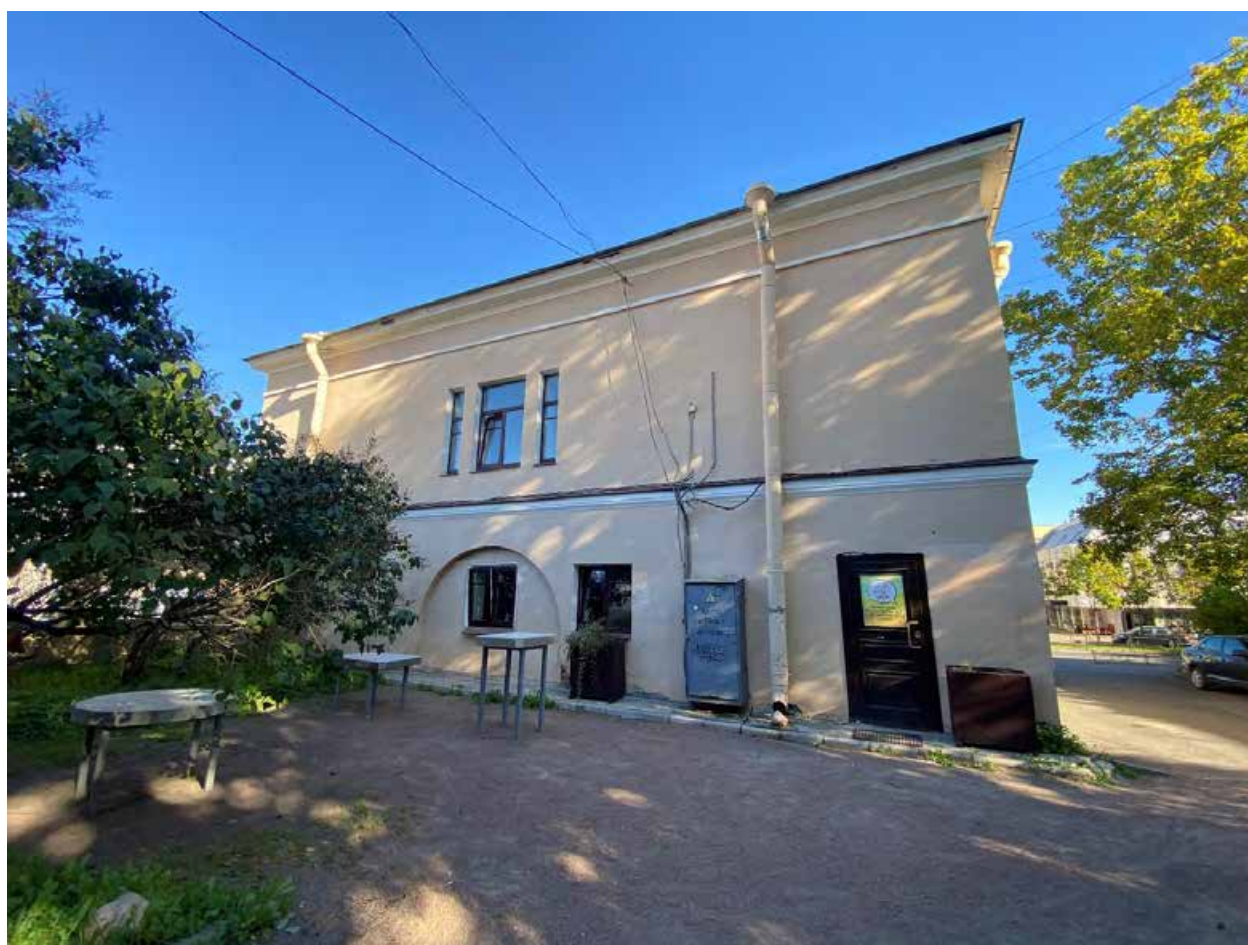
Фото 17. Юго-западный фасад со стороны городского сквера.
