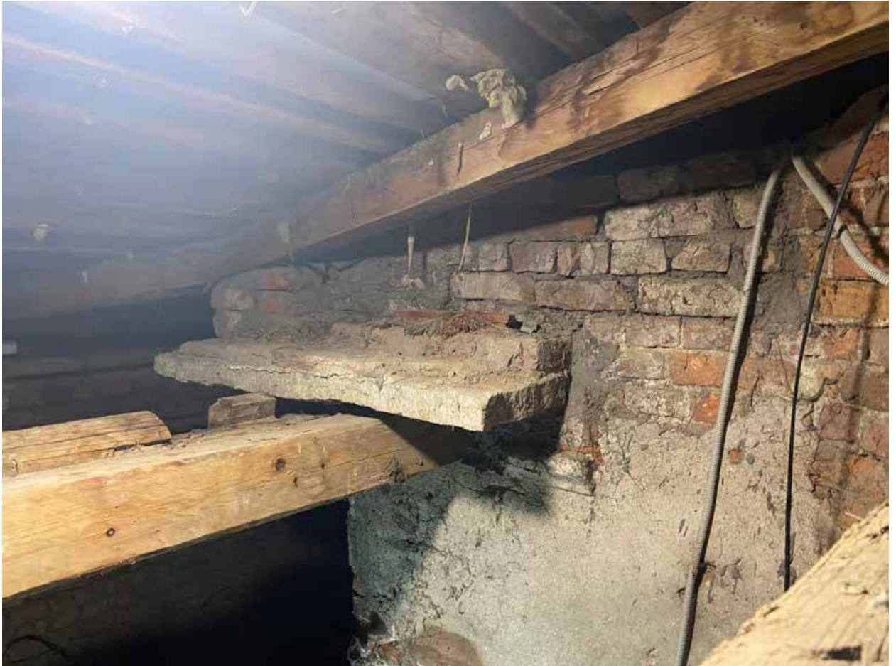
Фото 201. Чердак. Угловое примыкание наклонных дощатых стропил и перекрытия.
