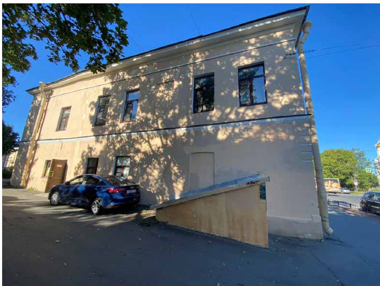
Фото 22. Юго-восточная часть тыльного фасада.
