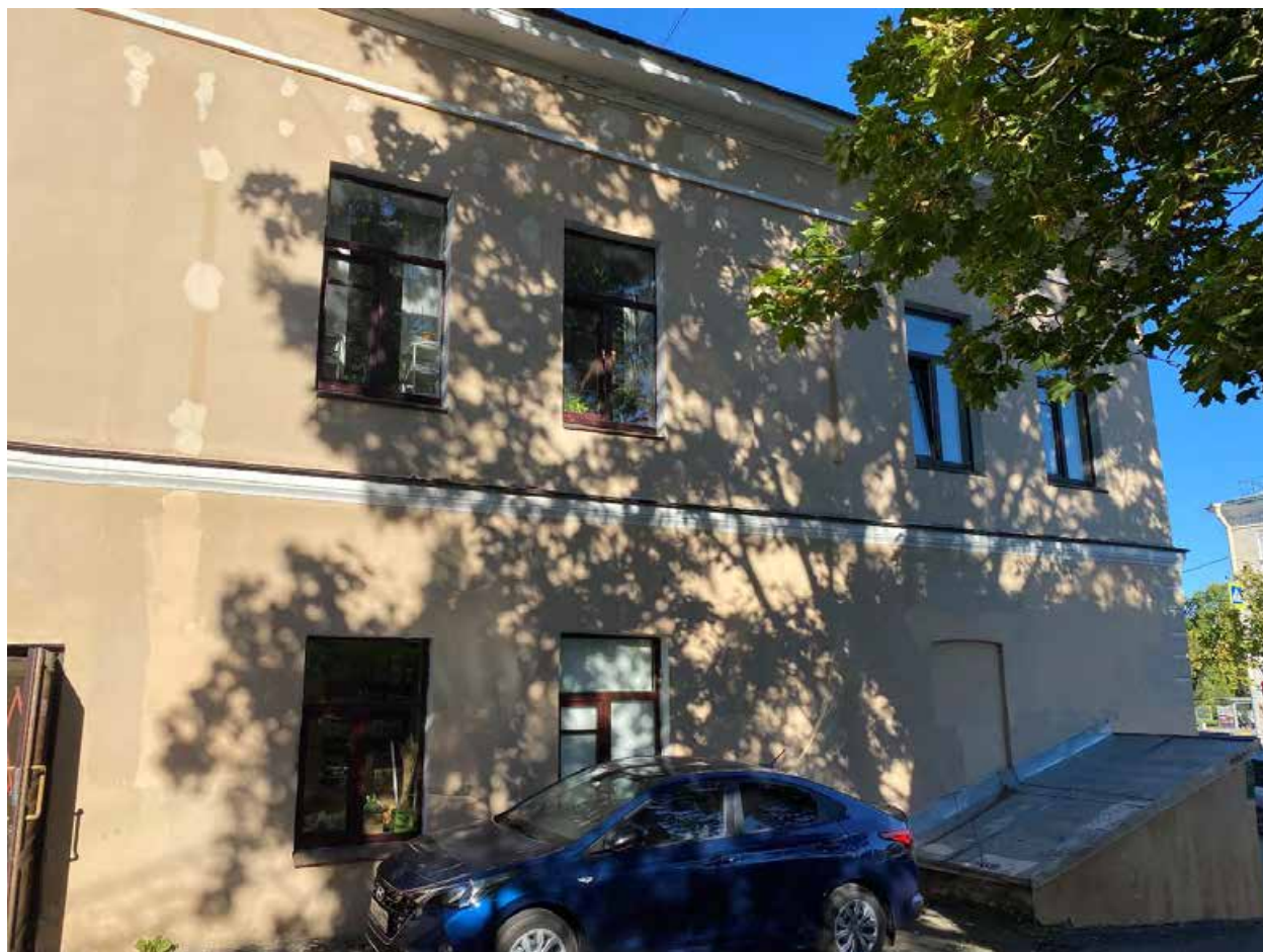
Фото 20. Юго-восточный дворовый фасад.
