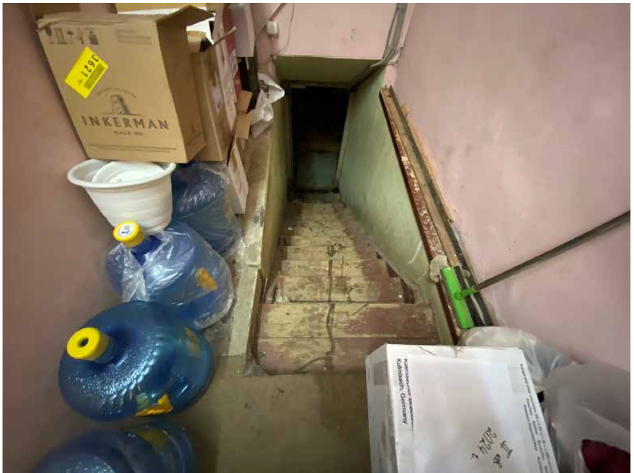
Фото 89. 1этаж. Помещение 1-Н(10)
