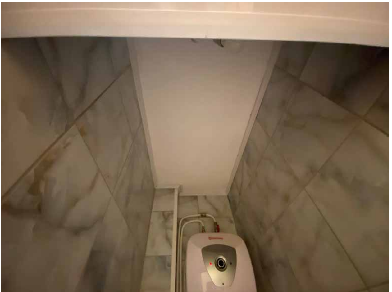
Фото 123. 2 этаж. Помещение 1-Н(29)
