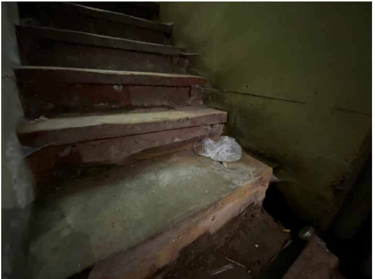
Фото 178. Подвал. Лестница с помещение 1-Н(34)
