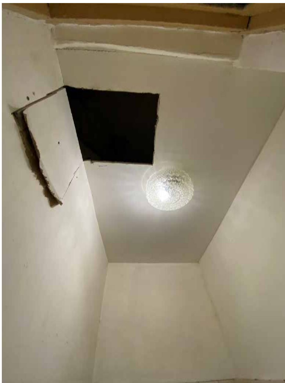
Фото 82. 1этаж. Помещение 1-Н(12)
