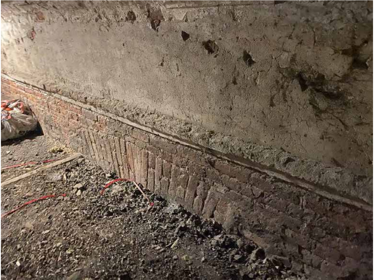
Фото 203. Чердак в объеме пристроенной лестницы. Фрагмент исторического лицевого фасада.
