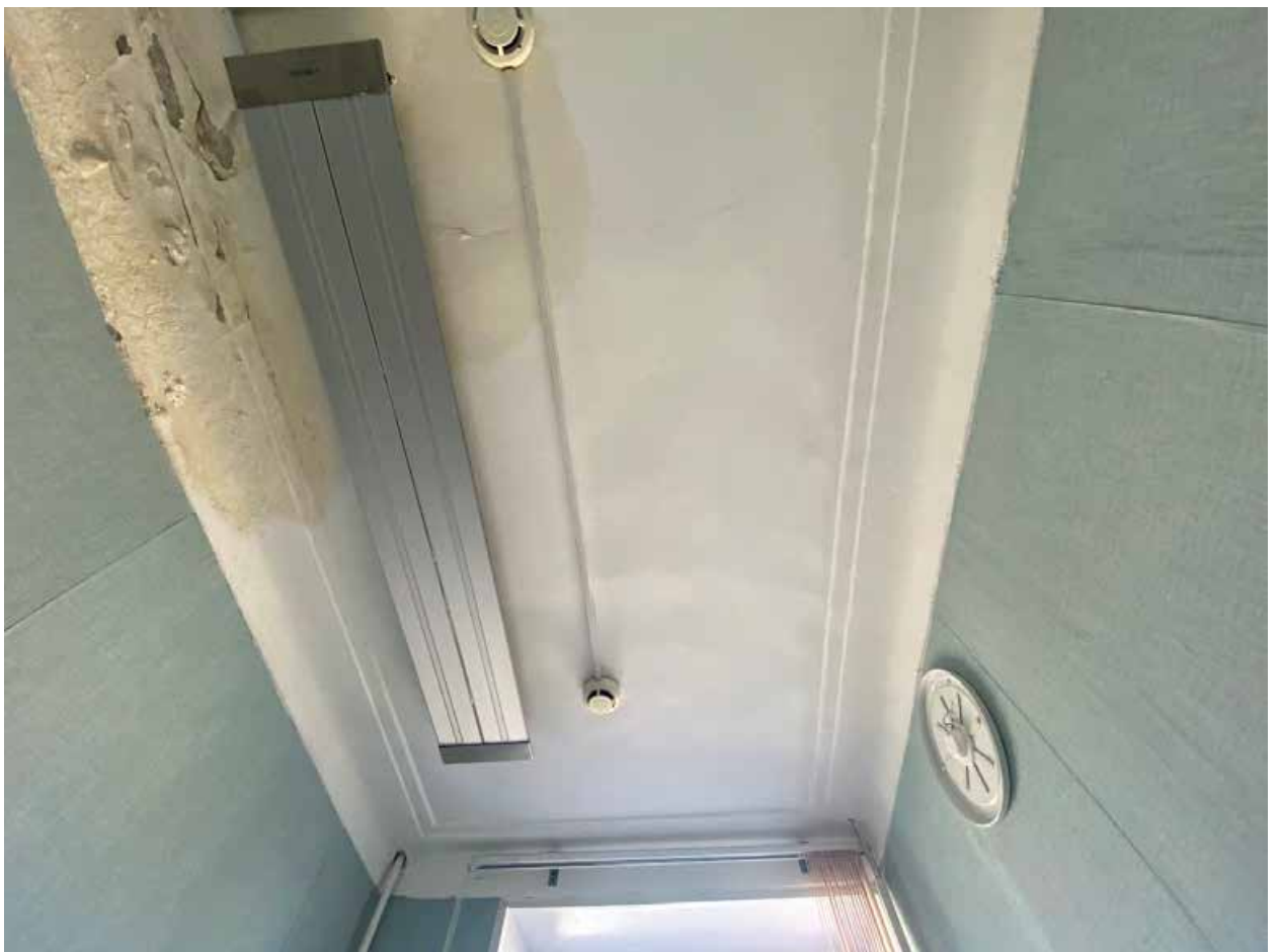
Фото 121. 2 этаж. Помещение 1-Н(17)
