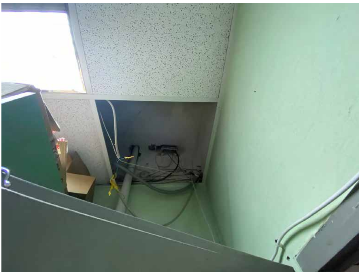
Фото 66. 1этаж. Помещение 1-Н(4)
