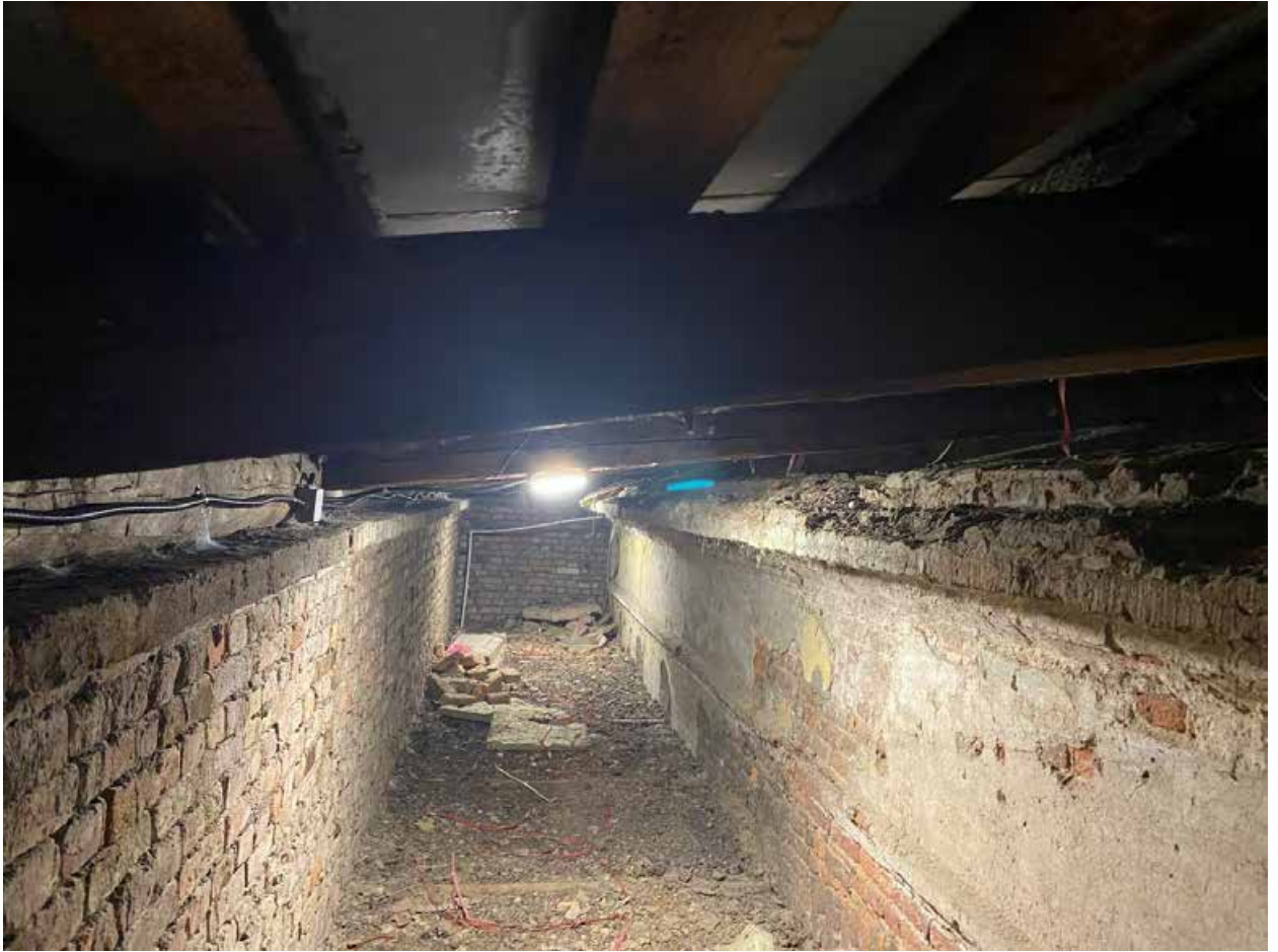
Фото 204. Чердак в объеме пристроенной лестницы. Фрагмент исторического лицевого фасада.
