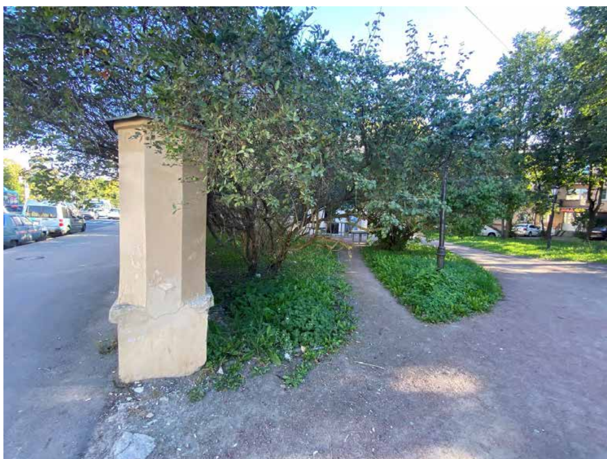
Фото 11. Часть садового ограждения со стороны Оранжерейной улицы
