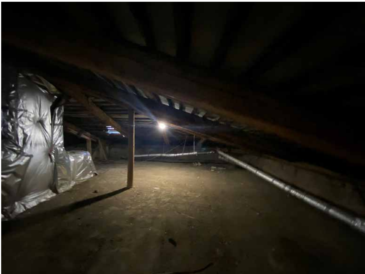
Фото 221. Чердак. Угловой фрагмент.
