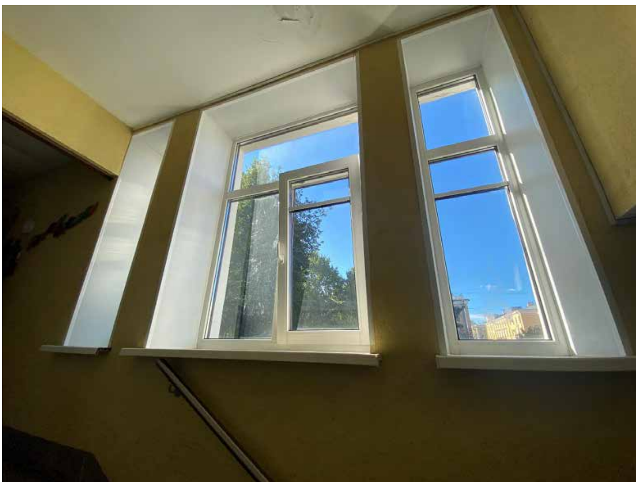
Фото 105. Лестница 2 этаж, окна юго-западной части фасада
