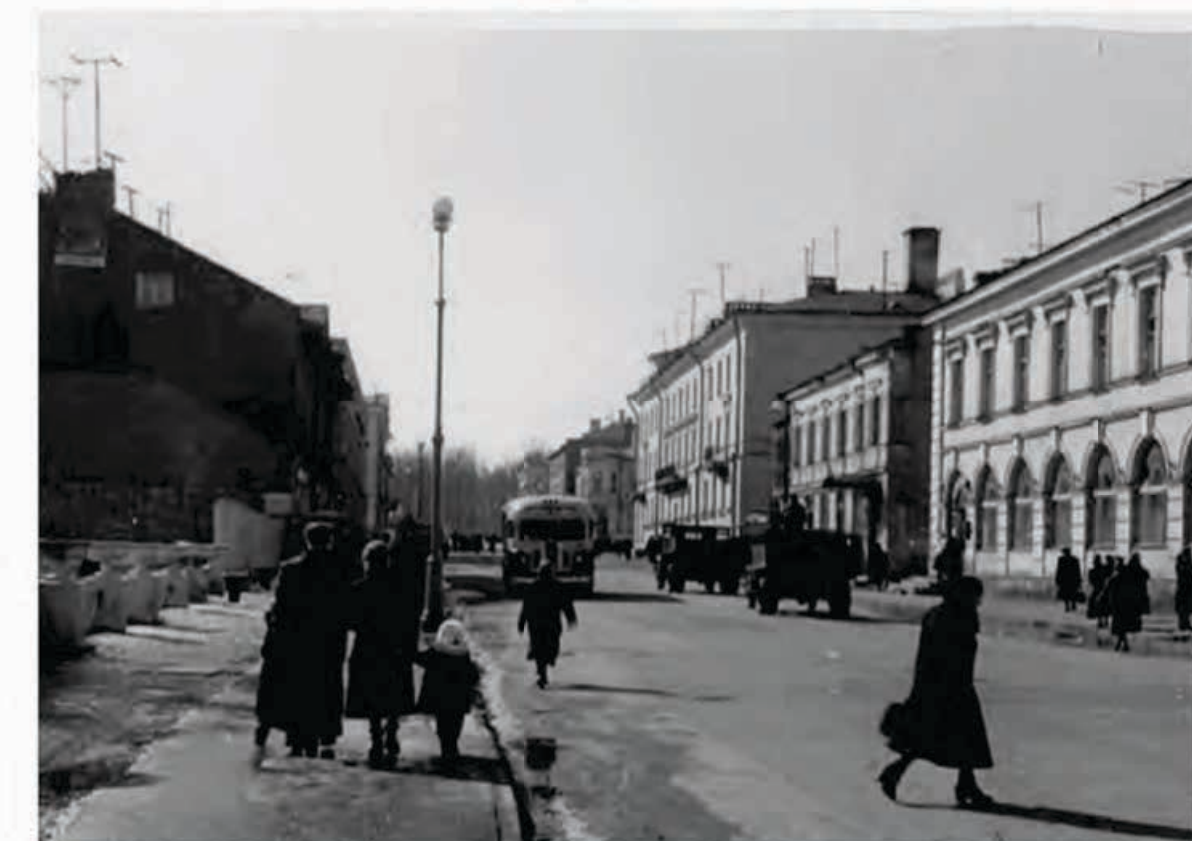
Ограждение участка по Оранжерейной ул. 1955 - 1958 гг.
