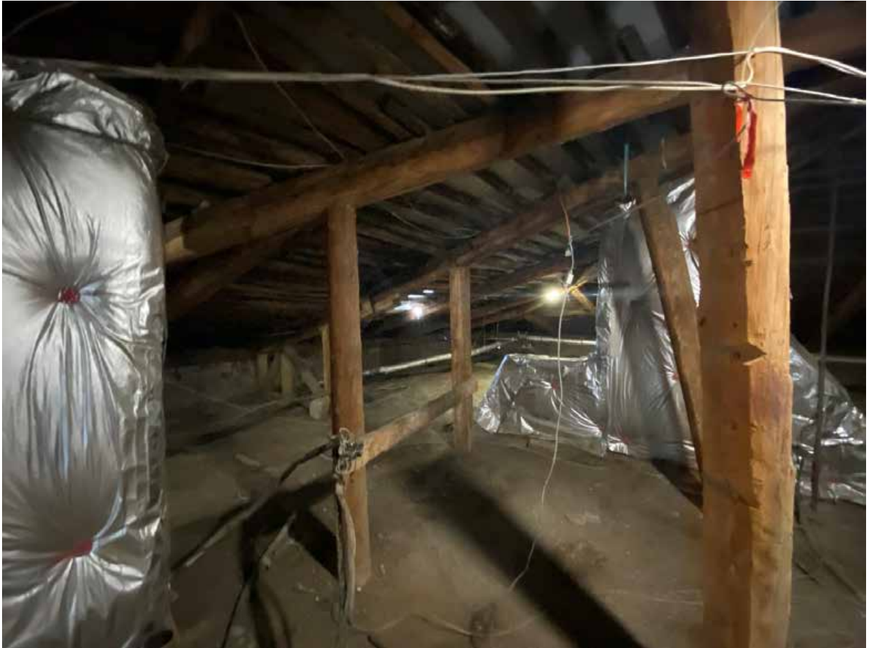
Фото 215. Чердак. Наклонная стропильная конструкция.
