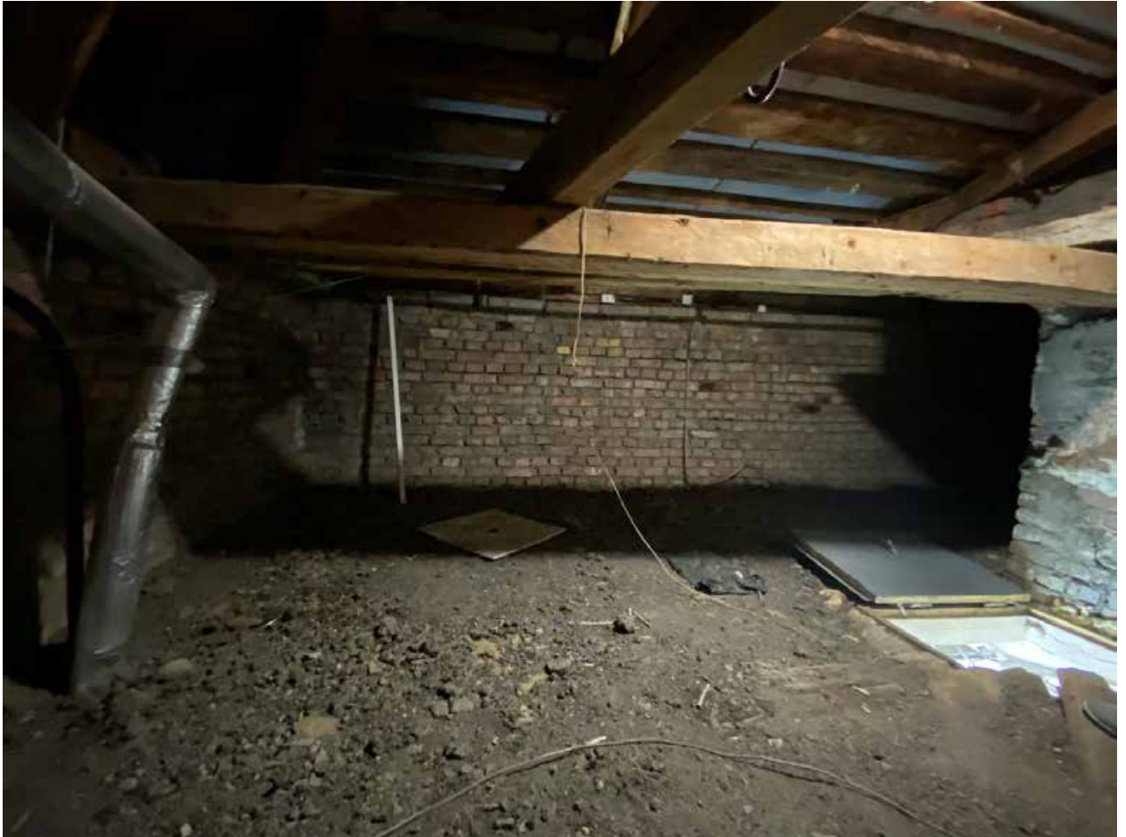
Фото 198. Чердак. Крепление дощатого перекрытия. Опорный узел.
