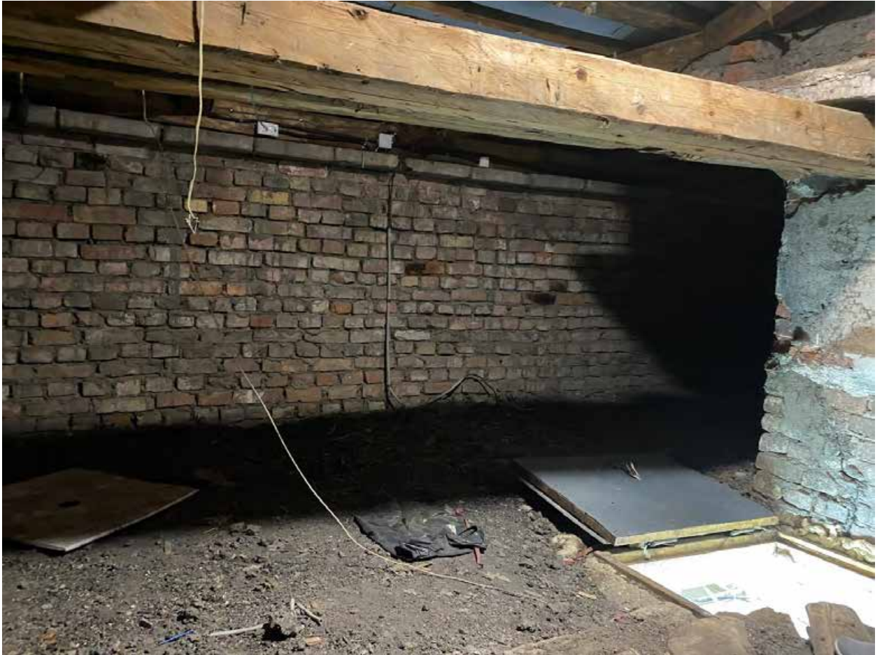
Фото 200. Чердак. Сдвоенный дощатый мауэрлат.
