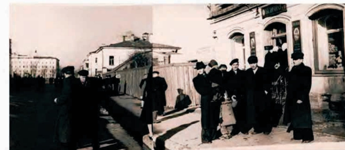
Ограждение участка по Оранжерейной ул. 1946 - 1953 гг.
