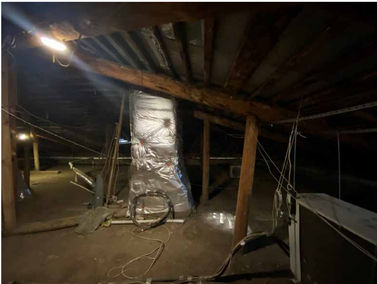
Фото 212. Чердак. Наклонная стропильная подпорка.
