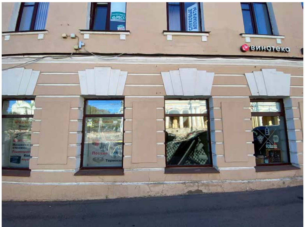
Фото 29. Северо-западный фасад со стороны улицы Оранжерейная
