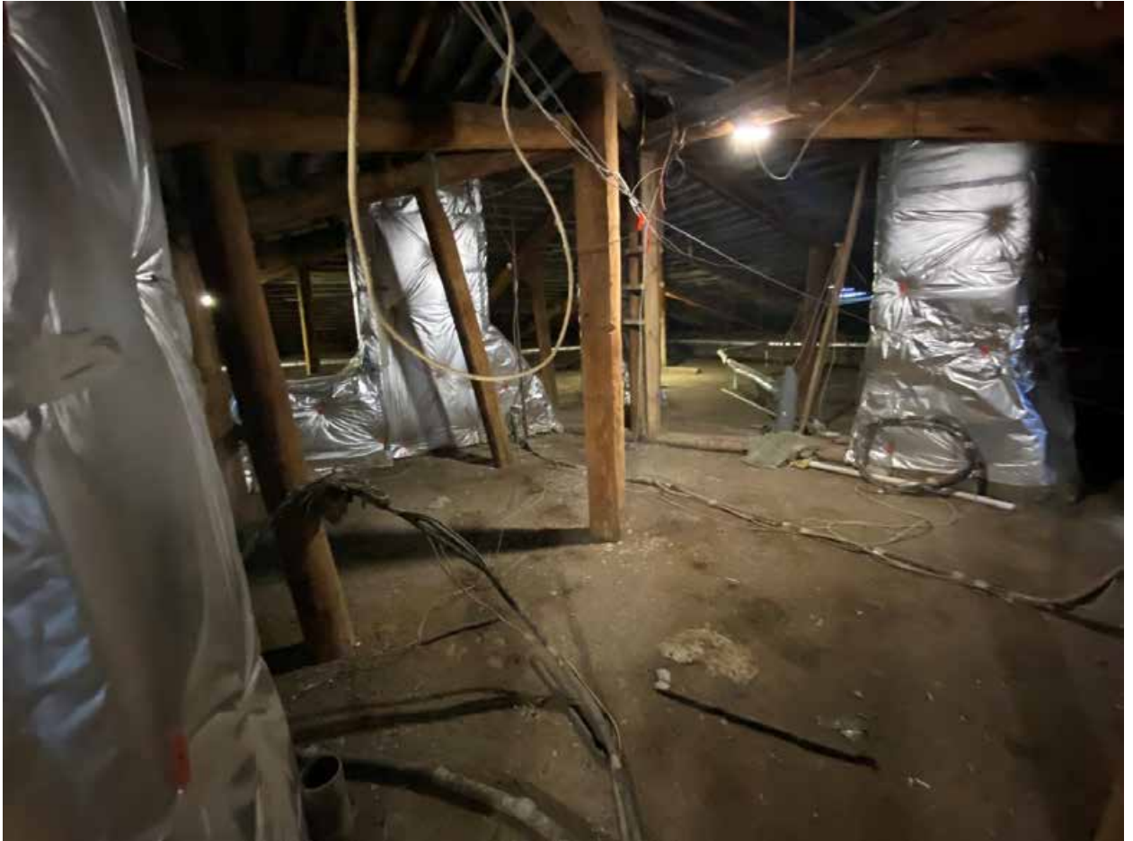
Фото 211. Чердак. Горизонтальная стропильная подпорка.
