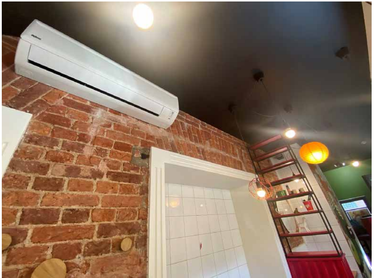
Фото 45. 1этаж. Помещение 1-Н(15).
