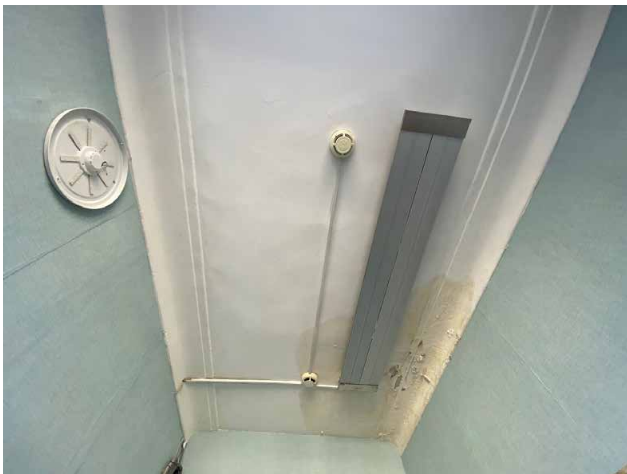
Фото 119. 2 этаж. Помещение 1-Н(17)
