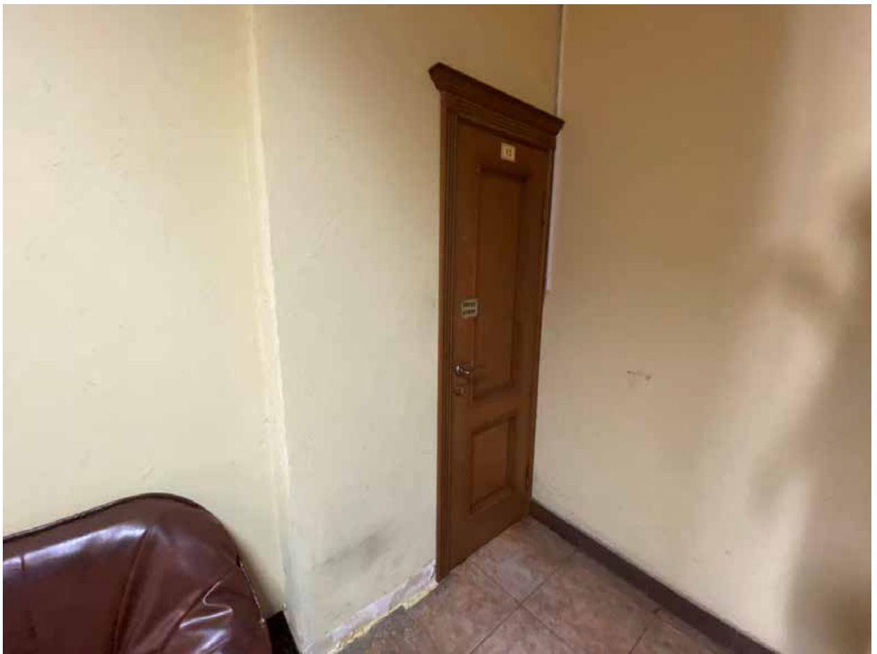
Фото 129. 2 этаж. Помещение 1-Н(16)
