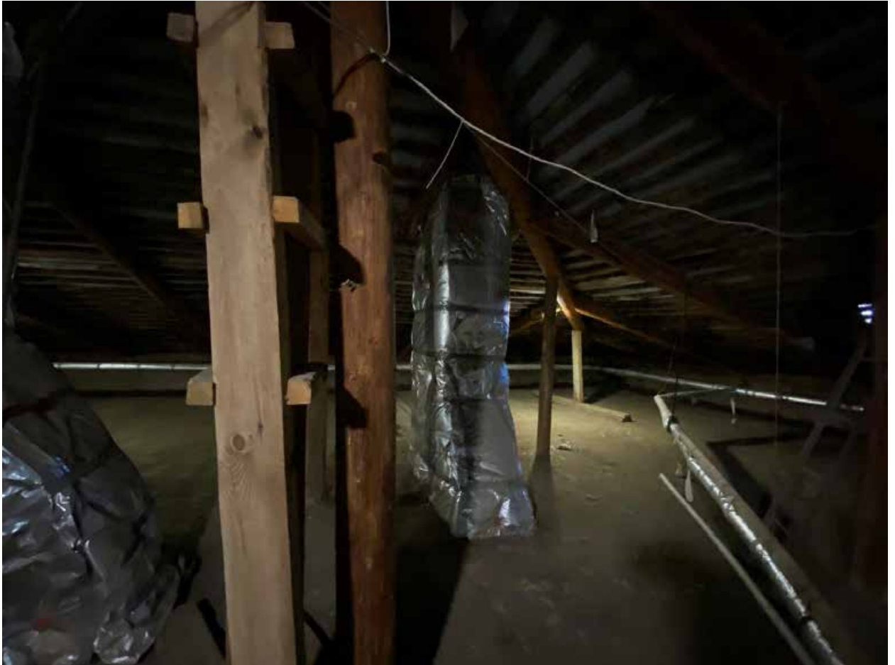
Фото 216. Чердак. Вертикальные подпорные стойки.
