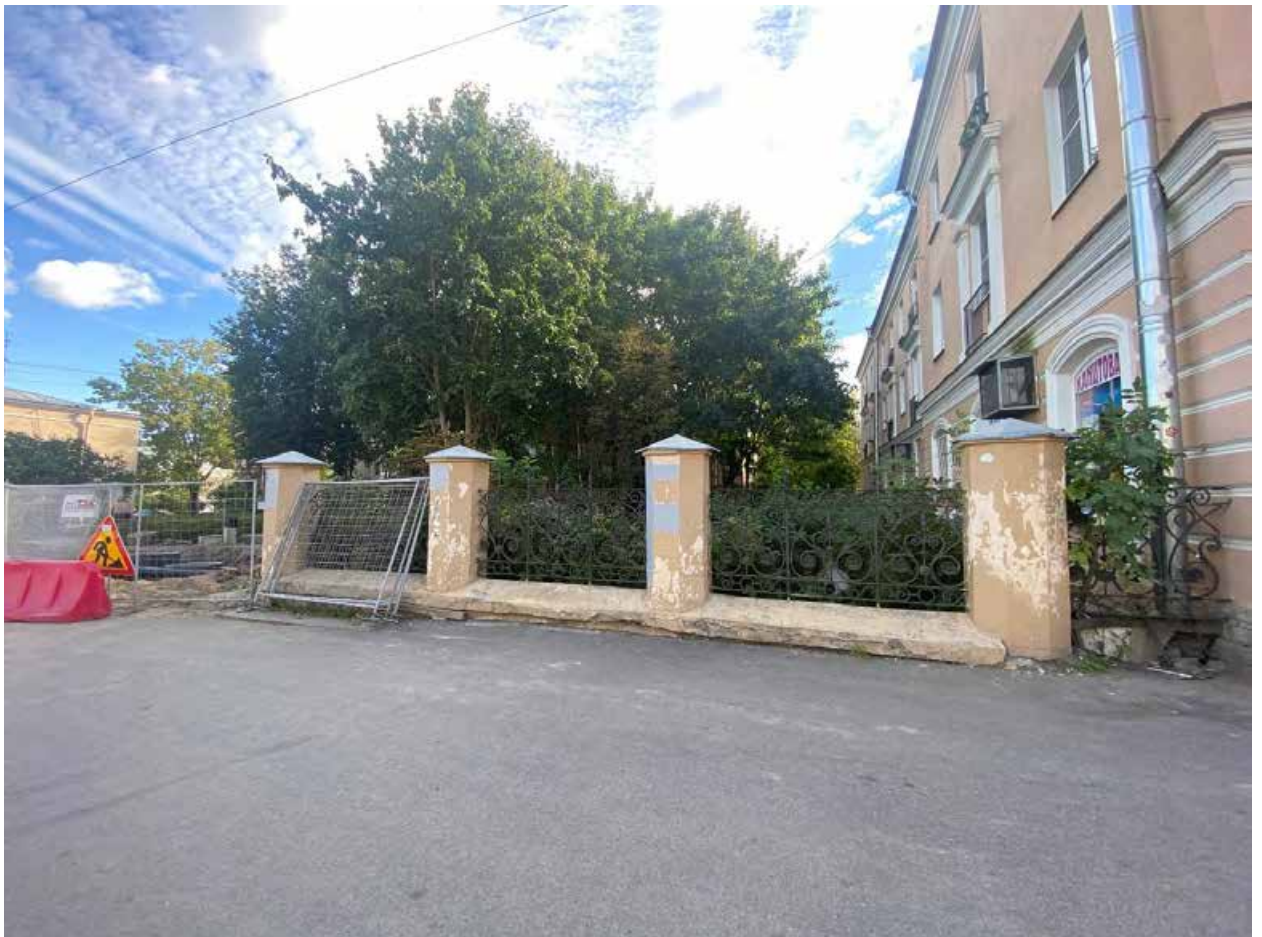
Фото 34. Часть садового ограждения со стороны Оранжерейной улицы
