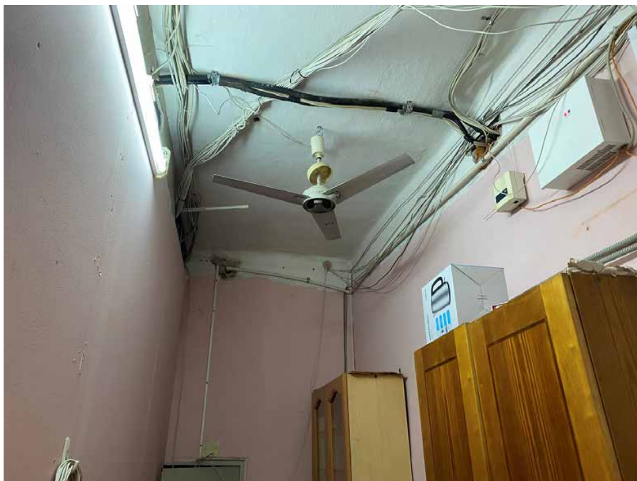
Фото 87. 1этаж. Помещение 1-Н(10)
