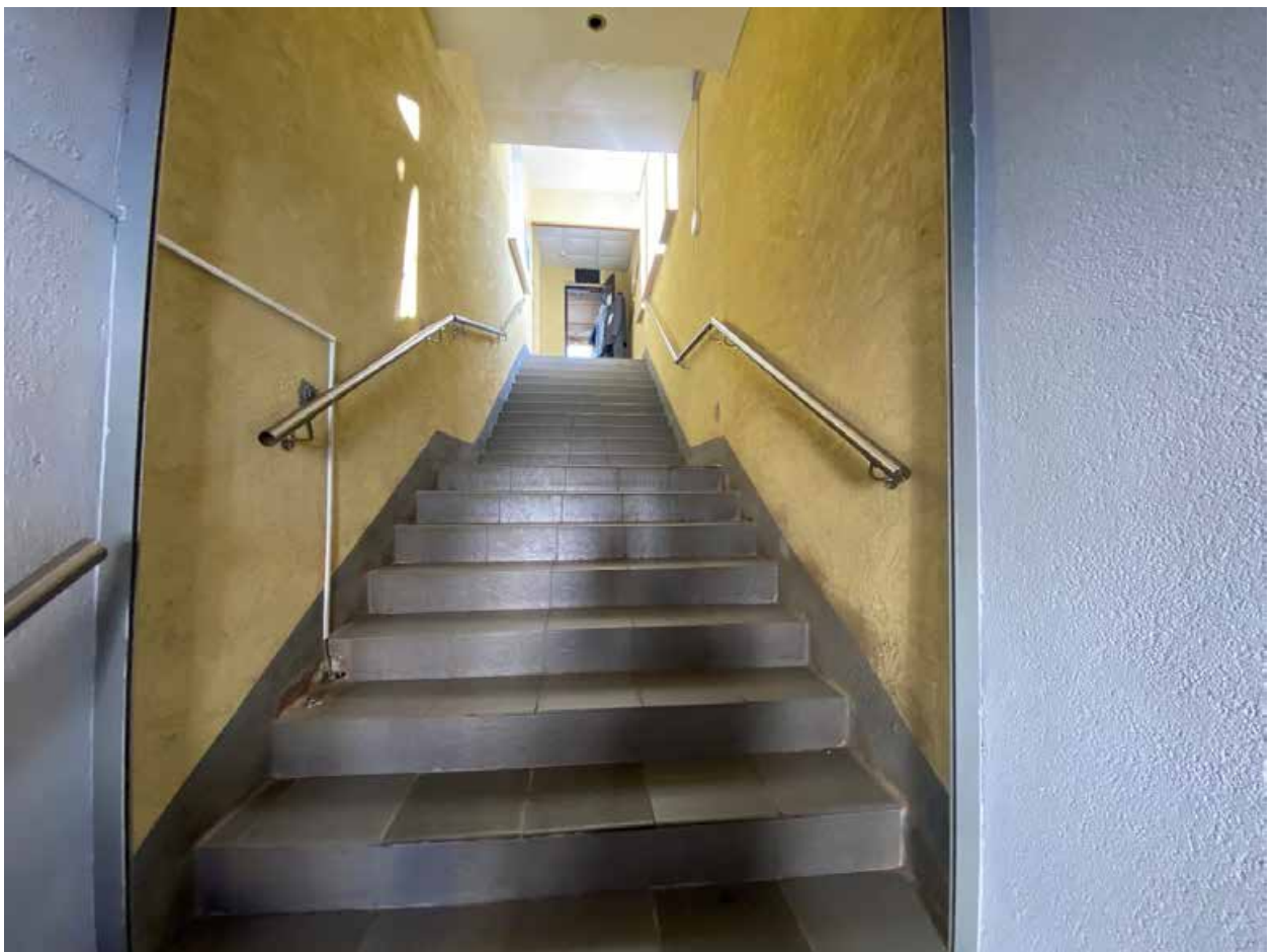
Фото 103. Помещение 1-Н(1). Лестница на 2 этаж
