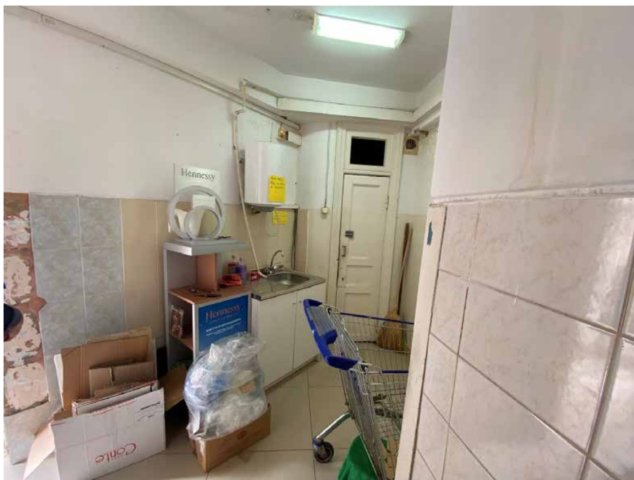
Фото 77. 1этаж. Помещение 1-Н(11)
