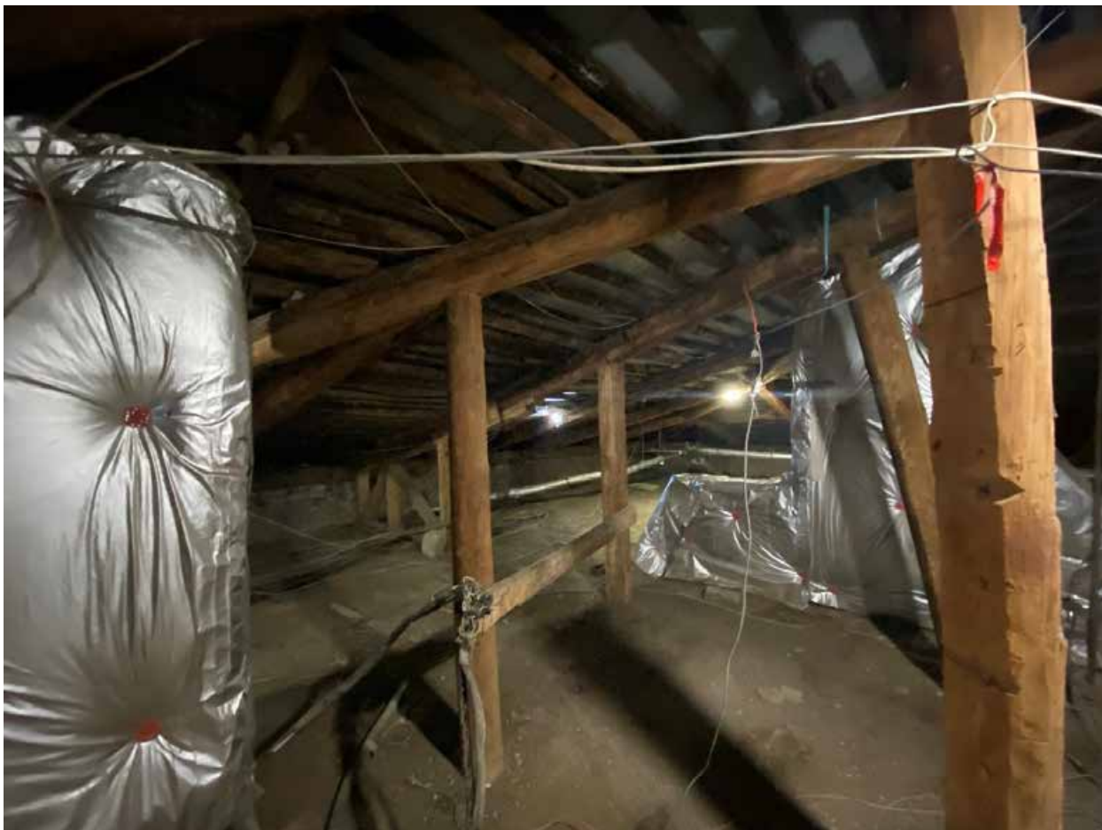
Фото 214. Чердак. Наклонная стропильная конструкция.
