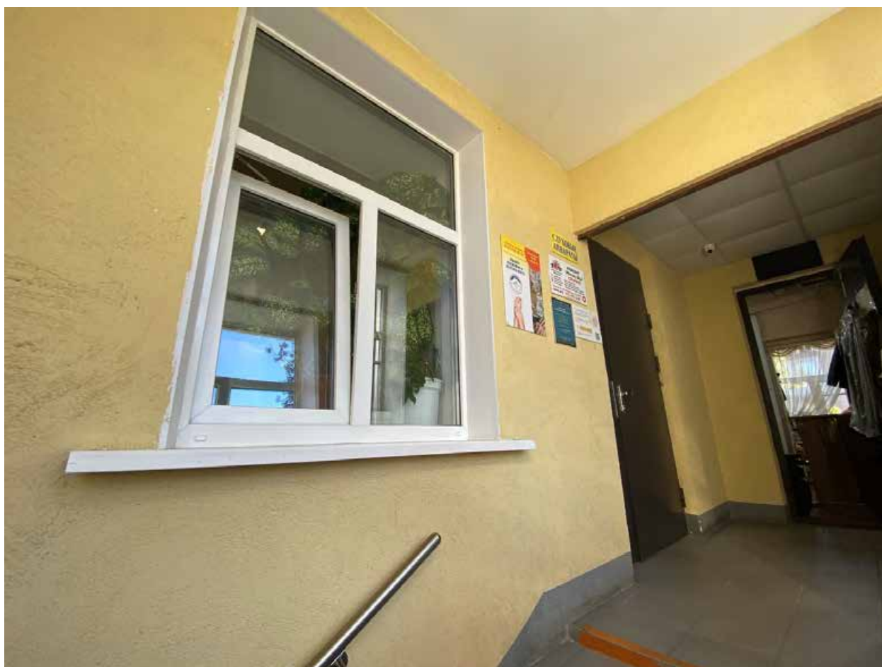
Фото 106. Лестница 2 этаж, окно в помещение 1-Н(16)
