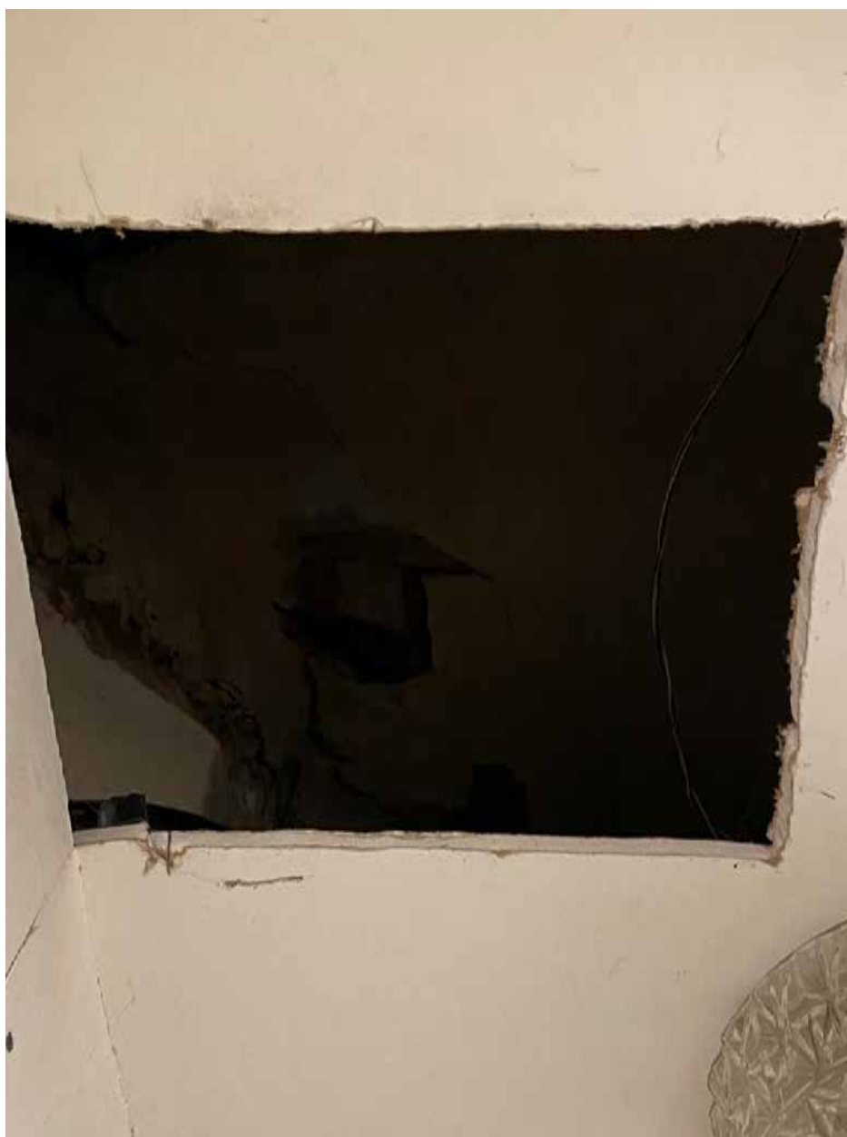
Фото 83. 1этаж. Помещение 1-Н(12)
