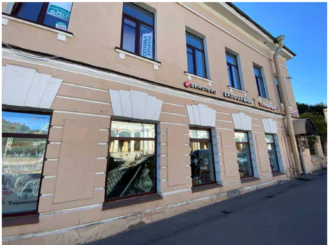
Фото 28. Северо-западный фасад со стороны улицы Оранжерейная.
