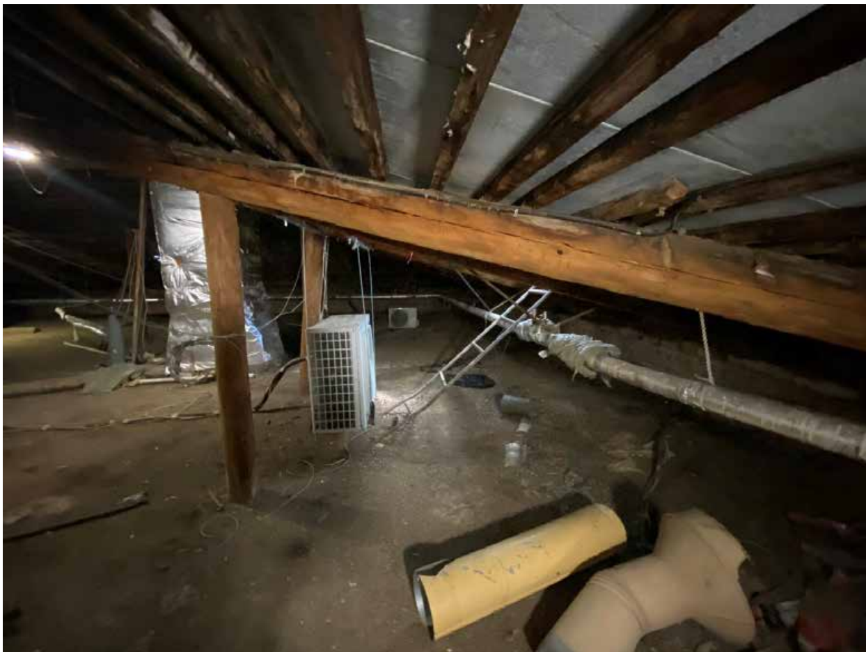
Фото 210. Чердак. Наклонная стропильная подпорка.
