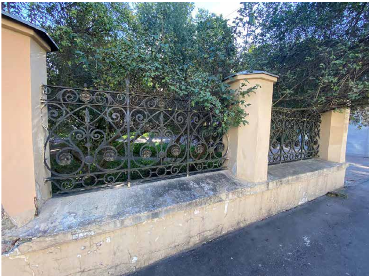
Фото 9. Часть садового ограждения со стороны Оранжерейной улицы
