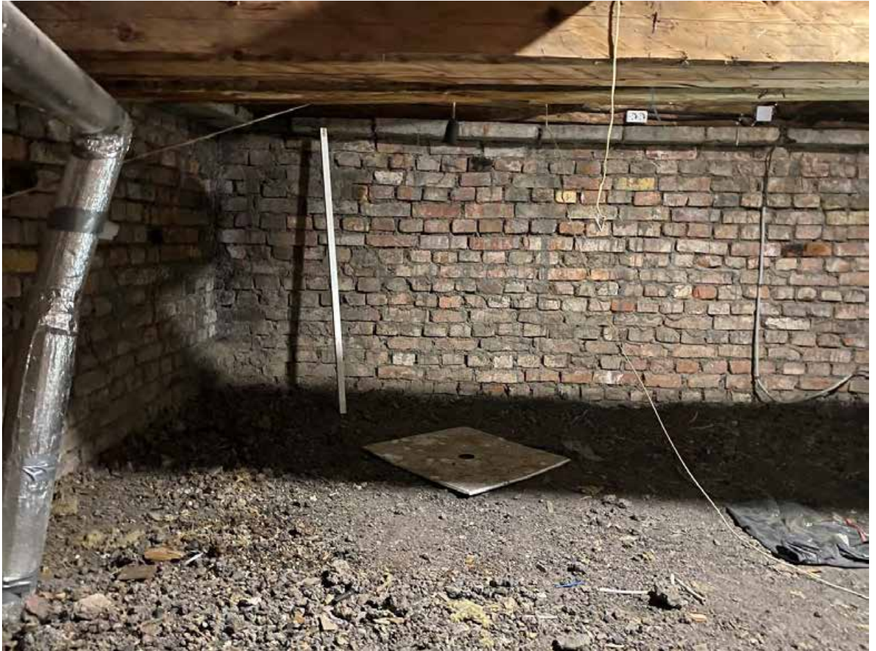
Фото 199. Чердак. Дощатый мауэрлат. Вертикальный фрагмент водопроводной трубы.
