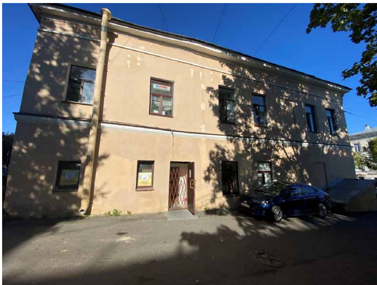
Фото 18. Юго-восточный дворовый фасад.
