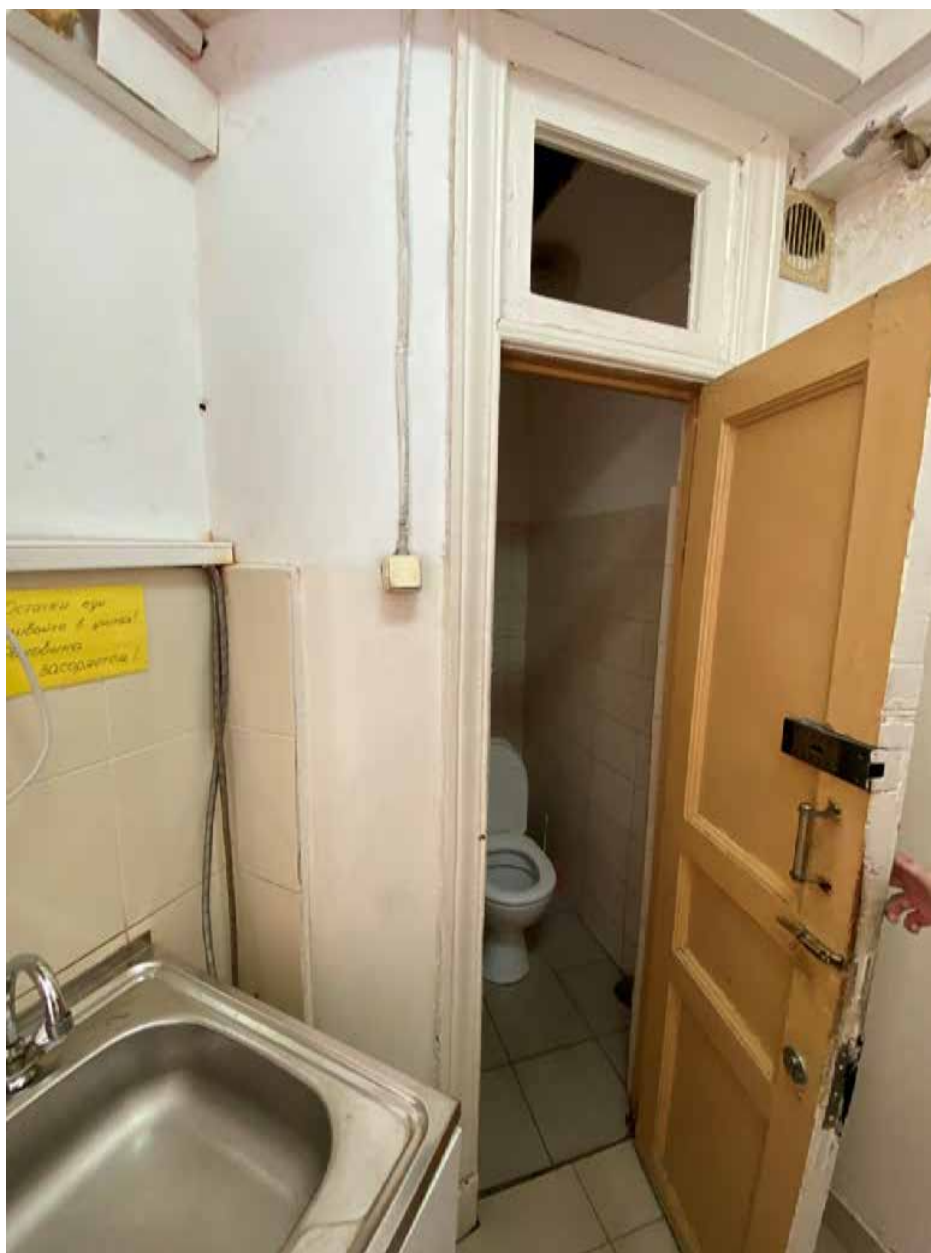
Фото 80. 1этаж. Помещение 1-Н(11) 1-Н(12)
