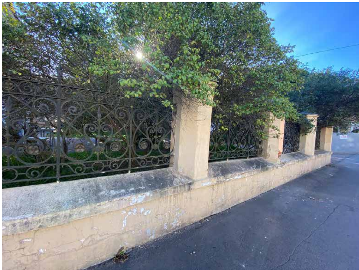
Фото 7. Часть садового ограждения со стороны Оранжерейной улицы
