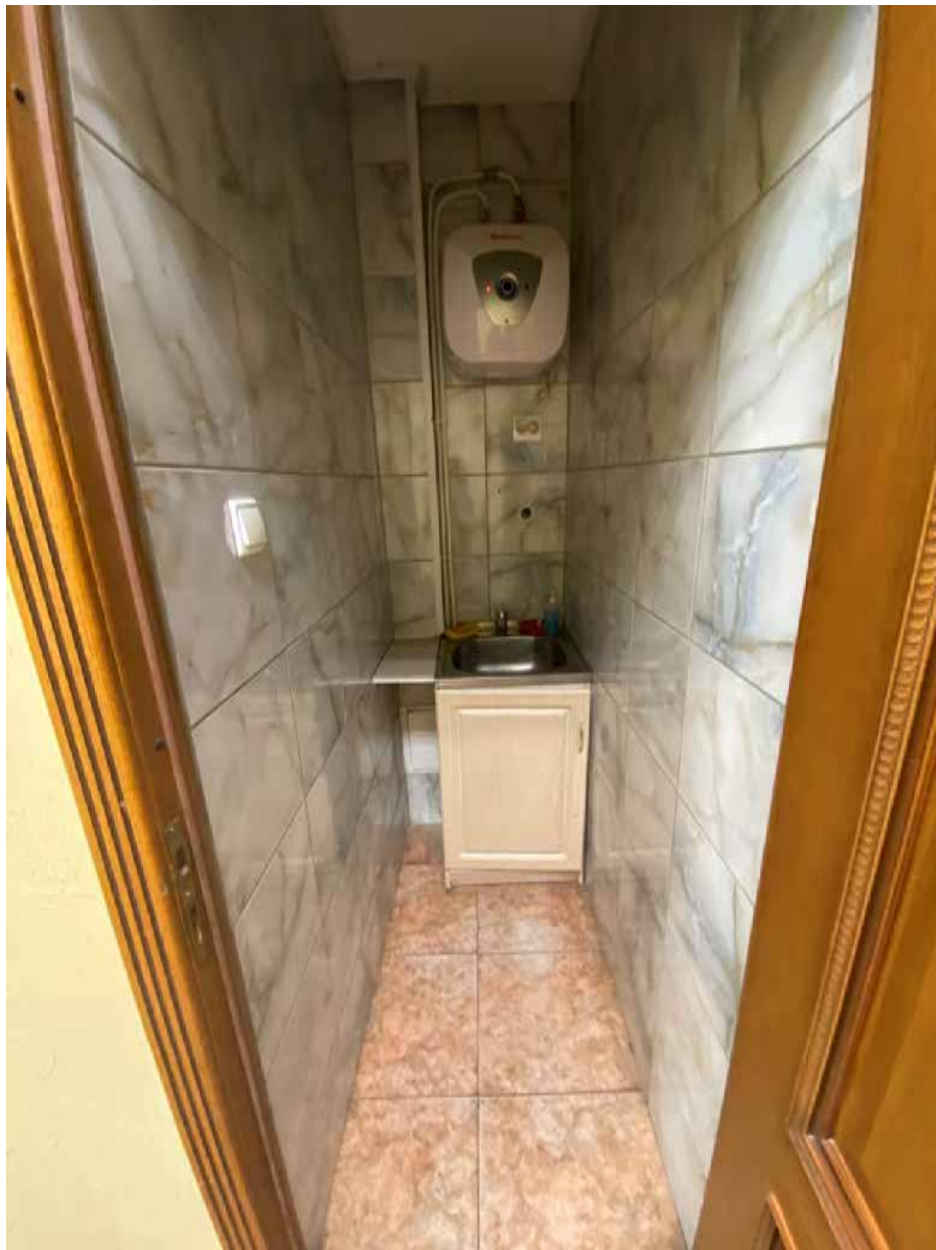
Фото 124. 2 этаж. Помещение 1-Н(29)
