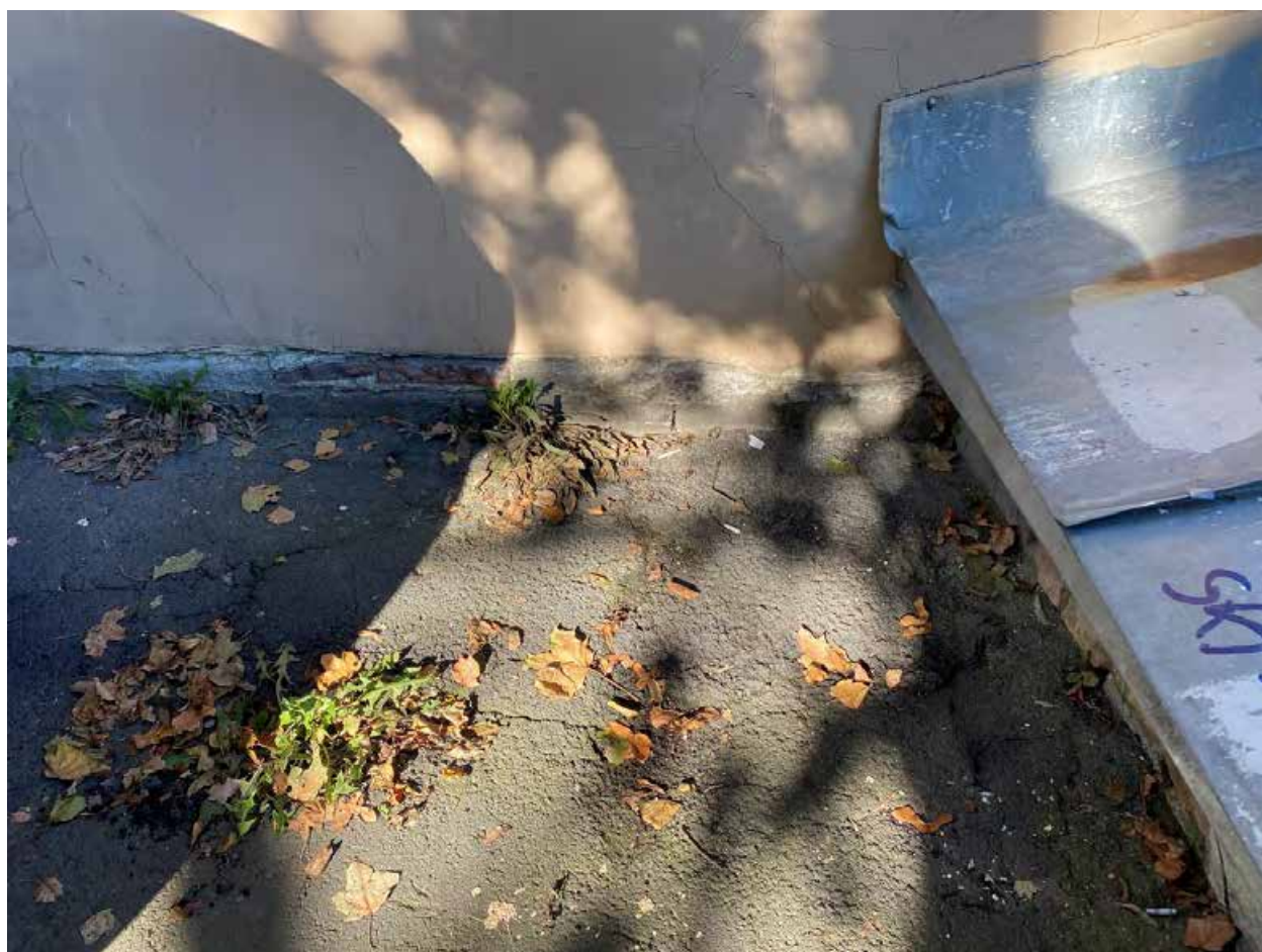
Фото 23. Примыкание к стене кровли наружного входа в подвал.
