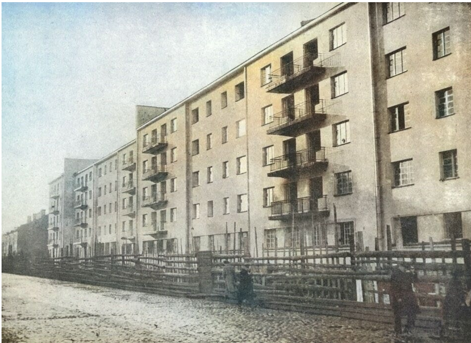
28. Здание жилого дома Бабуриного жилмассива. Смолячкова 14к1, Ленинград на стройке: К отчету Ленинградского совета XII созыва. 1931 г. // Источник: https://www.citywalls.ru/photo643148.html .
