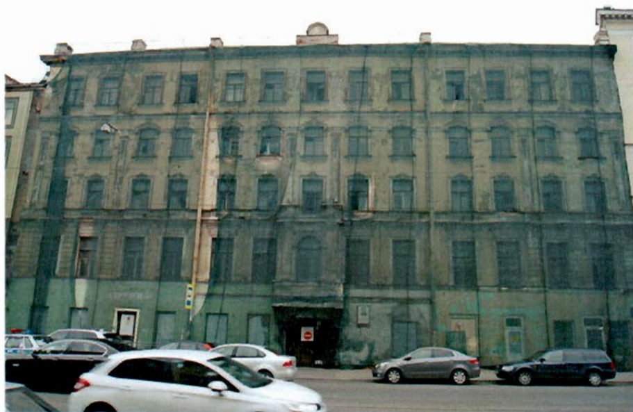
1. (Лицевой фасад по Садовой ул.)
