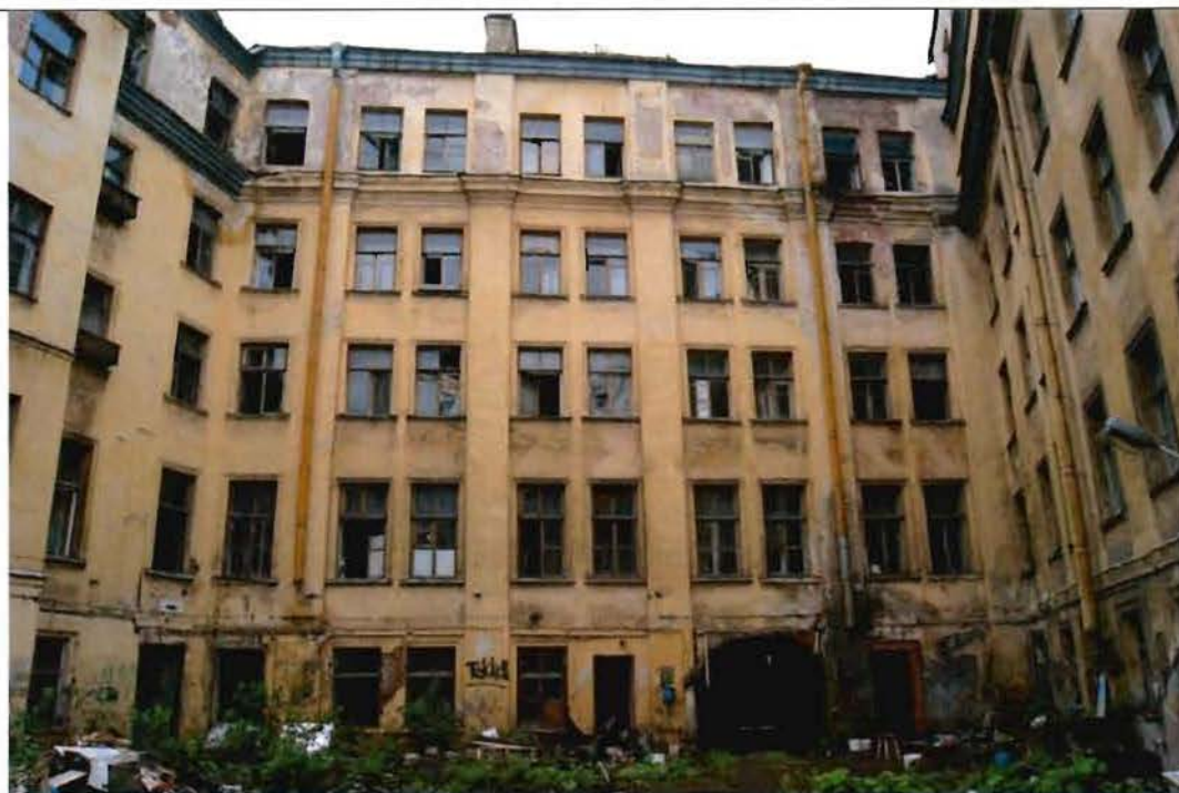
4. Фрагмент дворового фасада
