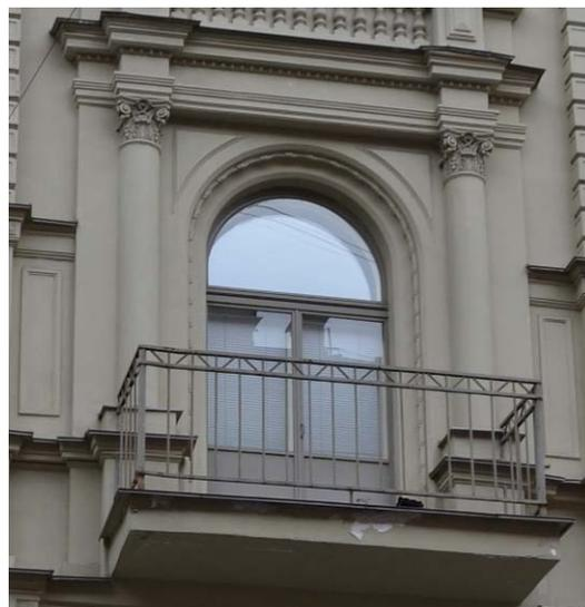
оформление оконных проемов в уровне 4-го этажа боковых ризалитов – фланкирован широкими лопатками, декорированными листьями аканта в основании и имитированными уплощенными профилями колонн, в завершении лопаток – стилизованные капители, украшенные профилированными филенками, между которыми (над оконным проемом) горизонтальная вставка с ромбовидным орнаментом);
