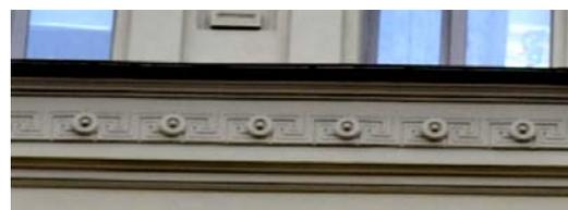
профилированные карнизы, в том числе раскрепованные, венчающий карниз ризалитов и венчающий карниз основной части фасада;
