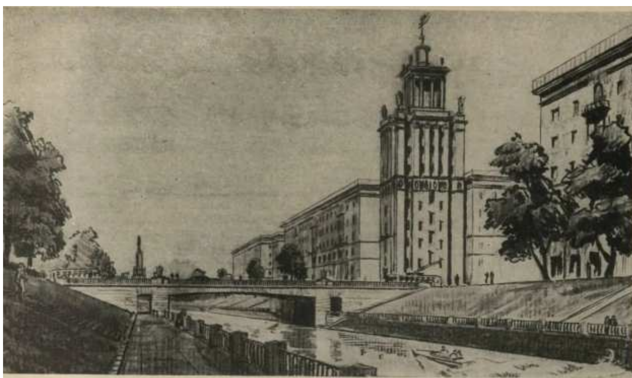
21. Пересечение проспекта и нового Обводного канала. (Архитектура и строительство Ленинграда. Сб. № 17. 1952)
