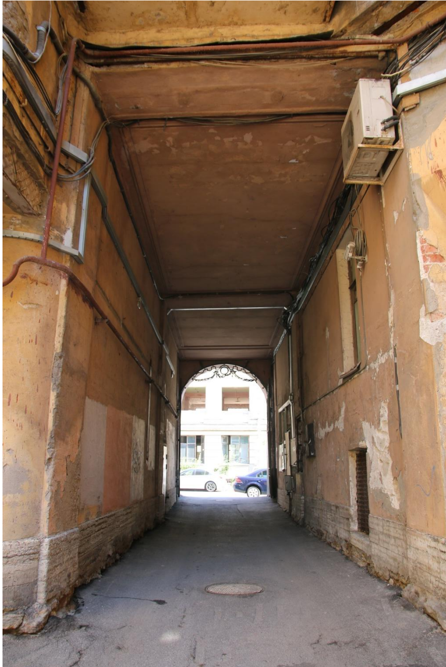
18. Своды проездной арки со стороны внутреннего двора. Вид с юго-запада
