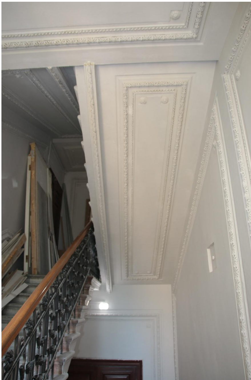
55. Интерьер парадного входа. Оформление нижних поверхностей парадной лестницы
