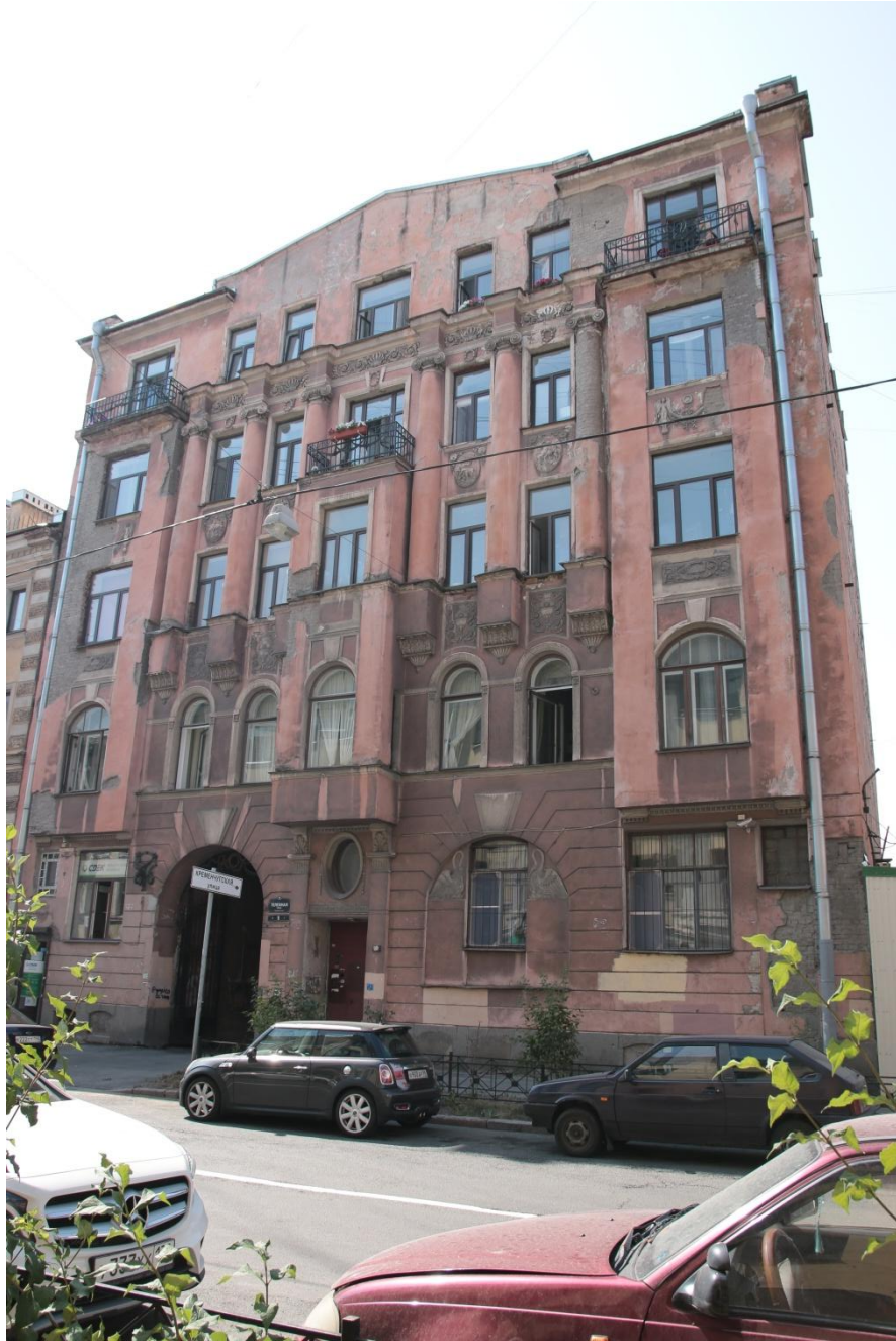
2. Общий вид главного фасада. Вид с севера
