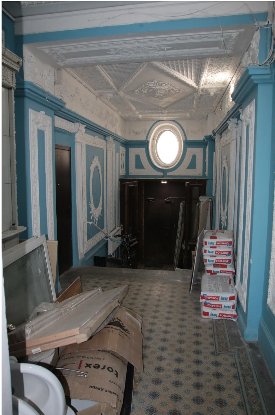
42. Интерьер вестибюля парадного входа. Оформление стен и потолка входа
