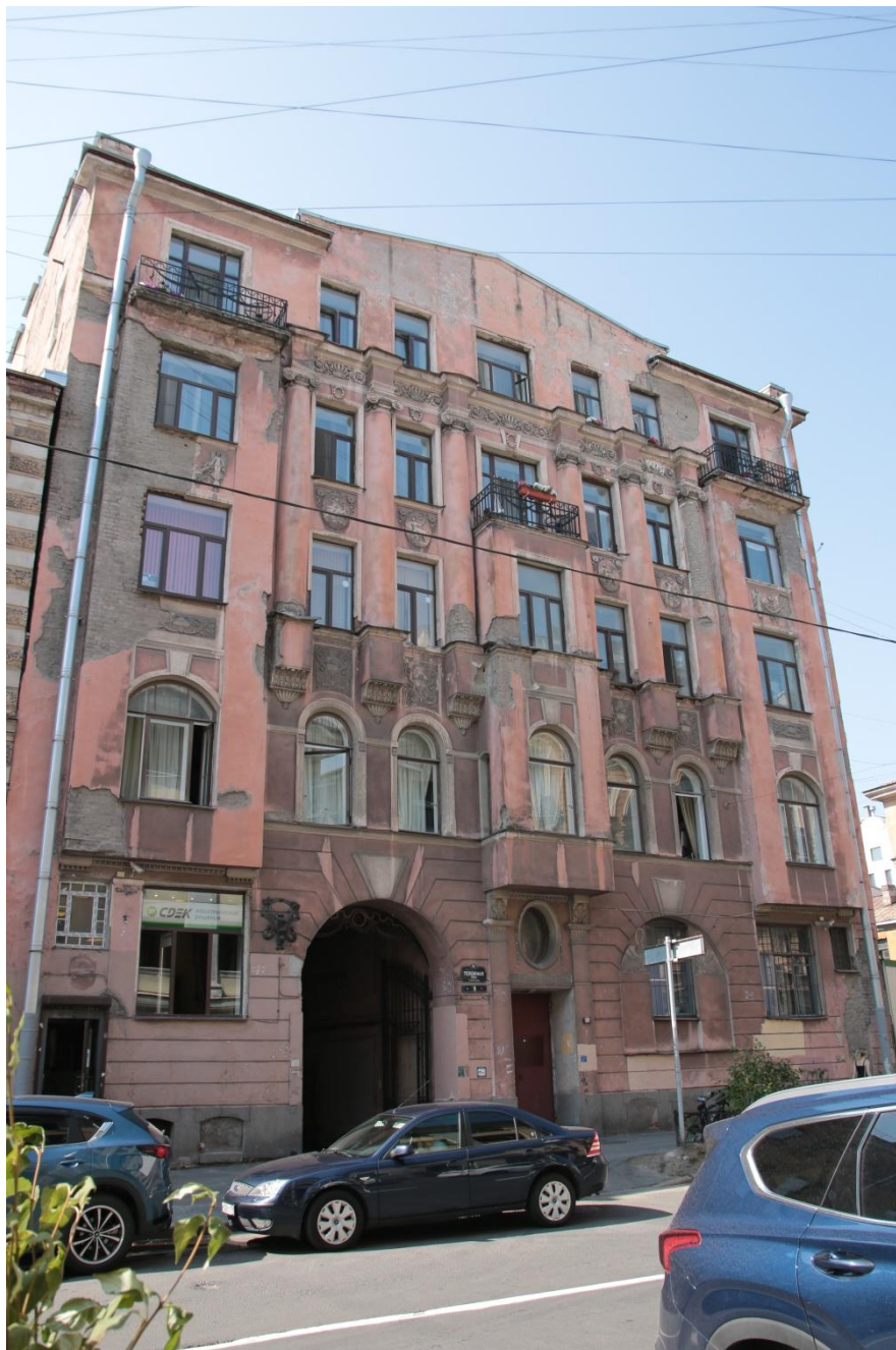
3. Общий вид главного фасада. Вид с северо-востока
