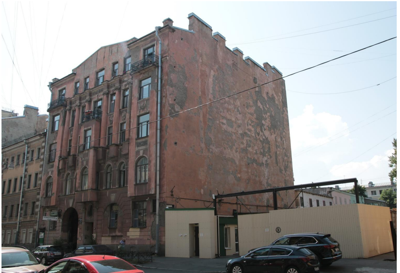
1. Общий вид здания. Вид с севера
