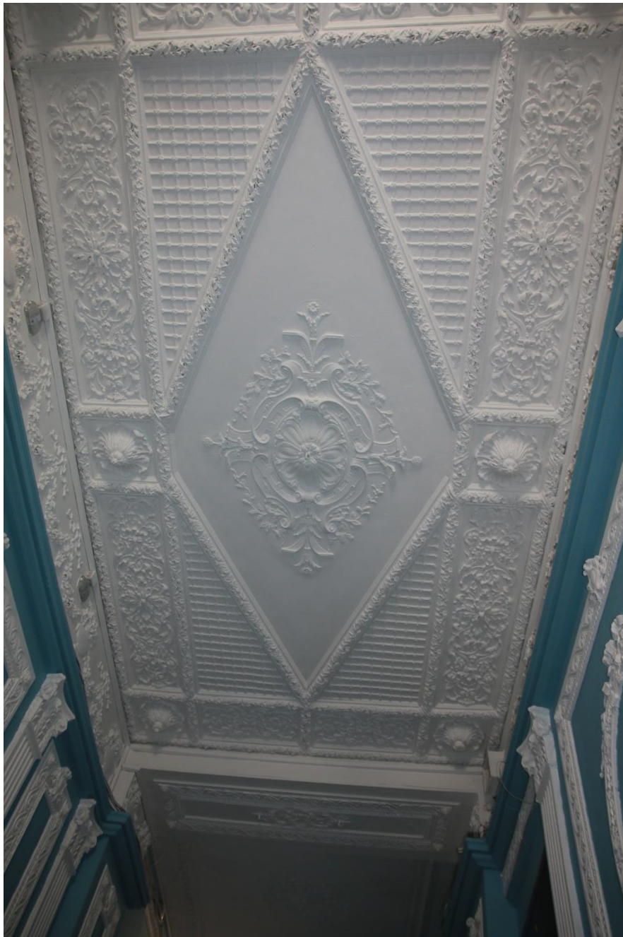
31. Интерьер вестибюля парадного входа. Оформление потолка
