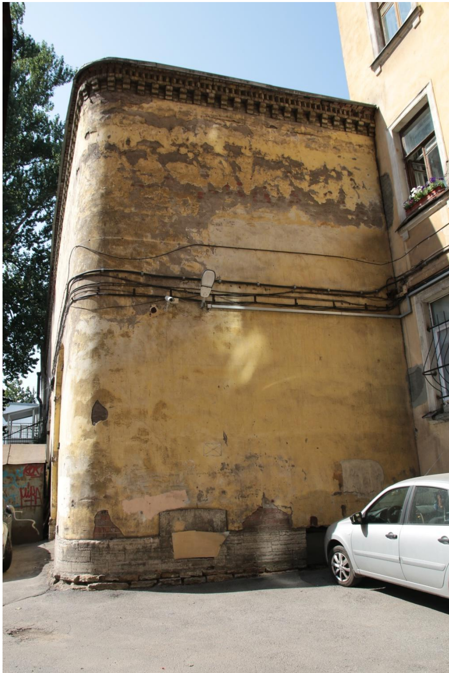
7. Фрагмент литеры Б дома № 9 по Тележной улице. Вид с северо-востока
