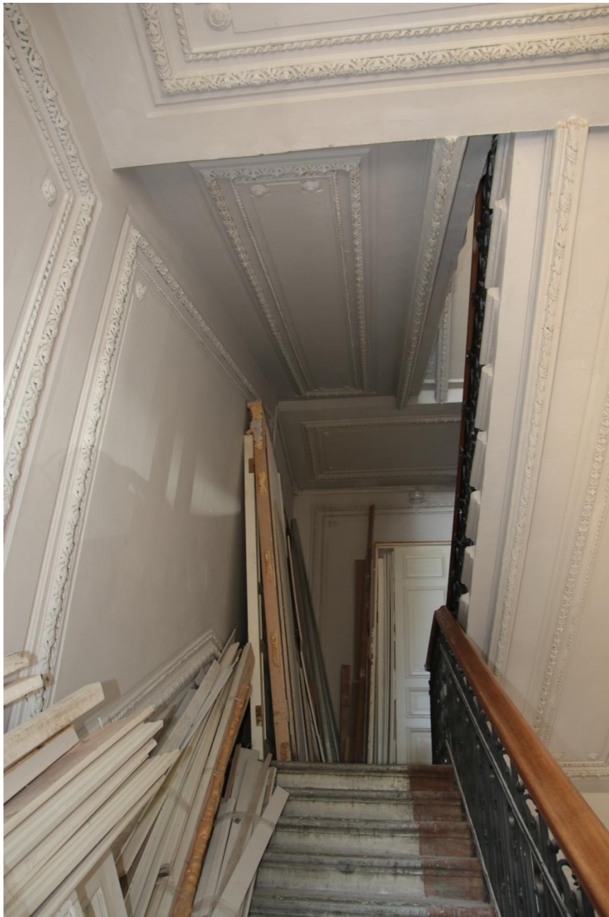
56. Интерьер парадного входа. Оформление нижних поверхностей парадной лестницы
