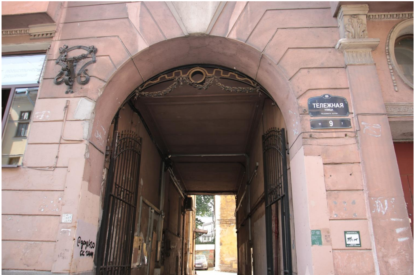
16. Фрагмент главного фасада. Оформление проездной арки. Вид с северо-востока
