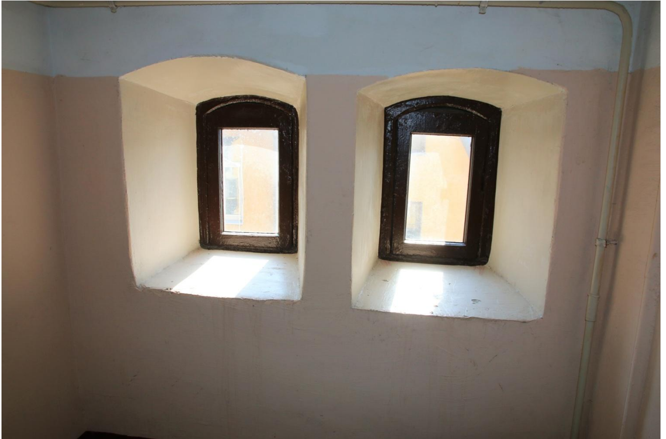
84. Интерьер дворовой парадной. Оконные проемы лестничной площадки шестого этажа
