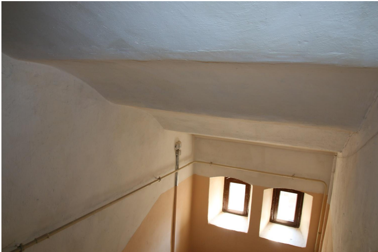
77. Интерьер дворовой парадной. Фрагмент оформления потолка. Оконные проемы лестничной площадки шестого этажа
