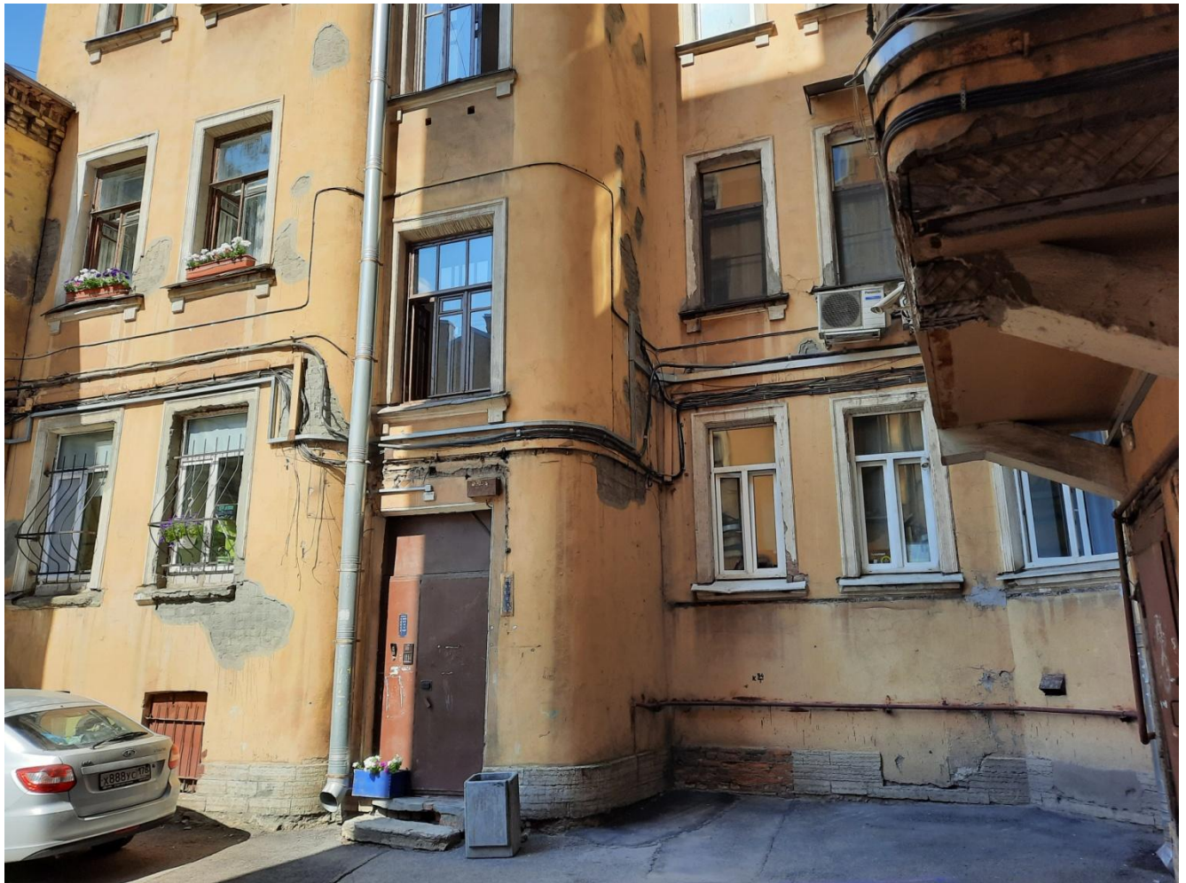
27. Фрагмент дворового фасада. Дверь входа дворовой парадной. Вид с востока
