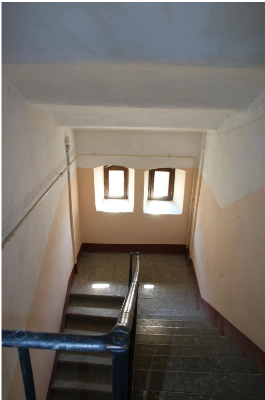
76. Интерьер дворовой парадной. Фрагмент оформления потолка. Оконные проемы лестничной площадки шестого этажа
