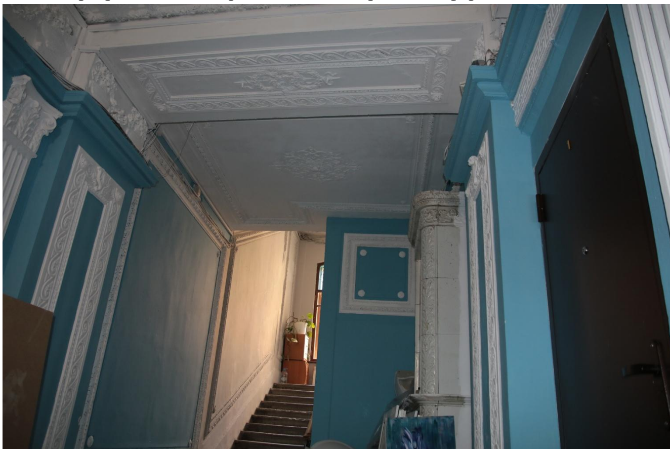
33. Интерьер вестибюля парадного входа. Фрагмент оформления стен и потолка
