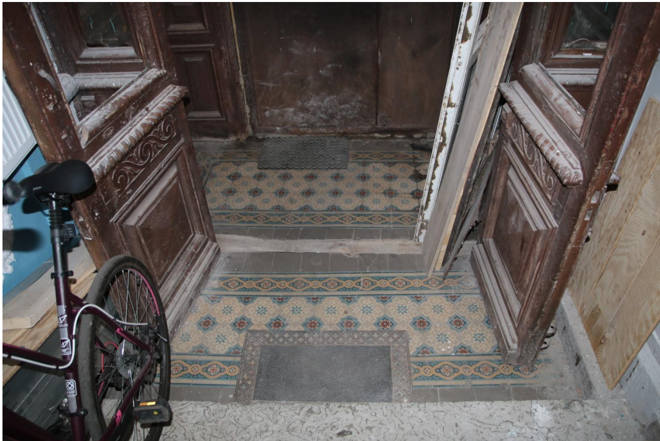
50. Интерьер вестибюля парадного входа. Оформление пола тамбура парадного входа
