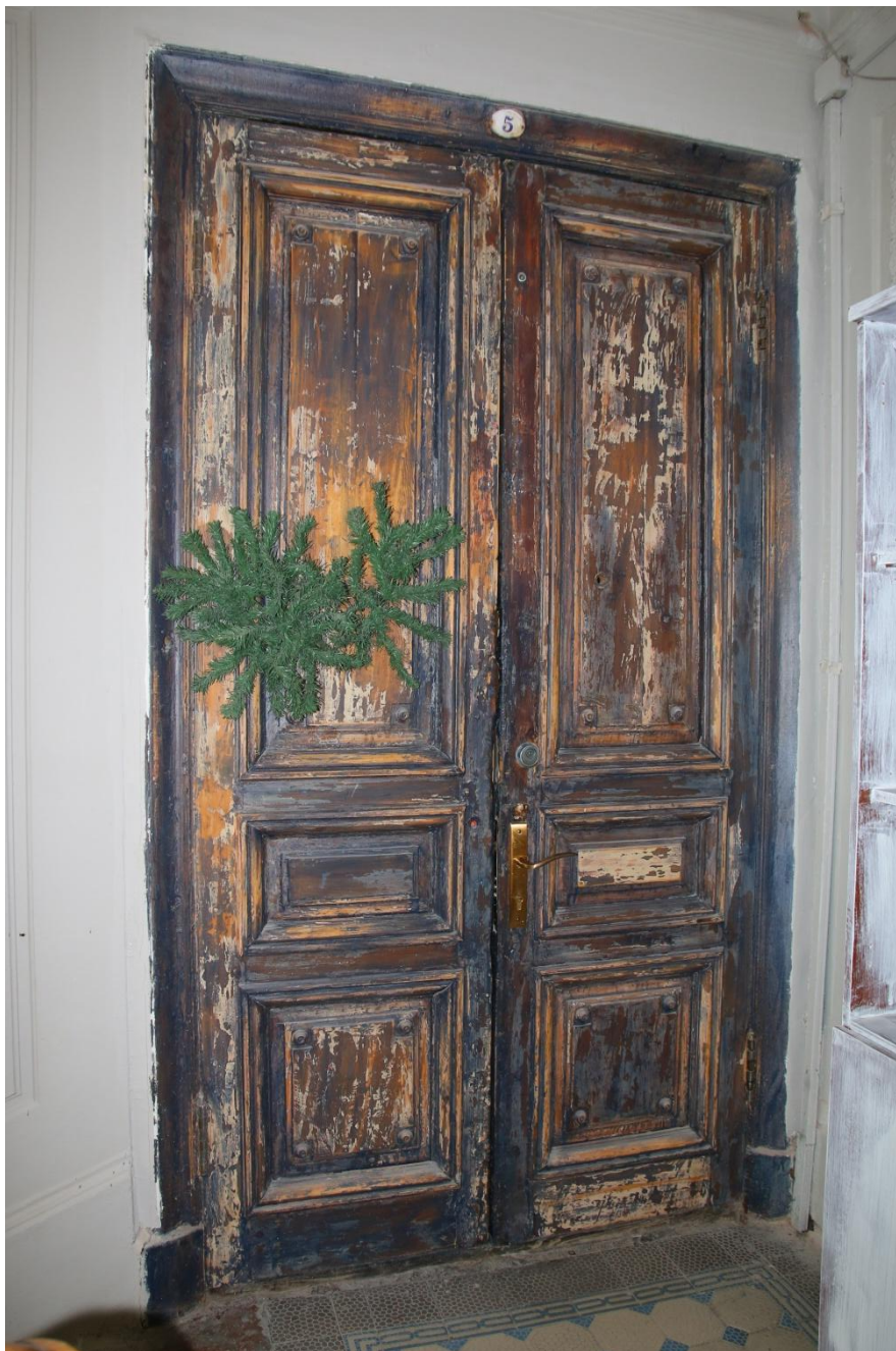
60. Интерьер парадного входа. Дверь жилого помещения
