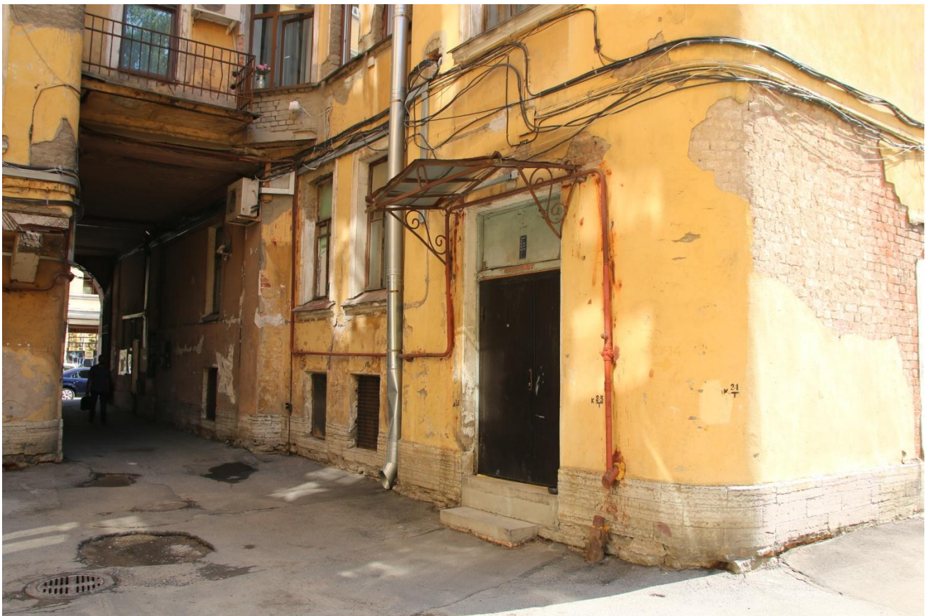
20. Фрагмент дворового фасада. Вид с запада
