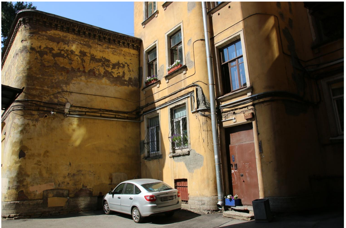
28. Фрагмент дворового фасада. Дверь входа дворовой парадной. Вид с востока
