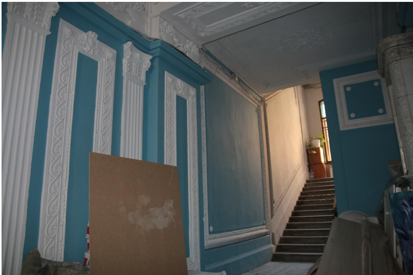
32. Интерьер вестибюля парадного входа. Фрагмент оформления стен и потолка
