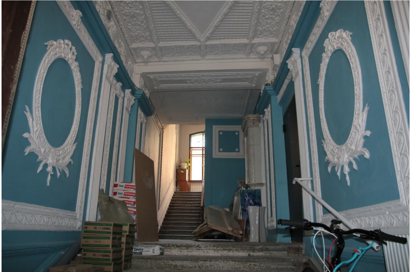
30. Интерьер вестибюля парадного входа. Фрагмент оформления стен и потолка
