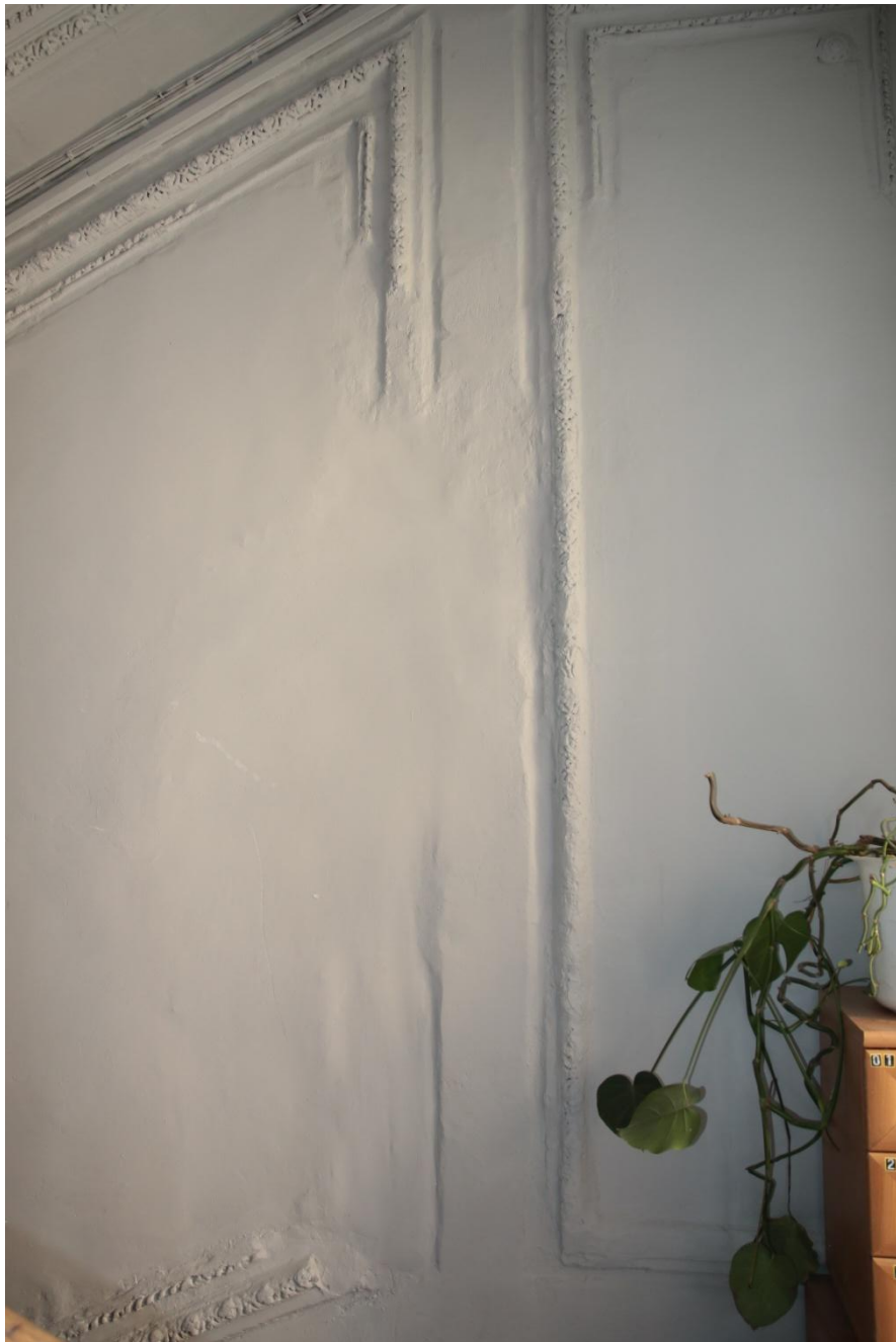
53. Интерьер парадного входа. Оформление стен парадной лестницы
