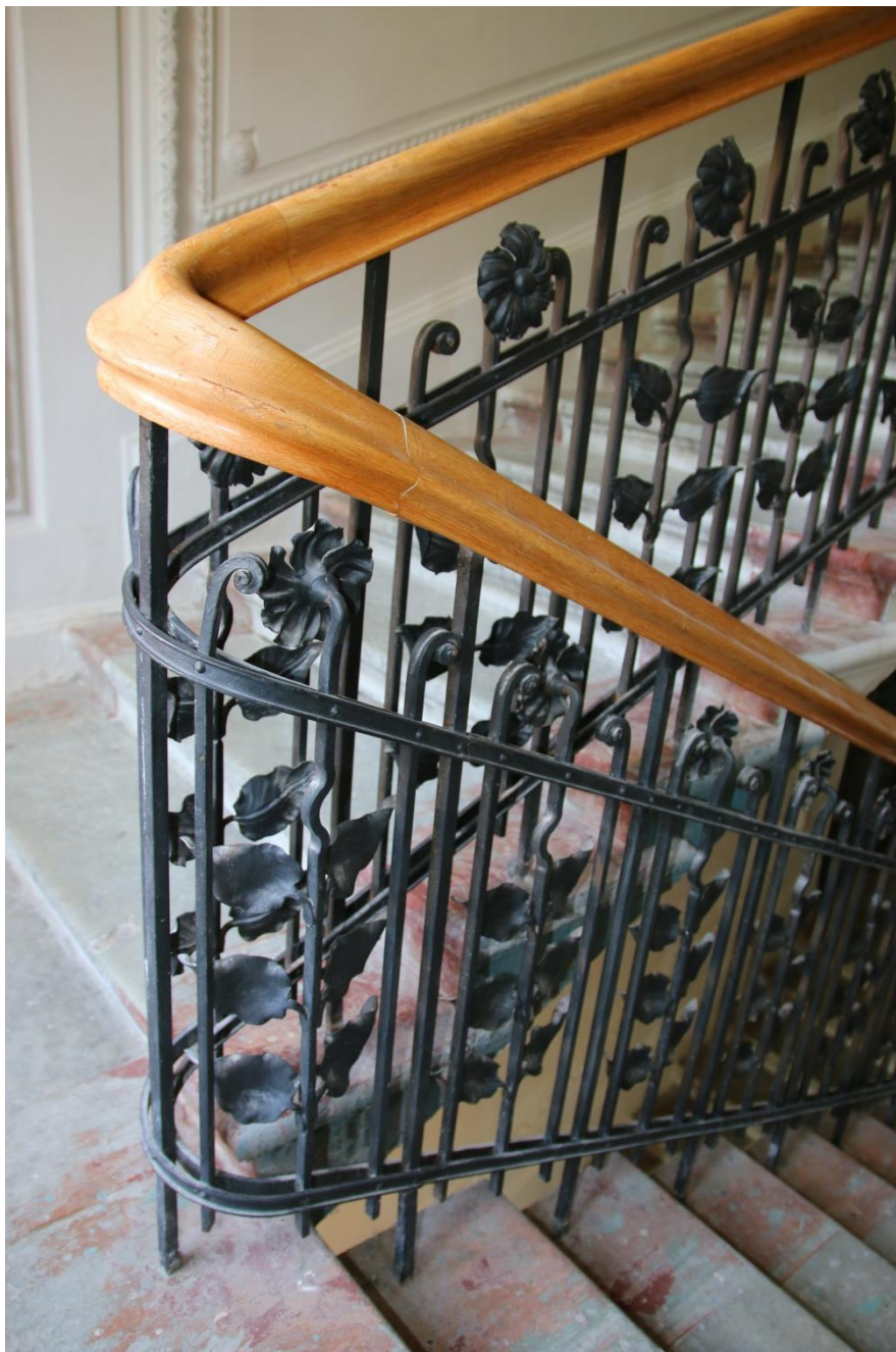
66. Интерьер парадного входа. Фрагмент ограждения парадной лестницы
