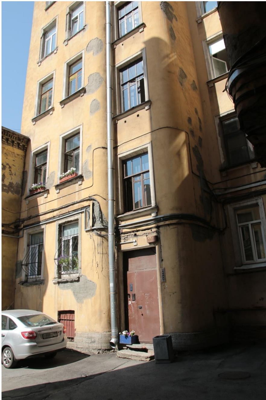
29. Фрагмент дворового фасада. Оформление оконных проемов дворовой парадной. Вид с востока
