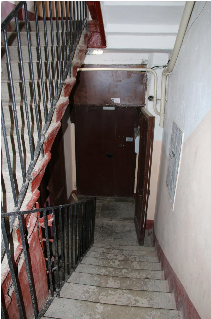
74. Интерьер первого этажа дворовой парадной. Тамбур входа
