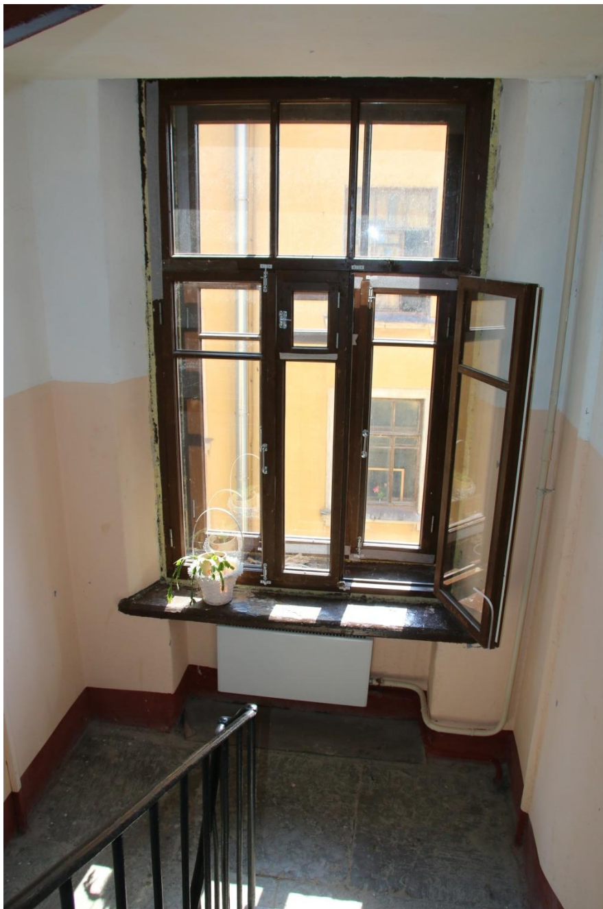
86. Интерьер дворовой парадной. Оконный проем лестничной площадки
