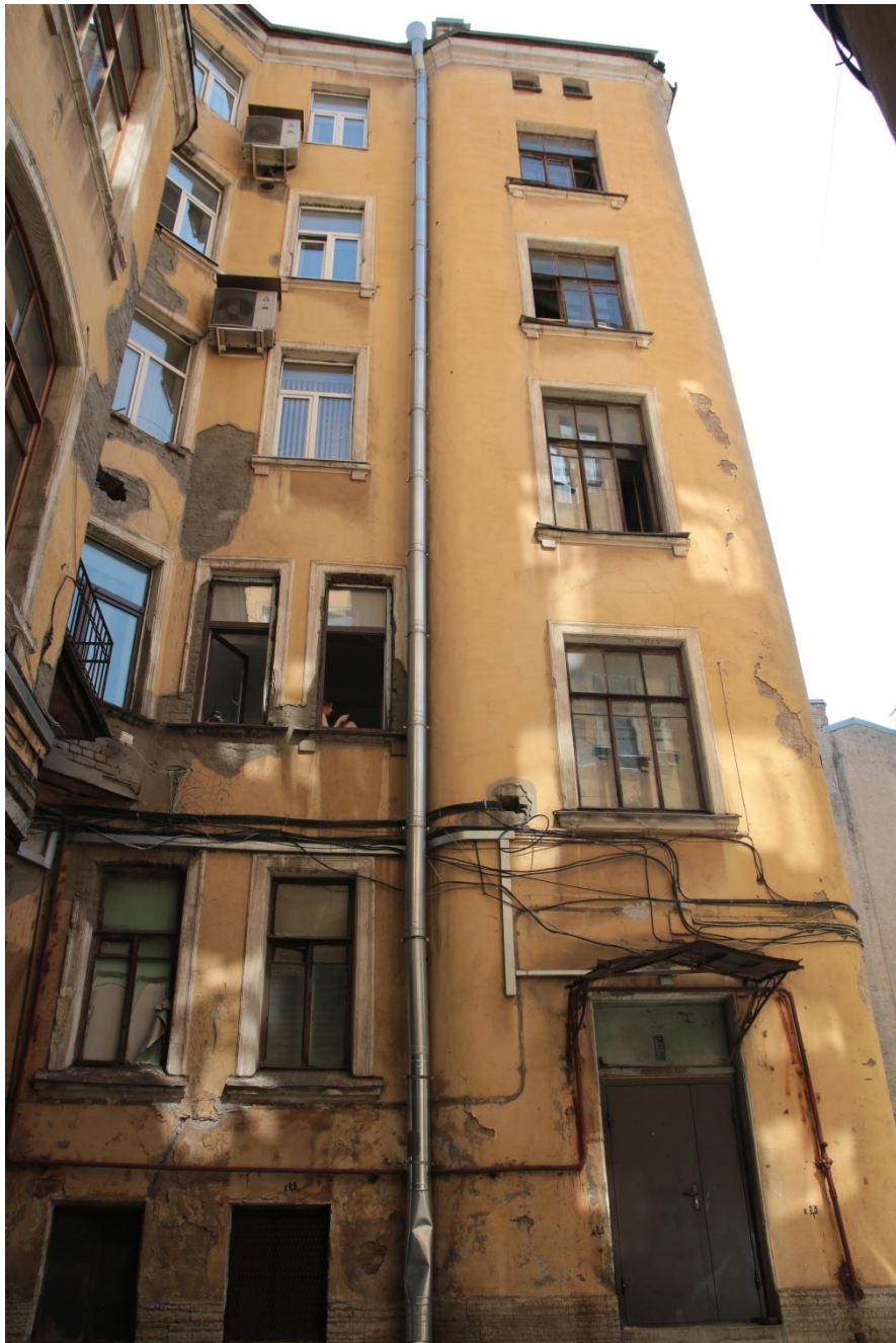
22. Фрагмент дворового фасада. Оформление оконных проемов. Вид с северо-запада
